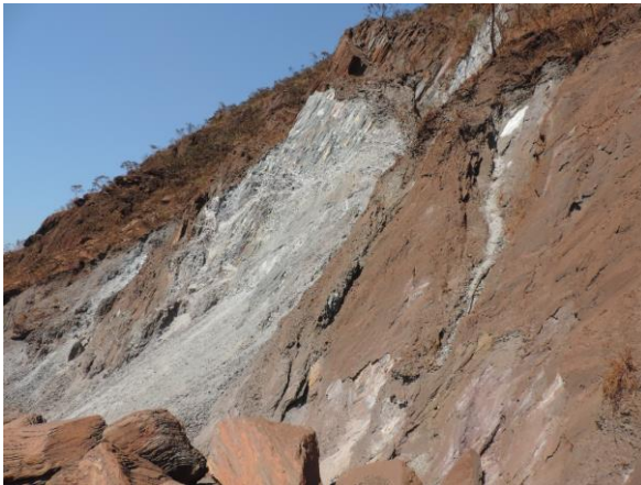
Foto 9.3-1: Processos erosivos nos itabiritos friáveis, talude no acesso a Honório Bicalho, no Trecho 5, considerado o mais crítico sobre o ponto de vista da presença de processos que indicam instabilidade geotécnica do terreno.
