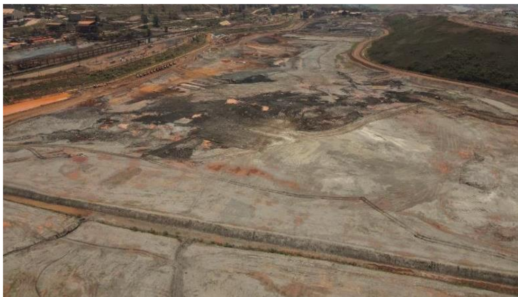
Figura 2 – Visão Geral da escavação Área 1 Fase 2(27/10/2022)
