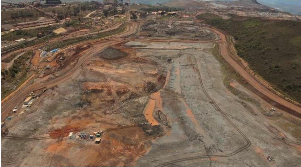
Figura 5 – Sistema de bombeamento para projeto PPPC (27/10/2022)
