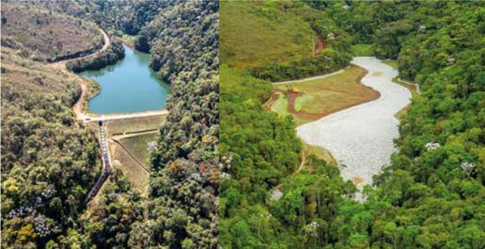
A barragem 8B era usada para contenção de sedimentos. Após as obras realizadas este ano, a estrutura não possui mais alteamento e nem funciona como barragem. Toda a área ocupada pela 8B já foi revegetada com espécies da região para garantir a reintegração ao meio ambiente.
