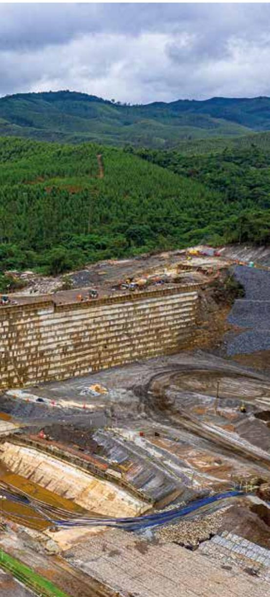
Também estão sendo implantadas três estruturas de contenção (em concreto ou pedras) a jusante das barragens B3/B4, Sul Superior e Forquilhas 1 e 3. Essas barragens encontram-se em nível 3 de emergência. As comunidades que viviam na ZAS já foram transferidas para locais fora da área de risco. O objetivo dessas contenções é reter o material dessas barragens na eventualidade de rompimento e, dessa forma, reduzir impactos às pessoas e ao meio ambiente.
