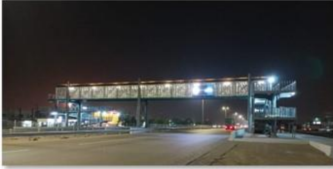
Construção da Passagem de Pedestres em Liwa
