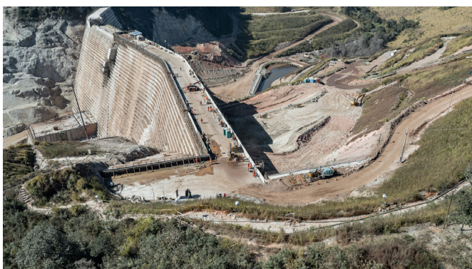
A contenção possui 95 metros de altura e 330 metros de comprimento.
