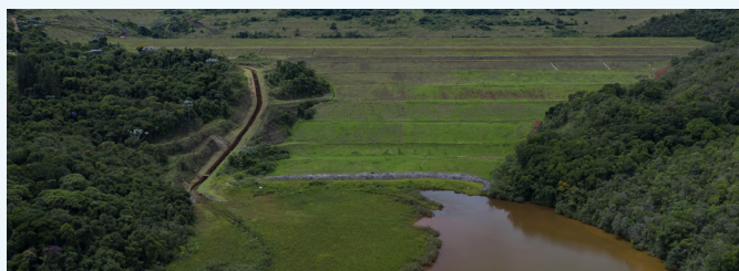
Na barragem Sul Superior, estão sendo realizadas atividades preliminares para a descaracterização.
