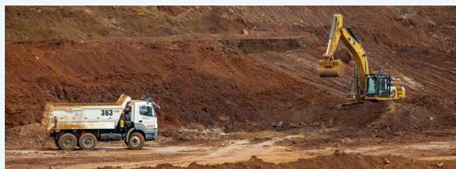
Desde o início das obras, em novembro passado, são utilizados equipamentos não tripulados na barragem B3/B4.
