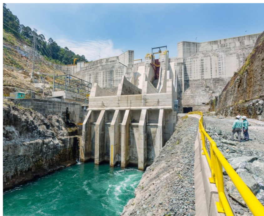
Usina hidroelétrica Kerebbe, Indonésia
