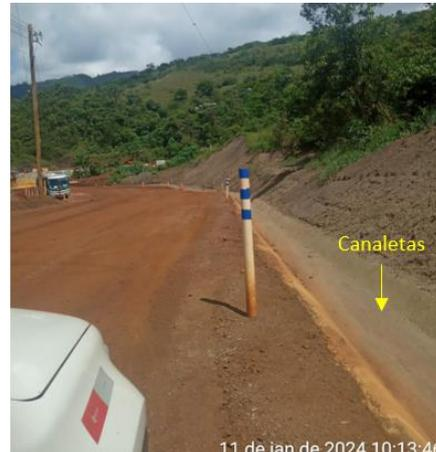
**Foto 16:** Aspecto das canaletas limpas do acesso operacional em direção ao sump 1 da Torre 1. Manutenção ativa na retenção de sedimentos. Fonte: Vale, 2024.
