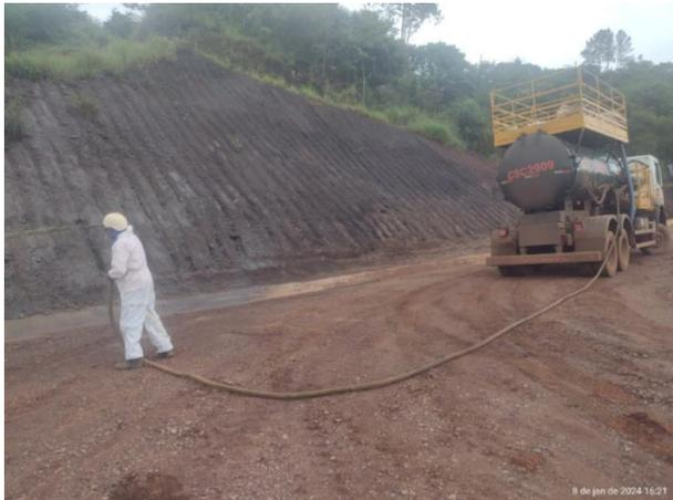
**Foto 26:** Aplicação de MVP em talude da Torre 1. Fonte: Vale, 2024.
