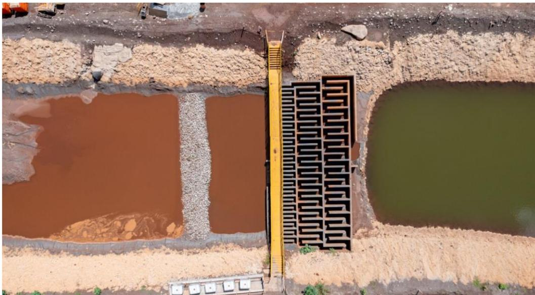
**Foto 44:** Aspecto do sump a jusante da PDR cujo ponto de monitoramento é o GSO-SUMP2. Detalhe para o controle ambiental (chincanas) instaladas. Fonte: Vale, 2024
