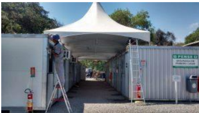
Figura 11 Modelos de Container – Canteiro de Obras
