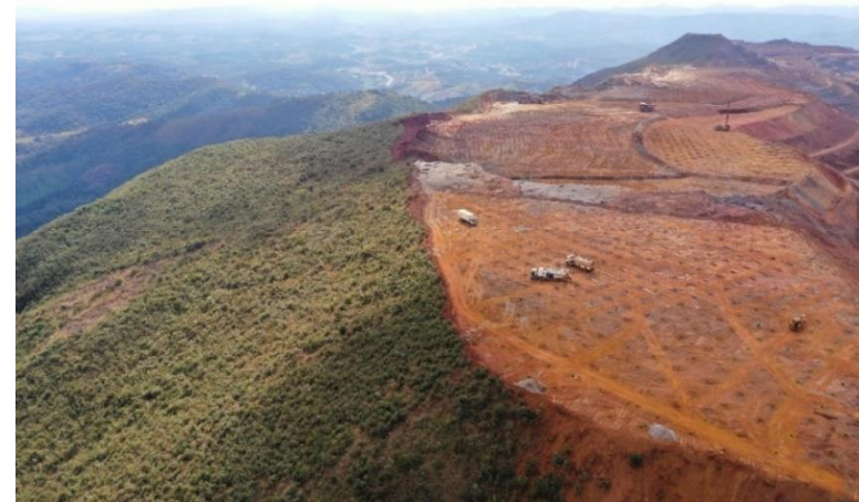
Figura 01 Vista da borda da Cava da Mina de Brucutu
