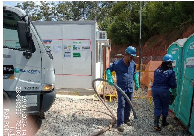
Foto 26. Execução de limpeza e higienização de banheiros químicos nos canteiros de obras e frentes de serviço. Fonte: Vale, 2024.
