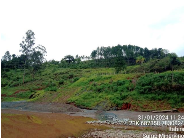
Foto 20. Desenvolvimento da Aplicação de hidrossemeadura com biomanta em taludes como medida de contenção de processos erosivos – Sump Dique Minervino. (VALE, 2024).
