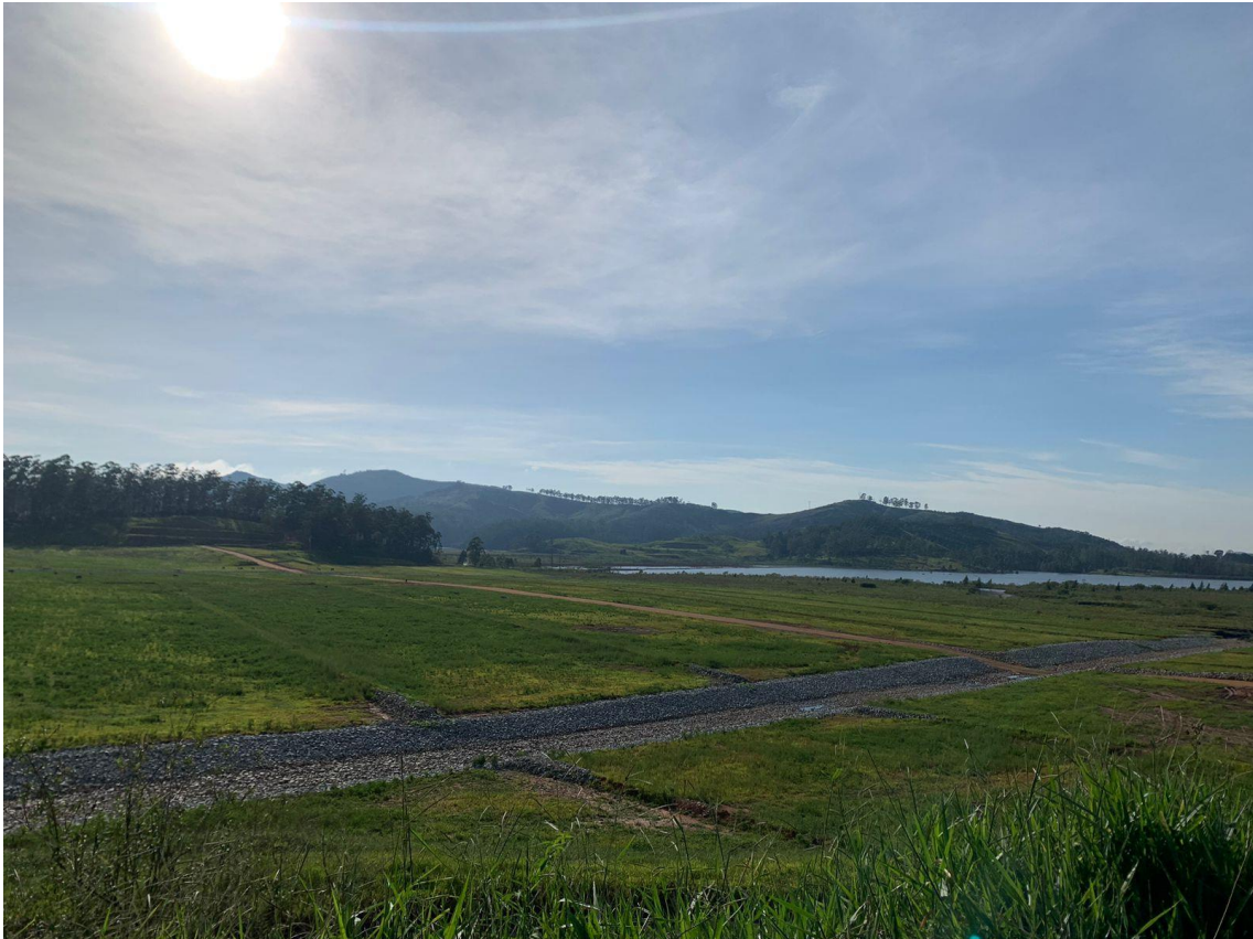
Foto 30. Acompanhamento da vegetação– Dique 2. Fonte: Vale, 2024.
