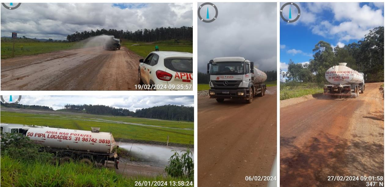
Figura 8. Operações de aspersão de água realizadas durante as atividades preliminares da ECJ
