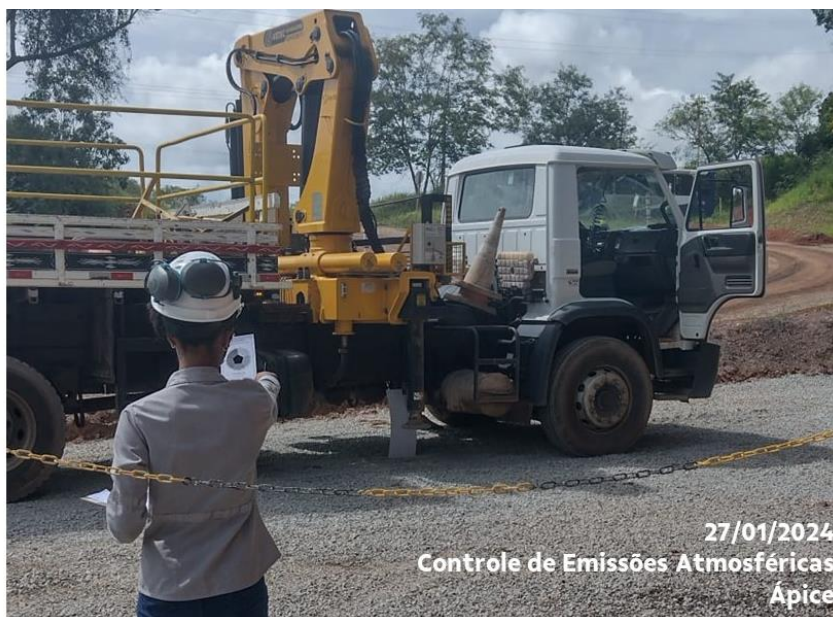
Foto 22. Controle de Emissões Proveniente de Escapamento de Equipamentos Movidos a Diesel
