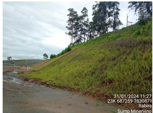
Foto 21. Desenvolvimento da Aplicação de hidrossemeadura com biomanta em taludes como medida de contenção de processos erosivos – Sump Dique Minervino. (VALE, 2024).
