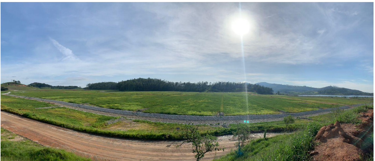
Foto 31. Acompanhamento da vegetação– Dique 2. Fonte: Vale, 2024.
