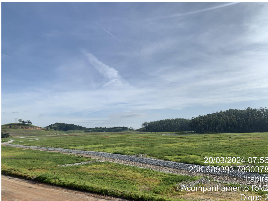
Foto 29. Acompanhamento da vegetação– Dique 2. Fonte: Vale, 2024.
