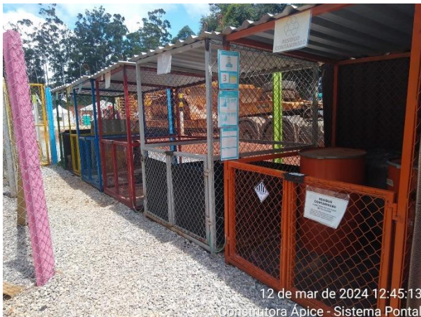
Foto 27. Depósito intermediário de Resíduos e Transporte de resíduos para a Central de Materiais Descartáveis.
