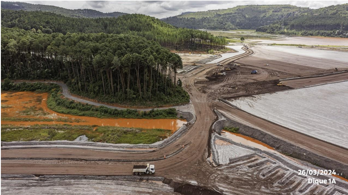
Foto 14. Canal provisório de direcionamento de água do Dique 1A para Barragem Itabiruçu. Fonte: Vale, 2024.
