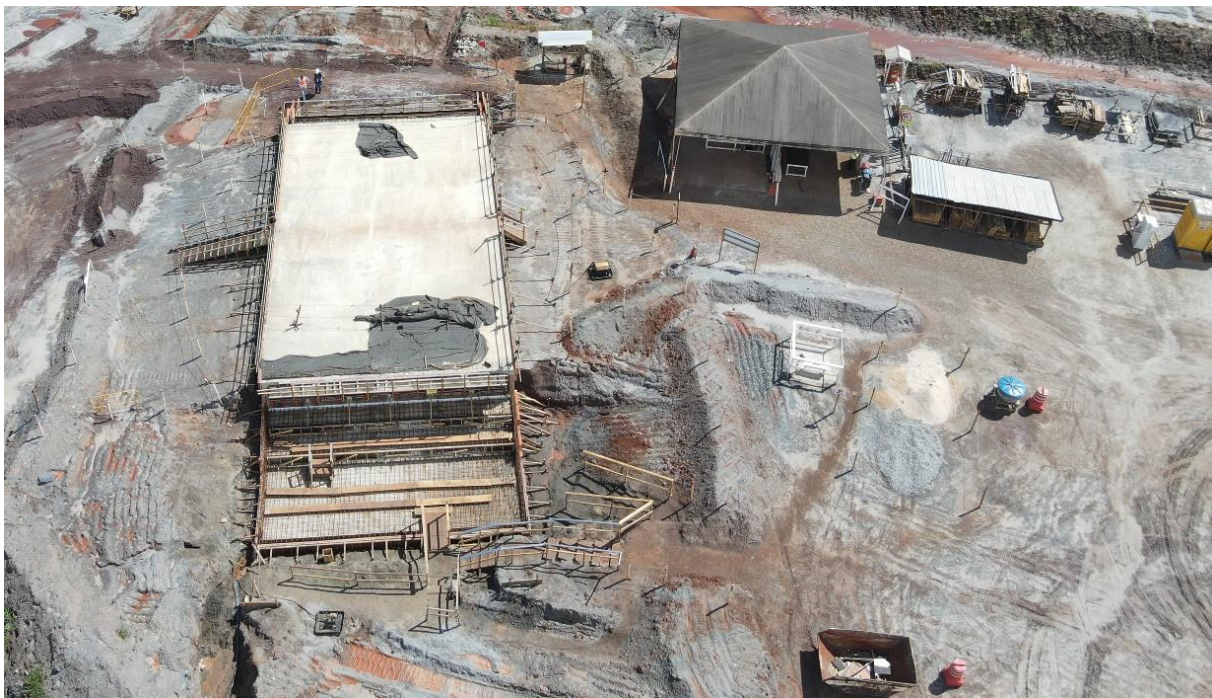
Foto 7. Execução de galeria do canal de drenagem C1 do Dique 1ª (abril/24).
