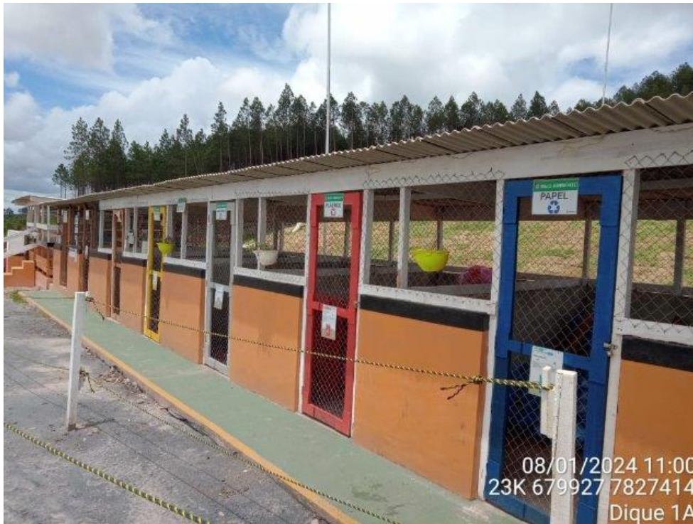
Foto 42. Depósito Intermediário de Resíduos Dique 1A, também utilizado para as obras do Dique 1B. (Fonte: Vale, 2024).
