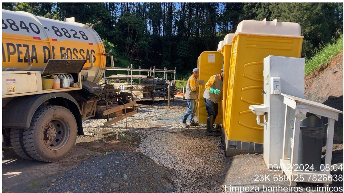
Foto 38 e Foto 39. Evidências de Limpeza dos banheiros químicos e sucção de efluentes sanitários. Fonte: Vale, 2024.
