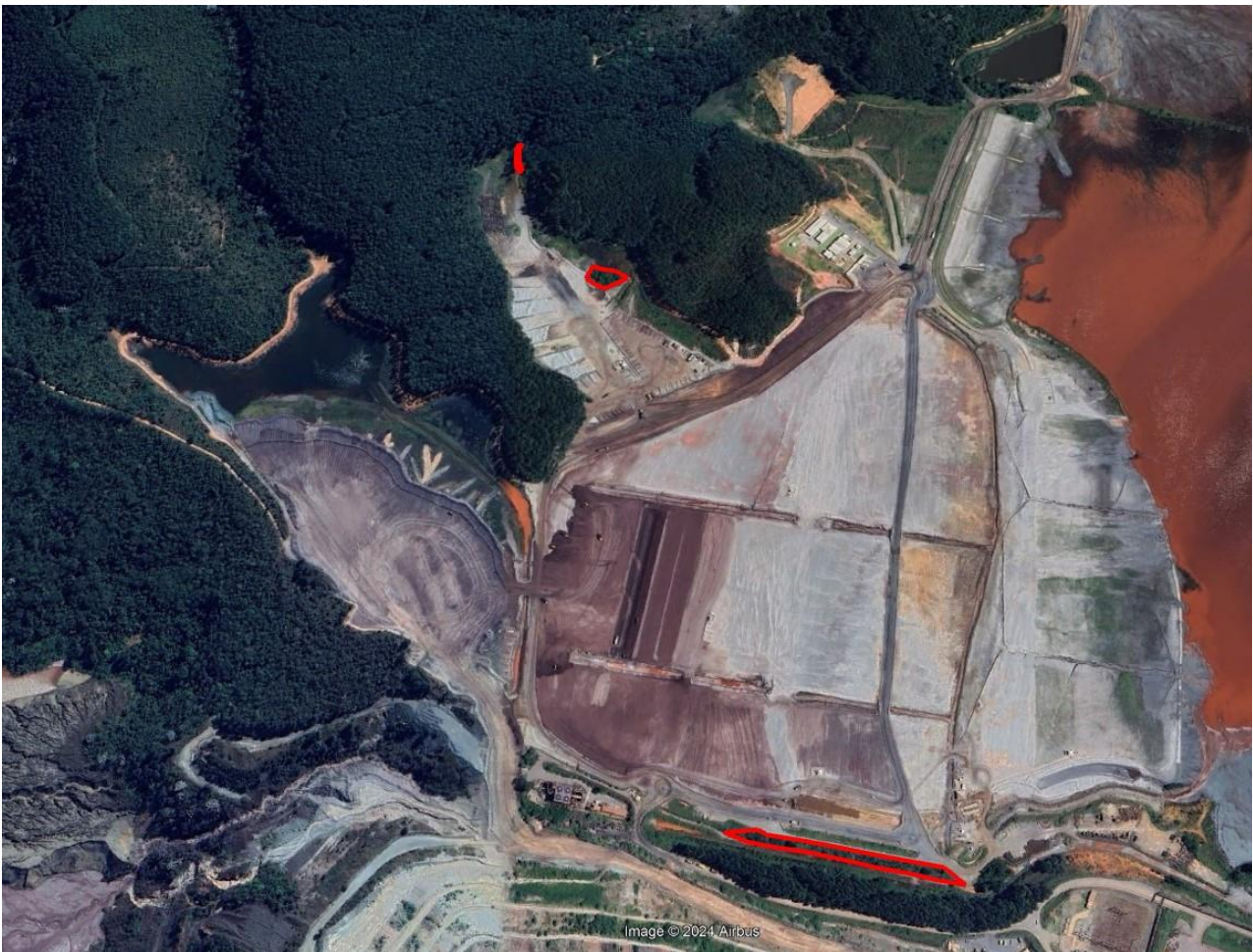
Figura 26. Áreas supressão vegetal no Dique 1A. Vale, 2024.
