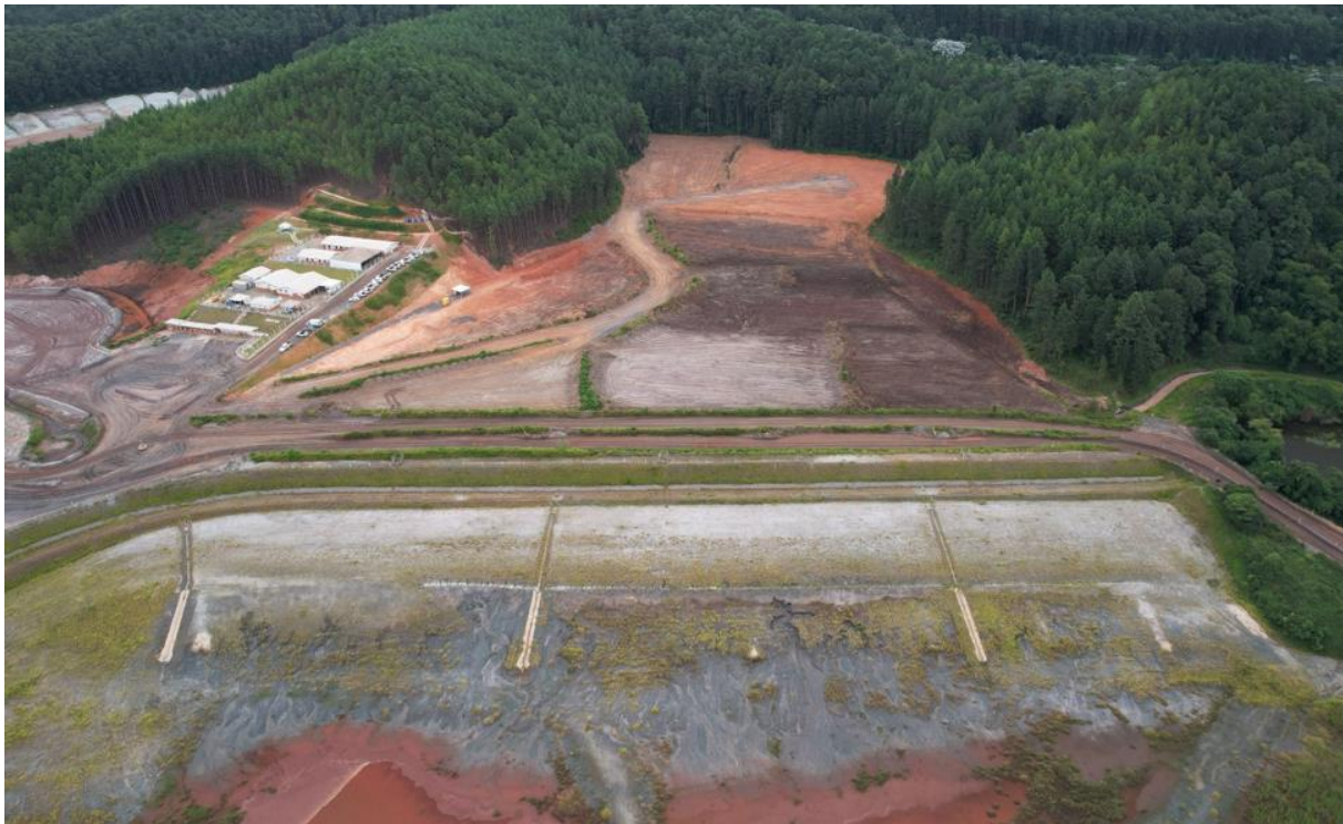
Foto 12. Limpeza da área do Dique 1B (Abril/24).
