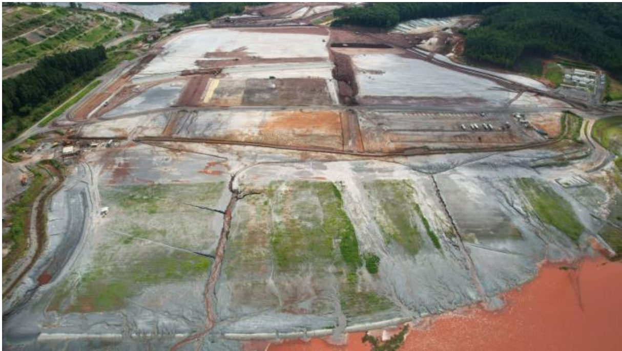
Foto 8. Visão Geral do Dique 1A (abril/24).
