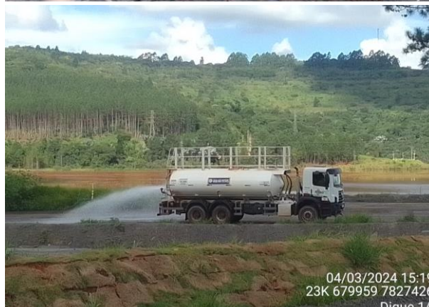
Foto 32, Foto 33, Foto 34 e Foto 35. Umeccação de vias de acesso as obras de descaracterização do Dique 1A. Fonte: Vale, 2024.
