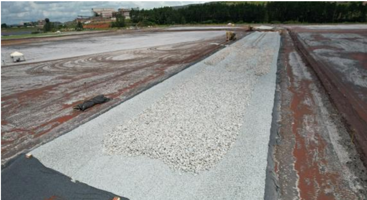
Foto 11. Execução dos Canais de Drenagem do Dique 1A (Abril/24).
