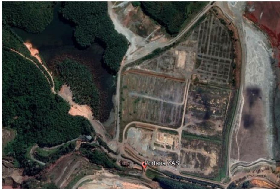
Figura 7. Localização da Portaria ZAS Dique 1A.
