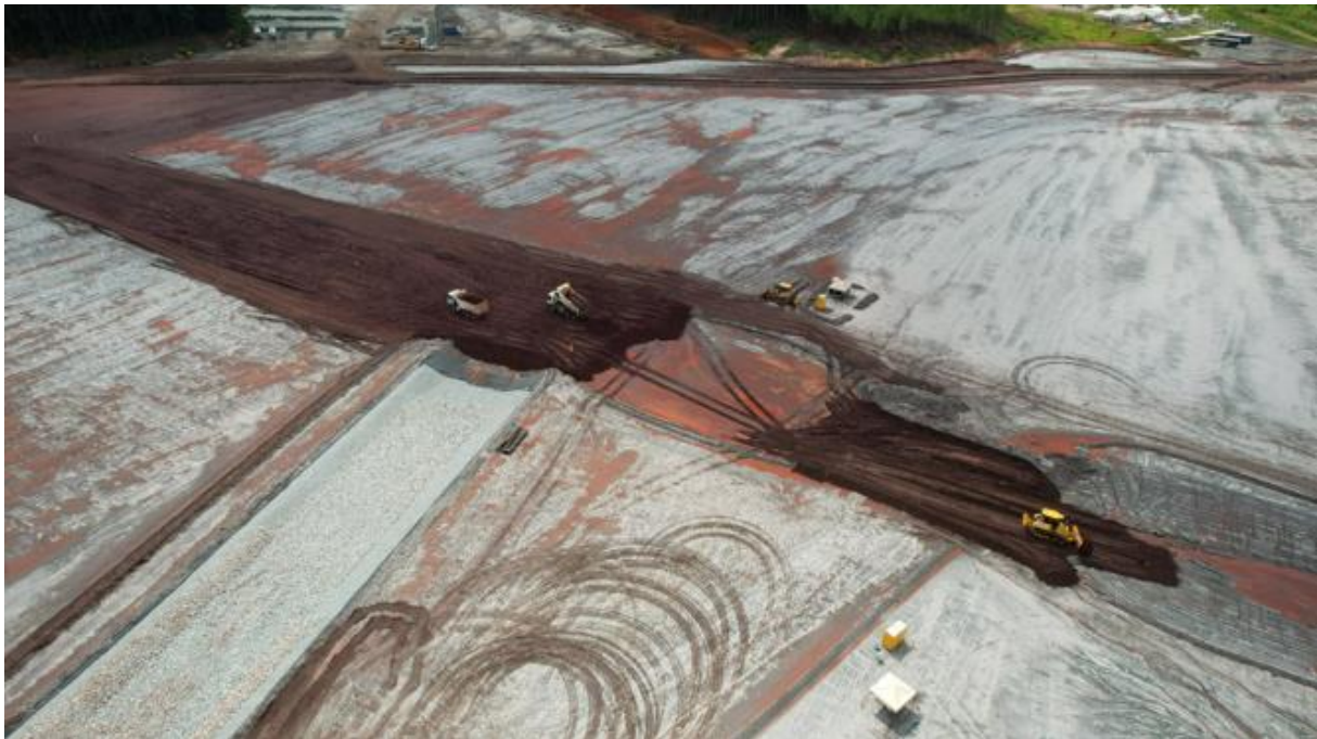
Foto 4. Regrade a montante do reservatório do Dique 1A (abril/24).
