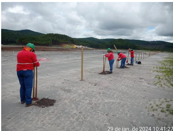
Foto 30 e Foto 31. Construção de cercas nas áreas já liberadas para o plantio no Dique 1A.
