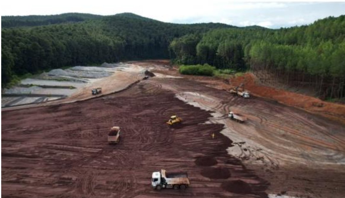
Foto 3. Regrade a montante do reservatório do Dique 1A (abril/24).
