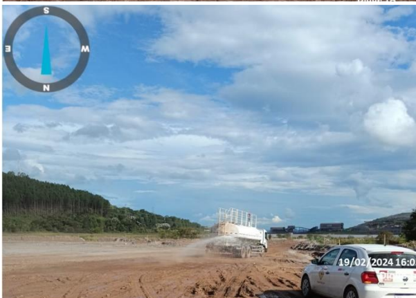
Foto 32, Foto 33, Foto 34 e Foto 35. Umeccação de vias de acesso as obras de descaracterização do Dique 1A. Fonte: Vale, 2024.
