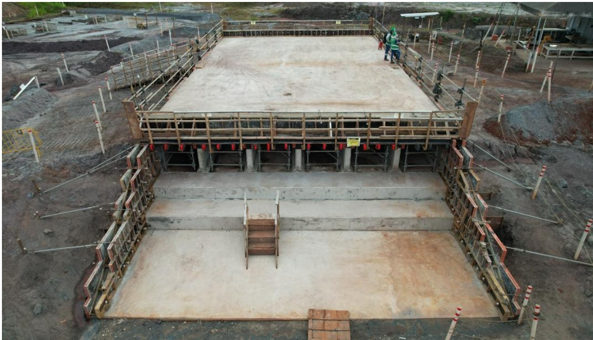
Foto 6. Execução da ala de saída da galeria do canal de drenagem C1 do Dique 1ª (abril/24).
