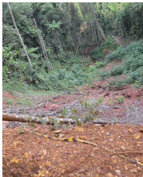
Deslizamento na margem de uma estrada na área de estudo do projeto.
