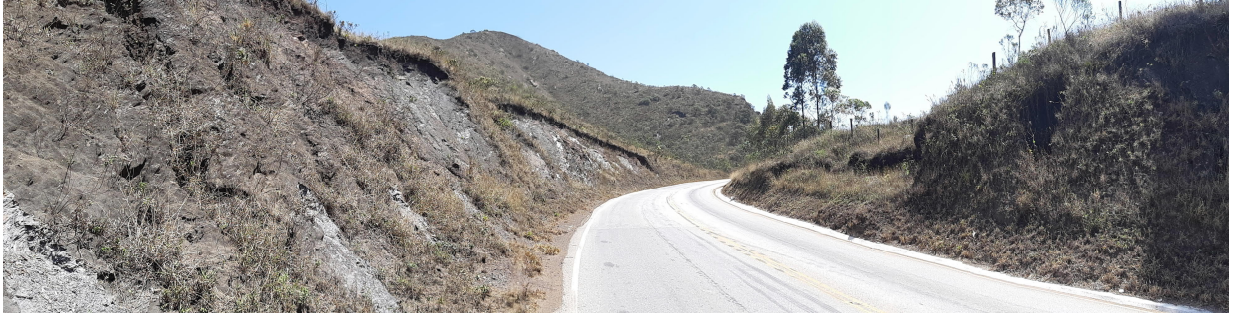
MG-442 no trecho do Viaduto
