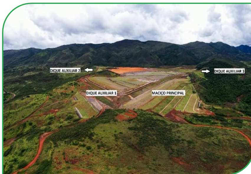
Vista da barragem Doutor
