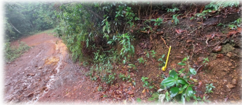
Figura 5.26 - Trecho da estrada onde foi projetado o acesso Mina/UTM, mostrando exposição do solo coluvionar sobre o saprolito amarelo de alteração de rochas máficas
