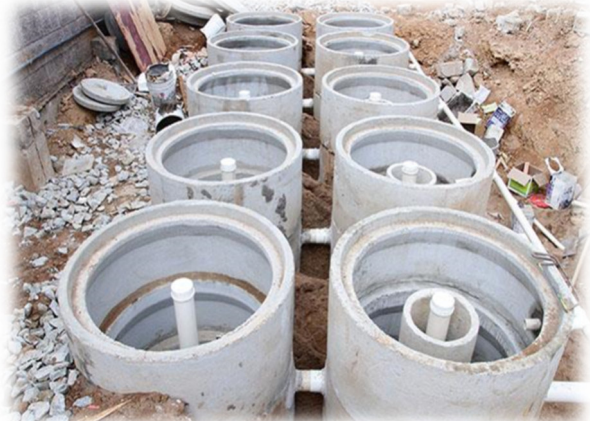
Figura 3.6 - Modelo de fossa séptica pré-fabricada, em anéis de concreto
