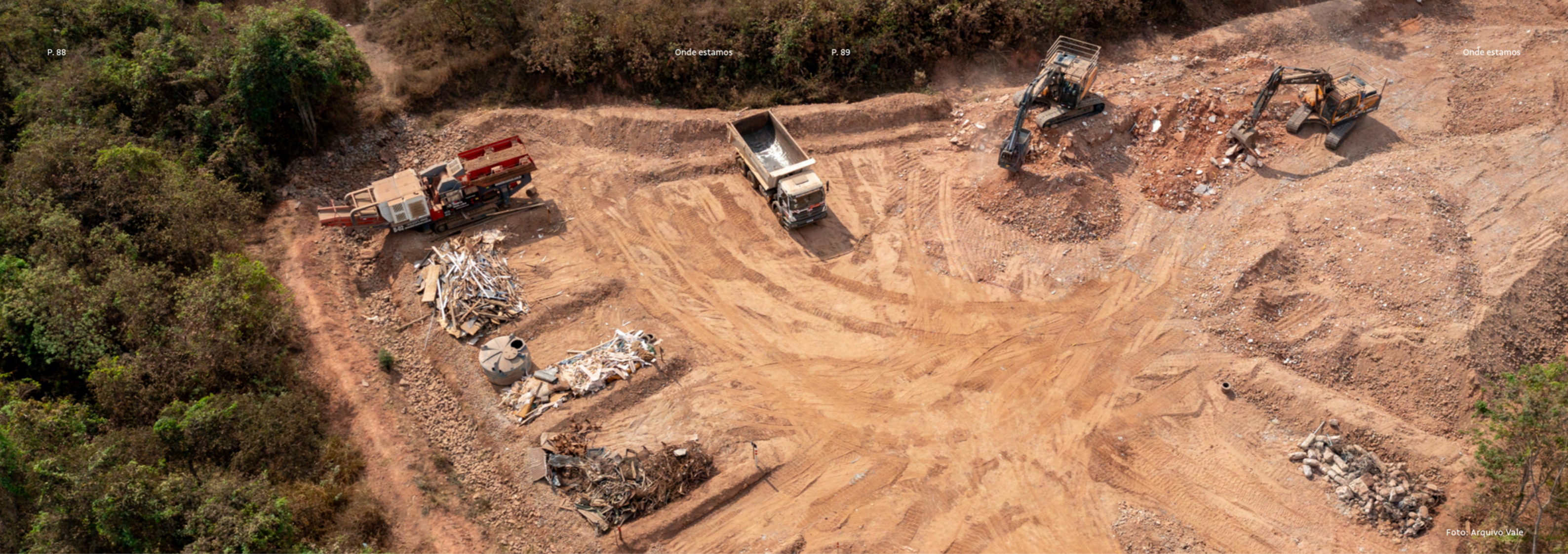
Depósitos Temporários de Rejeito
