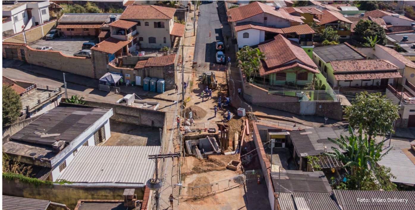
Obras de instalação da adutora Carlos Prates, em Belo Horizonte
