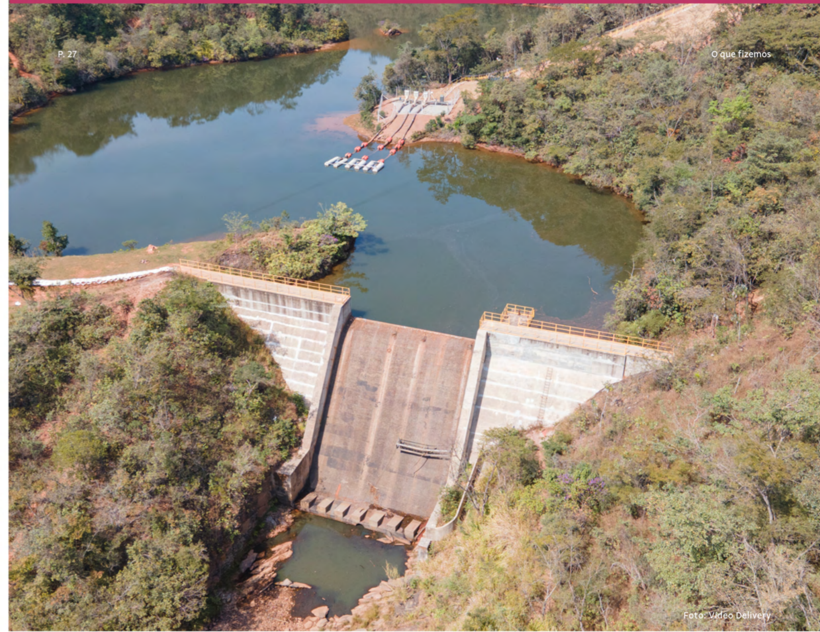
Captação e adutora na barragem de Cambimbe
