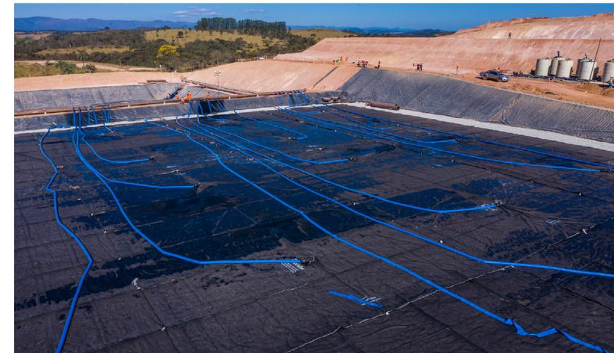
Vista geral das bolsas utilizadas para armazenamento e desidratação dos rejeitos da dragagem. A água drenada dessas bolsas é bombeada para a ETAF e retorna limpa ao rio Paraopeba. Foto: Arquivo Vale.
