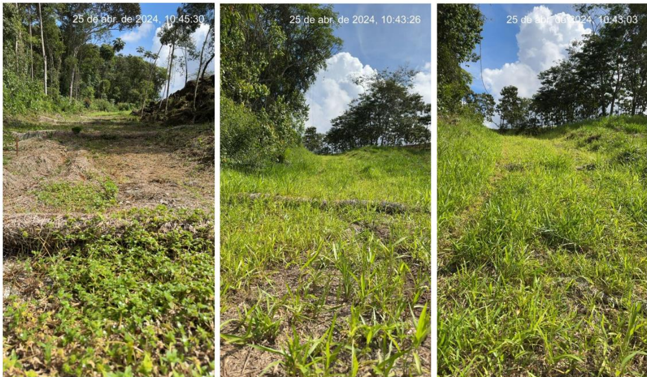
Foto 2, Foto 3 e Foto 4: Recuperação vegetal do acesso ocorrida em abril de 2024.
