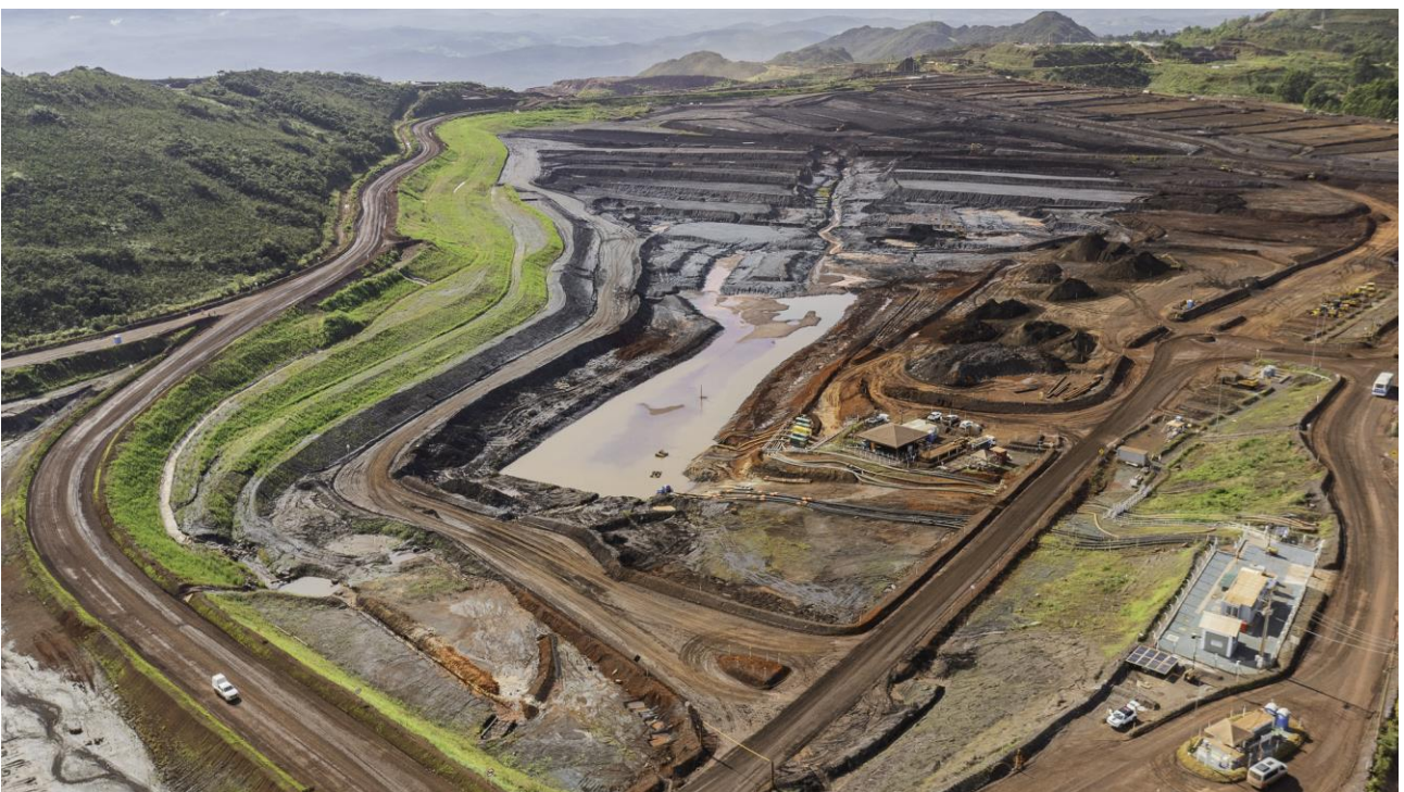
Foto 11. Vista da Barragem Vargem Grande, após processo de revegetação bem estabelecido da ombreira esquerda da barragem. (Fonte: Vale, 01 de abril de 2024).
