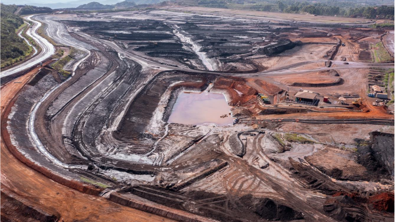
Foto 10. Vista da Barragem Vargem Grande, com foco na ombreira esquerda, durante o período de aplicação de MVP (Fonte: Vale, 01 de dezembro de 2023).
