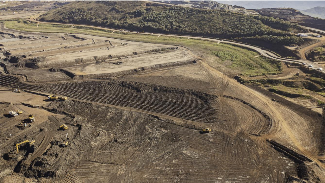
Foto 14. Vista da Barragem Vargem Grande, após processo de revegetação bem estabelecido da ombreira esquerda da barragem – período de seca. (Fonte: Vale, 06 de junho de 2024).
