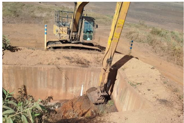
Foto 7. Execução de limpeza nos canais de cintura (Fonte: Vale, maio de 2024).
