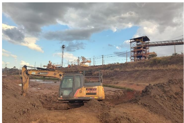
Foto 9. Execução de limpeza do SUMP (Fonte: Vale, julho de 2024)
