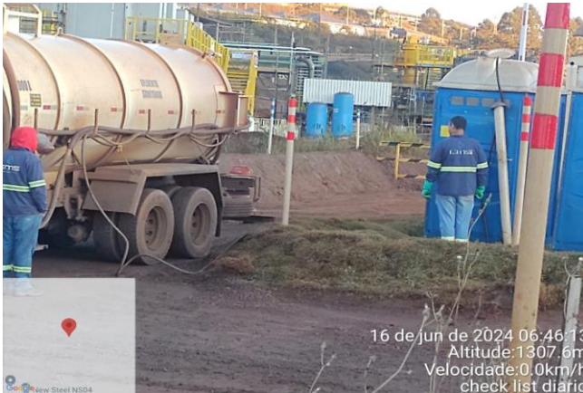
Foto 19. Limpeza dos banheiros frentes de serviço. (Fonte: Vale, 2024)
