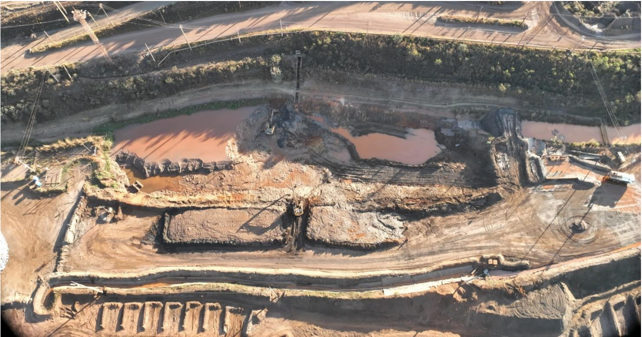
Foto 27. Imagem aérea das obras de ampliação do SUMP, com vista para o novo apanhador, desvio do canal e aplicação do floculante. Fonte: Vale, julho de 2024.
