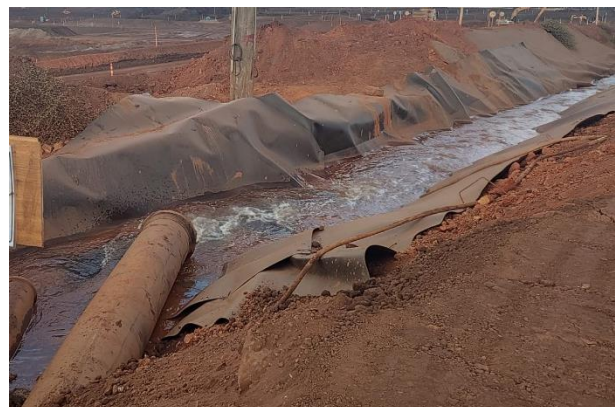
Foto 26. Desvio do canal CC02 com turbilhonamento para aplicação do coagulante. (Fonte: Vale, julho de 2024)
