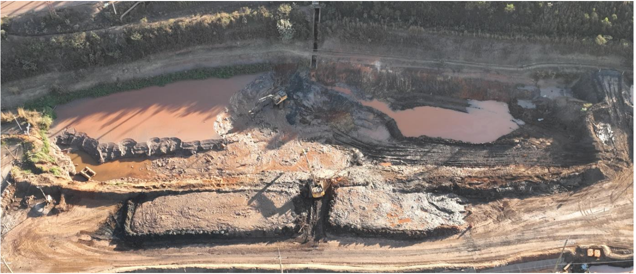
Foto 3. Limpeza regular no SUMP 02 de contenção de sedimentos (16/07/2024).
