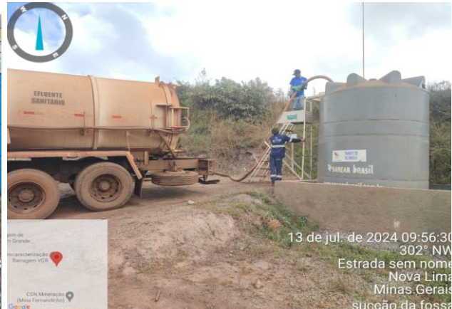
Foto 20. Sucção do tanque séptico no Canteiro. (Fonte: Vale, 2024).
