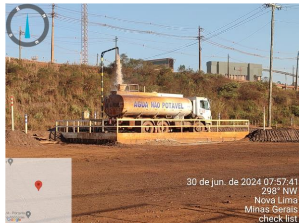
Foto 16: Abastecimento de caminhão pipa com água para umectação das vias de acesso (Fonte: Vale, junho de 2024)
