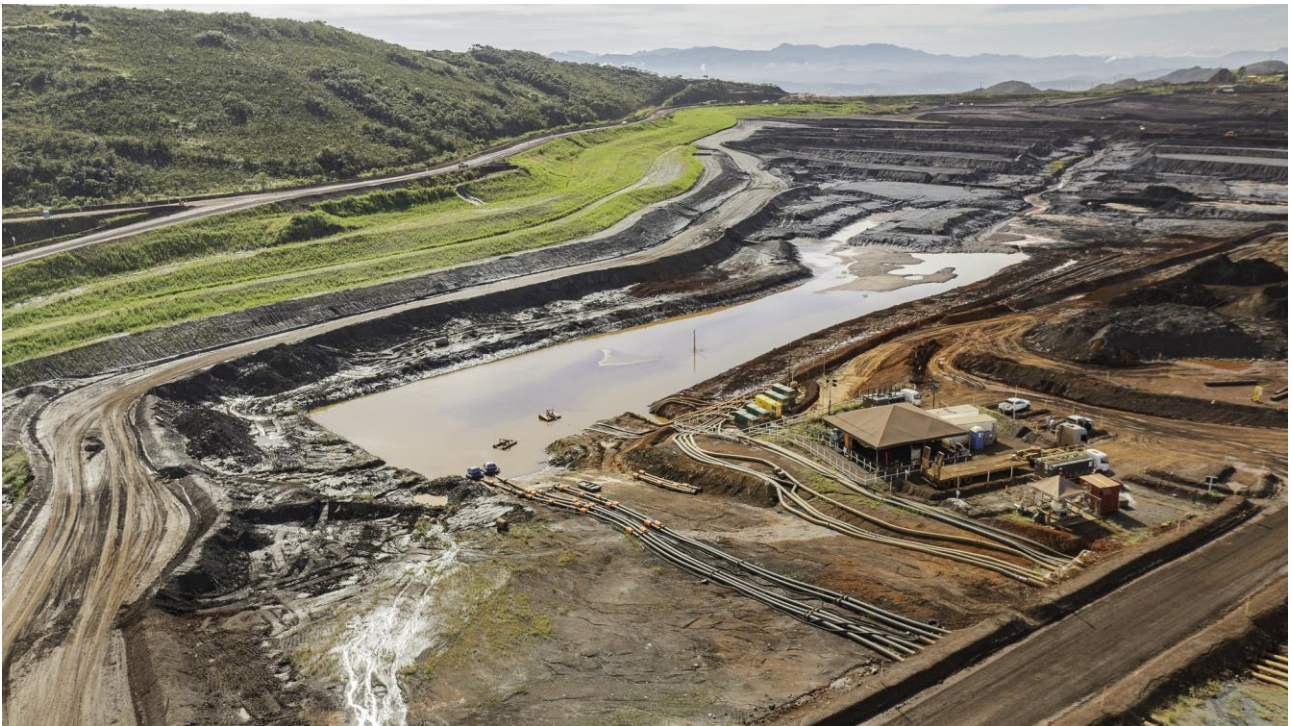
Foto 12. Vista da Barragem Vargem Grande, após processo de revegetação bem estabelecido da ombreira esquerda da barragem. (Fonte: Vale, 01 de abril de 2024).
