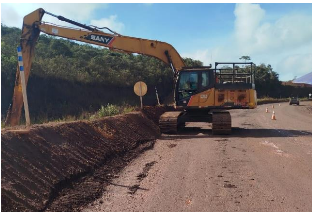
Foto 6. Execução de limpeza nos canais de cintura (Fonte: Vale, maio de 2024).
