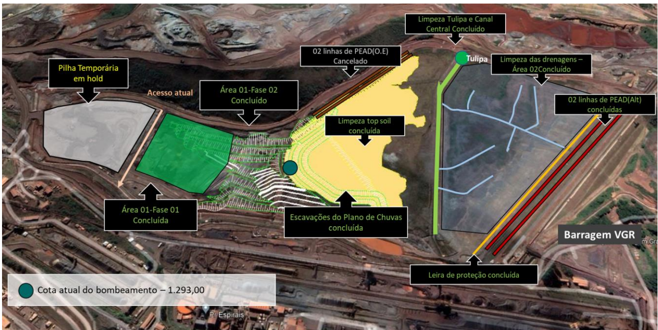
Figura 4. Visão das obras de melhorias na estrutura, concluído.
