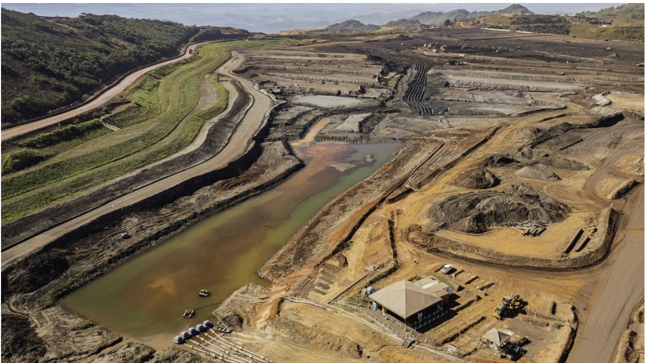
Foto 13. Vista da Barragem Vargem Grande, após processo de revegetação bem estabelecido da ombreira esquerda da barragem – período de seca. (Fonte: Vale, 06 de junho de 2024).
