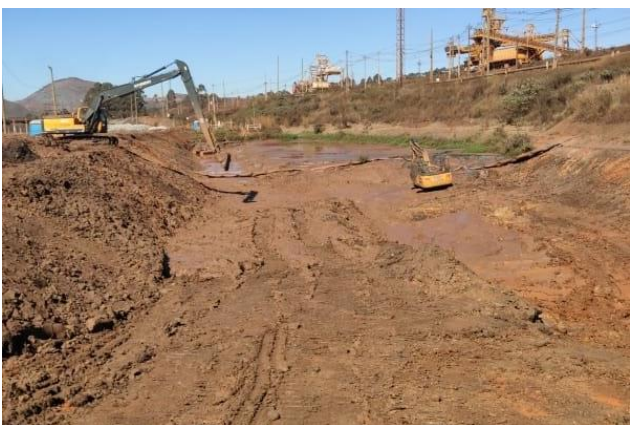
Foto 8. Execução de limpeza do SUMP (Fonte: Vale, julho de 2024)
