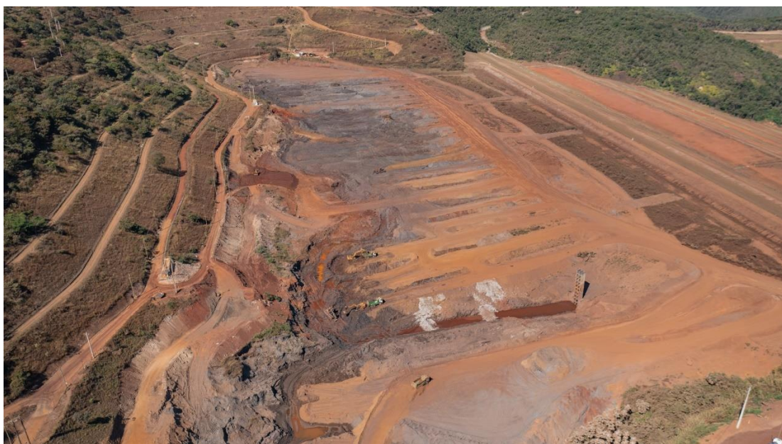
Figura 6. Visão geral – canal no reservatório de drenagens –direcionamento de águas para tulipa – julho/2024.
