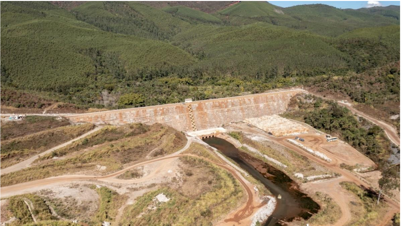
Foto 1. Estrutura de contenção a Jusante (ECJ) da Barragem Sul Superior.
