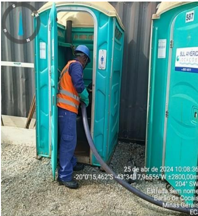
Foto 23. Limpeza de sanitários químicos (25/04/2024). Fonte: Vale, 2024.
