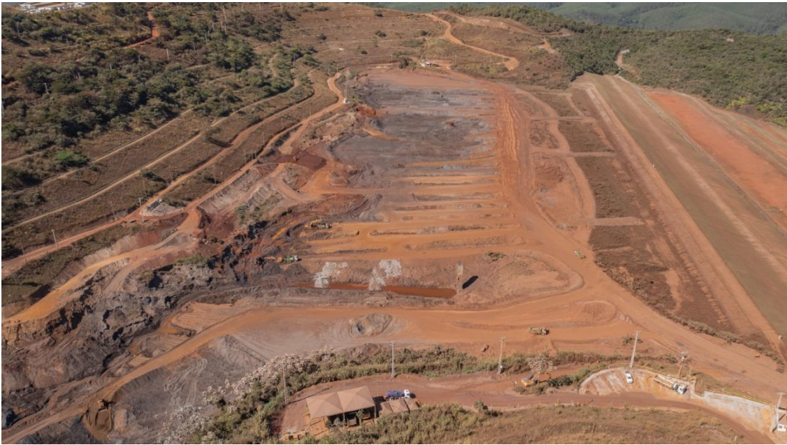
Foto 3. Vista reservatório da barragem Sul Superior (10/07/2024), escavação do platô.
