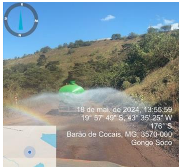
Foto 16. Umectação do acesso PDR. Fonte: Vale (18/05/2024)
