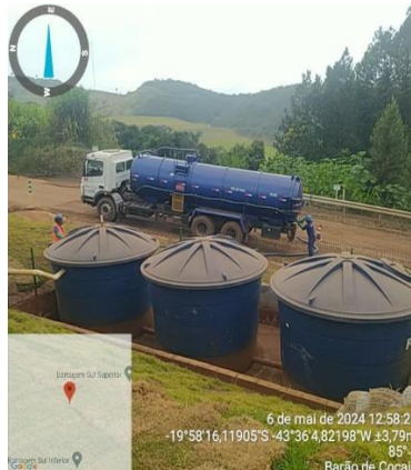
Foto 24. Sucção de fossas sépticas no Canteiro (06/05/2024). Fonte: Vale, 2024.
