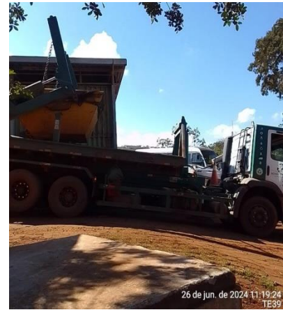
Foto 28. Retirada de caçambas do canteiro definitivo (26/06/2024). Fonte: Vale, 2024.
