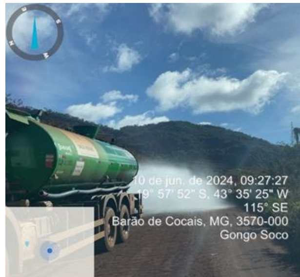
Foto 18. Umectação de Vias - acesso ECJ. Fonte: Vale (10/06/2024).
