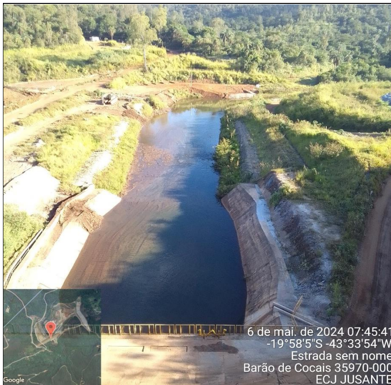
Figura 14. Conclusão do desassoreamento do Rio São João, à jusante da ECJ (maio, 2024). Fonte: Vale, 2024.
