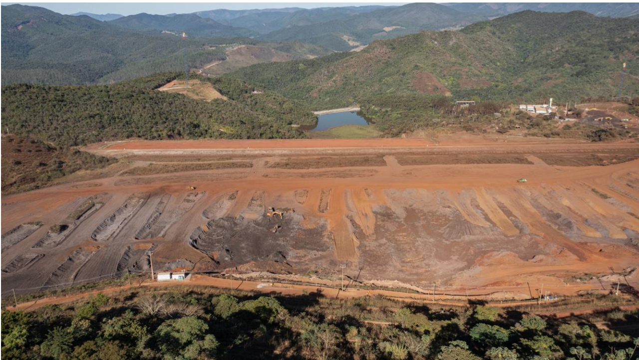
Foto 5. Aspecto geral do Reservatório da BSS evidenciando os canais principal e periférico no reservatório (junho/2024). Fonte: Vale, 2024.
