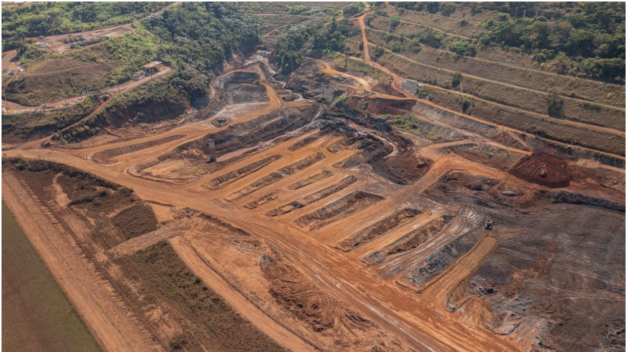
Foto 2. Vista área da Barragem de montante para jusante evidenciando a boa drenabilidade – Julho/2024.
