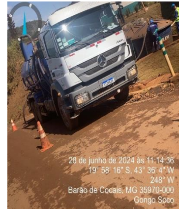
Foto 25. Sucção de fossa - Canteiro (24/06/2024). Fonte: Vale, 2024.
