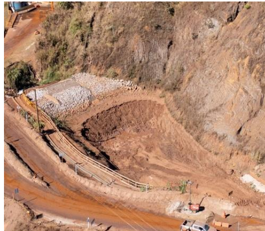
Foto 10. SUMP CAVA 1. Fonte: Vale, 07/2024.
