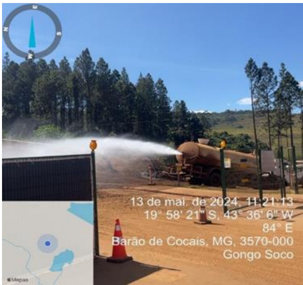
Foto 17. Umectação de Vias - Oficina Fonte: Vale (13/05/2024).
