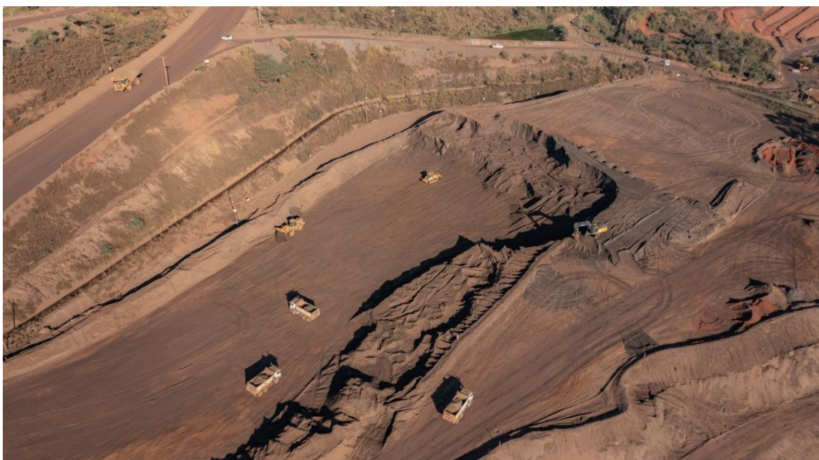
Foto 3. Carga e transporte do material depositado temporariamente na Cava 10,5 (Julho/24).
