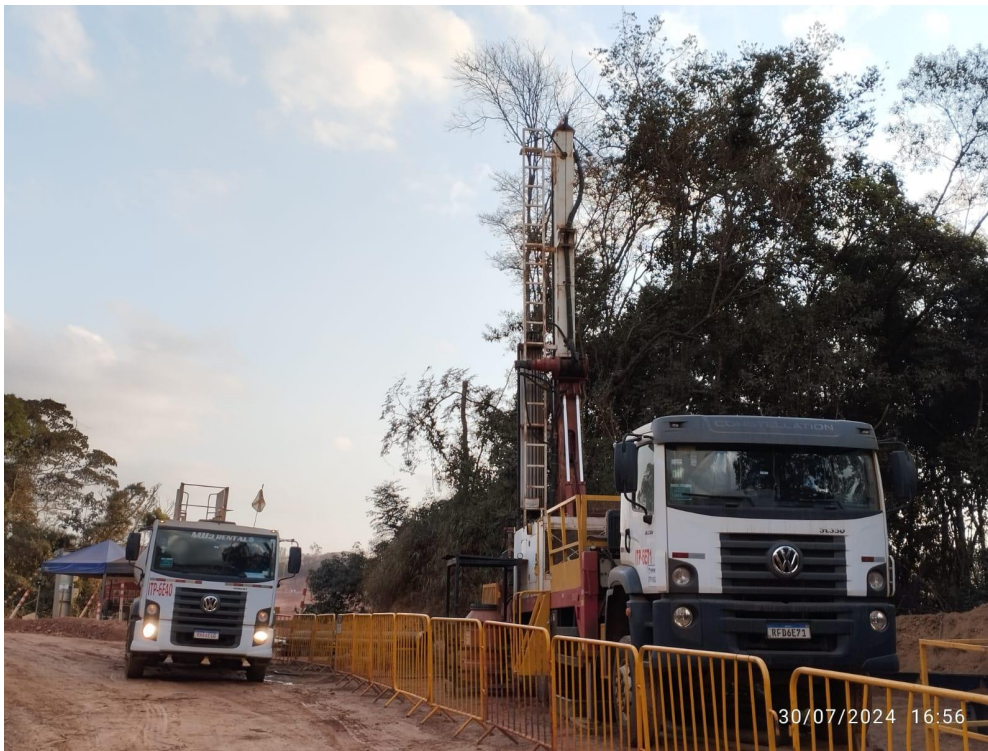
Foto 9. Mobilização da praça de perfuração do poço PP-GR-02 – (Julho/24) - REC. GR-0251.
