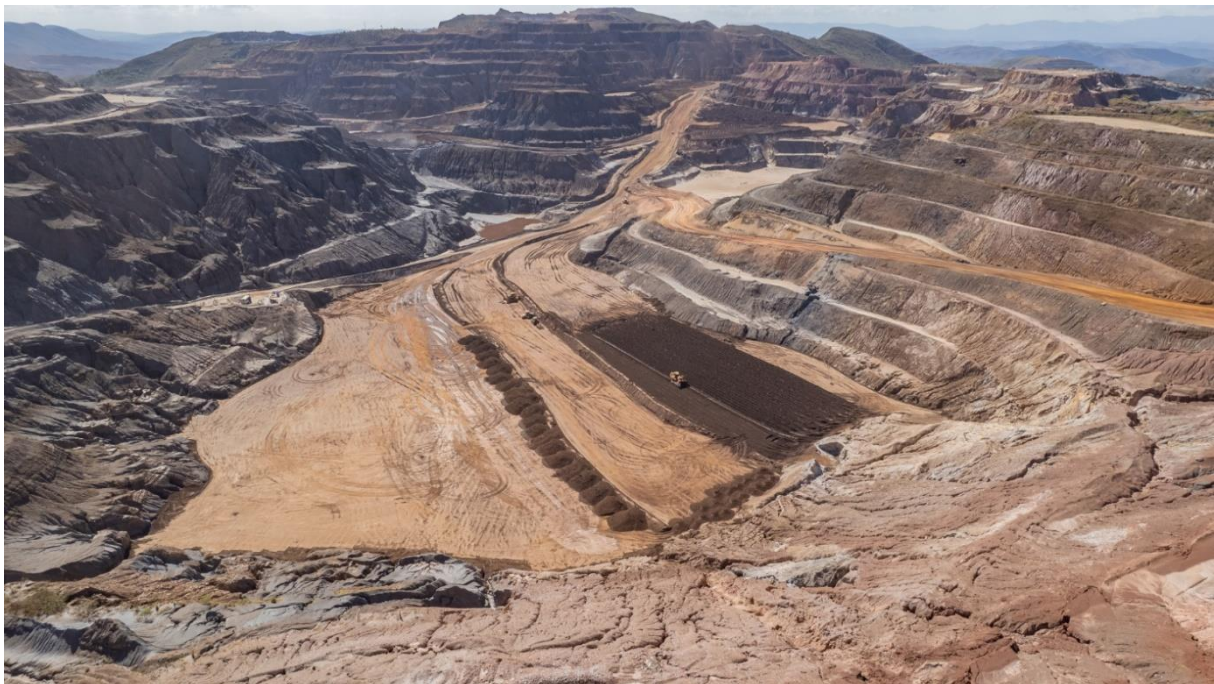
Foto 22. Disposição definitiva do rejeito da barragem de Grupo na Cava 5 (Julho/24).
