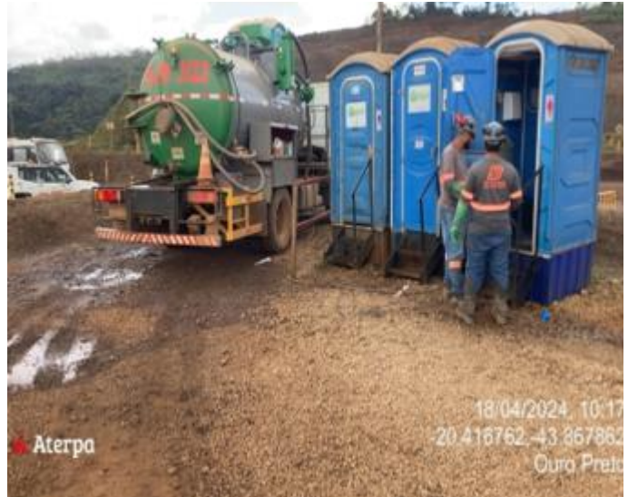
Foto 46. Limpeza e higienização dos banheiros químicos.. Fonte: Vale, abril, 2024.
