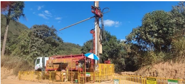
Foto 33. Praça de trabalho perfuração do poço tubular PPGR 01
