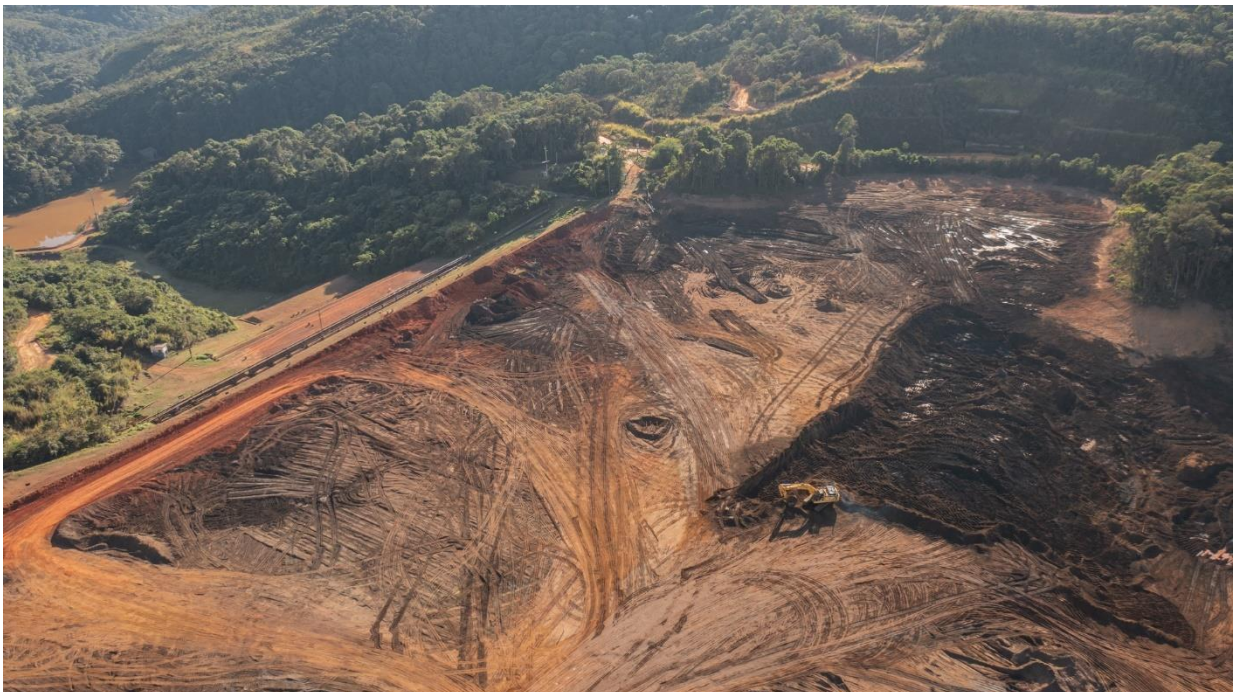
Foto 5. Escavação de rejeitos - Etapa 3.2 - Área 1 (Julho/24).
