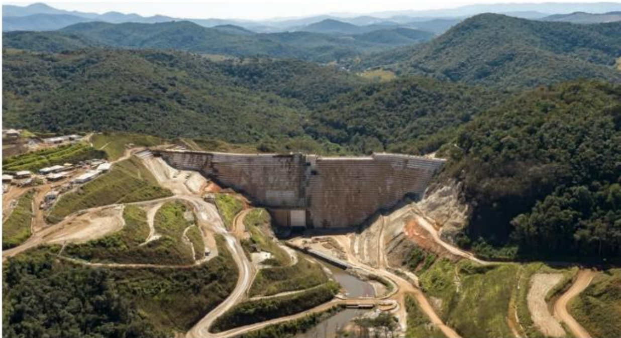
Foto 59. Estrutura de Contenção a Jusante Fábrica. Fonte: Vale, 2022.
