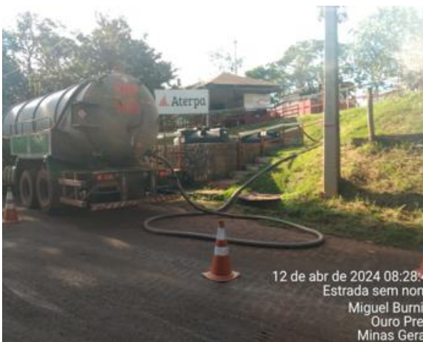
Foto 45. Limpeza do tanque séptico instalado no canteiro Grupo. Fonte: Vale, abril 2024.
