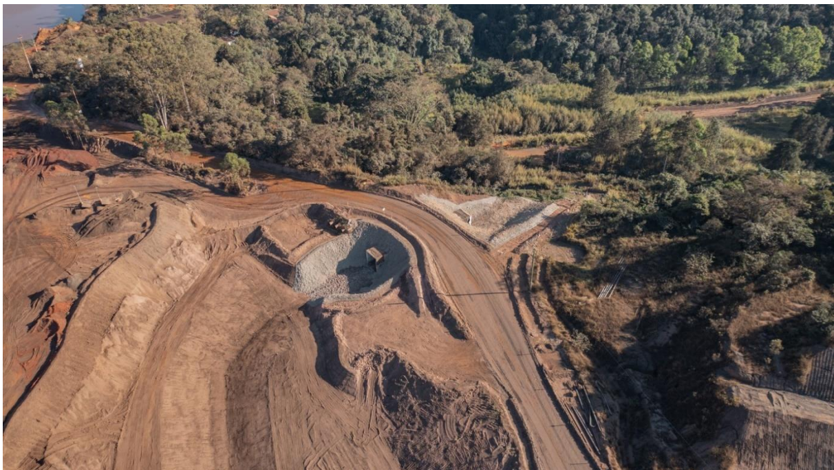
Foto 16: Conclusão do extravasor da Cava 10,5 (Julho/24).
