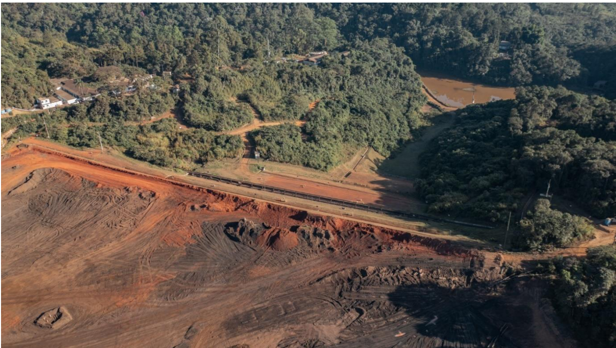
Foto 11. Rebaixamento de instrumentos (Julho/24).
