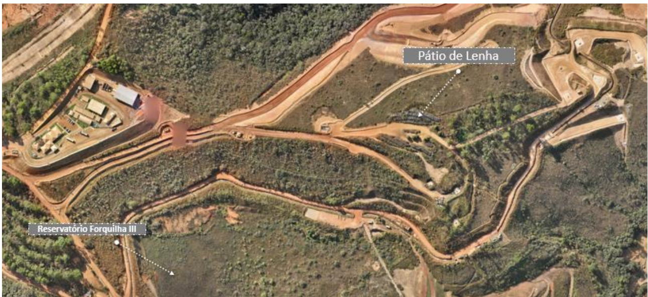
Figura 10. Pátio de lenhas - disposição do material suprimido
