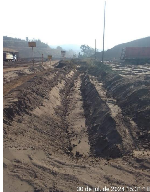
Foto 13. Status de limpeza dos canais de cintura (Julho/24) – REC. GR-0108
