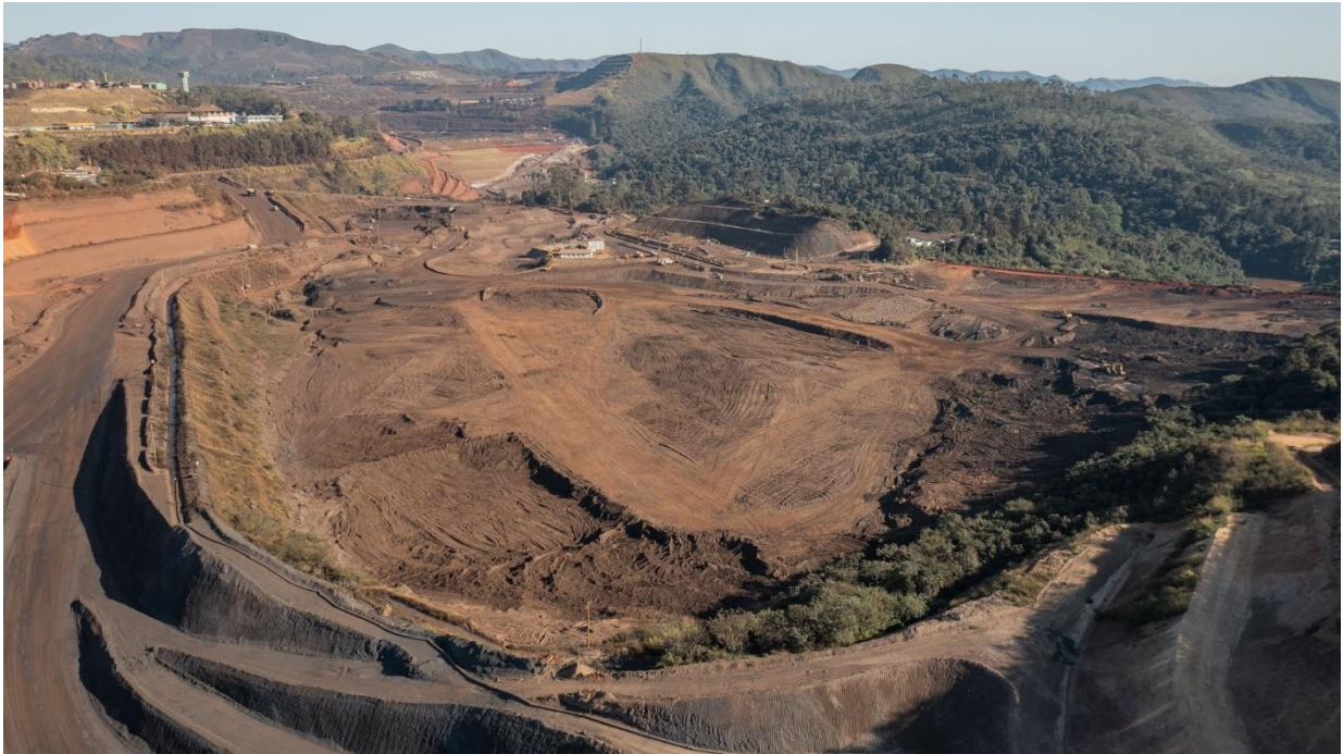
Foto 4. Escavação de rejeito no reservatório período seco (Julho/24).
