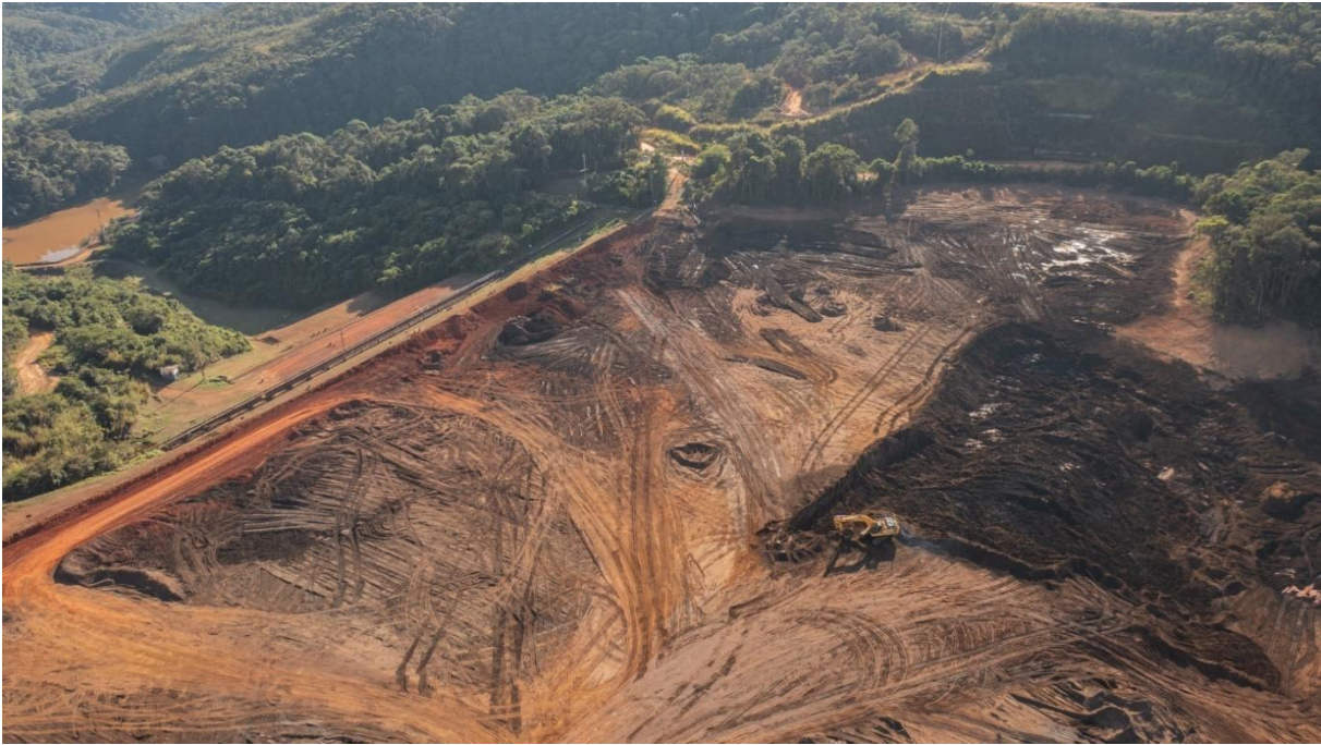
Foto 10: Remoção de estruturas abandonadas e sucatas no maciço e reservatório da barragem de Grupo (Julho/24).
