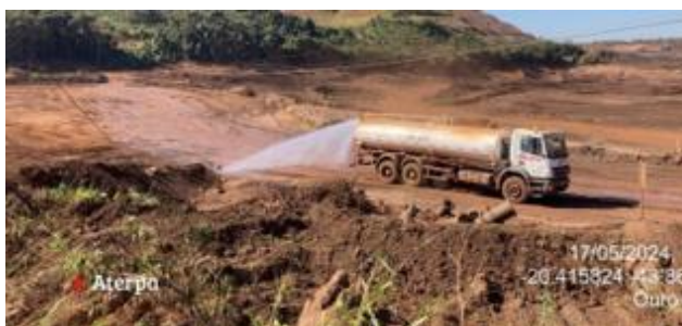
Foto 37. Aspersão nos acessos (Fonte: Vale, maio, 2024).
