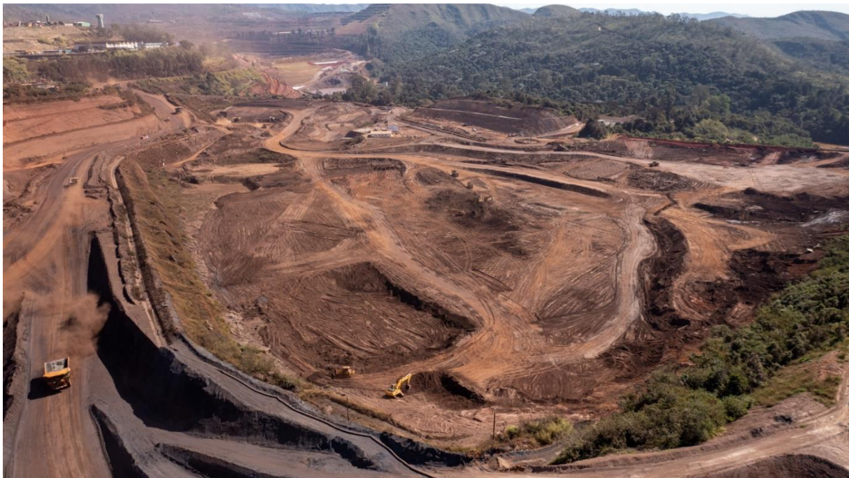
Foto 20: Escavação do sump de montante e rejeitos no reservatório (Junho/24).
