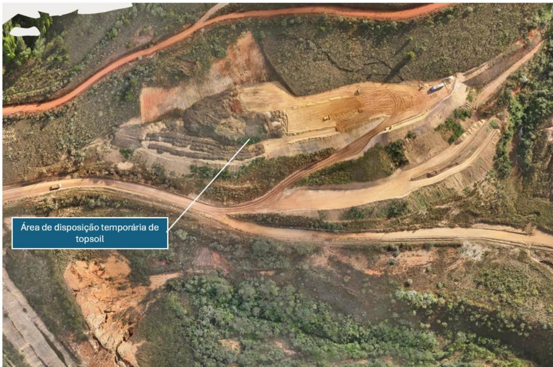
Figura 8. Bota fora Forquilha V – evidência de disposição do topsoil (Julho/2024).
