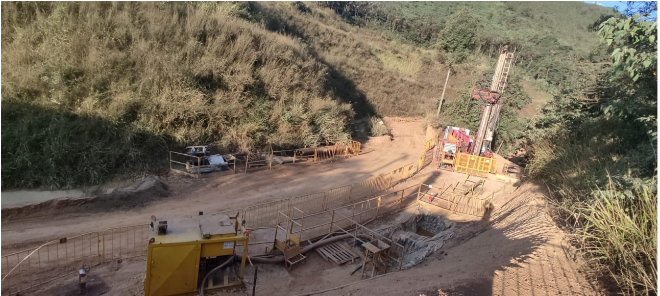
Foto 8. Praça de perfuração do poço PP-GR-01 (Julho/24).
