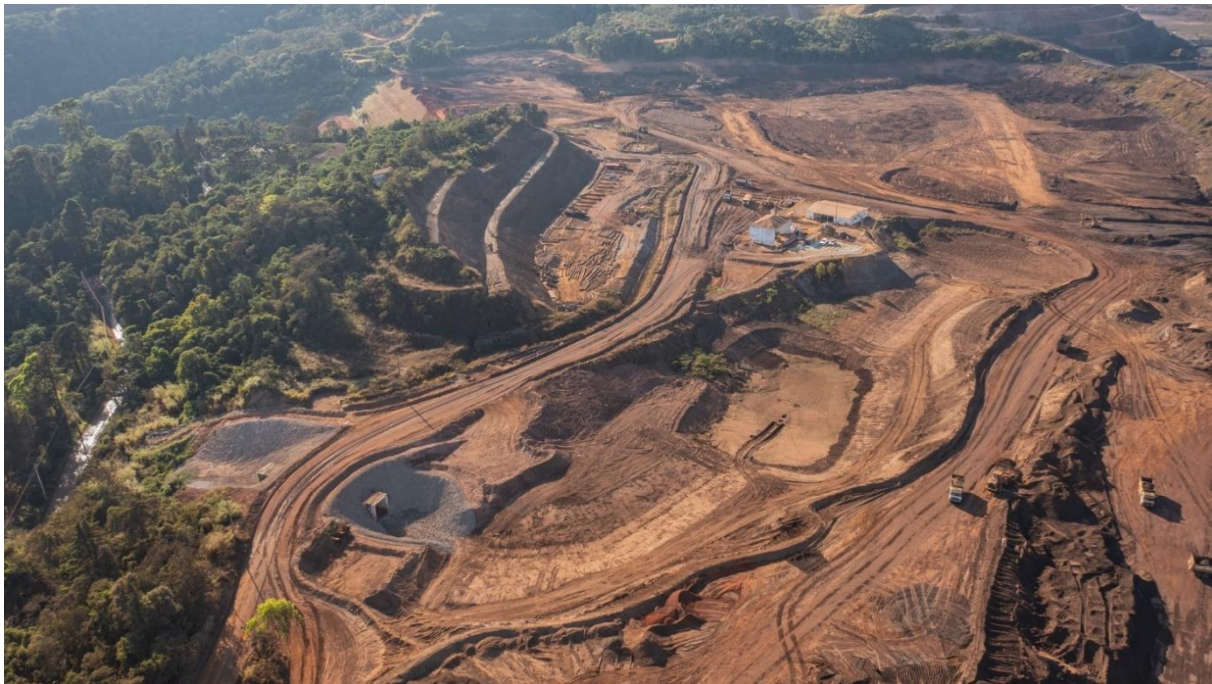
Foto 6. Canal extravasor Cava 10,5 sem fluxo de água (Julho/24).
