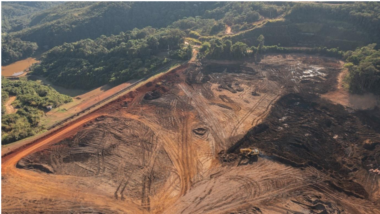
Foto 19. Escavação dos rejeitos na Etapa 3.2 - Área 1 (Julho/24).
