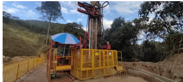
Foto 34. Atividade de perfuração do poço PPGR 01
