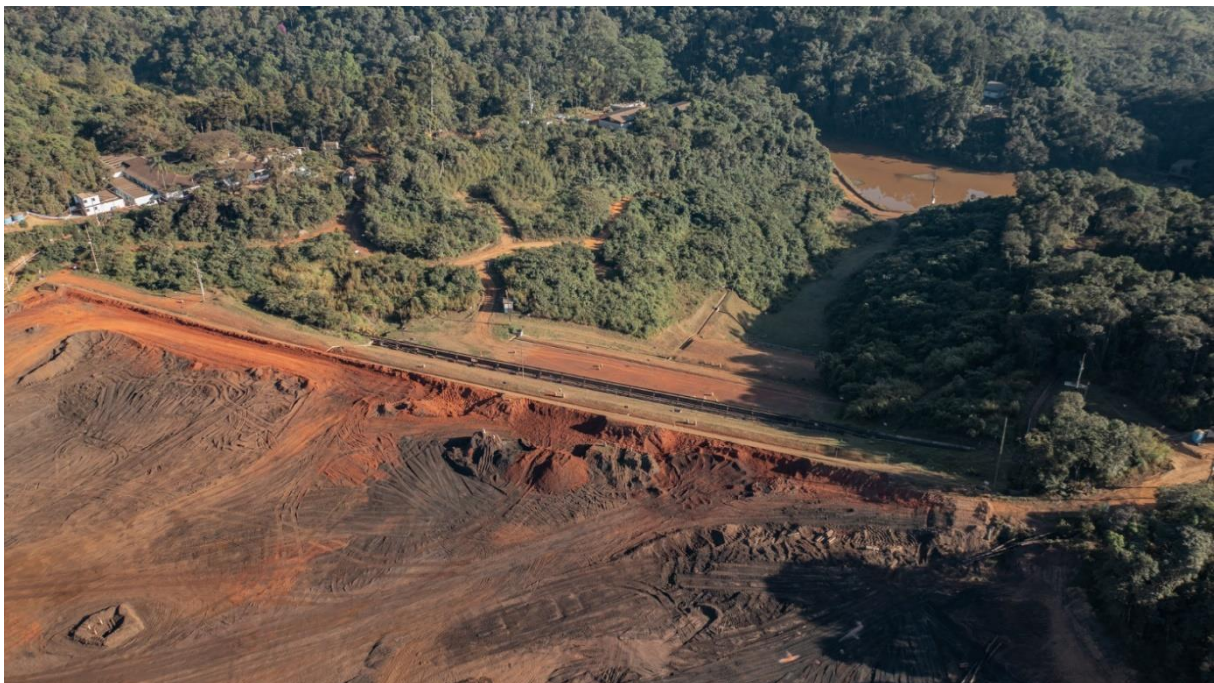
Foto 18. Remoção de sucatas no reservatório (Julho/24) – REC GR-0073
