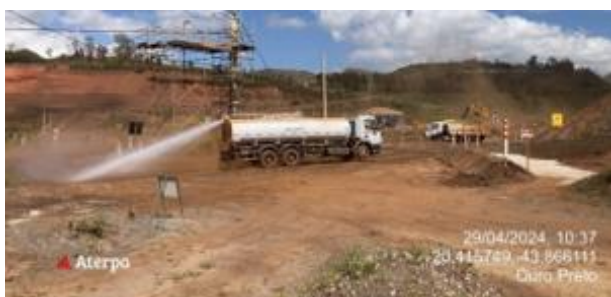
Foto 35. Uso de caminhão pipa para umectação das vias (Fonte: Vale, abril, 2024).
