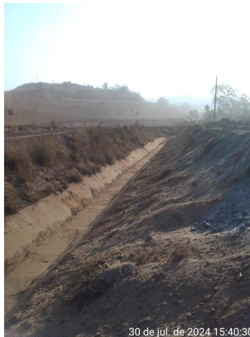
Foto 14. Status de limpeza dos canais de cintura (Julho/24) – REC. GR-0108
