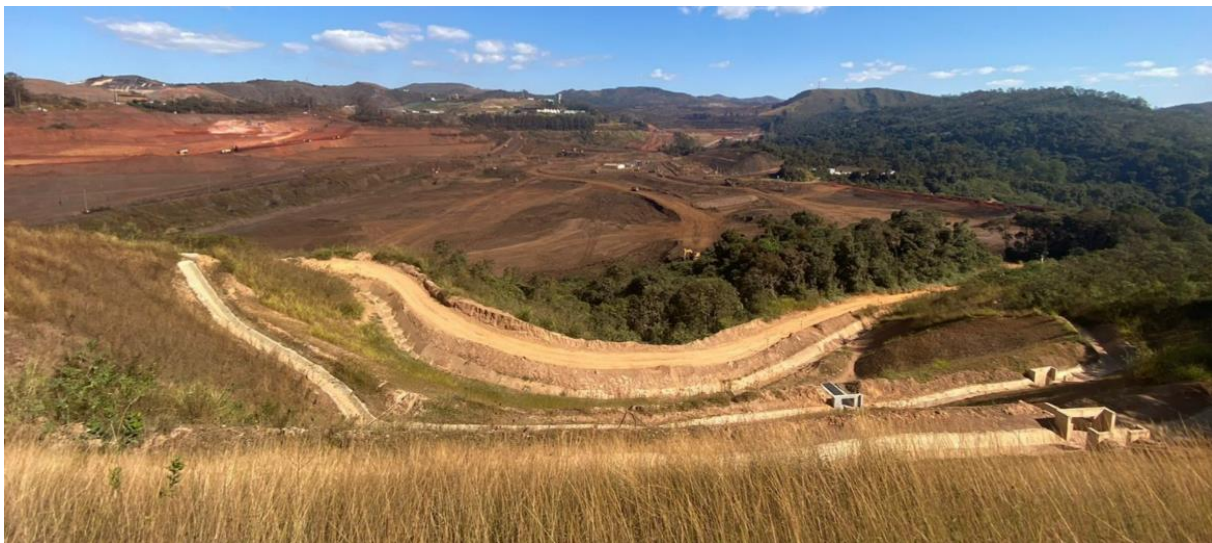
Foto 30. Status de limpeza dos canais de cintura (Julho/24).
