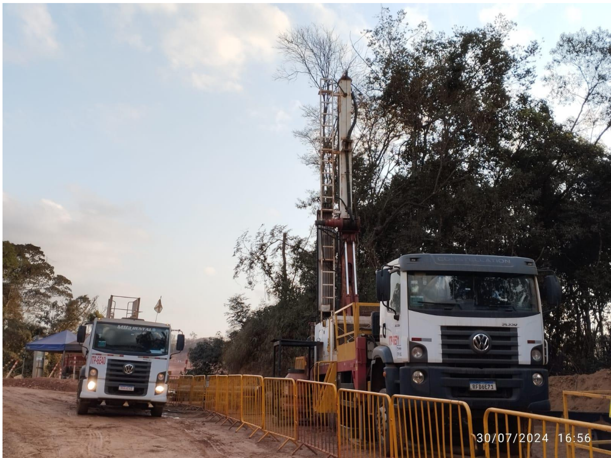
Foto 26. Mobilização da praça para perfuração do poço PP-GR-02 (Julho/24).
