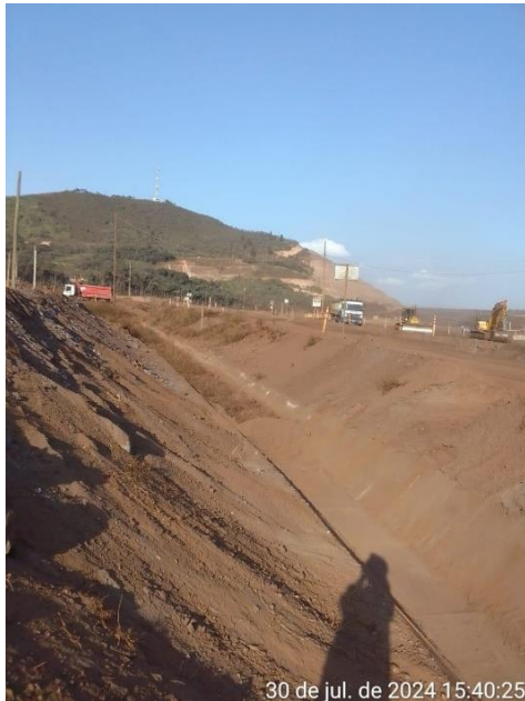
Foto 12. Status de limpeza dos canais de cintura (Julho/24) – REC. GR-0108
