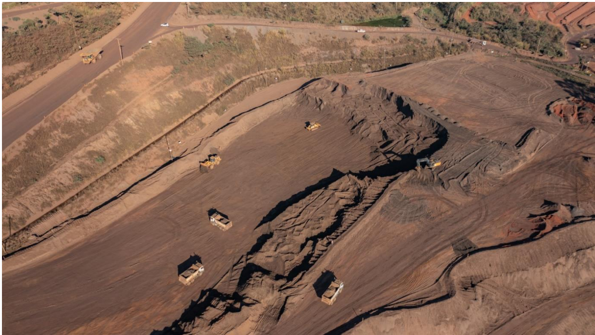
Foto 21. Carga e transporte de rejeito da Cava 10,5 com destinação a Cava 5 (Julho/24).
