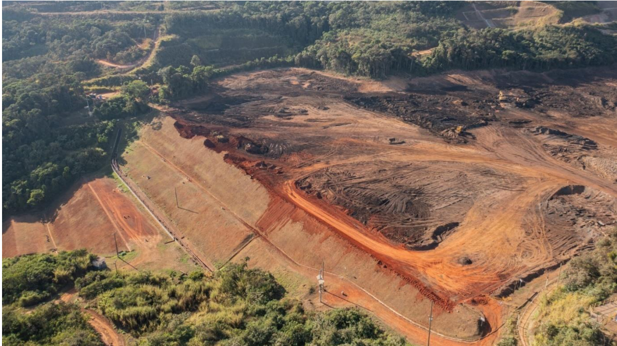
Foto 1. Remoção das sucatas próximas ao maciço da barragem (Julho/24) – REC. GR-0073.
