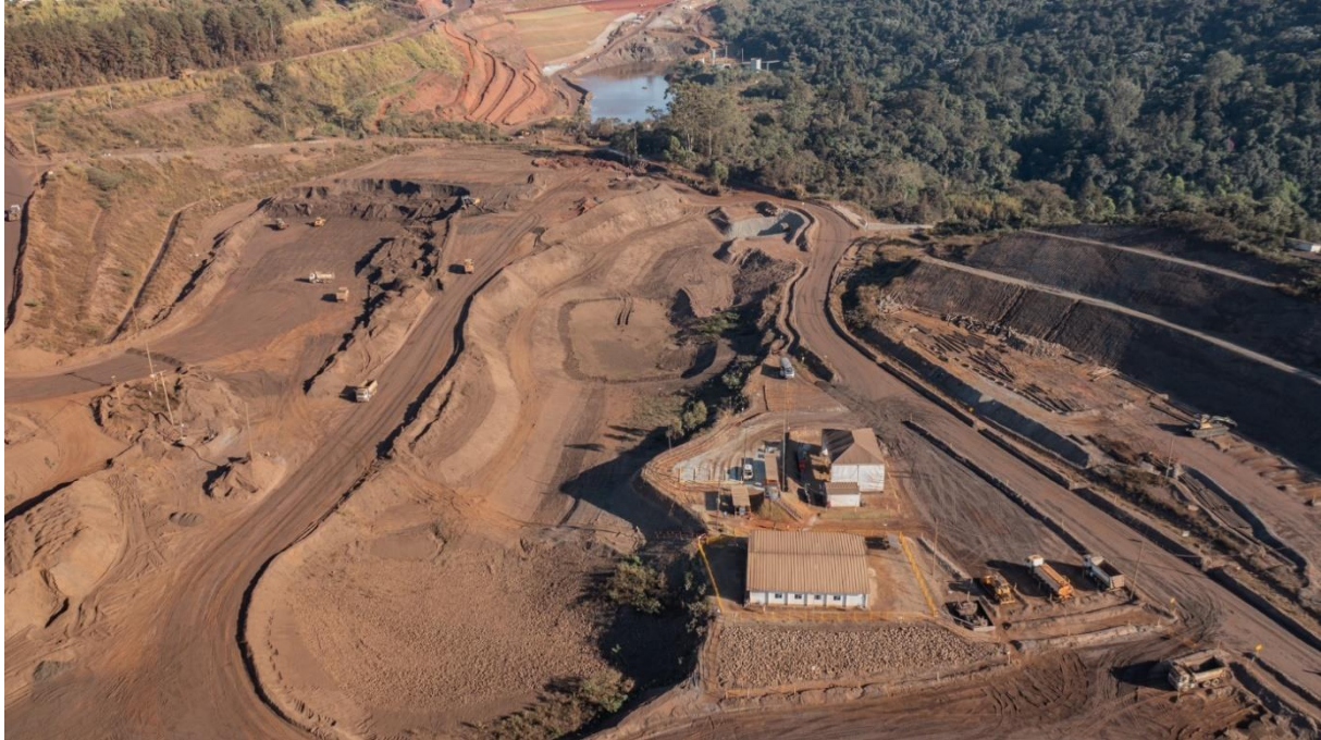
Foto 17. Manutenção da drenagem na Cava 10,5 (Julho/24)
