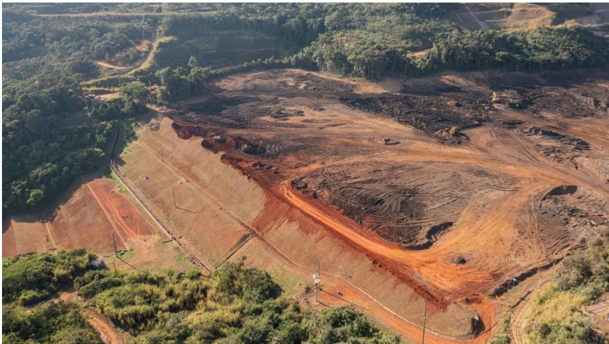
Foto 24. Escavação dos rejeitos da Etapa 3.1
