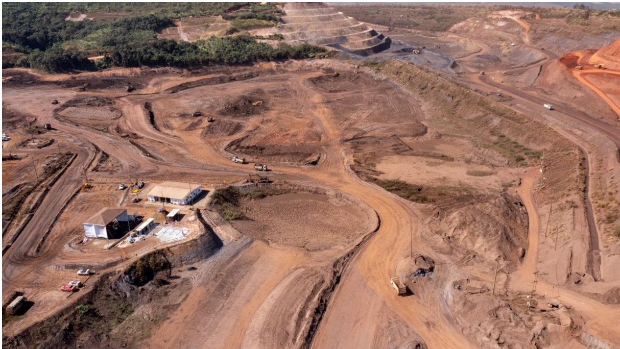
Foto 23. Desmobilização do sistema de bombeamento no reservatório (Junho/24)
