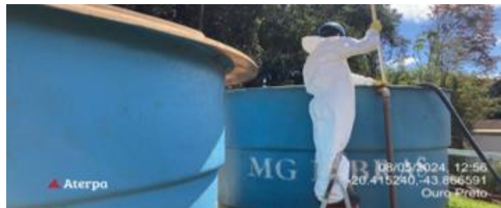
Foto 56. Limpeza da caixa D' água . Fonte: Vale, maio de 2024.
