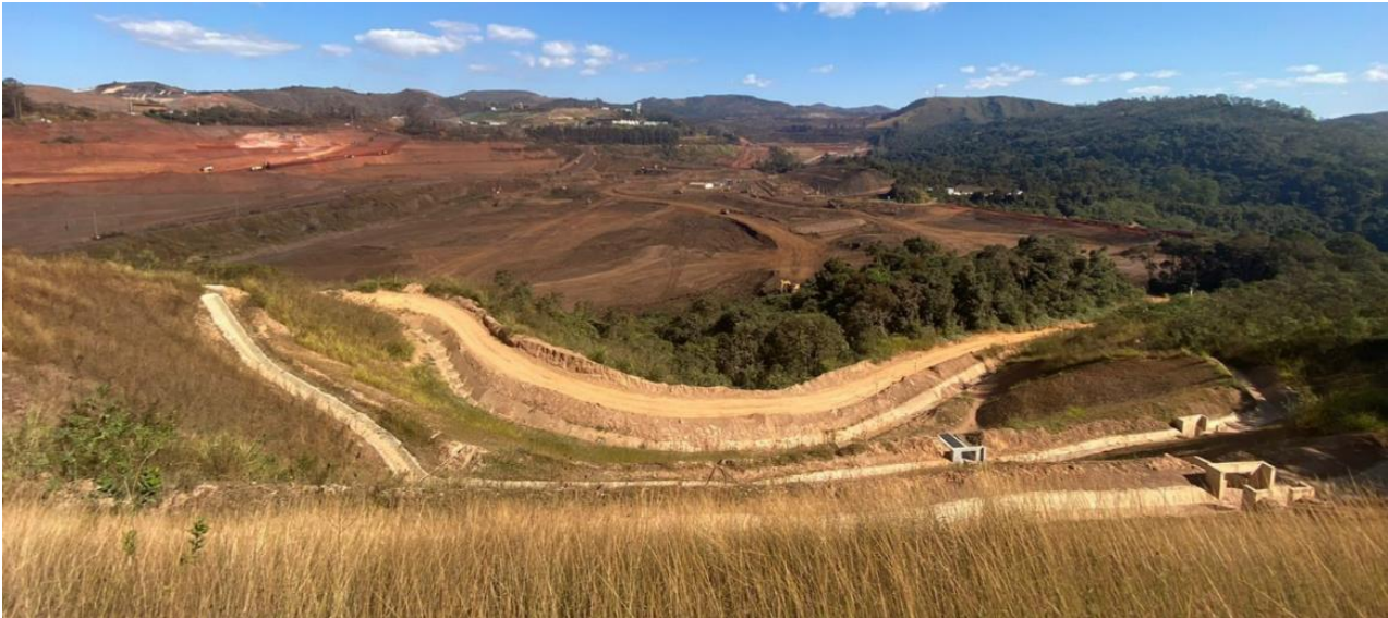
Foto 15. Status de limpeza dos canais de cintura (Julho/24).
