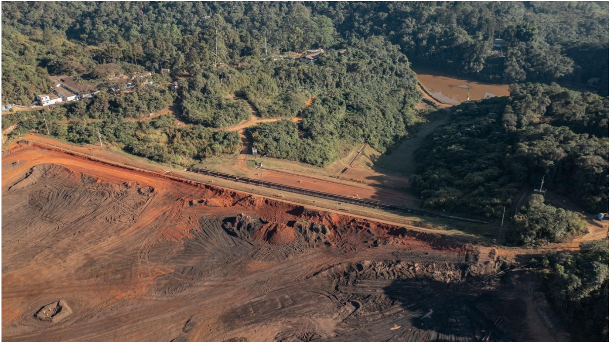
Foto 25. Rebaixamento dos instrumentos na crista da barragem.
