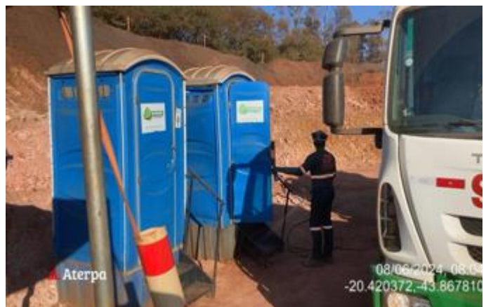
Foto 48. Sucção de efluentes de banheiro químico nas frentes de obra. Vale, Junho 2024.
