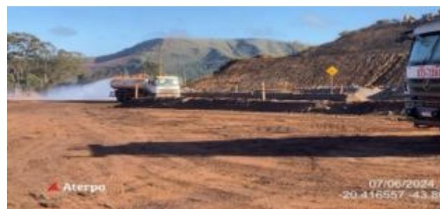
Foto 38. Aspersão frentes de obras da contratada Aterpa (Fonte: Vale, junho, 2024).
