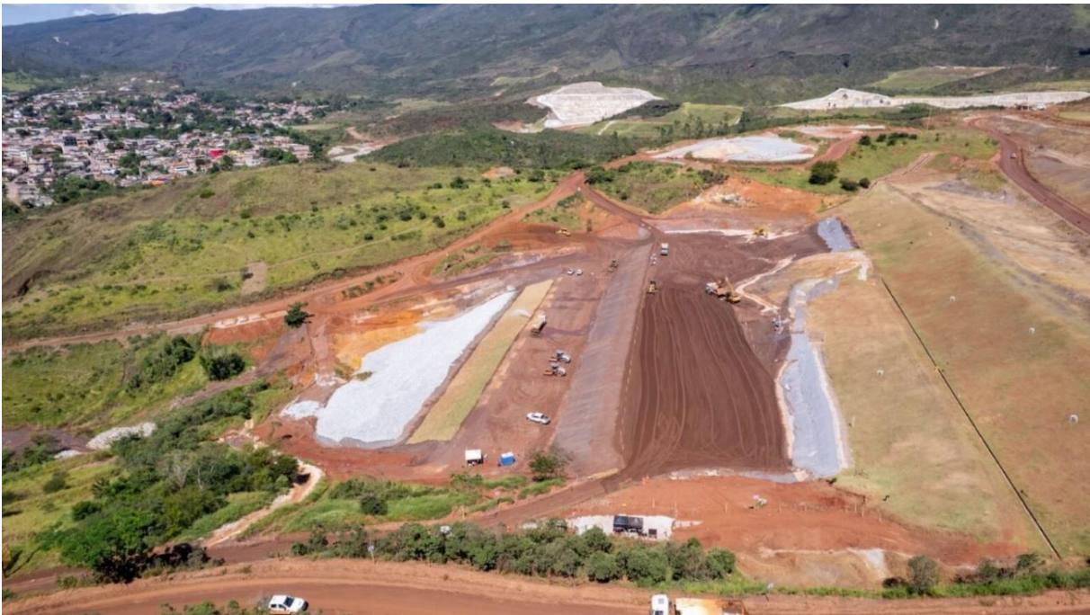
Foto 8. Tratamento da fundação do Dique 1 – foto dia 24/04/24 (Concluído).
