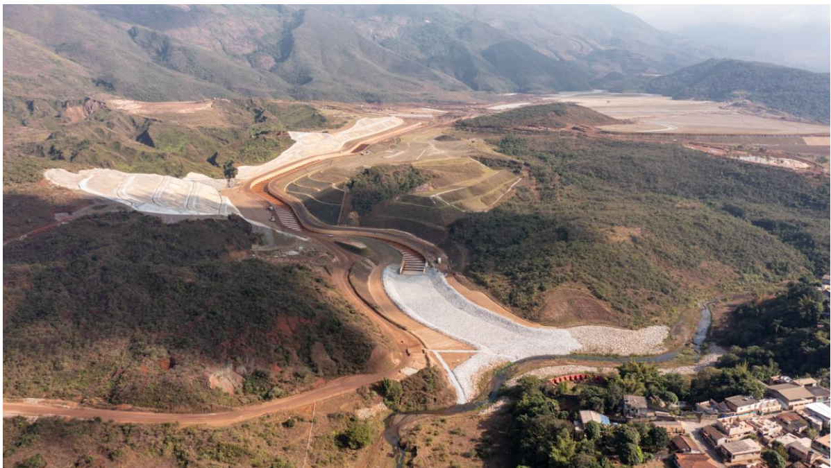
Foto 1. Obra bacia de restituição (03/07/24).
