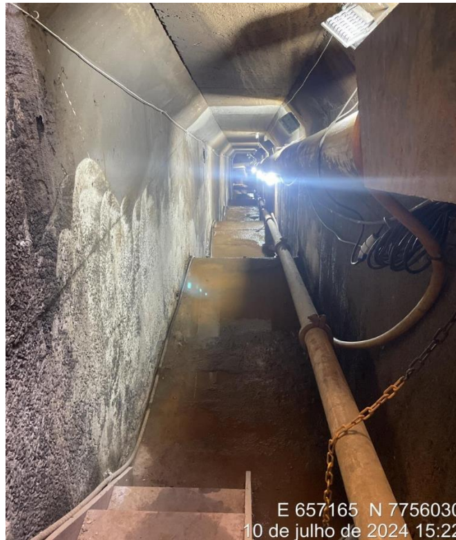
Foto 4. Tamponamento da Tulipa Foto 10/07/24 (Em andamento) - Término previsto – 11/04/2025.
