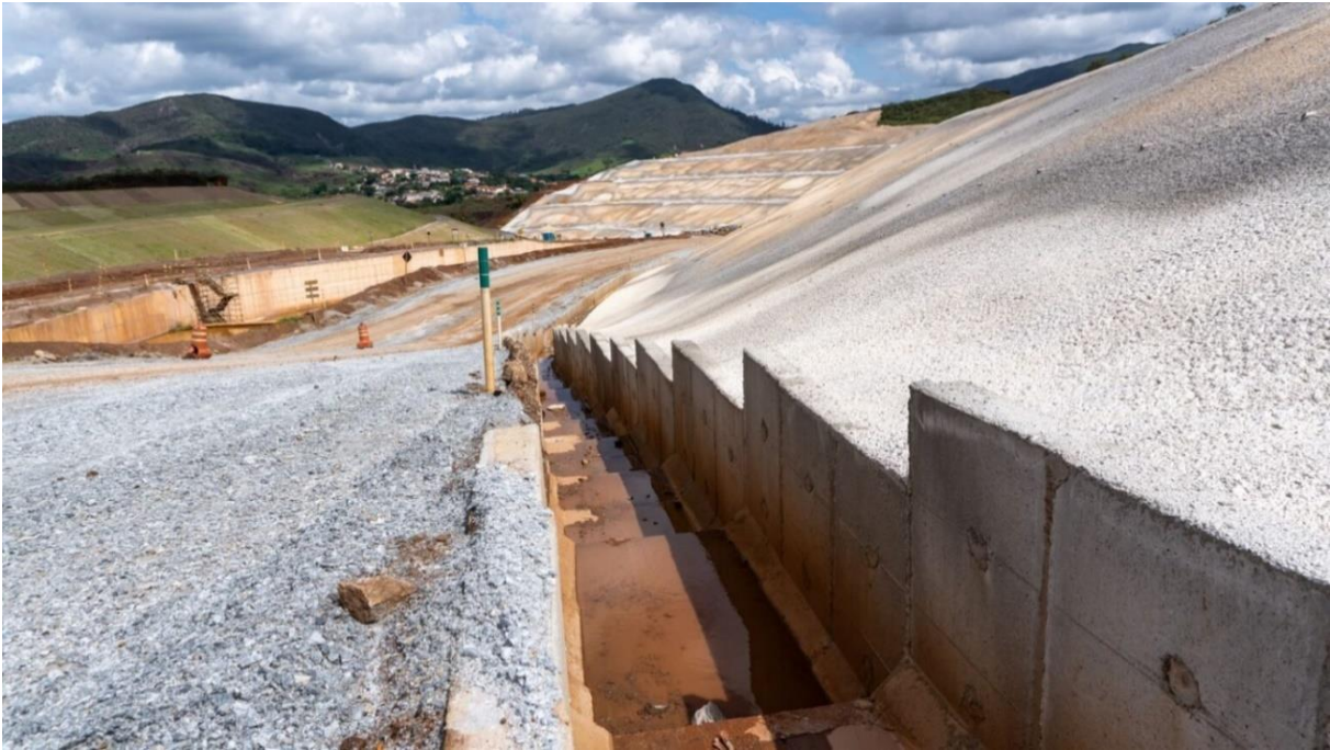
Foto 7. Recuperação de taludes (Concluída) foto dia 13/12/23.
