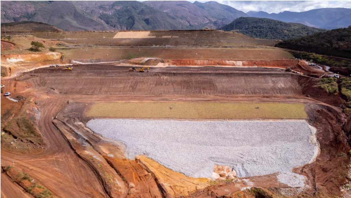
Foto 9. Aterro do reforço do Dique 1 – foto dia 03/07/24 (Em andamento) – Término previsto – 27/01/2027.
