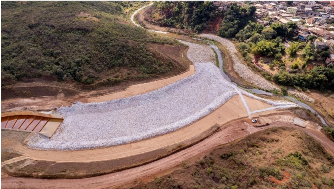
Foto 14. Bacia de dissipação do canal extravasor. Fonte: Vale, julho/24.
