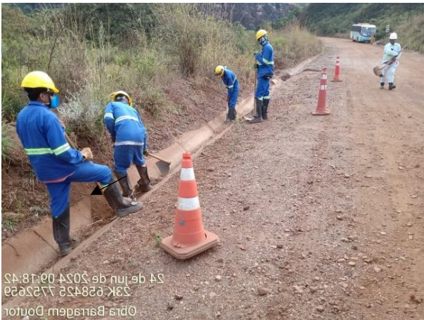
Foto 10 e Foto 11. Canaletas do acesso da MG 129. Nota-se o bom estado de conservação das estruturas de drenagem. Fonte: Vale, julho/24.
