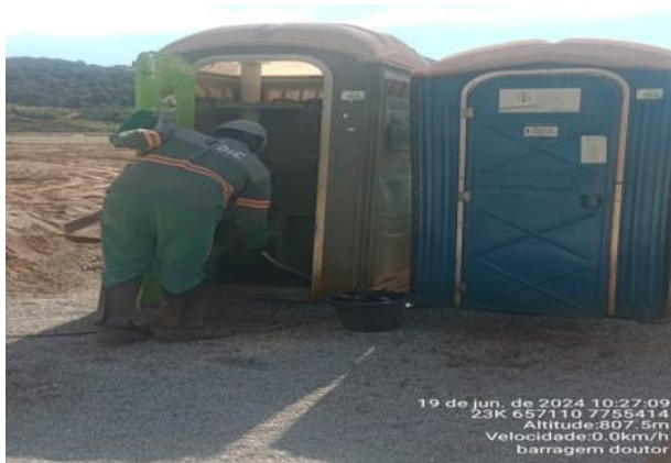
Foto 42. Limpeza de banheiro químico. Fonte: Vale, (06/2024).
