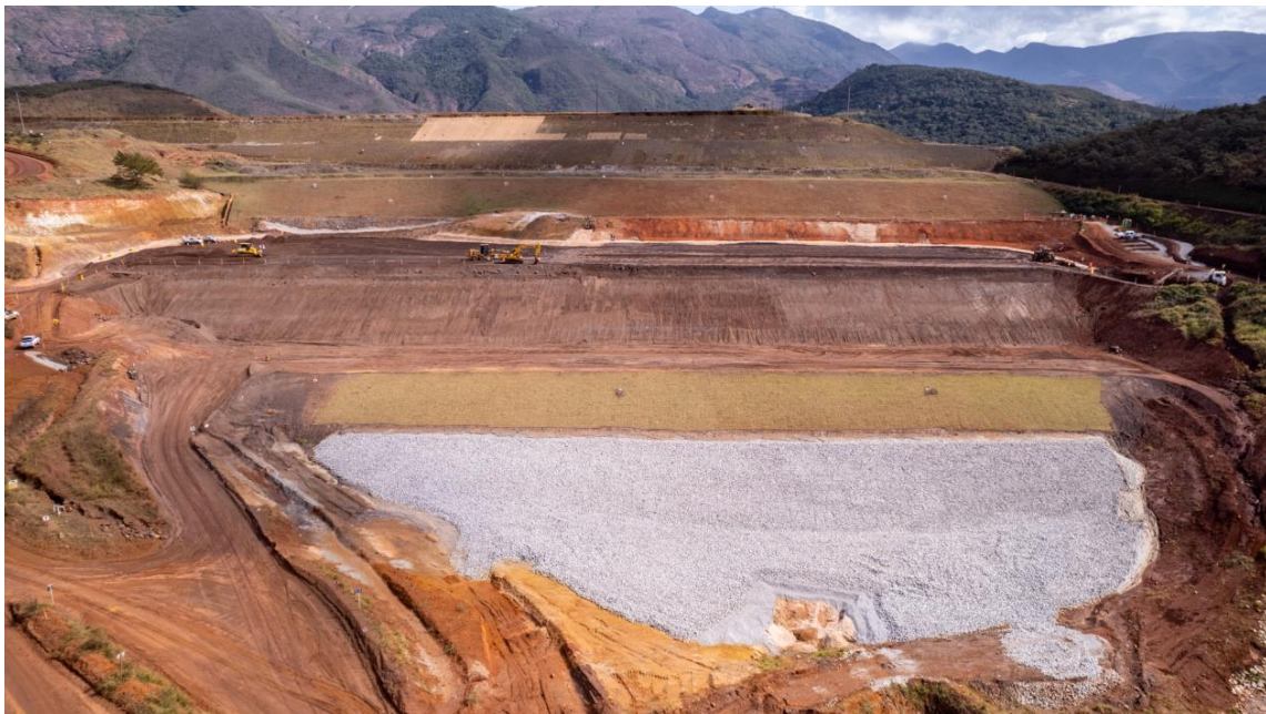
Foto 3. Tratamento de fundação do Dique 1 (Imagem de 03/07/24).
