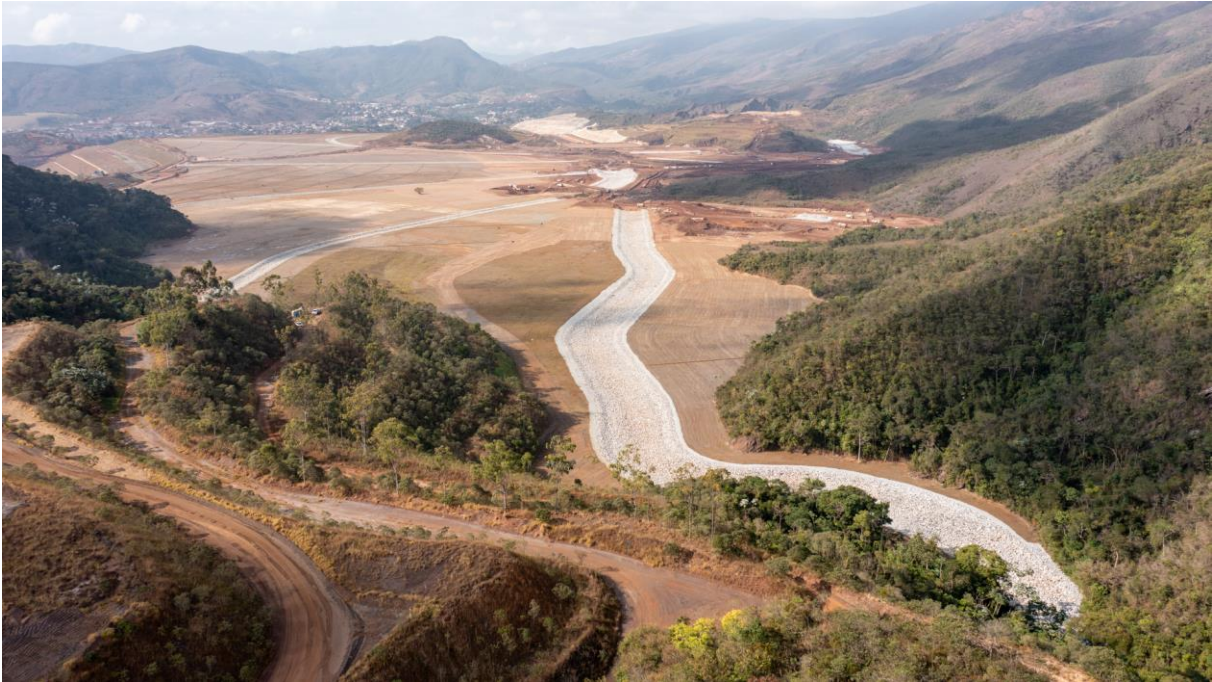
Foto 5. Reconformação do reservatório – Canal 1 foto dia 03/07/24 (Em andamento).
