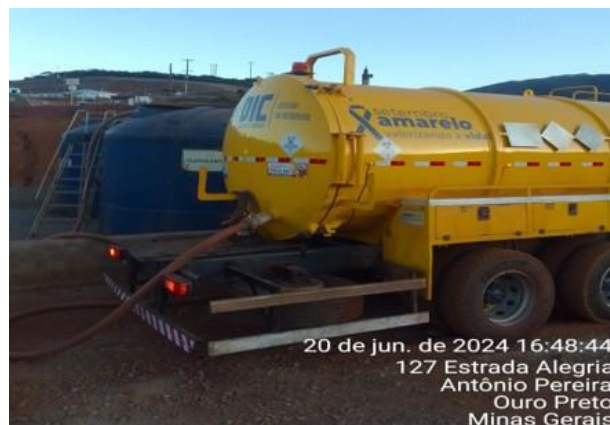
Foto 43. Limpeza de tanque séptico. Fonte: Vale, (06/2024).
