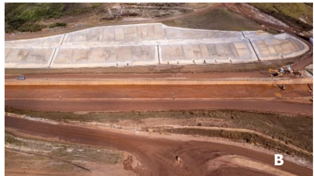
Foto 12 e Foto 13. Canaletas e escada hidráulica para drenagem do (A) Talude 3 e (B) Talude 4. Fonte: Vale, julho/24.
