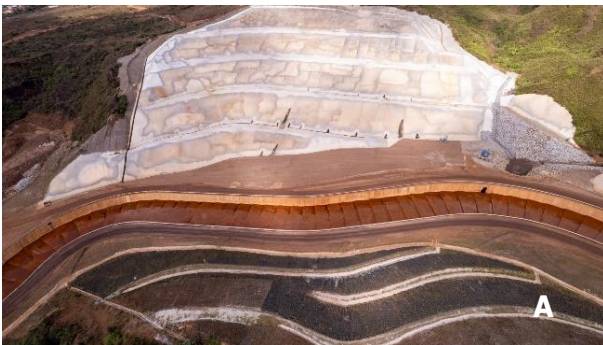
Foto 12 e Foto 13. Canaletas e escada hidráulica para drenagem do (A) Talude 3 e (B) Talude 4. Fonte: Vale, julho/24.
