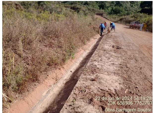
Foto 10 e Foto 11. Canaletas do acesso da MG 129. Nota-se o bom estado de conservação das estruturas de drenagem. Fonte: Vale, julho/24.
