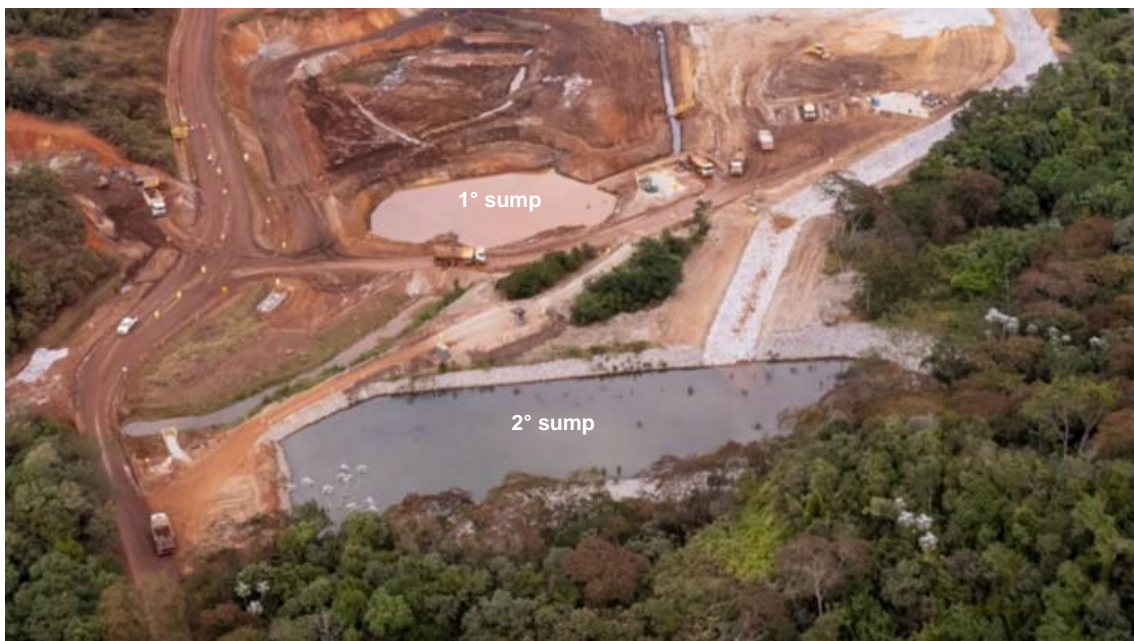
Foto 15. Sump's do maciço principal. Fonte: Vale, julho/24.
