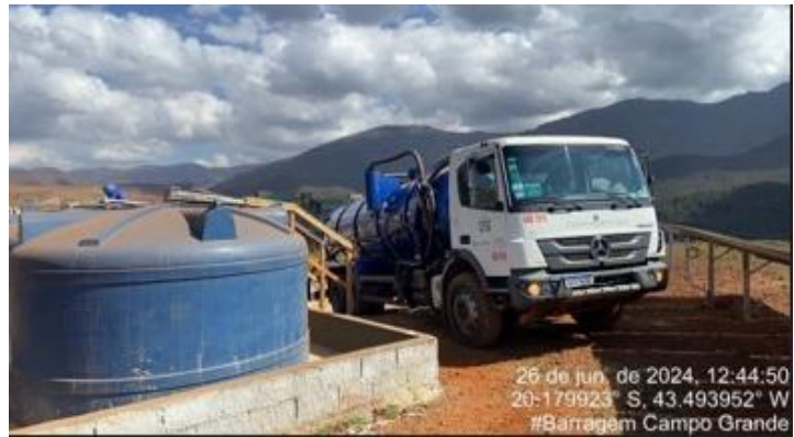
Foto 39. Sucção de efluente sanitário. Fonte: Vale, julho/2024
