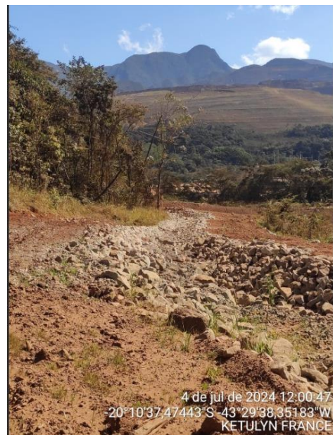
Foto 11. Aspecto da drenagem com pedras de mão para reduzir a velocidade de escoamento superficial da drenagem pluvial. Fonte: Vale, julho/2024
