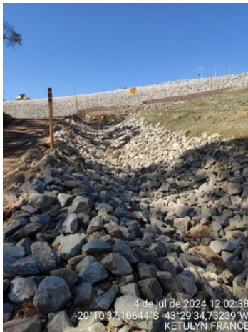
Foto 12. Aspecto da drenagem. Fonte: Vale, julho/2024
