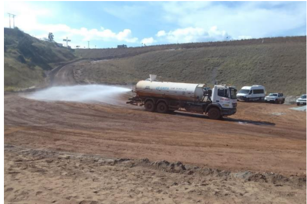
Foto 31. Umidificação de acesso. Fonte: Vale, julho/2024.
