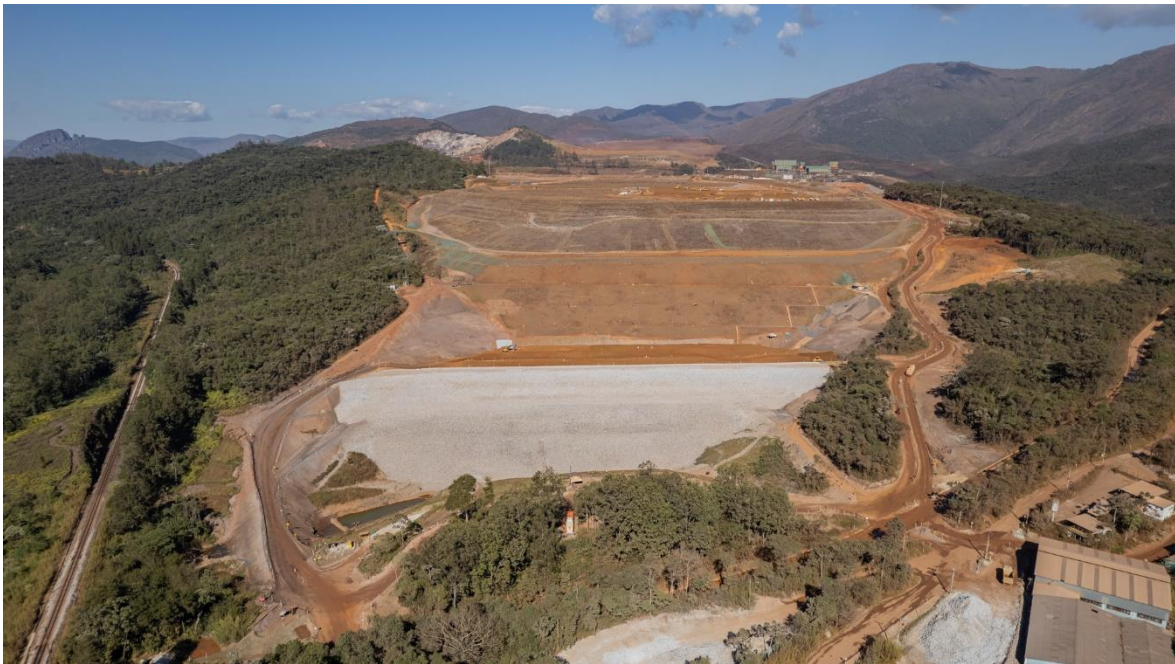
Foto 6. Obras no Maciço Principal – reforço em enrocamento e estéril.
