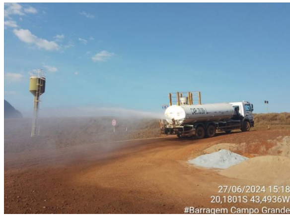
Foto 33. Umidificação de acesso próximo ao canteiro de obras. Fonte: Vale, julho/2024.
