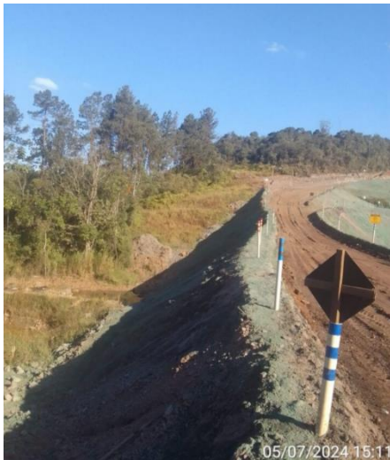
Foto 26. Aplicação de hidrossemeadura no acesso da ombreira direita. Fonte: Vale, julho/2024.
