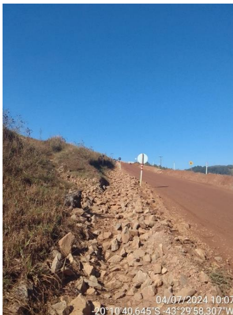
Foto 10. Aspecto da drenagem com pedras de mão. Fonte: Vale, julho/2024.
