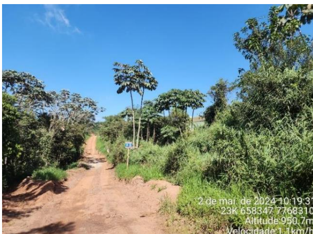
Foto 18. Área de supressão vegetal na ombreira direita da Barragem de campo Grande. Fonte: Vale, julho/2024.
