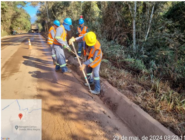
Foto 14. Limpeza de canaleta. Fonte: Vale, julho /2024
