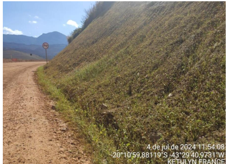
Foto 27. Vista parcial da germinação em talude. Fonte: Vale, 2024.
