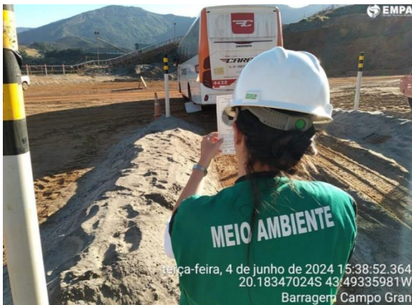
Foto 34. Controle de emissões atmosféricas junto aos equipamentos movidos a diesel na obra da barragem Campo Grande. Fonte: Vale, julho/2024.
