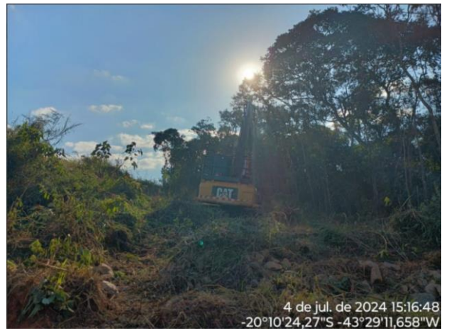
Foto 23. Supressão mecanizada na ombreira esquerda do reservatório. Fonte: Vale, 2024.
