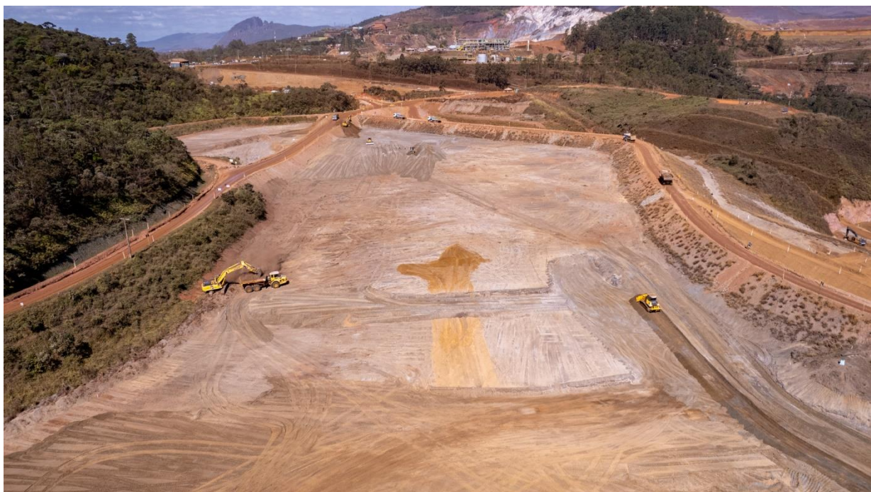
Foto 9. Obras no Regreide – limpeza e escavação.
