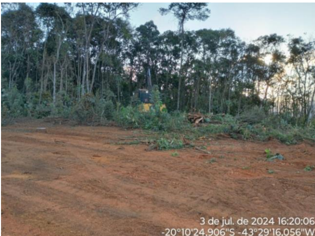
Foto 22. Supressão mecanizada ombreira esquerda. Fonte: Vale, julho/2024.
