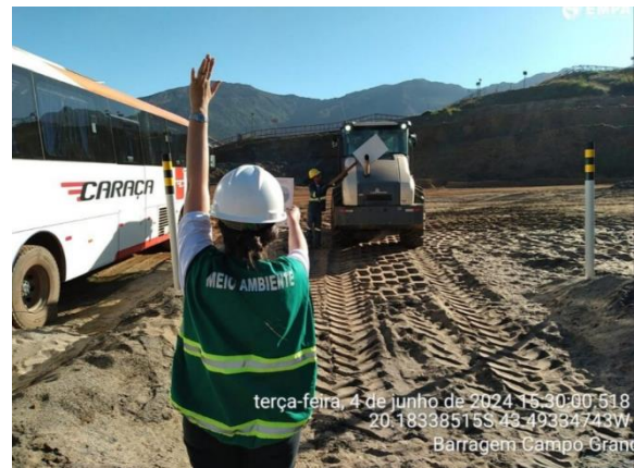
Foto 35. Controle de emissão atmosférica. Fonte: Vale, julho/2024.
