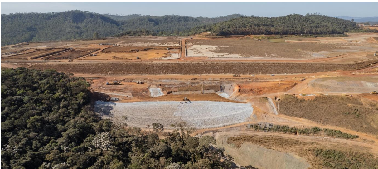
Foto 7. Obras no Dique de Sela – reforço em enrocamento e estéril.
