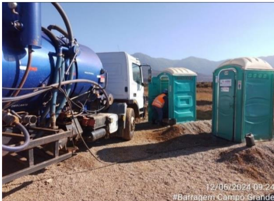
Foto 38. Limpeza de banheiro químico. Fonte: Vale, julho/2024.
