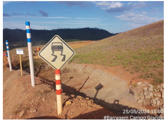
Foto 13. Desassoreamento de sump adjacente ao acesso. Fonte: Vale, julho/2024
