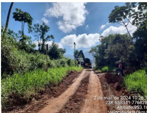
Foto 24. Supressão mecanizada na ombreira direita da barragem de campo Grande. Fonte: Bioma, 2024.
