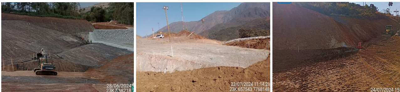
Foto 1, Foto 2 e Foto 3. Liberação de fundação Maciço Principal, Dique de Sela e Dique Norte Sul, respectivamente.
