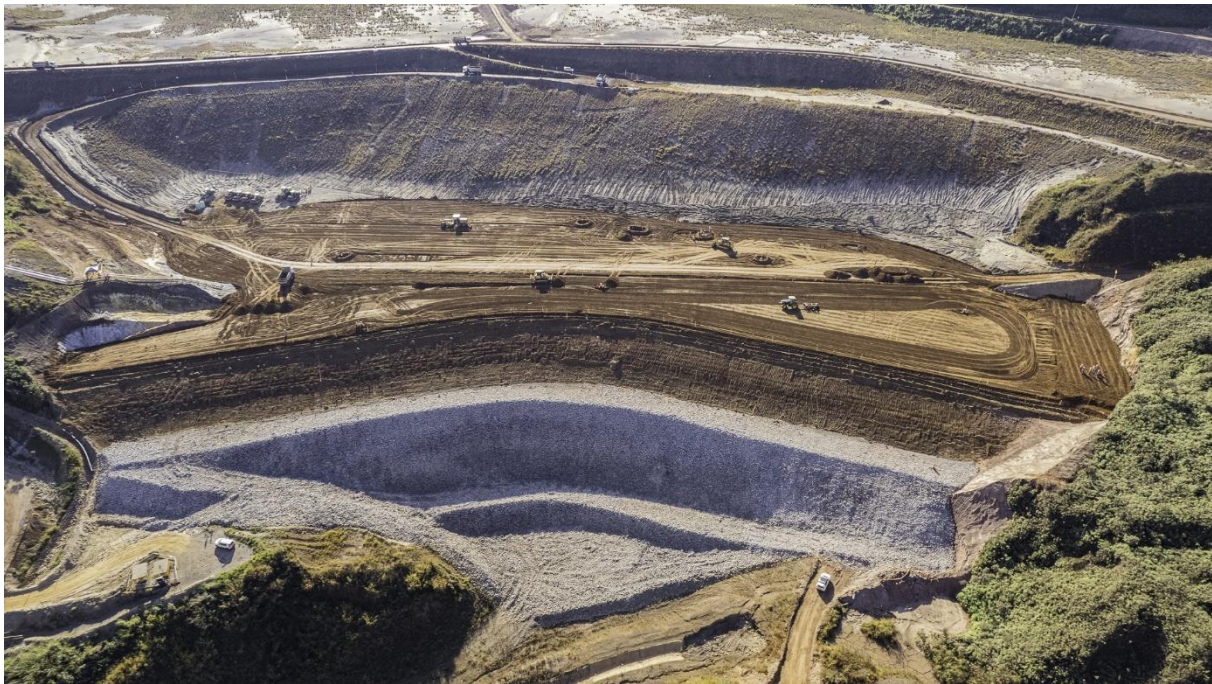
Foto 8. Obras no Dique Norte-Sul – reforço em enrocamento e estéril.
