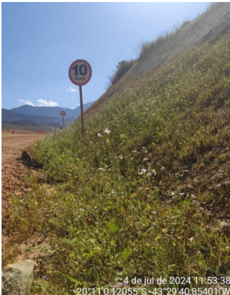
Foto 28. Detalhe da germinação do talude após a hidrossemeadura. Fonte: Vale, julho/2024.
