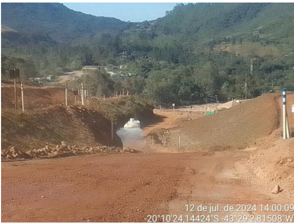
Foto 32. Umidificação de acesso. Fonte: Vale, julho/2024.
