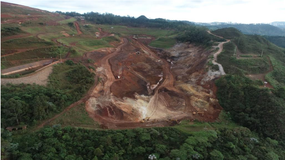
Foto 1. Finalização da descaracterização. (Fonte: Vale, maio 2024).
