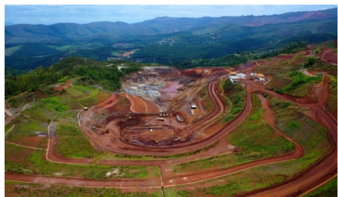
Foto 13. Vista da PDE-X após processo de revegetação bem estabelecido das ombreiras da barragem. (Fonte: Vale, janeiro de 2024)
