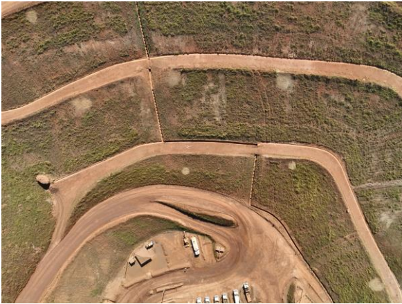
Foto 3. Canaletas e drenagens – PDE-X. (Fonte: Vale, 15 de julho de 2024).
