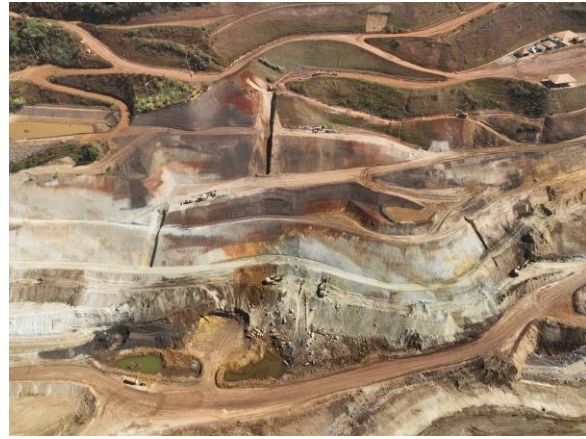
Foto 4. Vista da construção de canais de drenagem da ombreira direita. - Obras de execução do PRAD. (Fonte: Vale, 15 de julho de 2024).
