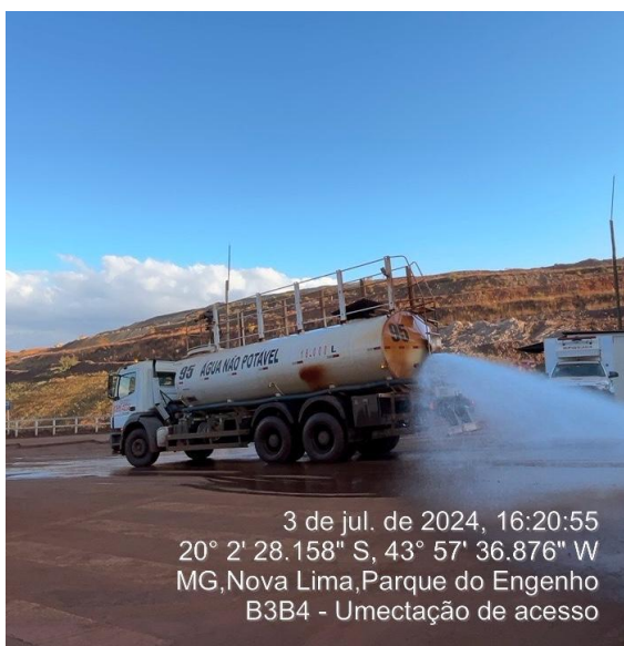
Foto 18. Umectação nos acessos ao canteiro. (Fonte: Vale, 03 de julho de 2024).
