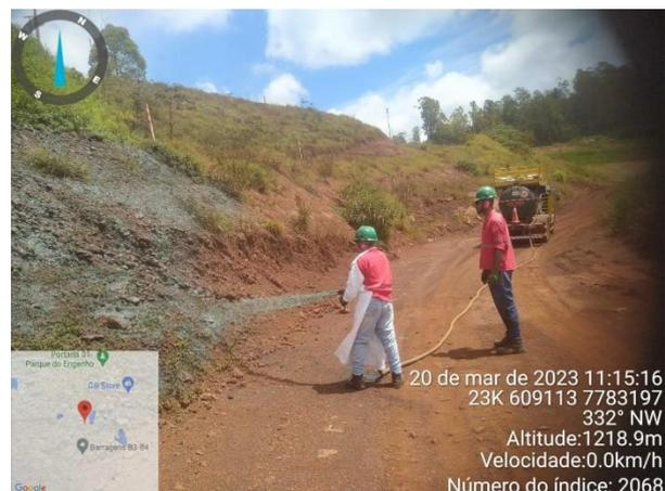
**Foto 22.** Aplicação de hidrossemeadura em taludes. (Fonte: Vale, 2023).
