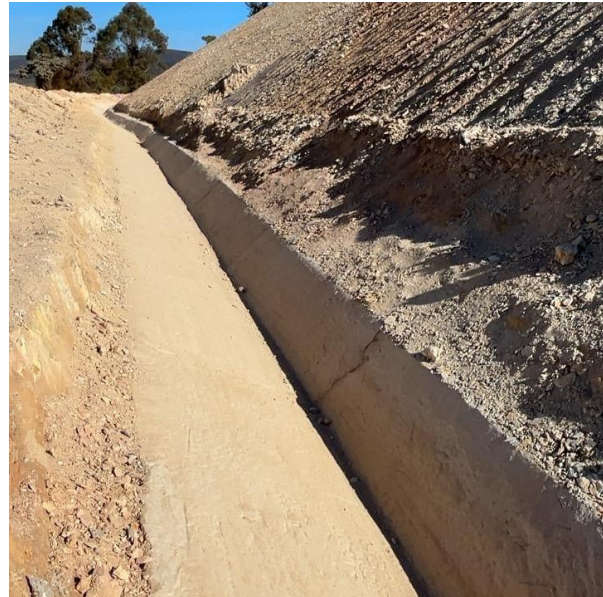
Foto 6. Execução de canaletas na ombreira direita - Obras de execução do PRAD (Fonte: Vale, julho de 2024).
