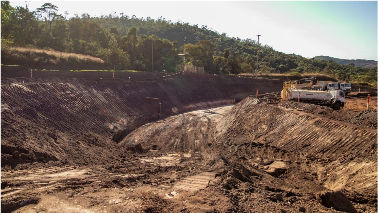
Foto 8. Escavação do canal de drenagem (Junho/24)
