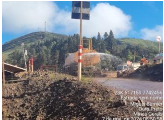
Foto 38. Caminhão pipa realizando aspersão das vias. Fonte: Vale, maio de 2024.
