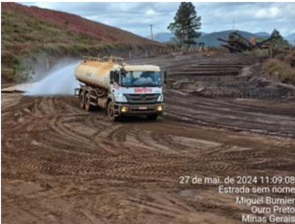
Foto 39. Aspersão de água nas vias, Fonte: Vale, maio de 2024.
