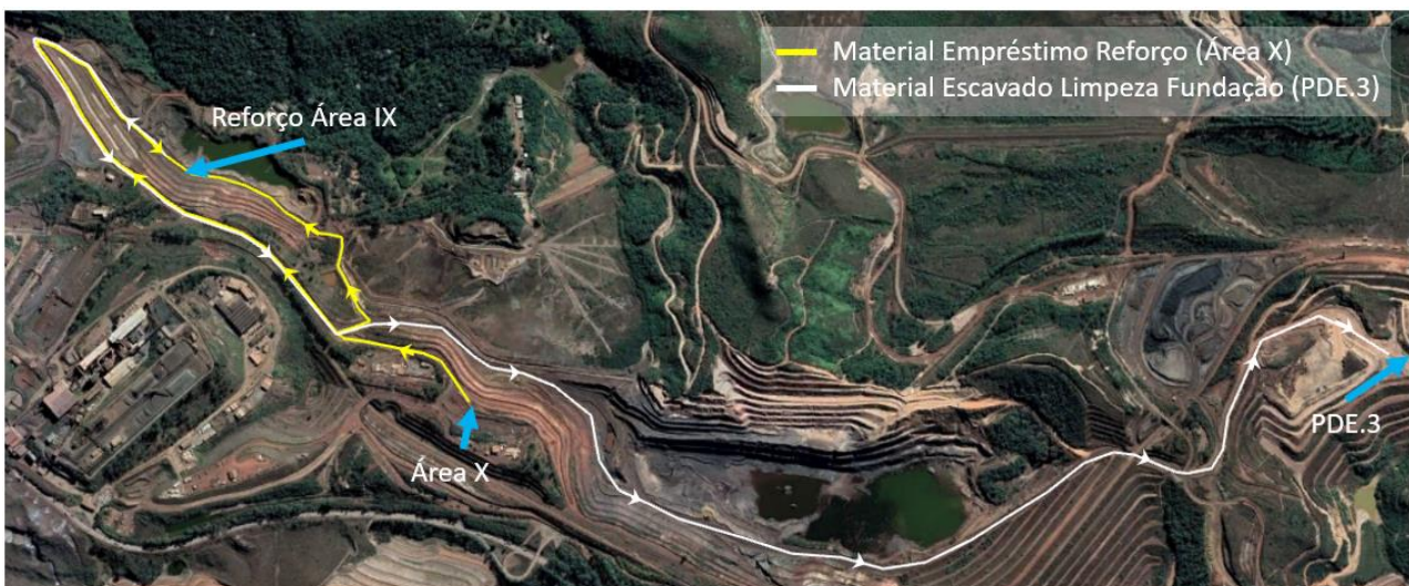
Figura 6. Movimentação de Terra
