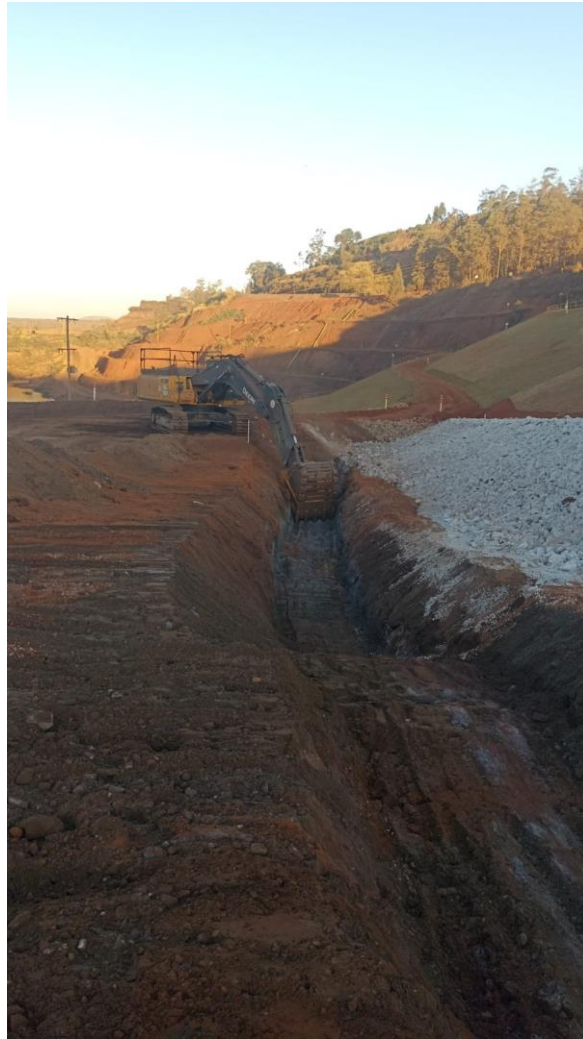
Foto 33. Início da escavação do canal periférico CP-01 (Julho/24).
