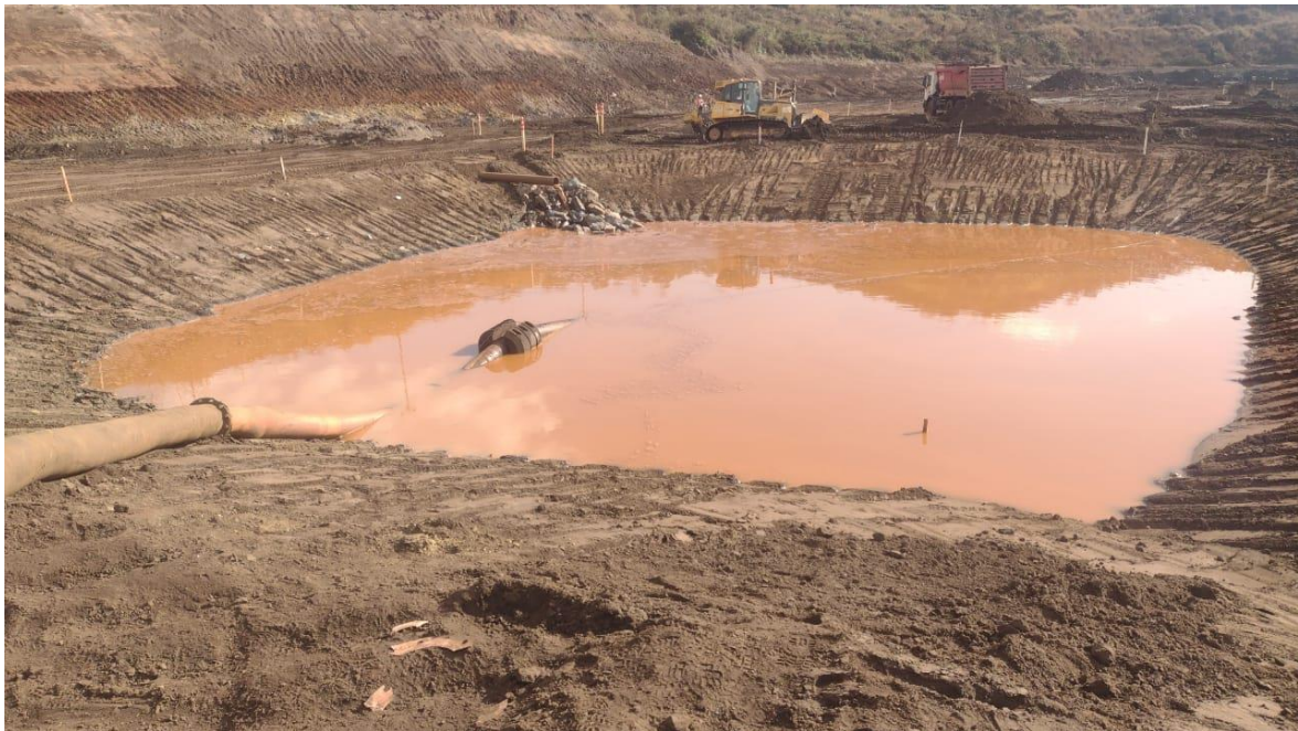
Foto 21. Construção do novo sump na ombreira direita com sistema de bombeamento (Julho/24).
