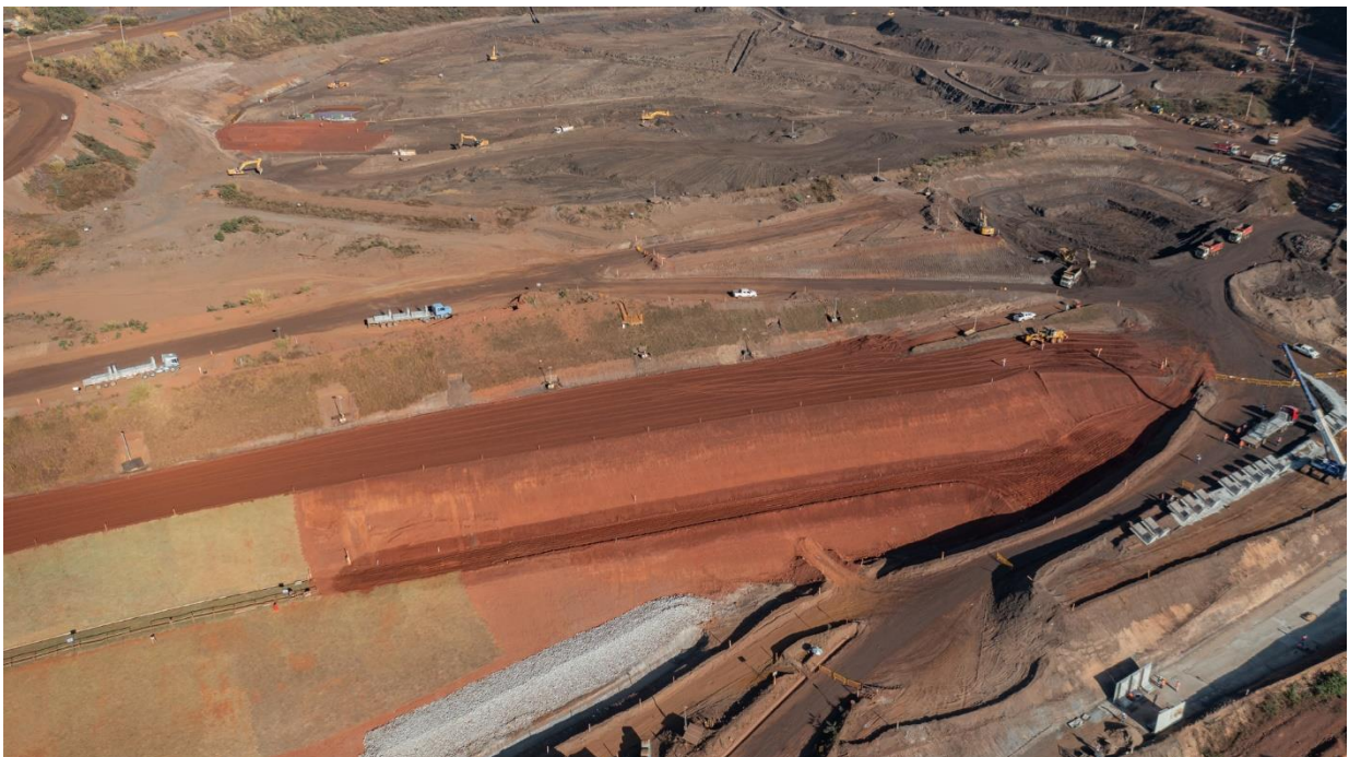
Foto 11. Execução do aterro compactado no reforço do trecho da estaca 10+0,0 a 17+0,0 (Julho/24)
