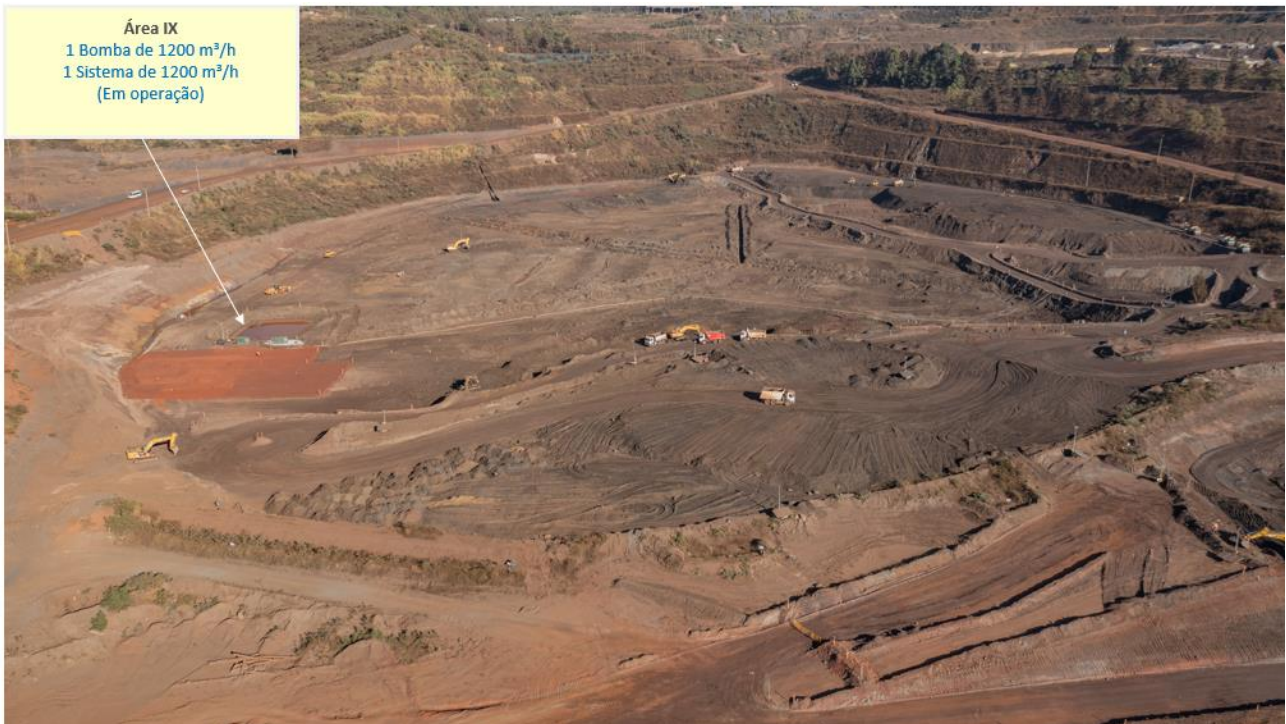
Figura 16. Sistema de bombeamento operante reservatório Área IX (Julho/24) - Recomendação A9-0117 .
