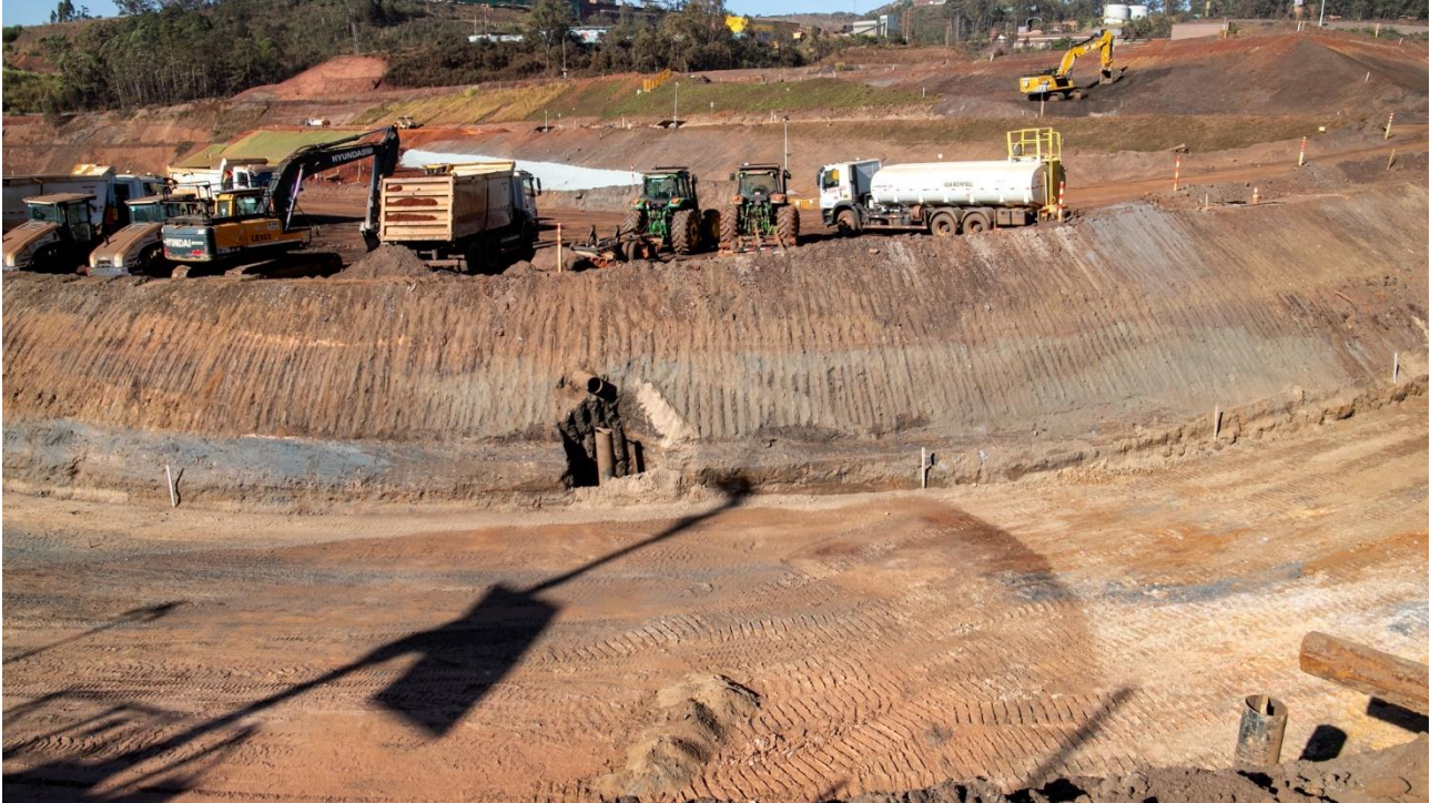
Foto 19. Remoção da tubulação no canal de drenagem (Junho/24).
