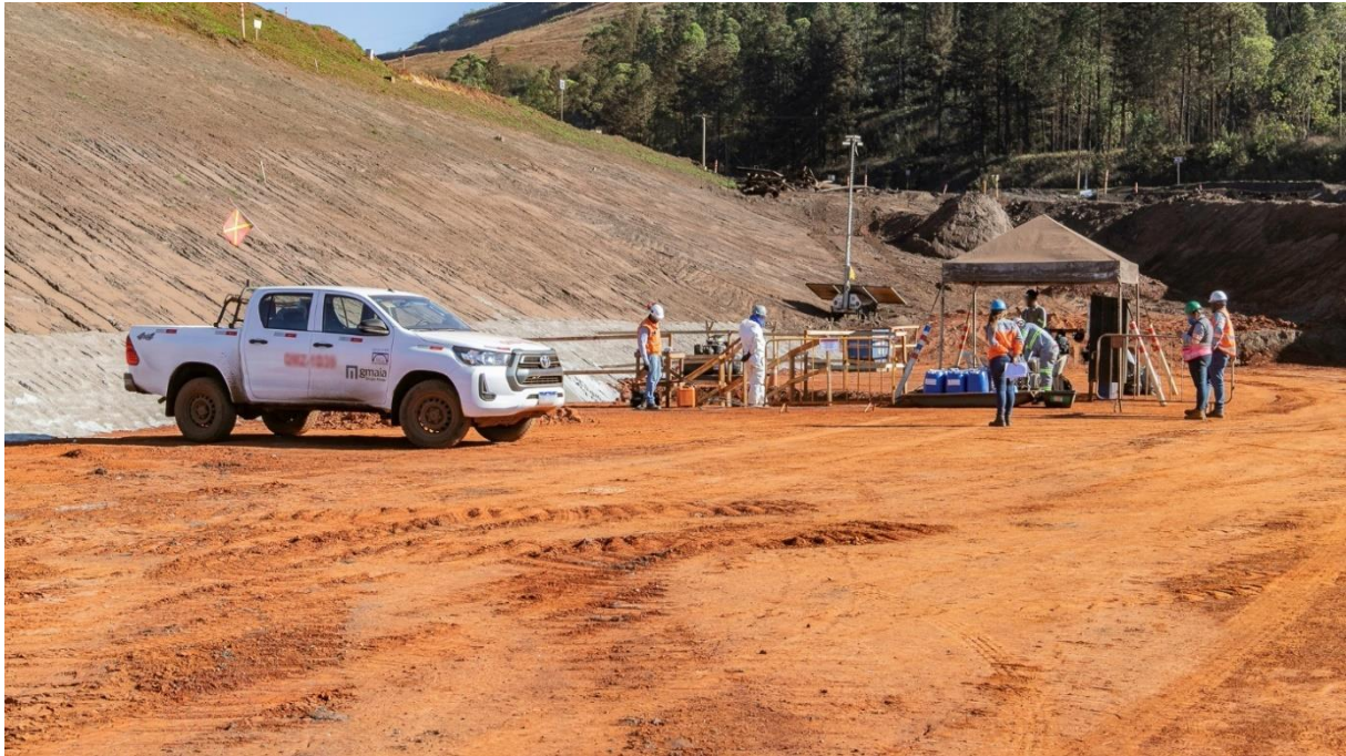
Foto 25. Execução do tamponamento do tubo na obra do reforço jusante (Junho/24).
