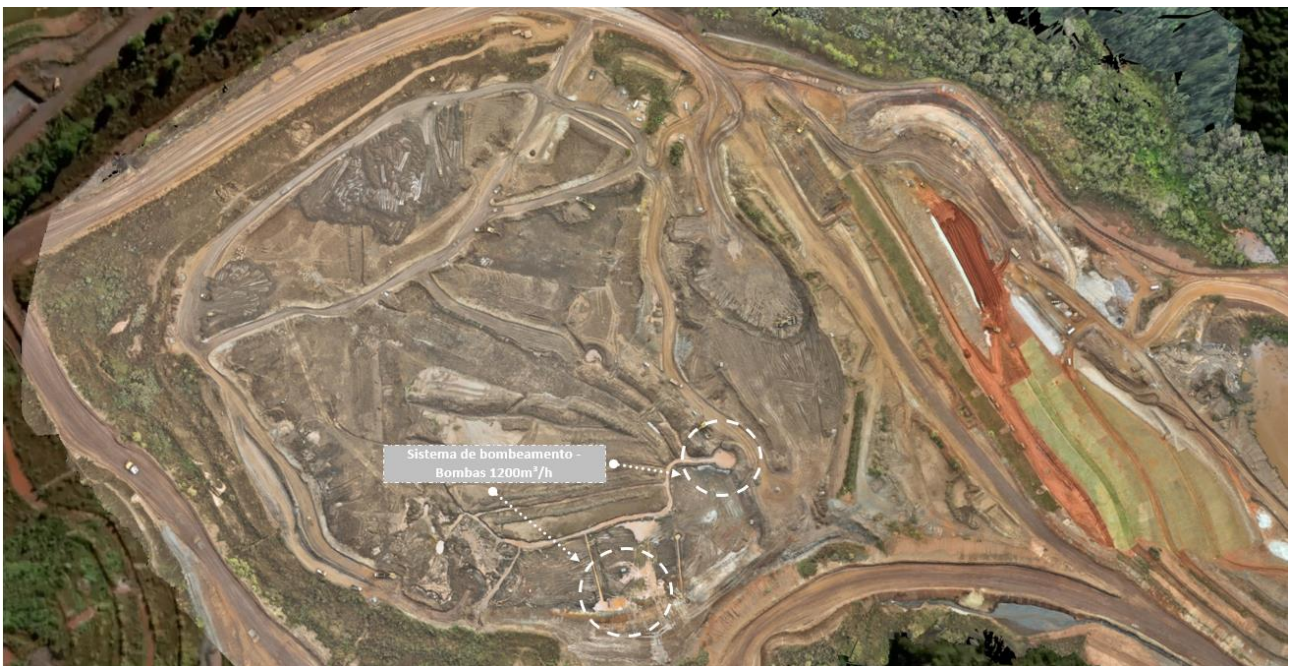
Figura 18. Planta com o sistema de bombeamento operante no reservatório Área IX (status de julho/2024).
