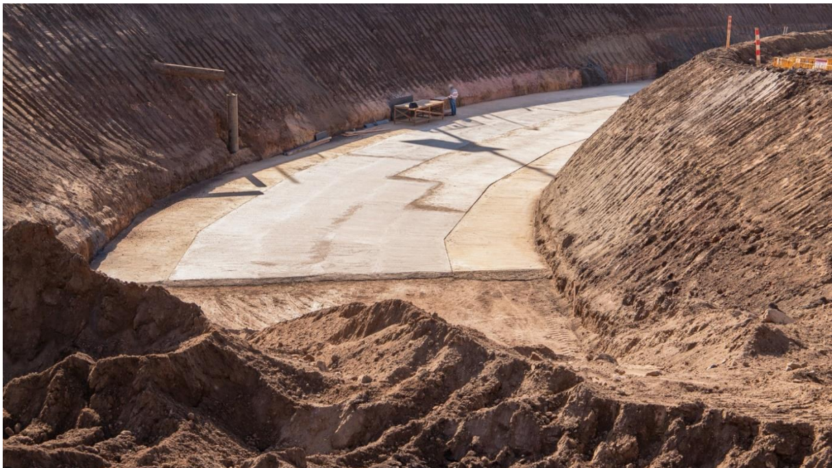
Foto 30. Concreto de regularização para posicionamento de pré-moldados (Julho/24).
