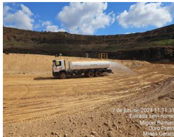
Foto 42: Caminhão pipa realizando aspersão das vias. Fonte: Vale, junho 2024.
