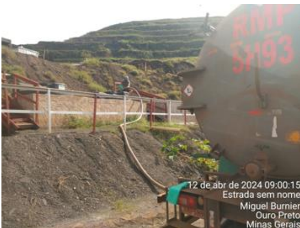
Foto 51: Limpeza tanque séptico canteiro central. Vale, abril de 2024.
