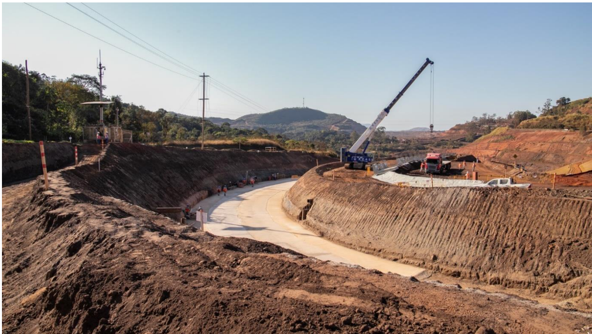
Foto 32. Instalação das peças pré-moldadas do canal de drenagem (Julho/24).
