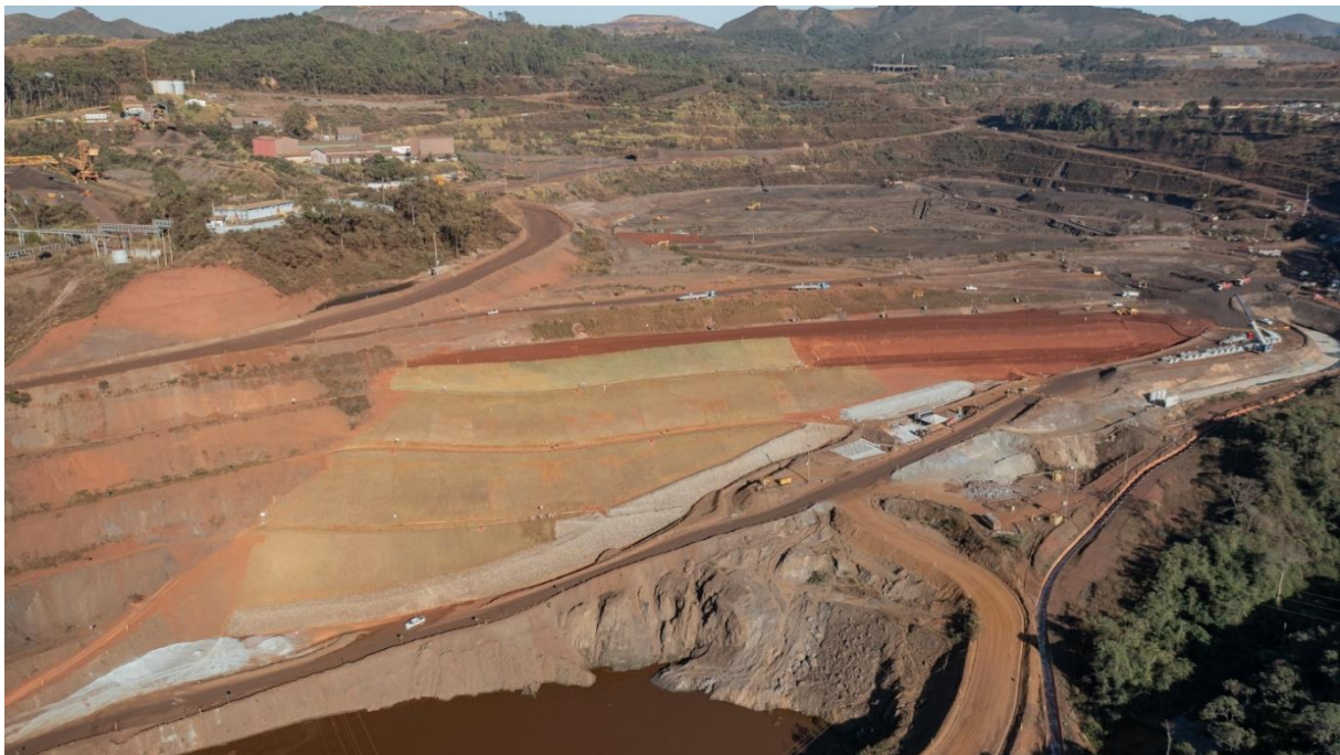
Foto 26. Conclusão de tapete drenante e aterro compactado no reforço do maciço (Julho/24).
