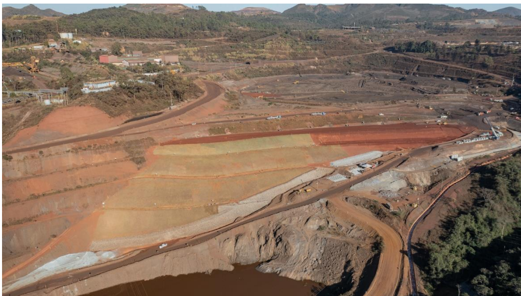
Foto 7. Execução do aterro compactado no reforço do maciço
