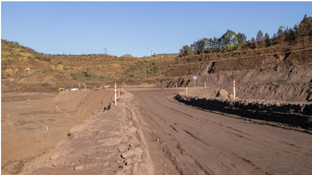
Foto 24. Adequação de acessos para obra (Julho/24).
