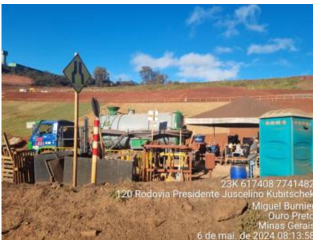
Foto 49. Manutenção dos banheiros químicos disponíveis nas frentes de obra. Vale, maio de 2024.
