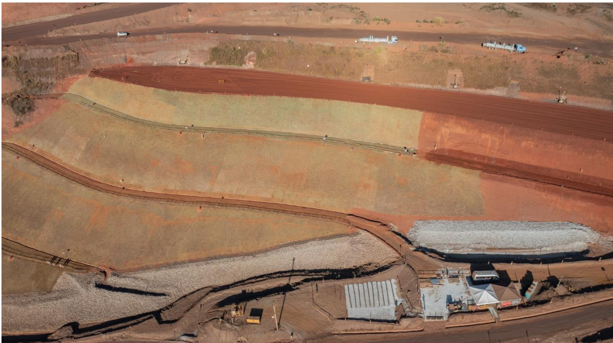
Foto 3. Plantio de grama no talude jusante do reforço (Julho/24).
