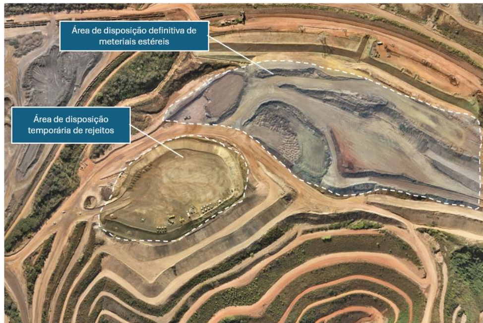
Figura 5. Imagem geral da PDE Ponto 3 – área segregadas de disposição de materiais (Junho/2024) – REC. A9-0197
