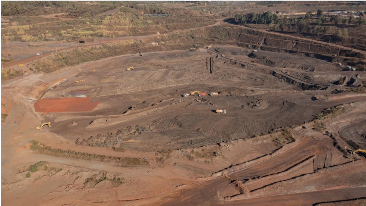
Foto 23. Escavação de rejeitos no reservatório (Julho/24).
