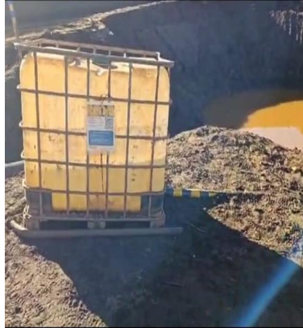
Foto 60. Aplicação de floculante. Vale, 2024.
