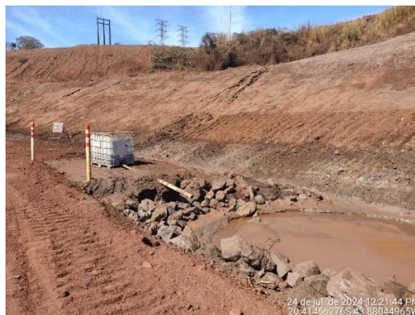
Foto 61. Aplicação de floculante no canal de drenagem. Vale, 2024.
