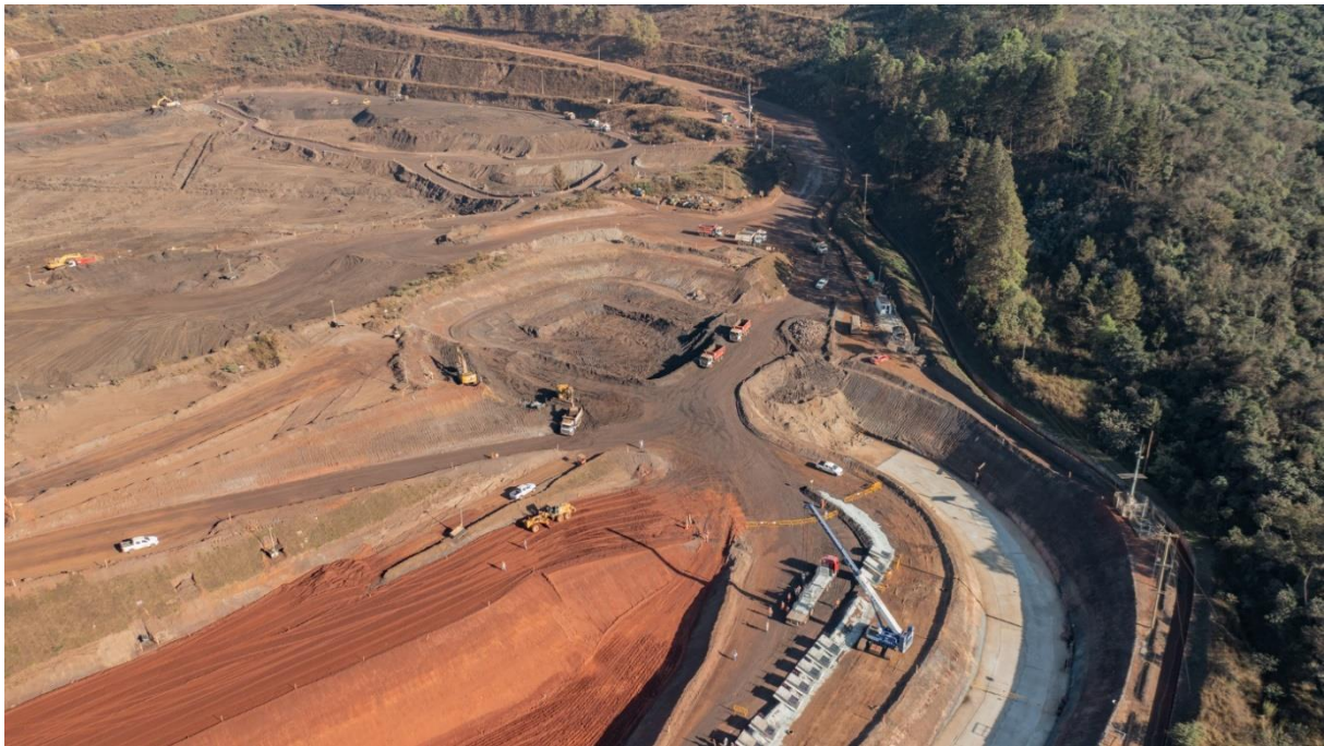
Foto 29. Escavação do emboque do novo extravasor (Julho/24).
