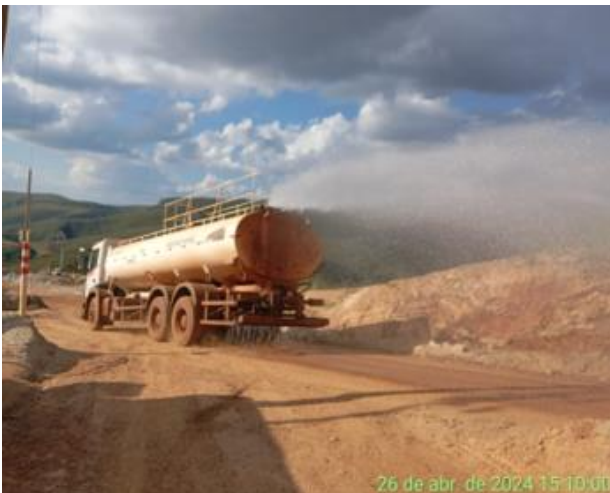
Foto 37. Caminhão pipa realizando aspersão das vias. Fonte: Vale, abril de 2024.
