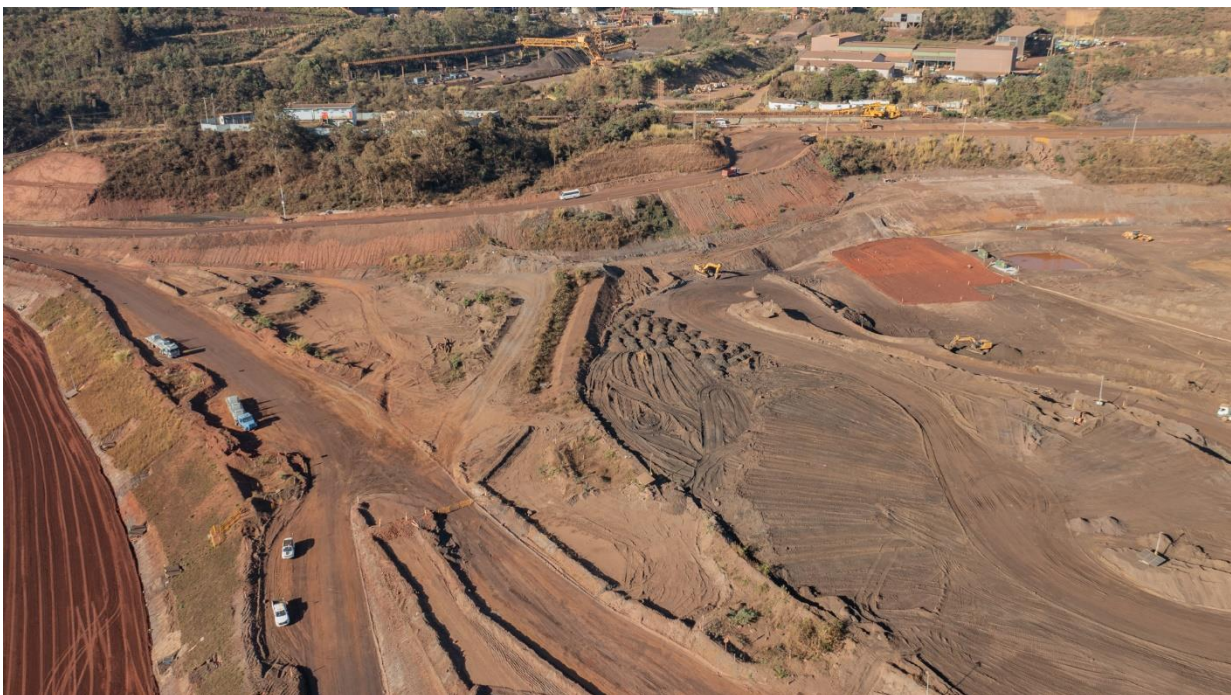
Foto 6. Crista da barragem sem acúmulo de água (Julho/24).
