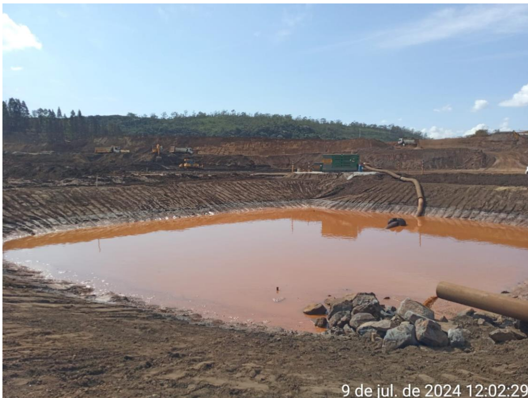
Foto 1. Implantação de um novo sump na margem direita do reservatório - Recomendação A9-0204 (Julho/24)
