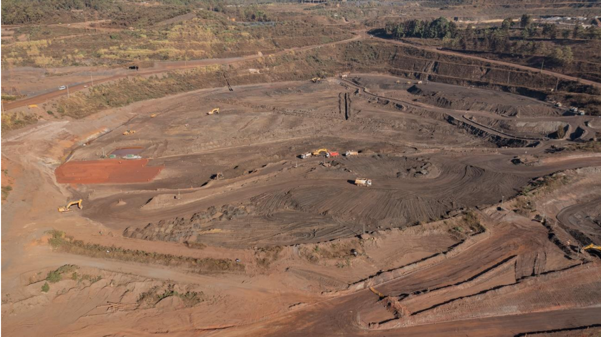
Foto 13. Escavação de rejeitos no reservatório (Julho/24).
