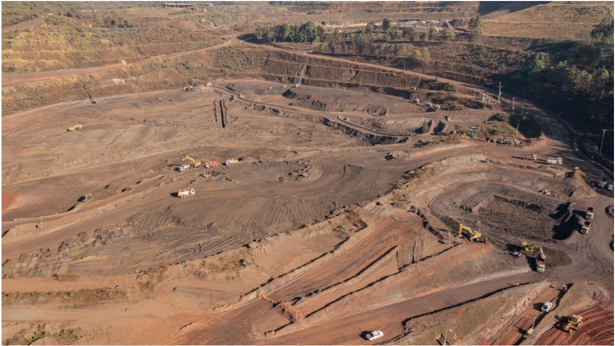
Foto 10. Execução dos aterros de conquista no reservatório (Julho/24)
