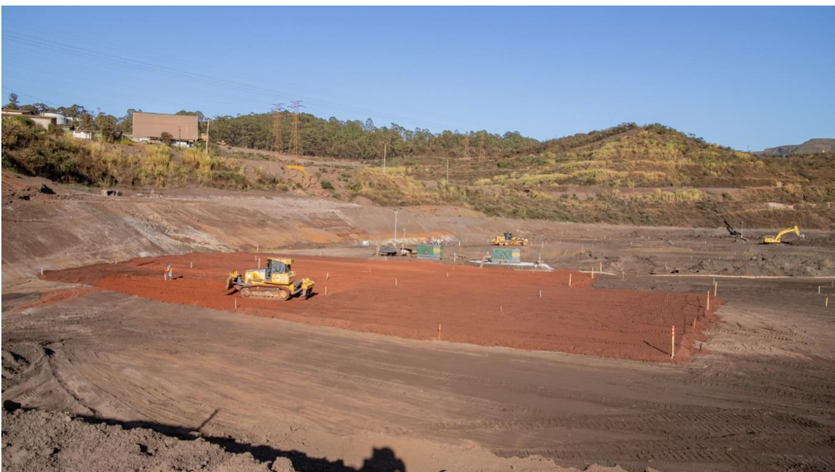
Foto 14. Revestimento do reservatório com material argiloso (Julho/24).
