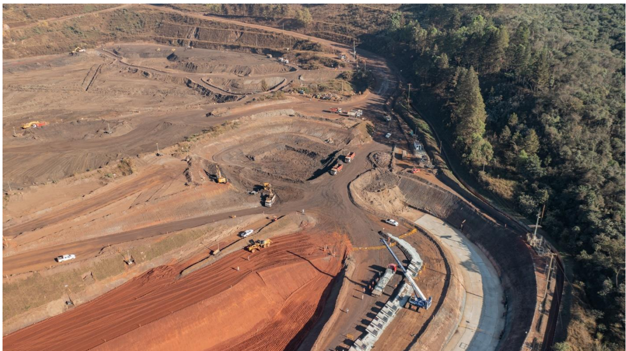
Foto 9. Escavação do emboque do novo extravasor (Julho/24)
