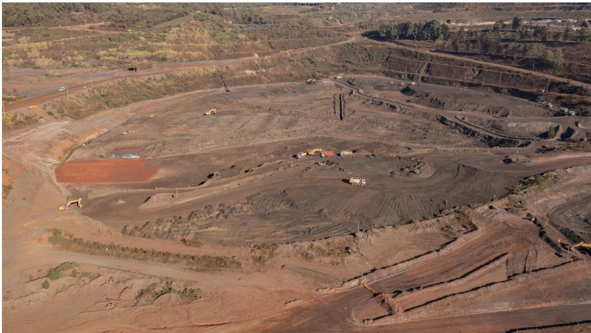
Foto 15. Escavação de rejeitos no reservatório (Julho/24).
