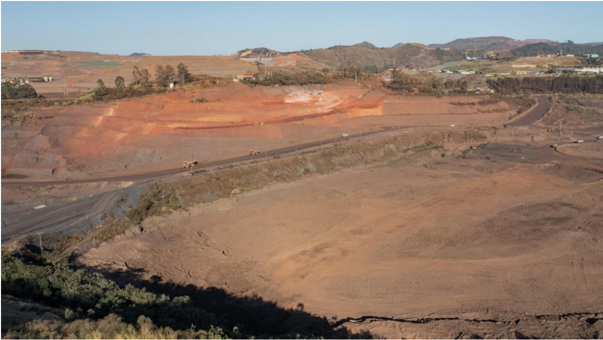
Foto 27. Escavação, carga e transporte de material Área X (Julho/24).
