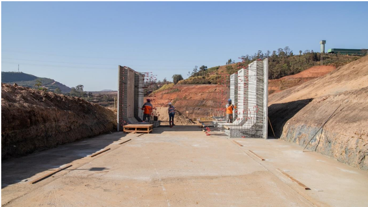
Foto 31. Instalação das peças pré-moldadas do canal de drenagem (Julho/24).
