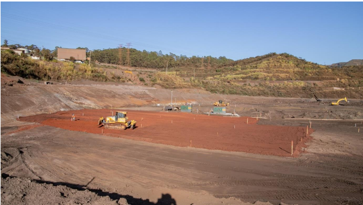
Foto 28. Início do revestimento do reservatório com material argiloso da Área X (Julho/24).
