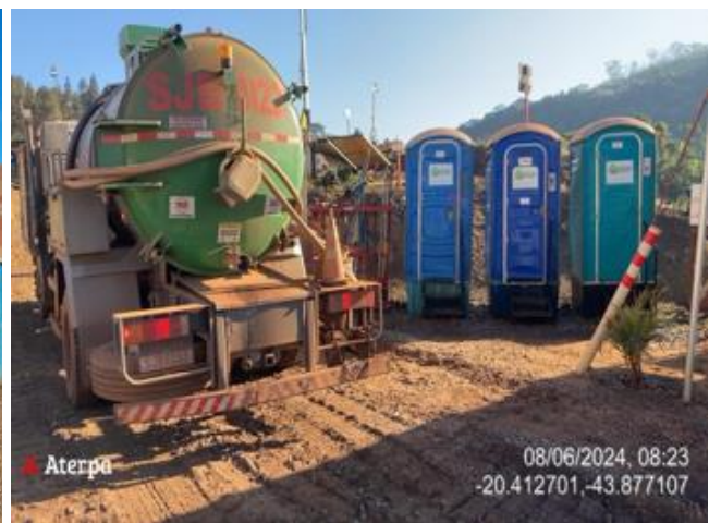
Foto 50. Limpeza de banheiros químicos por caminhão sucção. Vale, junho de 2024.
