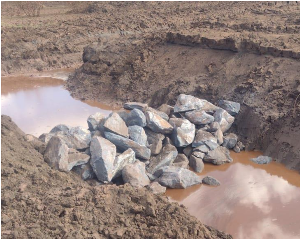
Foto 59. Instalação de enrocamento no canal de drenagem. Vale, 2024
