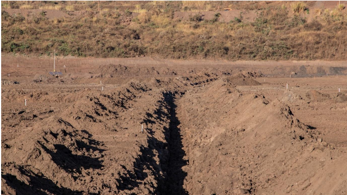
Foto 17. Execução de trincheiras para direcionamento de fluxo no interior do reservatório.
