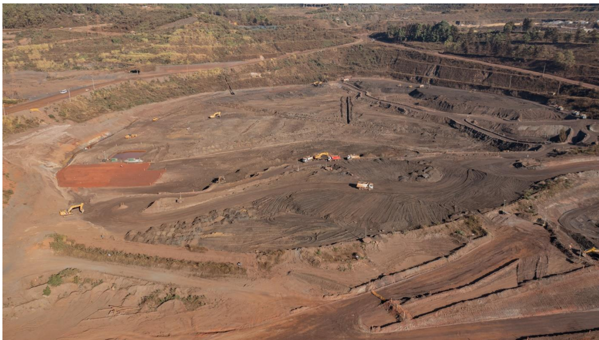
Foto 16. Bota esperas no interior do reservatório Área IX
