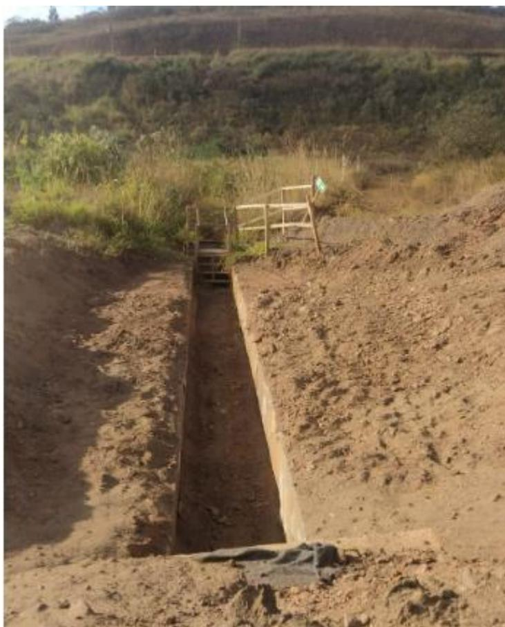
**Foto 31:** Reconstrução de trecho danificado dos canais de cintura – Forquilha II (Julho/24)
