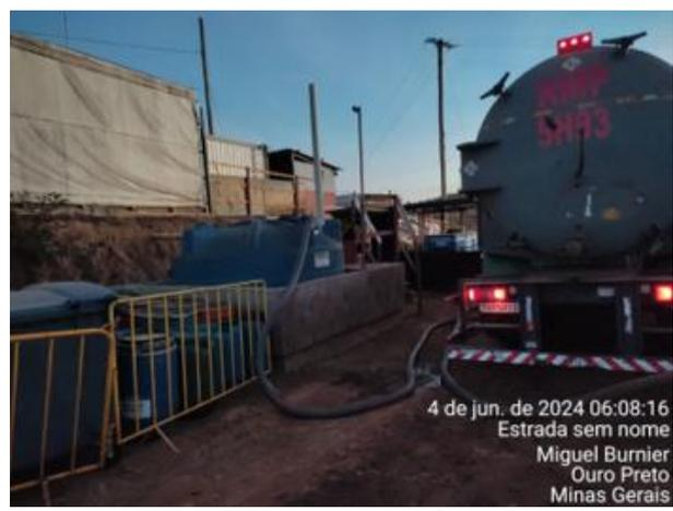
**Foto 49:** Sucção de efluente sanitário armazenado nos tanques sépticos. Vale, junho de 2024.
