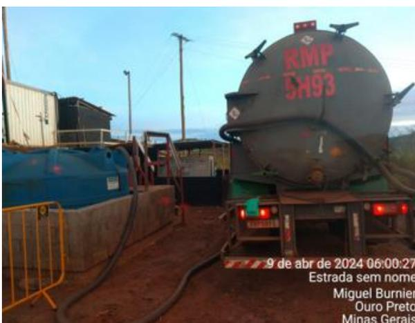
**Foto 48:** Limpeza tanque séptico canteiro central Forquilha abril de 2024.
