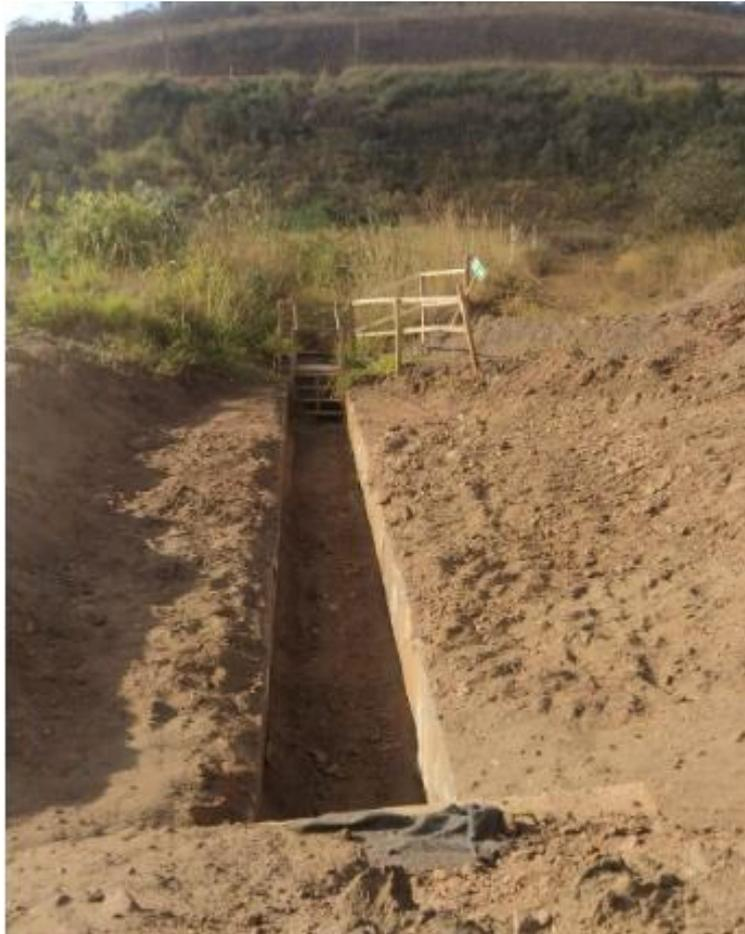
**Foto 14:** Reconstrução de trecho danificado dos canais de cintura – Forquilha II (Julho/24)
