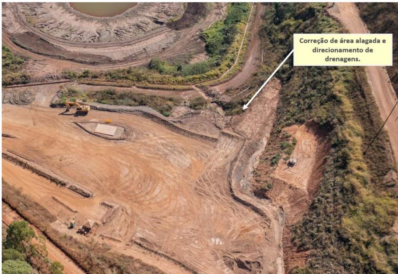
**Figura 21.** Forquilha II – Correção de drenagem e área alagada – margem direita do reservatório - recomendação F2-0119 (Julho/24).
