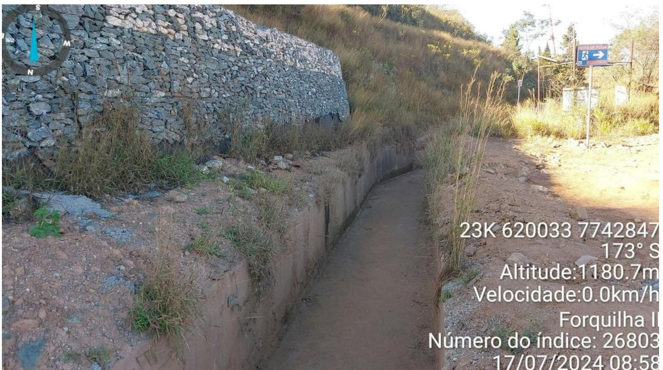
**Foto 30:** Status da limpeza e desobstrução dos canais de cintura – Forquilha II (Julho/24)
