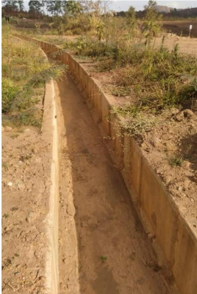
**Foto 27.** Forquilha II – Correção de drenagem danificada – margem direita do reservatório - recomendação F2-0149 (Julho/24).
