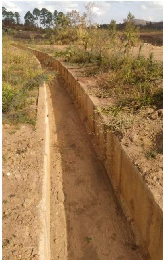
**Foto 28:** Status da limpeza e desobstrução dos canais de cintura – Forquilha II (Julho/24).
