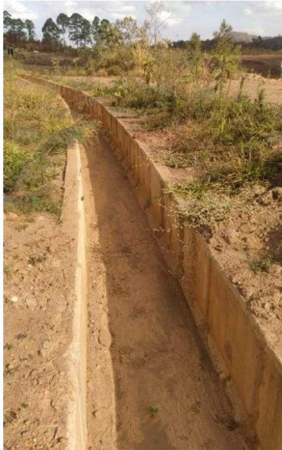
**Foto 11:** Status da limpeza e desobstrução dos canais de cintura – Forquilha II (Julho/24)
