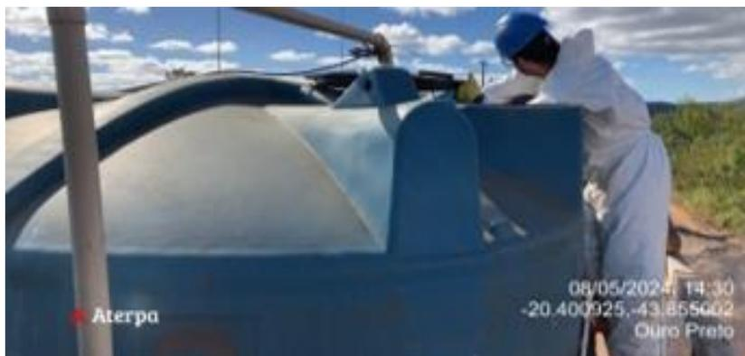
**Foto 58:** Higienização das caixas de água do canteiro principal de Forquilha.
