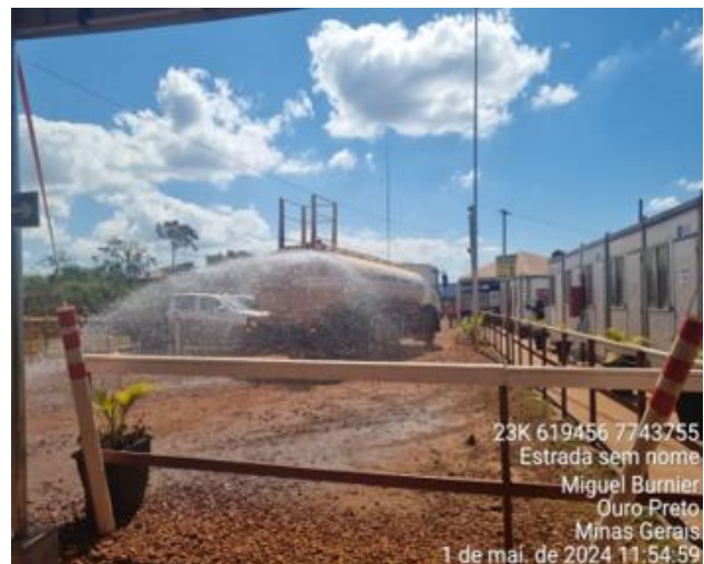
Foto 42. Aspersão no canteiro central da contrata Aterpa. Fonte: Vale, maio, 2024.
