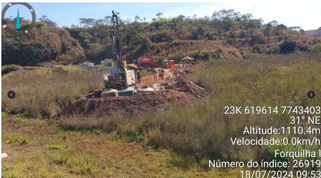
Foto 18. Forquilha I – Sondagem mista- empresa Umi San (FI-INTT-SM-17 - Julho/24).
