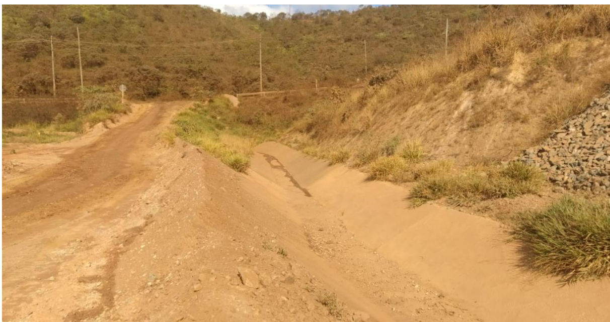
Foto 27. Status da limpeza e desobstrução dos canais de cintura – Forquilha I (Julho/24).
