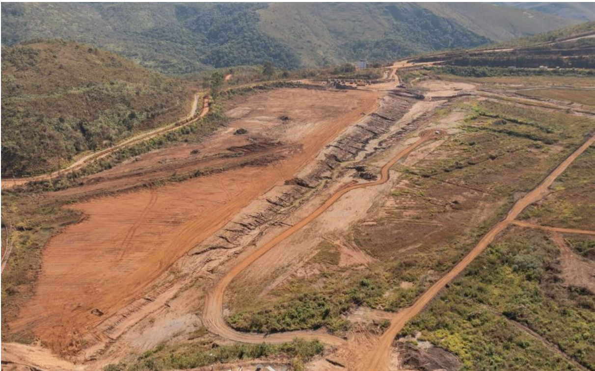
Foto 20. Forquilha I – Execução do PPC 24/25 (Julho/24).
