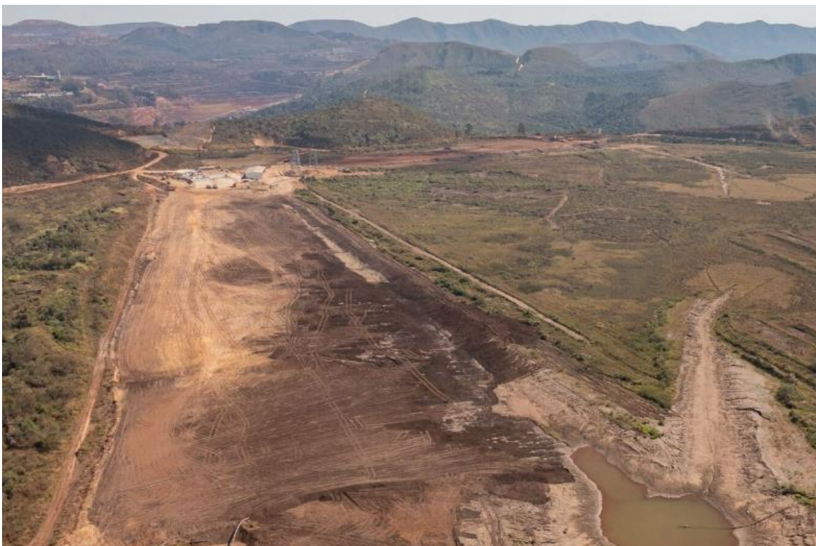
Foto 13. Status de remoção das interferências e infraestruturas na Região 6 (julho/24).
