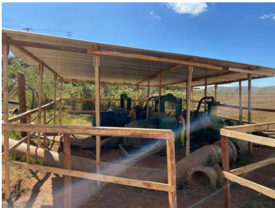
Foto 11. Melhorias na praça de posicionamento das bombas de Forquilha I - recomendação F1-0148 (julho/24).
