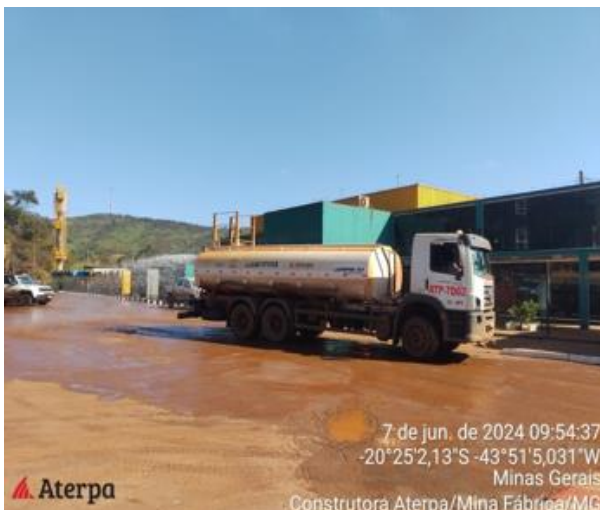
Foto 43. Aspersão frentes de obras da contrata Aterpa (canteiro DB). Fonte: Vale, junho, 2024.
