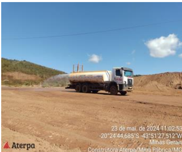
Foto 41. Aspersão de vias. Fonte: Vale, maio, 2024.
