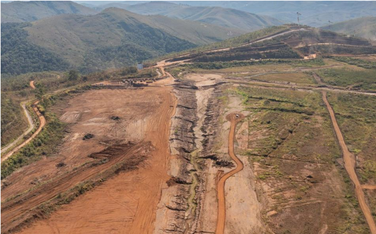
Foto 3. Forquilha I – Execução do PPC 24/25 (julho/24).
