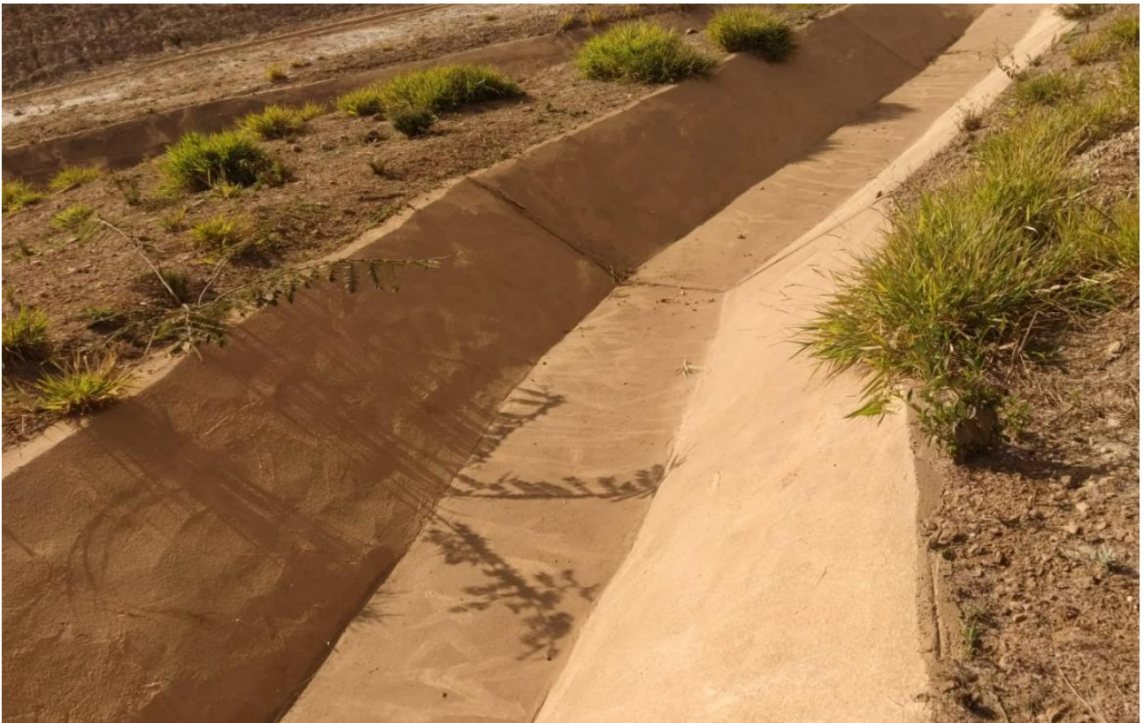
Foto 15. Status da limpeza e desobstrução dos canais de cintura – Forquilha I(julho/24).
