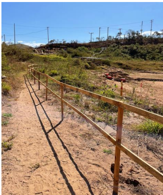
Foto 12. Melhorias na praça de posicionamento das bombas de Forquilha I - recomendação F1-0148 (julho/24).
