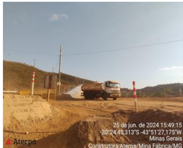
Foto 44. Caminhão pipa realizando aspersão das vias. Fonte: Vale, junho, 2024.
