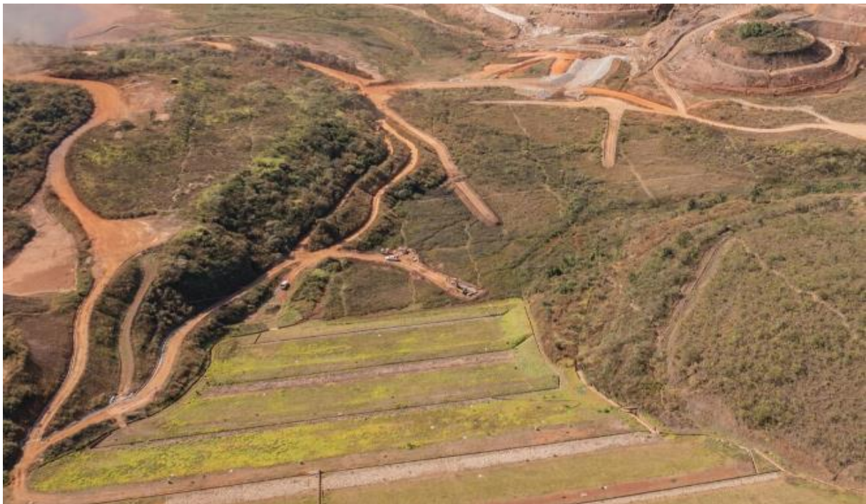
Foto 8. Forquilha I – Sondagens a jusante e ombreiras (julho/24).
