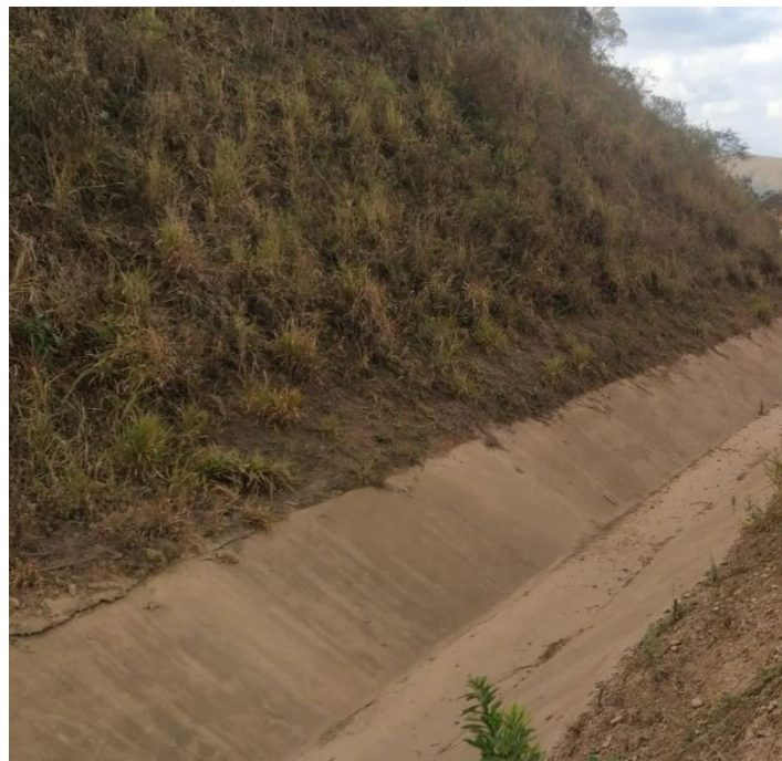
Foto 16. Status da limpeza e desobstrução dos canais de cintura – Forquilha I(julho/24).
