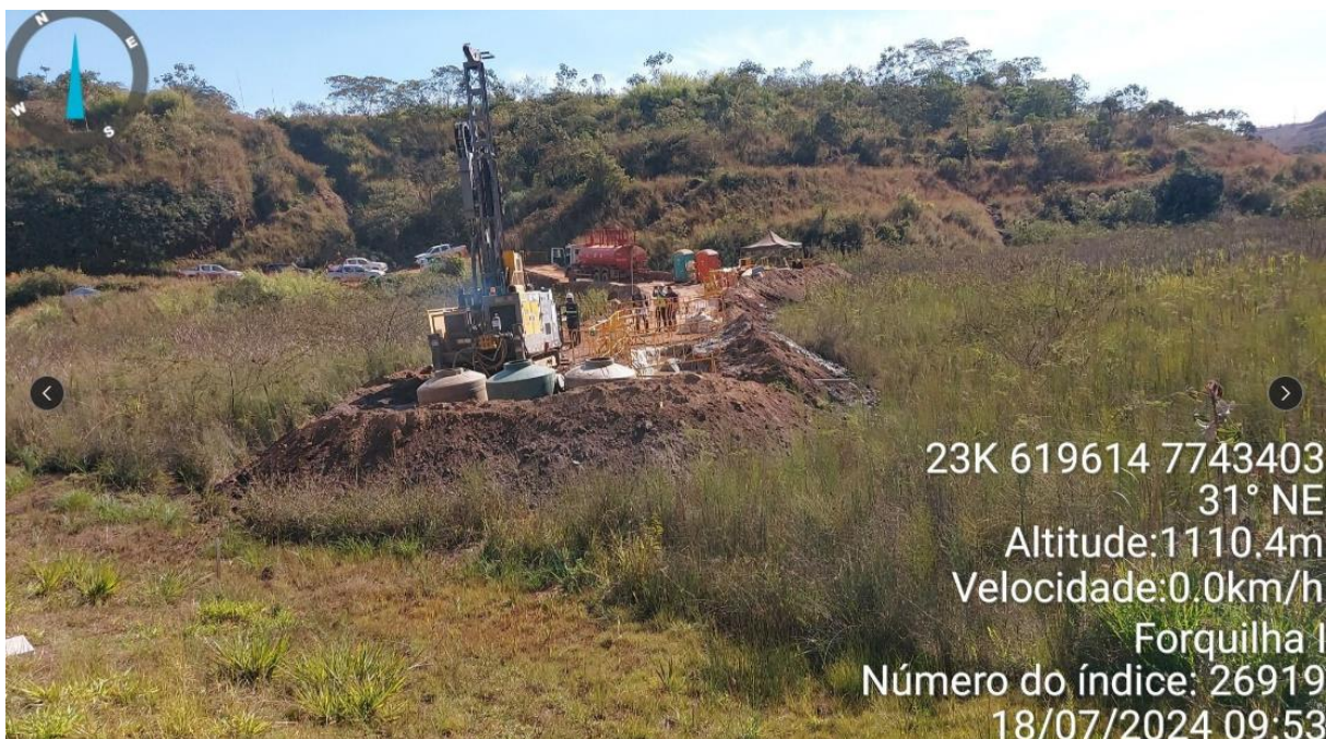
Foto 2. Forquilha I – Sondagem mista- empresa Umi San (FI-INTT-SM-17 - julho/24).
