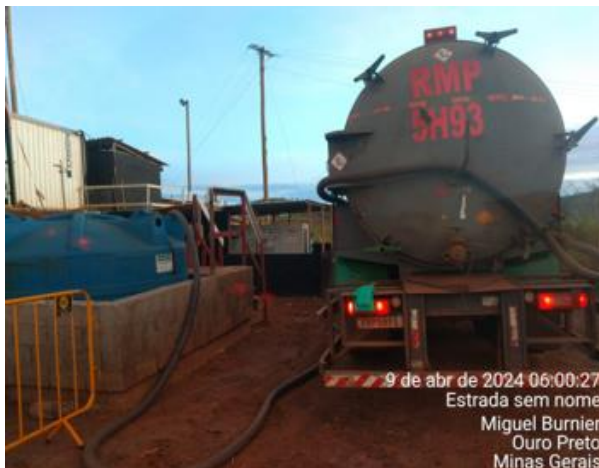
Foto 53: Limpeza tanque séptico canteiro central Forquilhas. Vale, abril de 2024.
