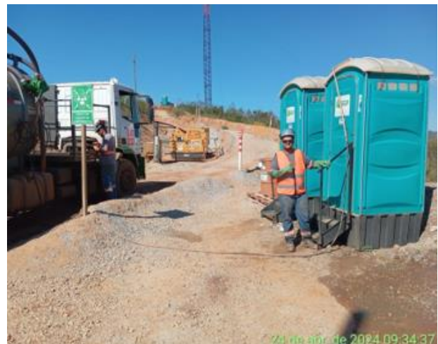
Foto 52. Limpeza de banheiros químicos por caminhão sucção. Vale, abril de 2024.
