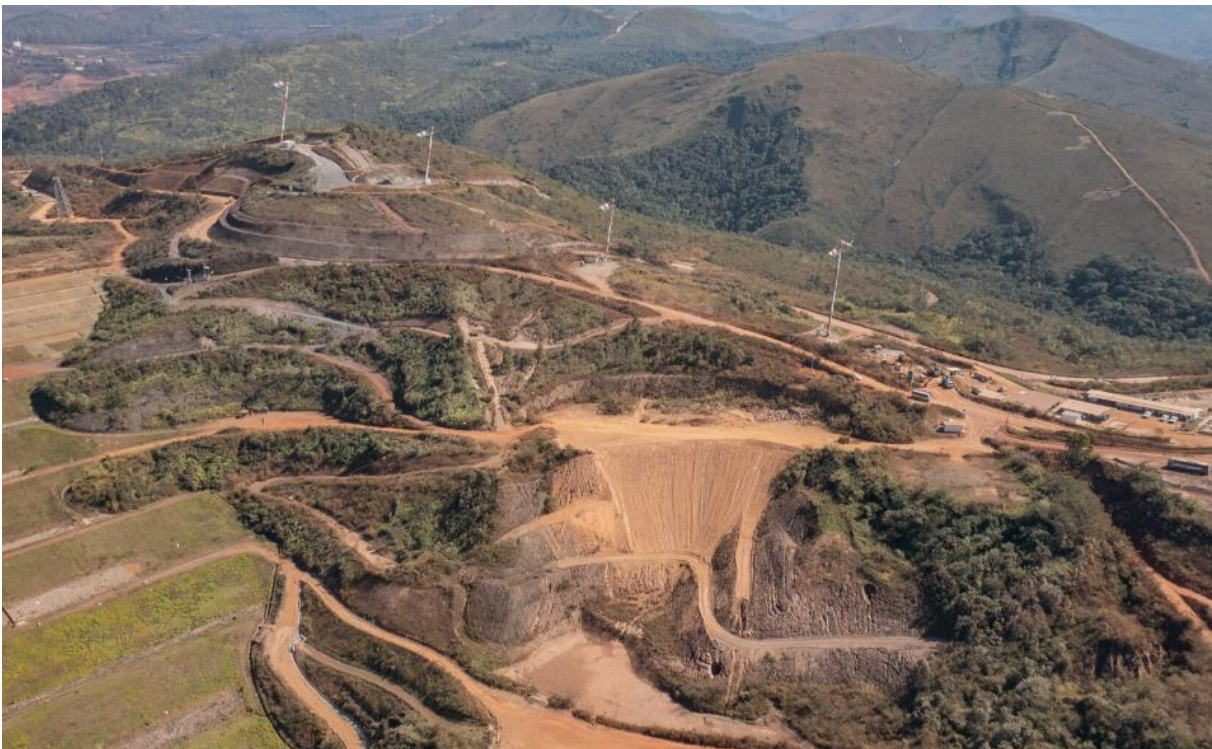
Foto 26. Forquilha I - Correção de anomalia ombreira esquerda de Forquilha I (Julho/24).
