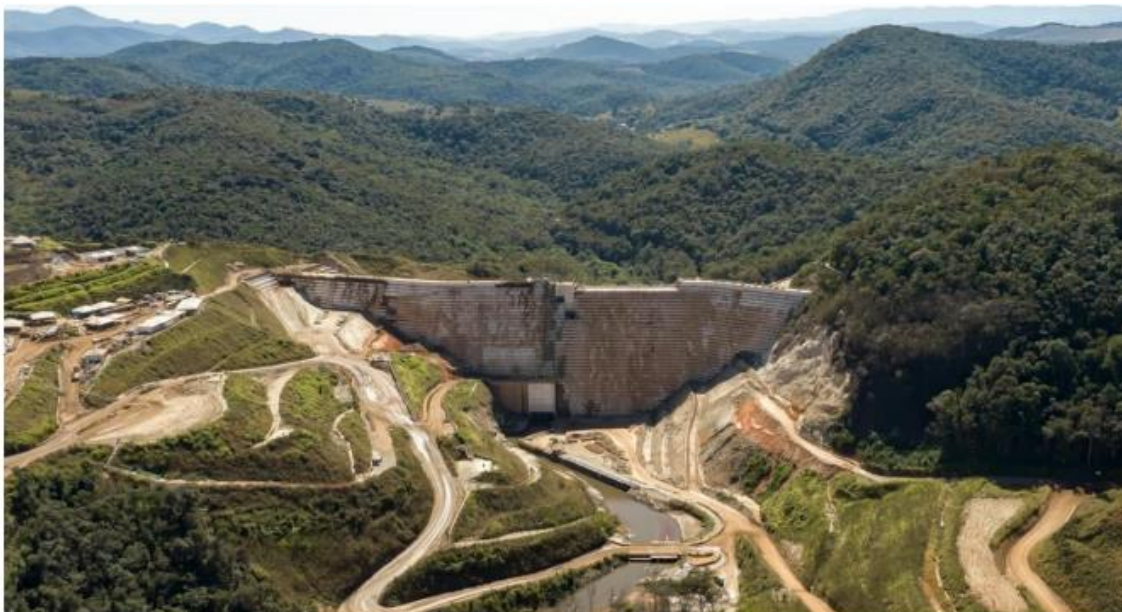
Foto 64: Estrutura de Contenção a Jusante Fábrica. Fonte: Vale, 2022.
