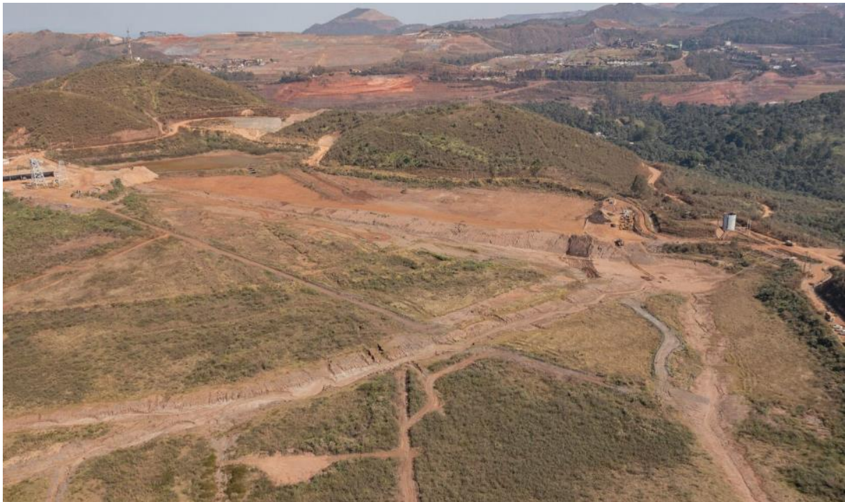
Foto 9. Forquilha I - Execução de raspagem do reservatório – PPC 24/25 (julho/24).
