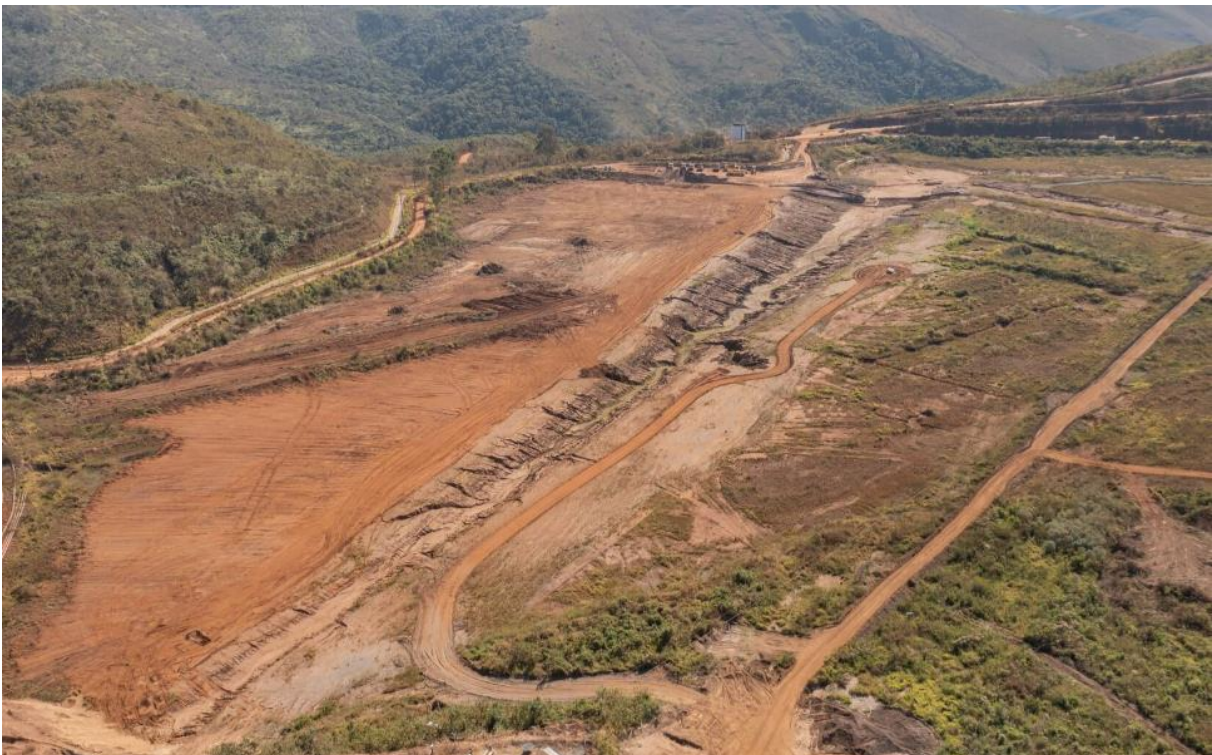
Foto 4. Forquilha I – Execução do PPC 24/25 (julho/24).
