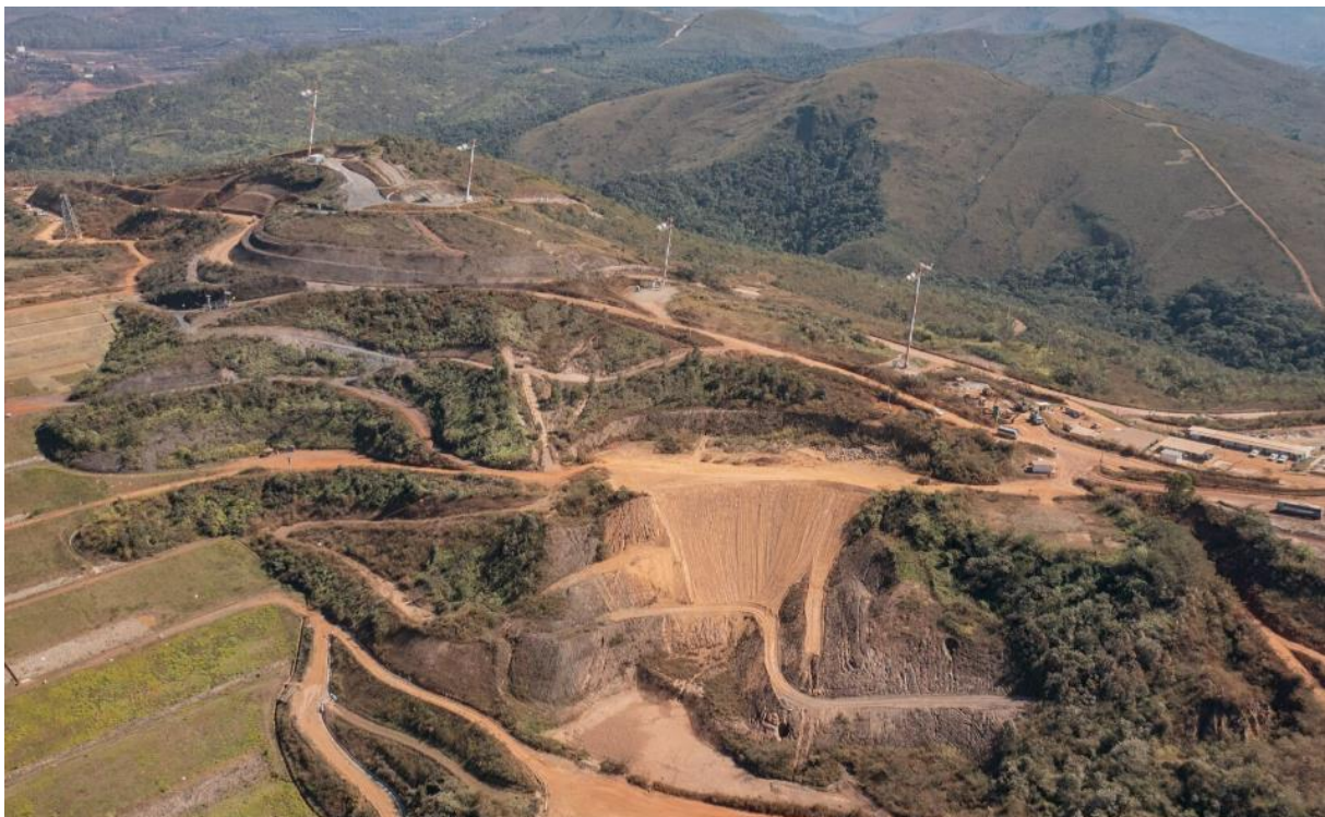
Foto 10. Forquilha I - Correção de anomalia ombreira esquerda de Forquilha I (julho/24).
