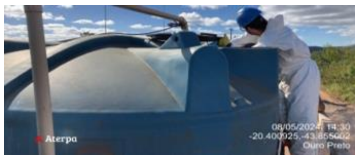
Foto 63: Higienização das caixas de água do canteiro principal de Forquilhas
