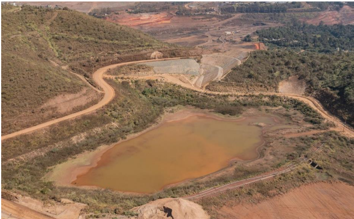
Foto 22. Forquilha I – Rebaixamento do Dique IV – Lagoa das Capivaras (Julho/24).
