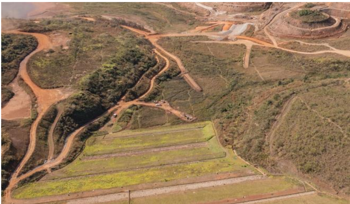
Foto 24. Forquilha I – Sondagens a jusante e ombreiras (Julho/24).
