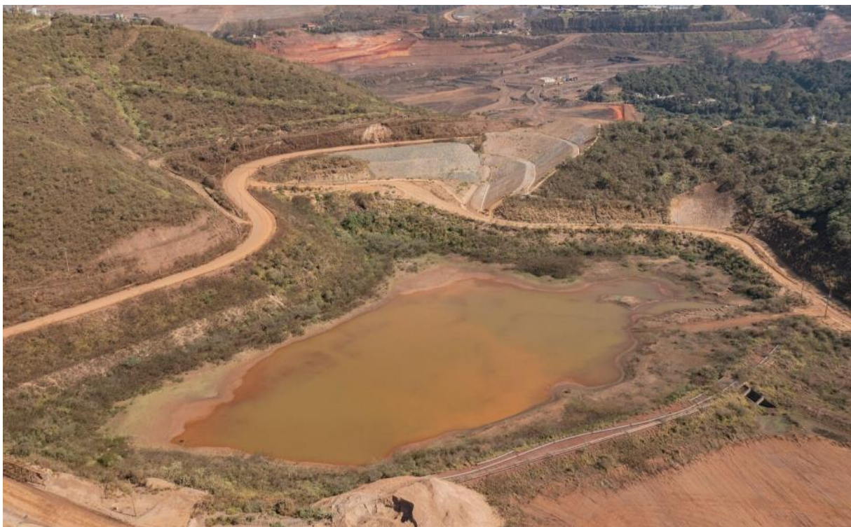
Foto 6. Forquilha I – Rebaixamento do Dique IV – Lagoa das Capivaras (julho/24).
