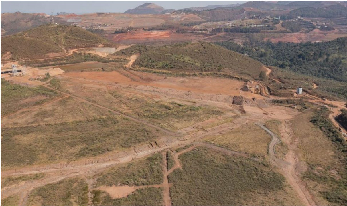
Foto 25. Forquilha I - Execução de raspagem do reservatório – PPPC 24/25 (Julho/24).
