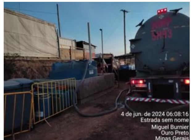
Foto 54: Sucção de efluente sanitário armazenado nos tanques sépticos. Vale, junho de 2024.
