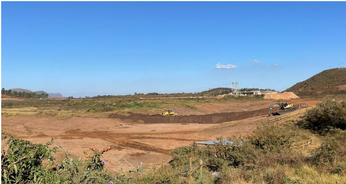
Foto 21. Forquilha I – Execução do PPC 24/25 (Julho/24).
