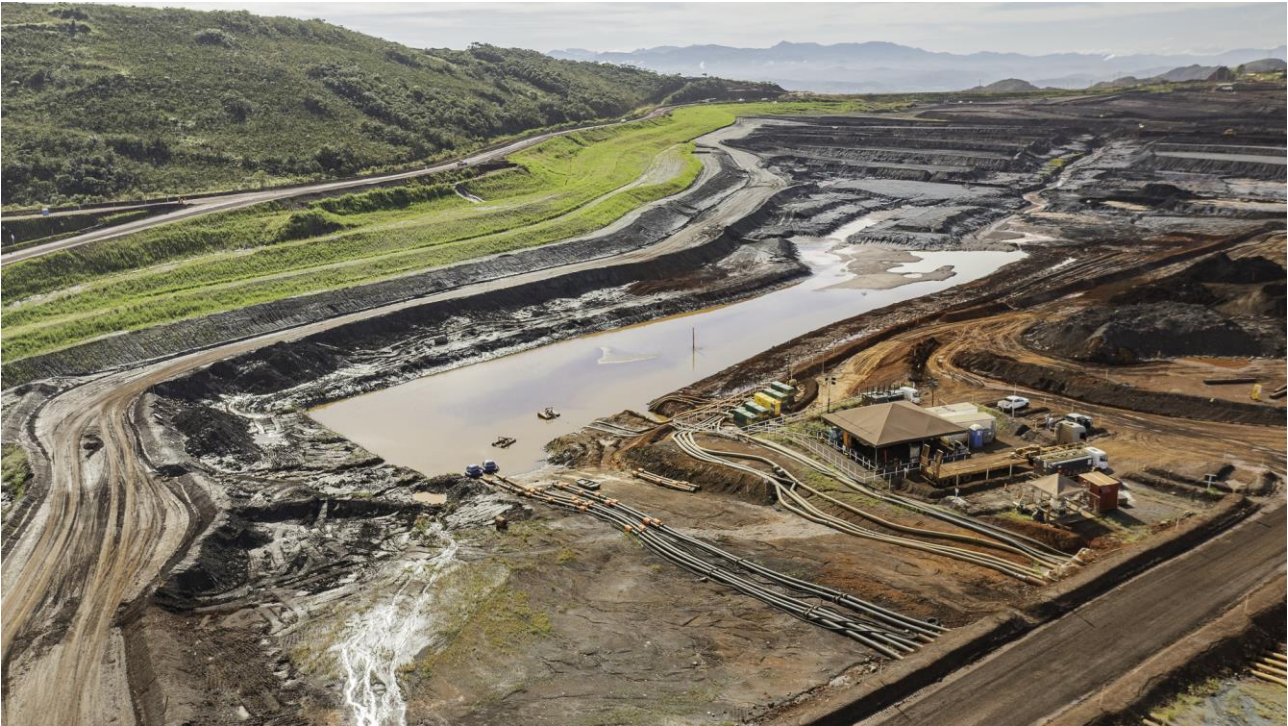
Foto 19. Vista da Barragem Vargem Grande, após processo de revegetação bem estabelecido da ombreira esquerda da barragem. (Fonte: Vale, 01 de abril de 2024).
