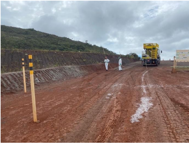
Foto 11: Aplicação de MVP no acesso administrativo (Fonte: Vale, fevereiro de 2024)
