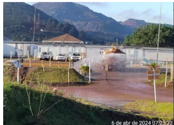
Foto 21: Umectação das vias de acesso (Fonte: Vale 2024)
