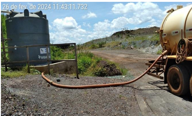
Foto 24: Sucção do tanque séptico no Canteiro. (Fonte: Vale, 2024).
