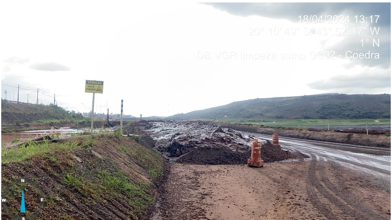
Foto 8: Avanço da Limpeza do Sump do canal de cintura da Barragem Vargem Grande, com destaque para o material retirado da estrutura. (Fonte: Vale, 18 de abril de 2024)
