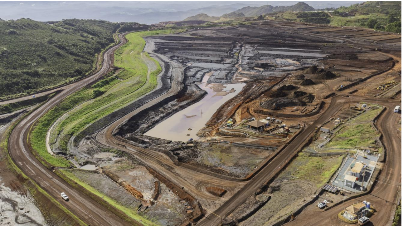
Foto 18. Vista da Barragem Vargem Grande, após processo de revegetação bem estabelecido da ombreira esquerda da barragem. (Fonte: Vale, 01 de abril de 2024).
