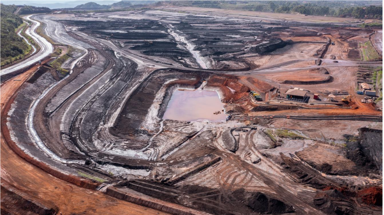
Foto 17. Vista da Barragem Vargem Grande, com foco na ombreira esquerda, durante o período de aplicação de MVP (Fonte: Vale, 01 de dezembro de 2023).
