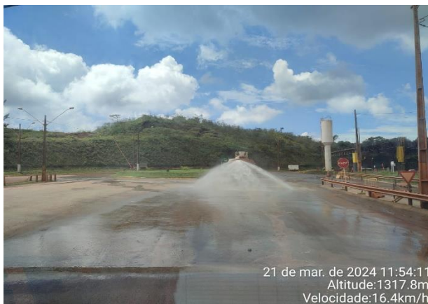
Foto 20: Umectação das vias de acesso (Fonte: Vale 2024)
