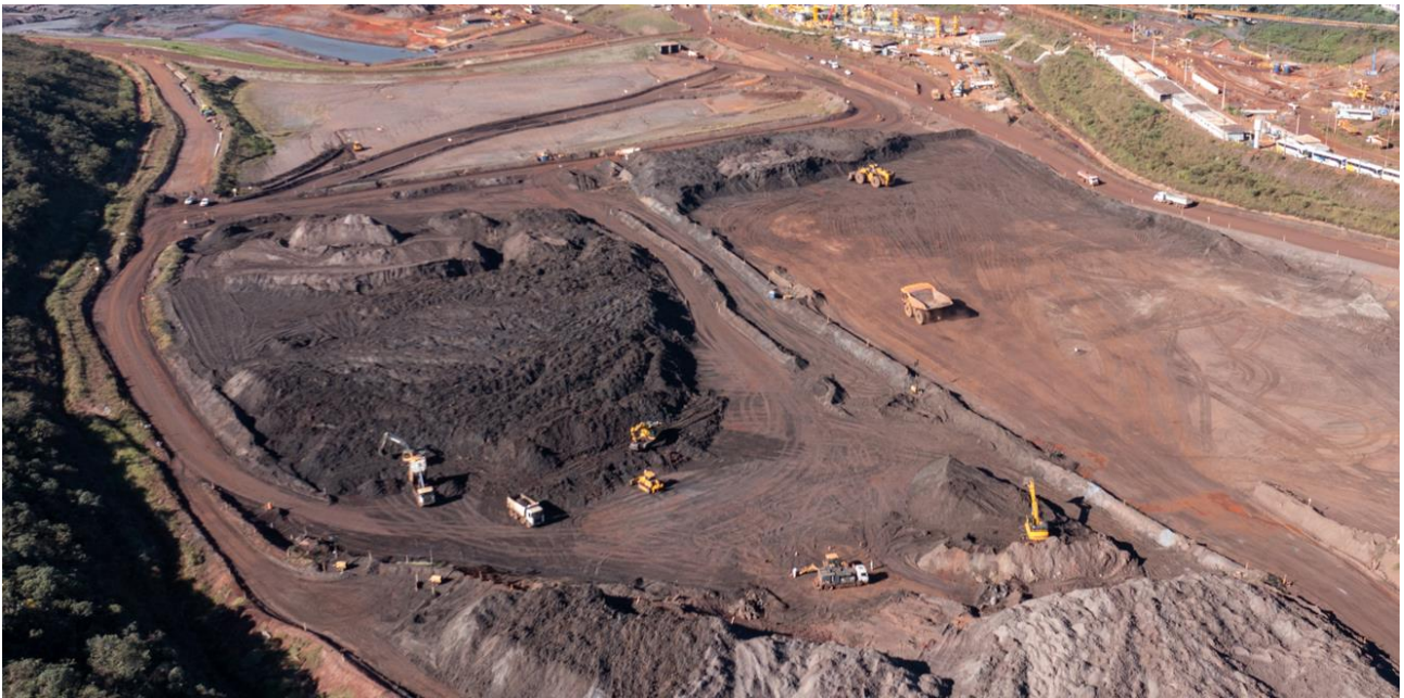
Foto 4: Visão geral de estocagem provisória na pilha temporária (30/04/2024).
