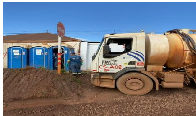
Foto 25: Limpeza dos banheiros frentes de serviço. (Fonte: Vale, 2024)
