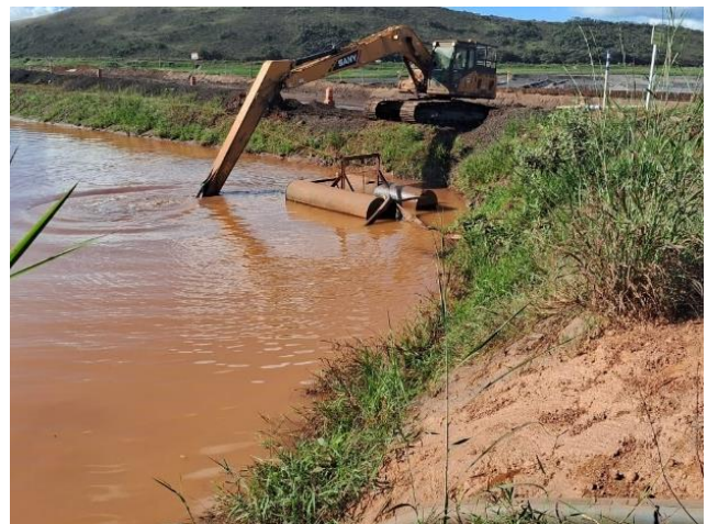
Foto 7: Início da Limpeza do Sump do canal de cintura da Barragem Vargem Grande (Fonte: Vale, 16 de abril de 2024)
