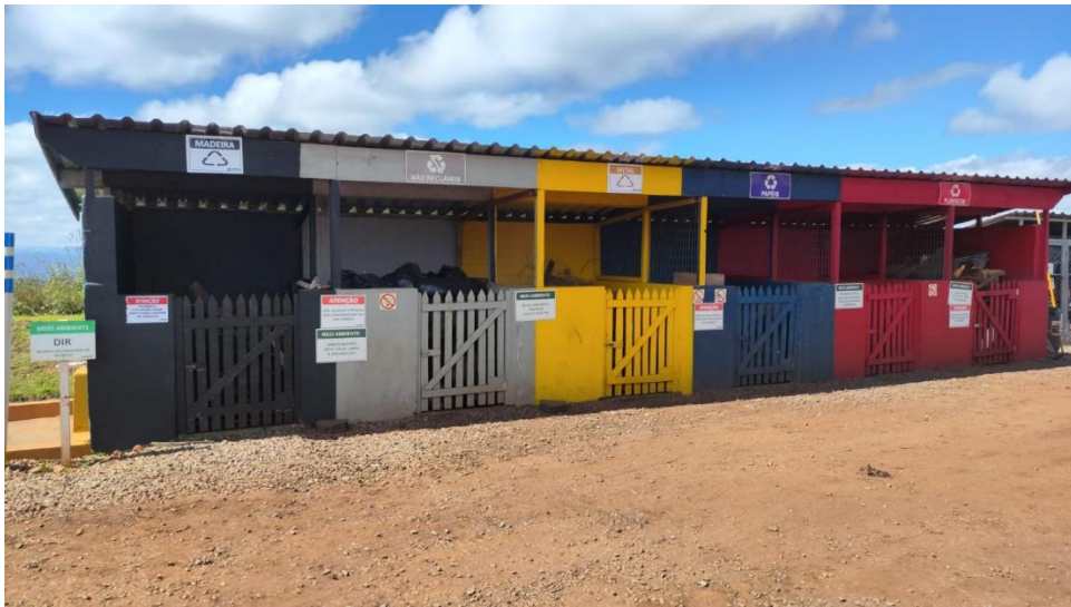
Foto 28: DIR do Canteiro. (Fonte: Vale, 2024).
