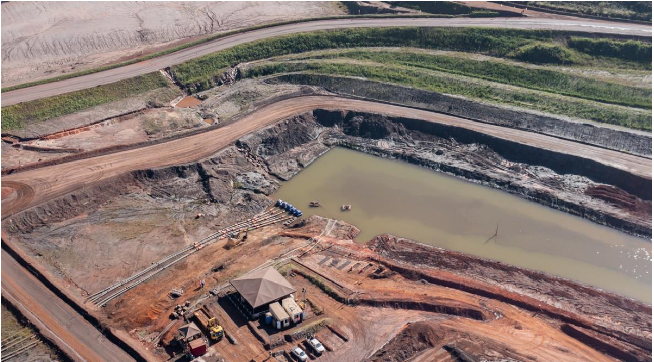
Foto 2: Sistema de bombeamento e contingência operantes (30/04/2024).
