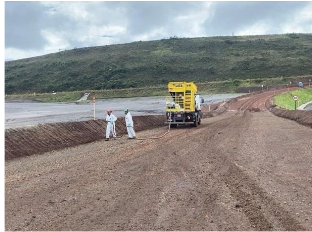
Foto 12: Aplicação de MVP no acesso administrativo (Fonte: Vale, fevereiro de 2024)
