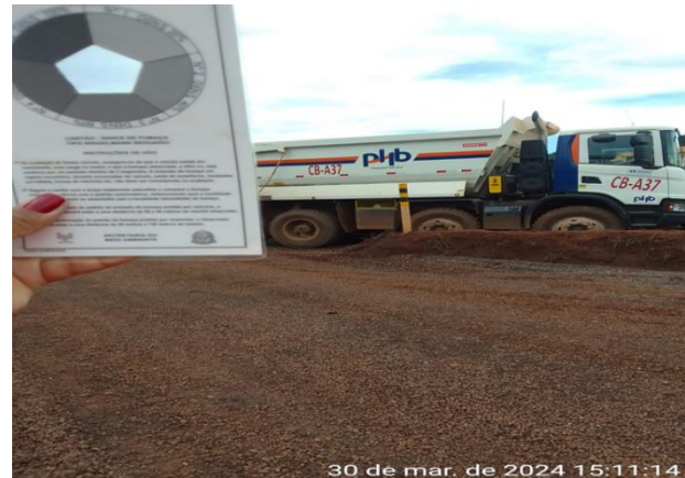
Foto 23: Monitoramento de fumaça preta dos veículos e equipamentos das frentes de serviço. (Fonte: Vale, março de 2024)
