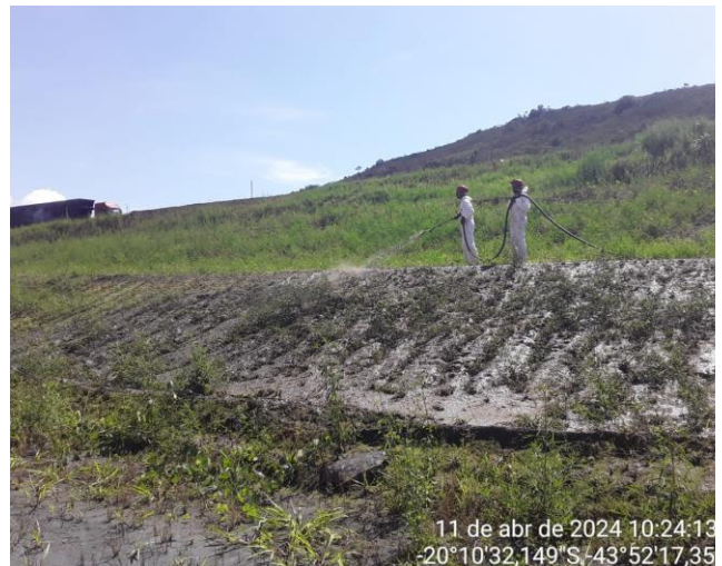
Foto 10: Reaplicação de MVP nos taludes da ombreira esquerda. (Fonte: Vale, fevereiro de 2024)
