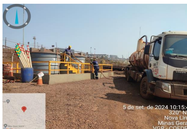
Figura 66 - Sucção do tanque séptico no canteiro. (Fonte: Vale, 2024).
