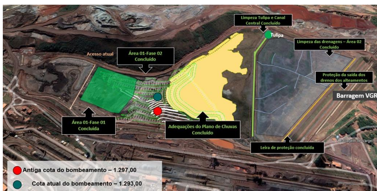
Figura 5 - Configuração geral das atividades preliminares ao início das obras de descaracterização.
