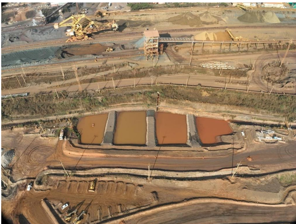
Figura 75 - Imagem aérea do redimensionamento e adequação do SUMP-CC02. Fonte: Vale, setembro de 2024.
