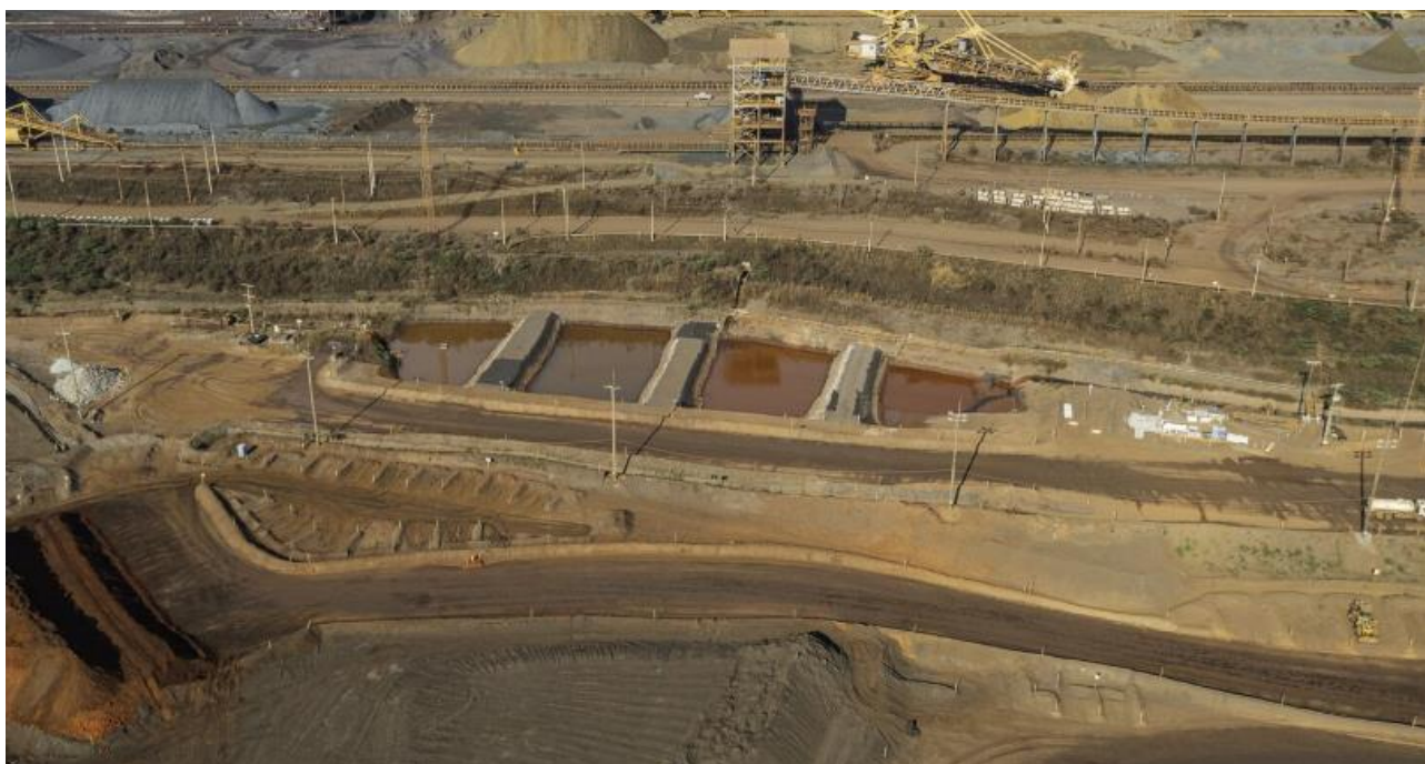
Figura 11 -Visão do SUMP 02 de contenção de sedimentos após projeto de melhorias (27/09/2024).
