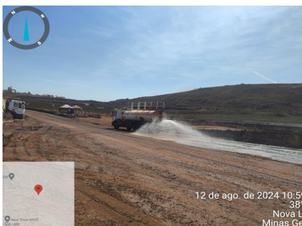
Figura 26 - Umecção das vias de acesso (Fonte: Vale, agosto de 2024)
