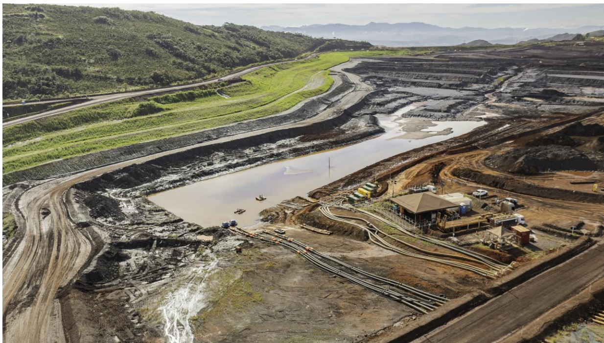
Figura 20 - Vista da Barragem Vargem Grande, após processo de revegetação bem estabelecido da ombreira esquerda da barragem. (Fonte: Vale, 01 de abril de 2024).
