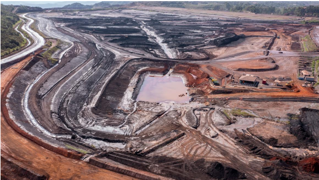
Figura 18 - Vista da Barragem Vargem Grande, com foco na ombreira esquerda, durante o período de aplicação de MVP (Fonte: Vale, 01 de dezembro de 2023).
