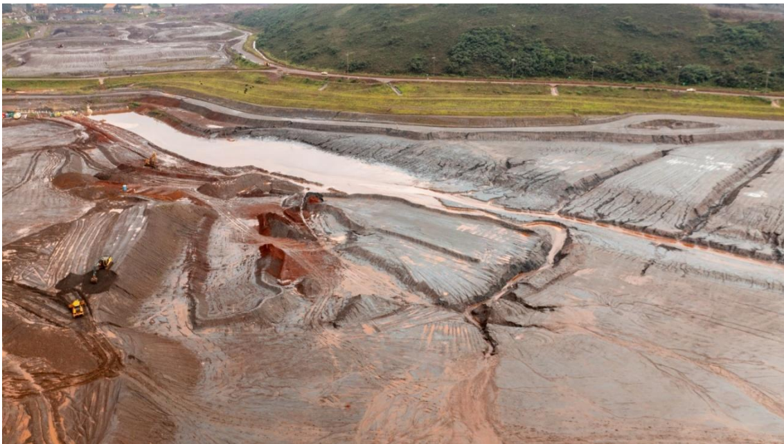
Figura 28 - Vista da Barragem Vargem Grande, após processo de revegetação bem estabelecido da ombreira esquerda da barragem – período chuvoso. (Fonte: Vale, janeiro de 2025).
