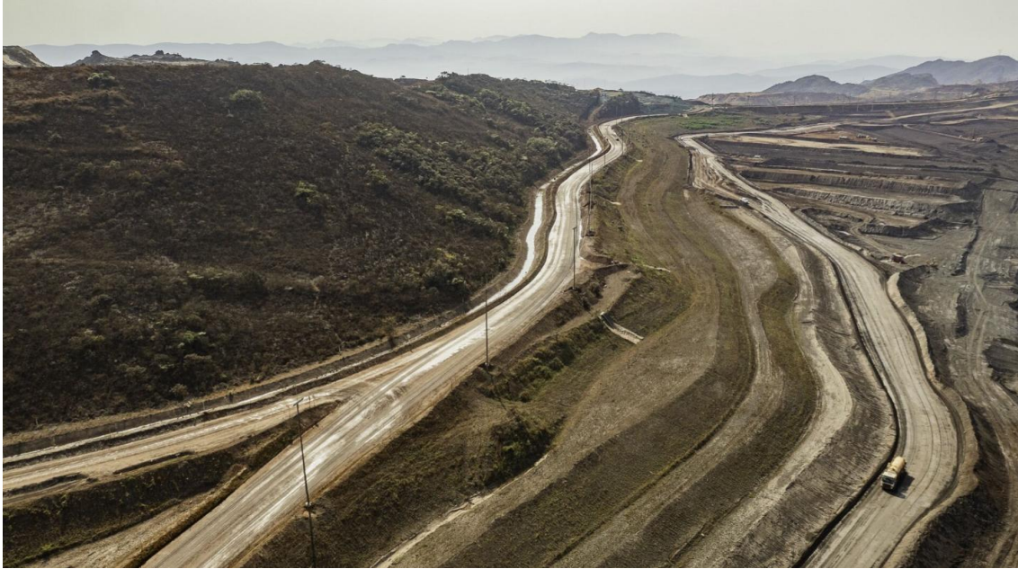
Figura 23 - Vista da Barragem Vargem Grande, após processo de revegetação bem estabelecido da ombreira esquerda da barragem – período de seca. (Fonte: Vale, 27 de setembro de 2024).
