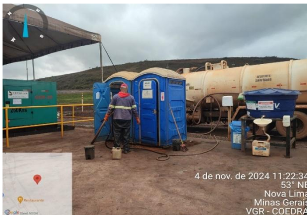
Figura 75 - Inspeção da limpeza dos banheiros nas frentes de serviço. (Fonte: Vale, 2024)
