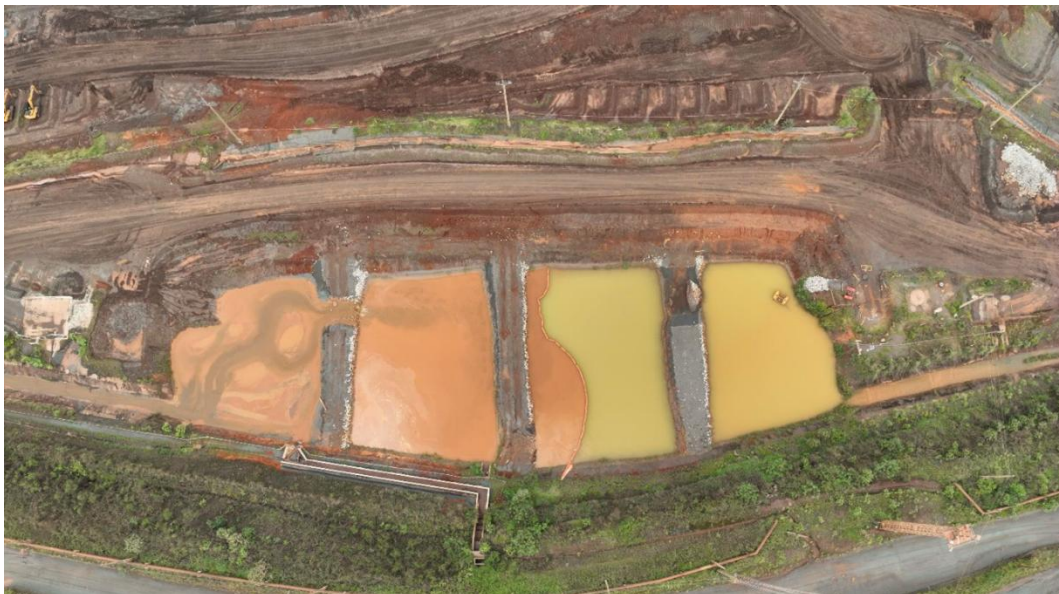
Figura 11 - Visão do SUMP 02 de contenção de sedimentos após projeto de melhorias (08/01/2025).
