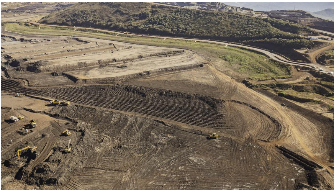
Figura 22 - Vista da Barragem Vargem Grande, após processo de revegetação bem estabelecido da ombreira esquerda da barragem – período de seca. (Fonte: Vale, 06 de junho de 2024).
