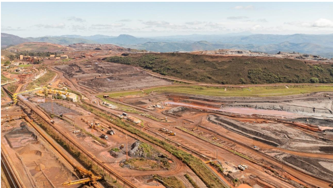
Figura 26 - Vista da Barragem Vargem Grande, após processo de revegetação bem estabelecido da ombreira esquerda da barragem – período chuvoso. (Fonte: Vale, 27 de novembro de 2024).
