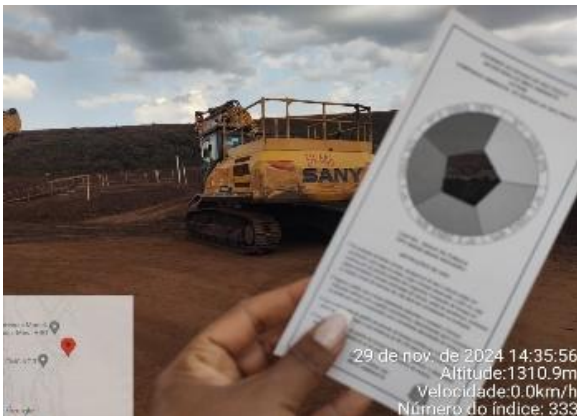
Figura 34 - Monitoramento de fumaça preta dos veículos e equipamentos das frentes de serviço. (Fonte: Vale, novembro de 2024)
