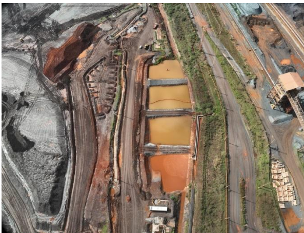
Figura 16 SUMP CC02 e canal de cintura (Fonte: Vale, novembro de 2024).
