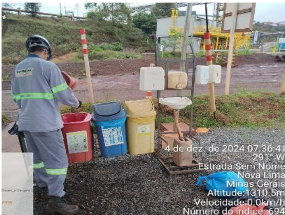
Figura 80 – Recolhimento de resíduos nas frentes de serviço (Fonte: Vale, dezembro de 2024)
