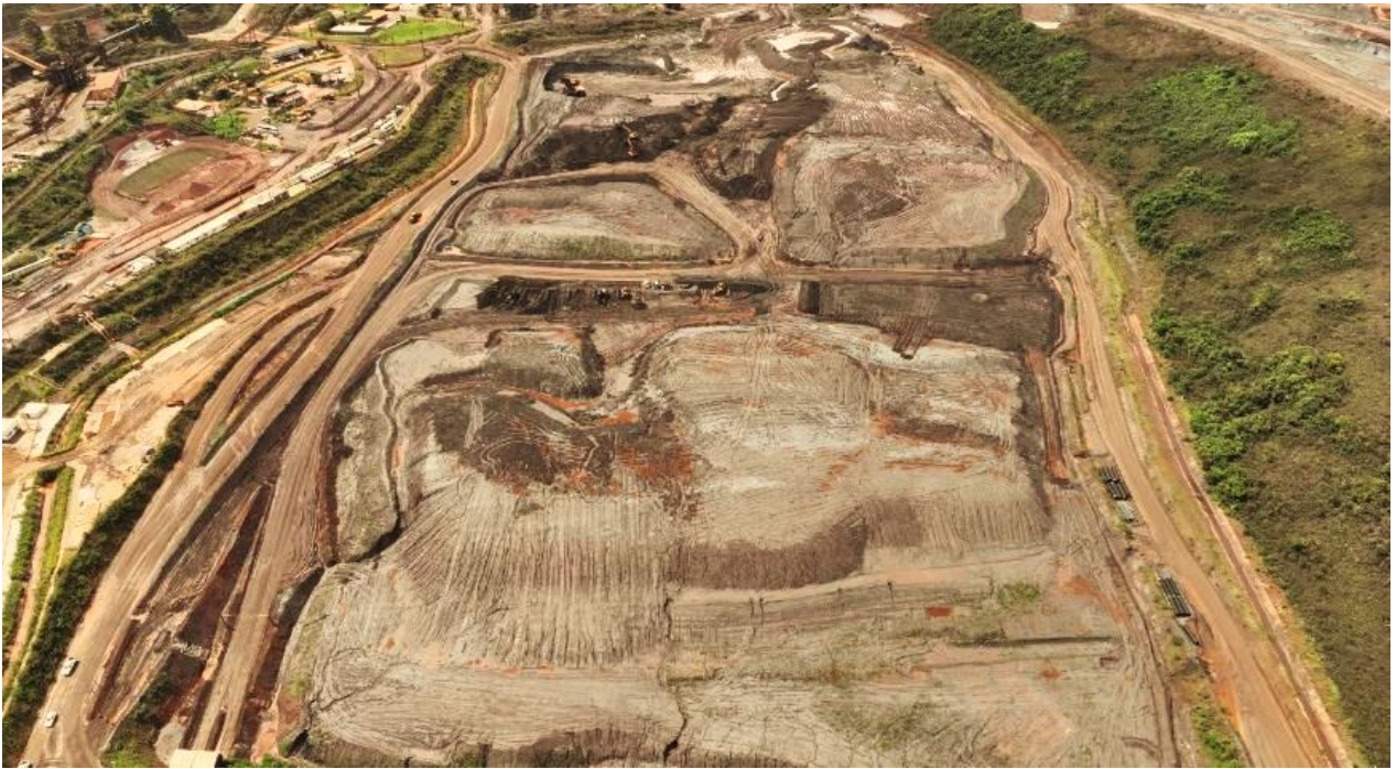
Figura 12 - Visão geral de estocagem temporária na pilha para desaguamento (08/01/2025).
