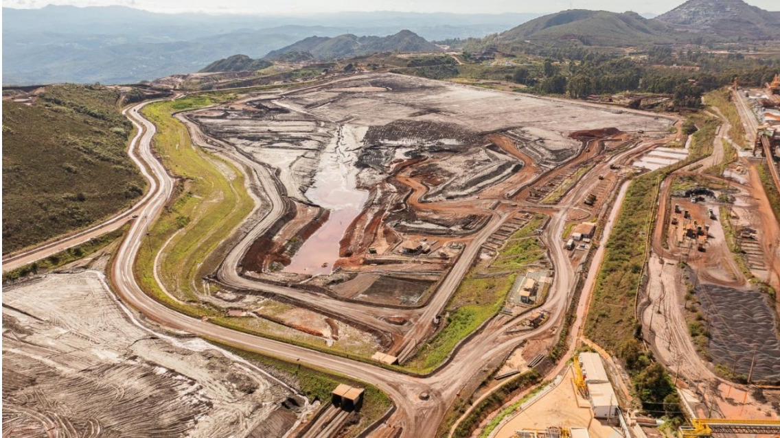
Figura 25 - Vista da Barragem Vargem Grande, após processo de revegetação bem estabelecido da ombreira esquerda da barragem – período chuvoso. (Fonte: Vale, 27 de novembro de 2025).
