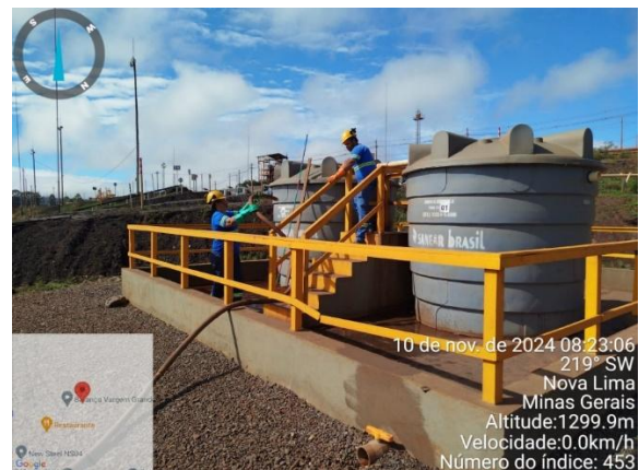
Figura 76 - Sucção do tanque séptico no canteiro. (Fonte: Vale, 2024).
