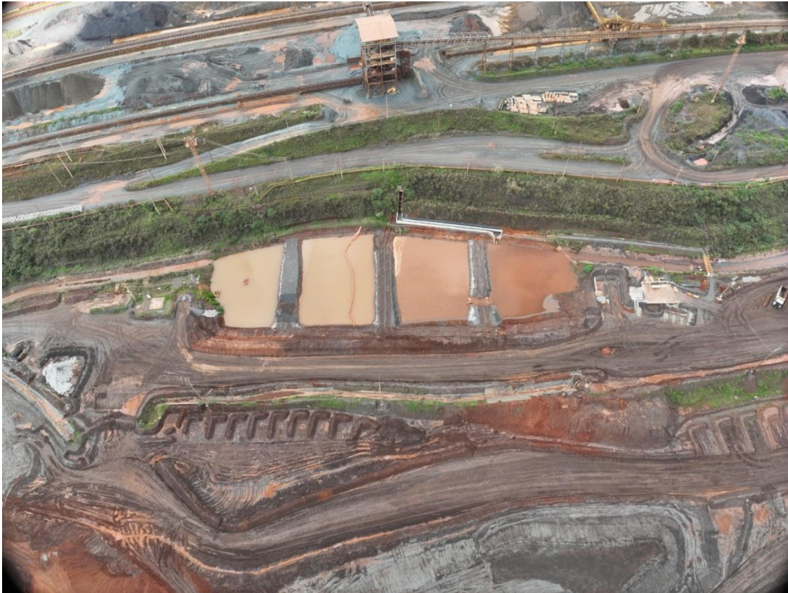
Figura 85 - Imagem aérea do redimensionamento e adequação do SUMP-CC02. Fonte: Vale, novembro de 2024.
