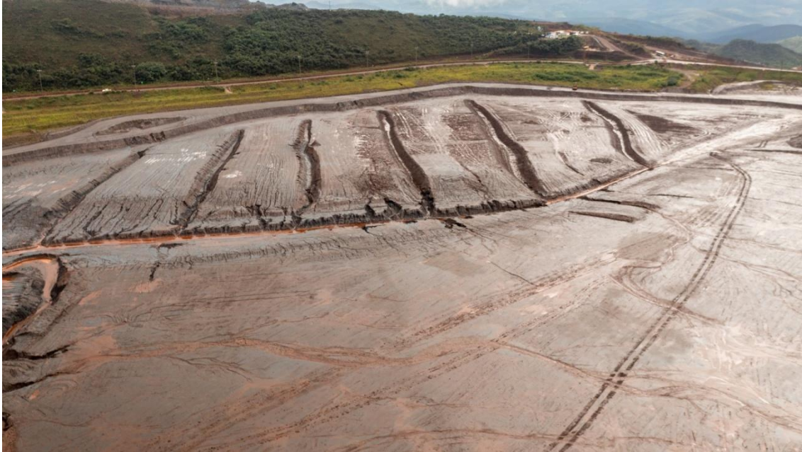
Figura 29 - Vista da Barragem Vargem Grande, após processo de revegetação bem estabelecido da ombreira esquerda da barragem – período chuvoso. (Fonte: Vale, janeiro de 2025).
