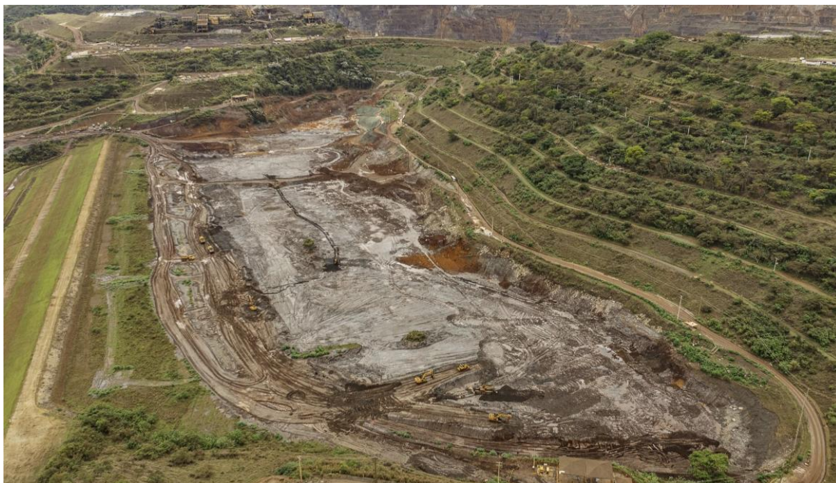
Figura 23 - Vista ombreira esquerda da BSS (31/10/2024), escavação do reservatório.
