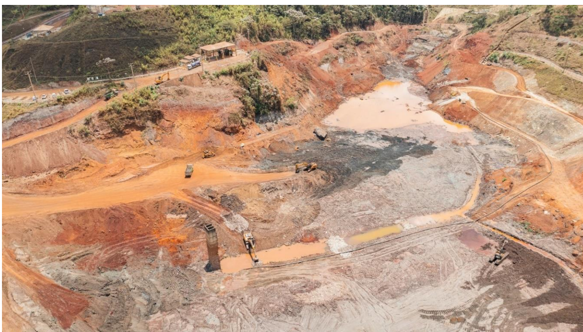
Figura 6 - Sump e Sistema de bombeamento BSS
