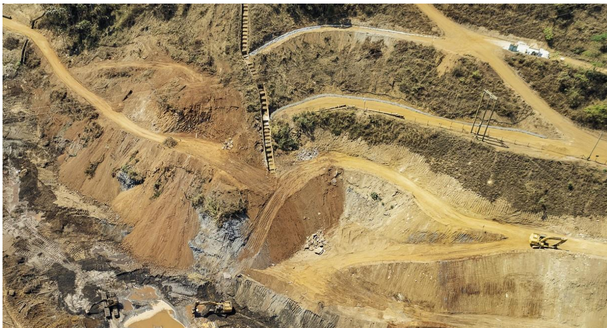
Figura 29 - Localização dos Sumps. Fonte: Vale, 2024.
