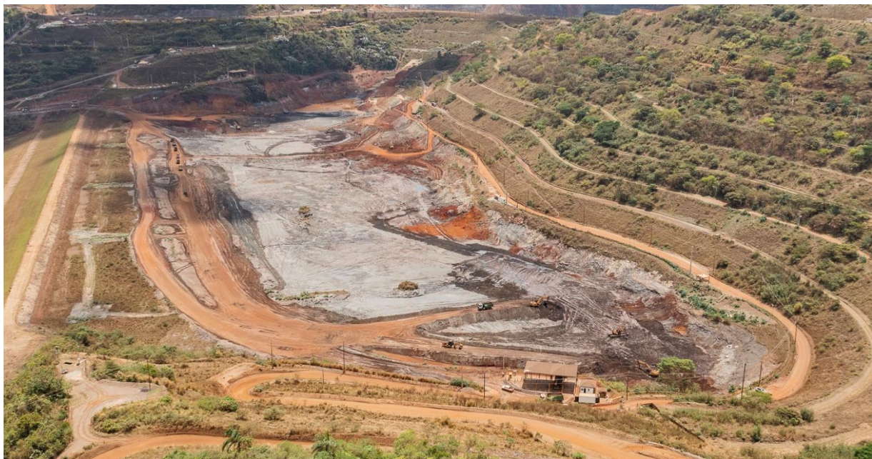
Figura 11 - Vista área da Barragem a partir da ombreira esquerda – Outubro/2024.
