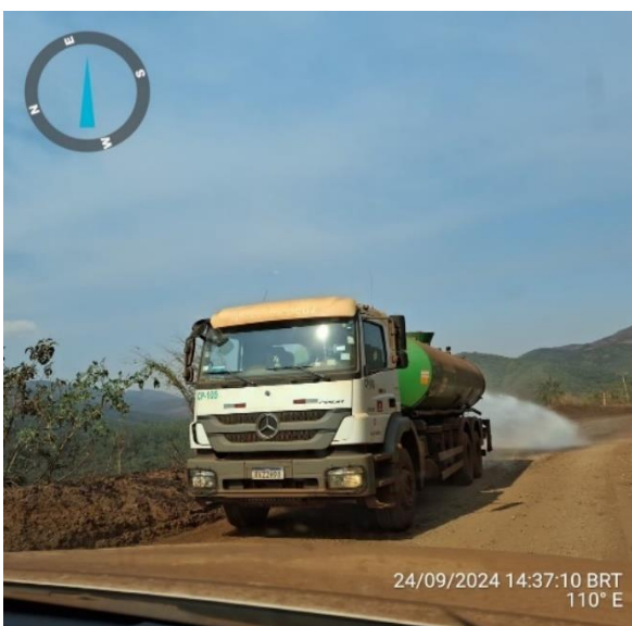
Figura 39 - Umectação de Vias - acesso PDR. Fonte: Vale (29/09/2024).
