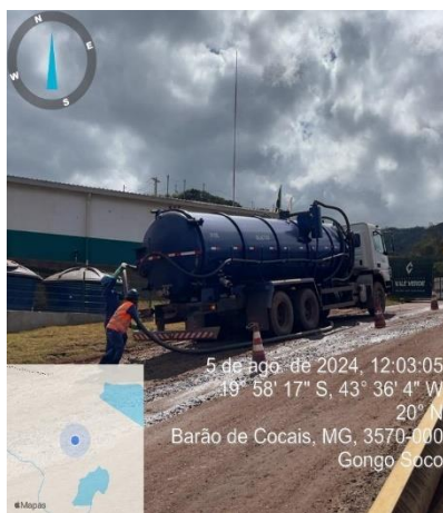
Figura 49 - Sucção de fossas - Canteiro (05/08/2024). Fonte: Vale, 2024.
