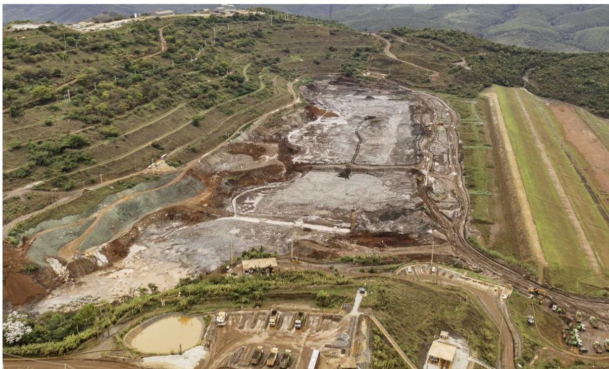
Figura 24 - Vista ombreira direita da BSS – Remoção de rejeitos no reservatório (31/10/2024).
