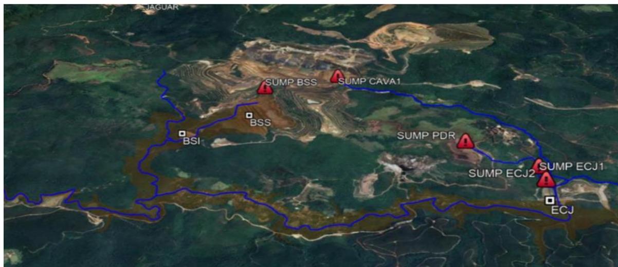
Figura 28 - Localização dos Sumps. Fonte: Vale, 2024.
