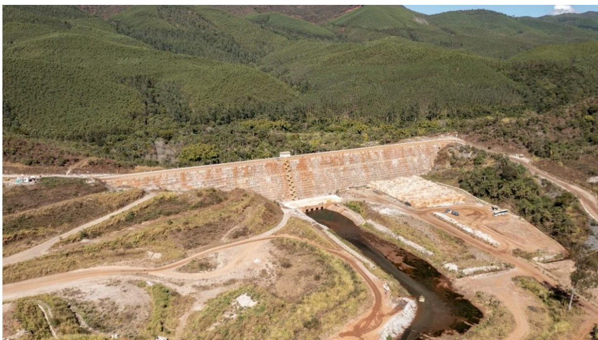
Figura 10 - Estrutura de contenção a Jusante (ECJ) da Barragem Sul Superior.
