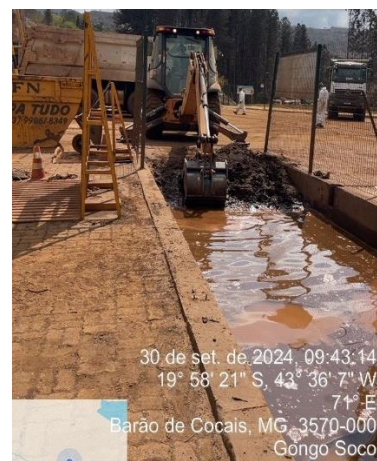
Figura 50 - Limpeza Caixa SAO (30/09/2024). Fonte: Vale, 2024.
