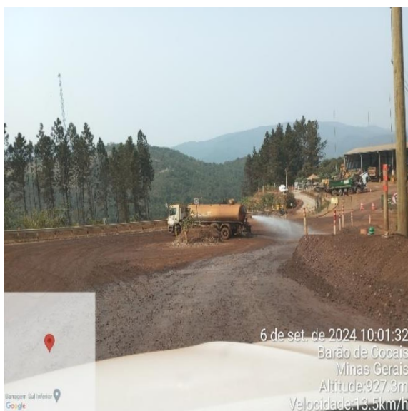
Figura 38 - Umectação de Vias – Acesso Oficina. Fonte: Vale (06/09/2024).
