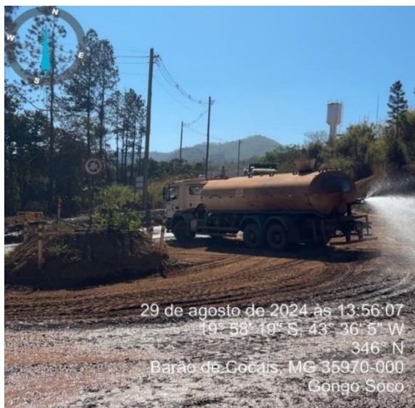
Figura 37 - Umectação de Vias - Acesso ao canteiro Fonte: Vale (29/08/2024)
