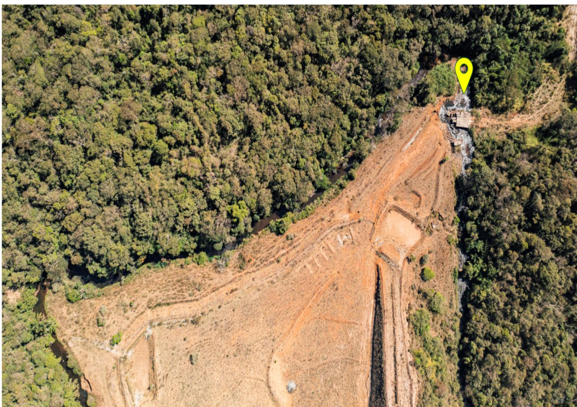
Figura 58 - GSO Remanso. Fonte: Vale (2024).
