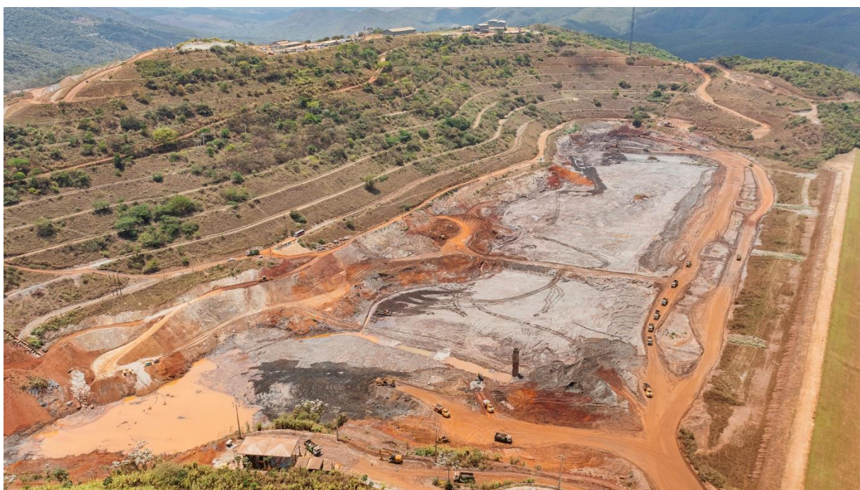
Figura 9 - Visão geral – canal no reservatório de drenagens – sistema de bombeamento de água para tulipa –Outubro/2024.
