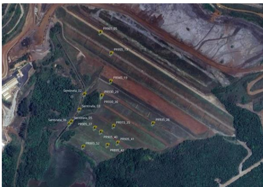
Figura 17 - Localização dos prismas que foram removidos, sendo eles: Sentinelas 02, Sentinelas 03, PR905_40, PR885_52, PR905_37, PR905_41, PR945_19, PR930_29, PR930_30, PR930_25, PR935_PR895_4226, PR955_13, PR965_05, PR955_14, PR965_06.
