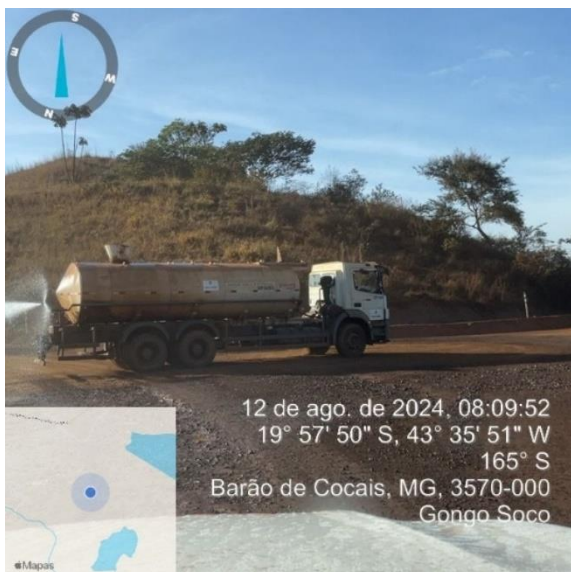
Figura 36 - Umectação de Vias - Pátio dos Caminhões. Fonte: Vale (12/08/2024).
