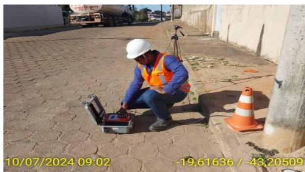
**Figura 268 - Ponto de vibração monitorado próximo a área demolida. Bioma, 2024.**
