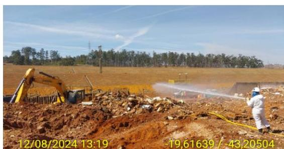
**Figura 220 – Atividade de remoção de entulho em área demolida, tarde, 12/08/2024**
