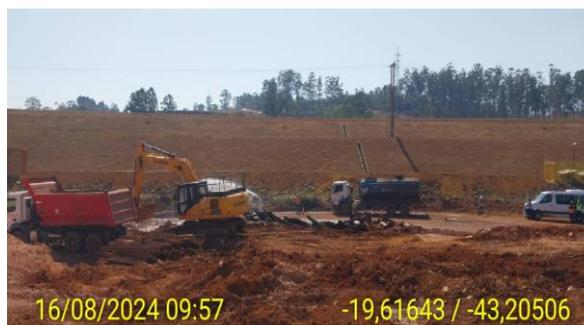
Figura 217 – Atividade de remoção de entulho em área demolida, manhã, 16/08/2024
