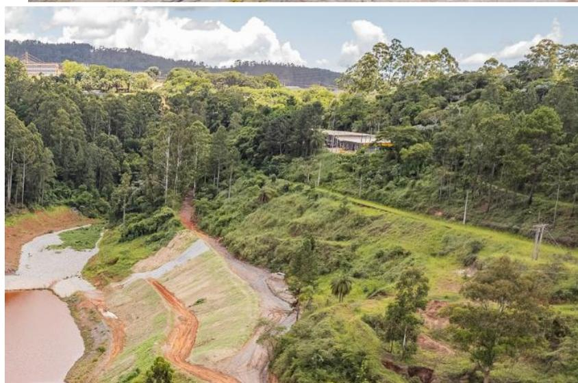
Figura 7 – Revestimento vegetal nos taludes do *Sump* - etapa I do projeto de rebaixamento do N.A do dique Minervino.
