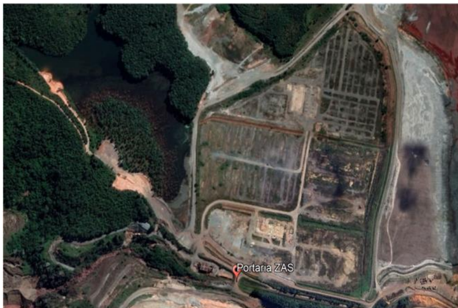
Figura 18 - Localização da Portaria ZAS Dique 1A.
