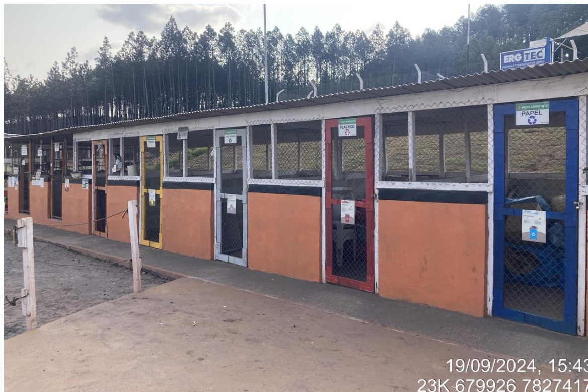
Figura 94 - Depósito Intermediário de Resíduos Dique 1A, também utilizado para as obras do Dique 1B. (Fonte: Vale, 2024).
