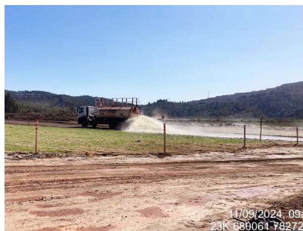
Figura 73 - Umectação de vias de acesso as obras de descaracterização do Dique 1A e 1B. Fonte: Vale, 2024
