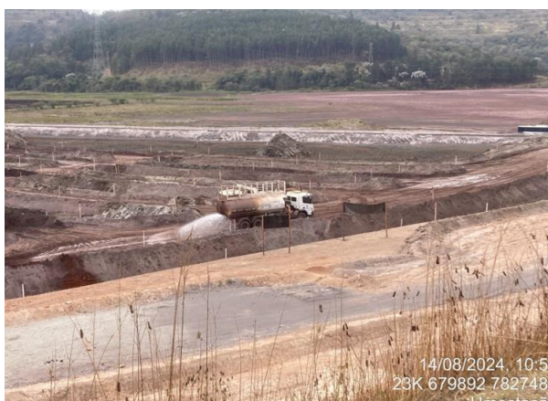
Figura 71 - Umectação de vias de acesso as obras de descaracterização do Dique 1B. Fonte: Vale, 2024.
