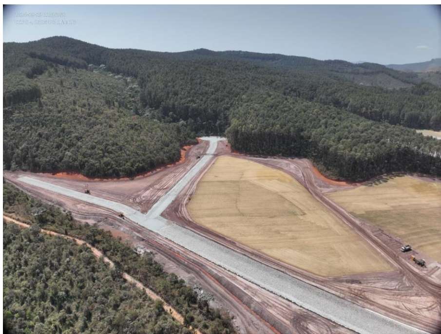
Figura 19 - Canais de drenagem a montante do reservatório do Dique 1A (Outubro/24).
