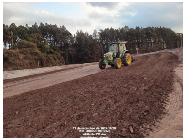
Figura 101 - Execução de gradagem do solo 17/09/2024 nas áreas do Dique 1A. Fonte: Vale, 2024.
