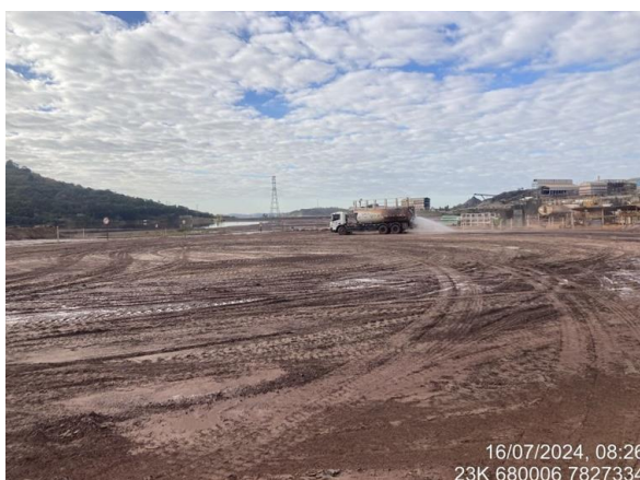
Figura 70 - Umectação de vias de acesso as obras de descaracterização do Dique 1ª. Fonte: Vale, 2024.
