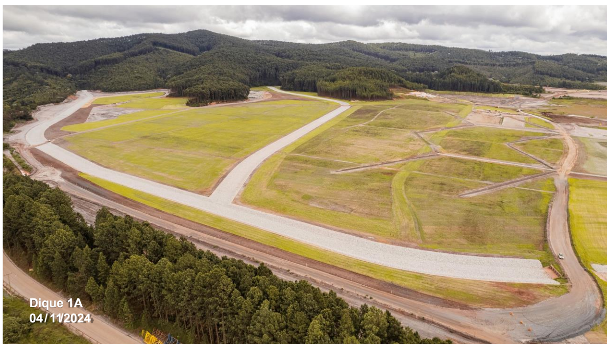
Figura 33 - Canais de Drenagem Permanente construídos conforme projeto direcionando águas para Barragem Conceição. Fonte, Vale, 2024.
