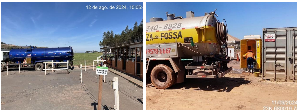
Figura 87 e Figura 88 - Evidências de Limpeza dos banheiros químicos e sucção de efluentes sanitários. Fonte: Vale, 2024.
