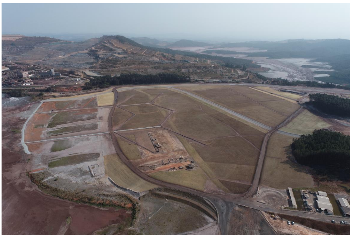
Figura 22 - Visão Geral do Dique 1A (Outubro/24).
