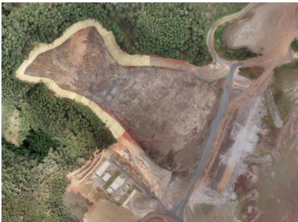
Figura 25 - Conclusão da escavação e do acesso do Dique 1B (Outubro/24).
