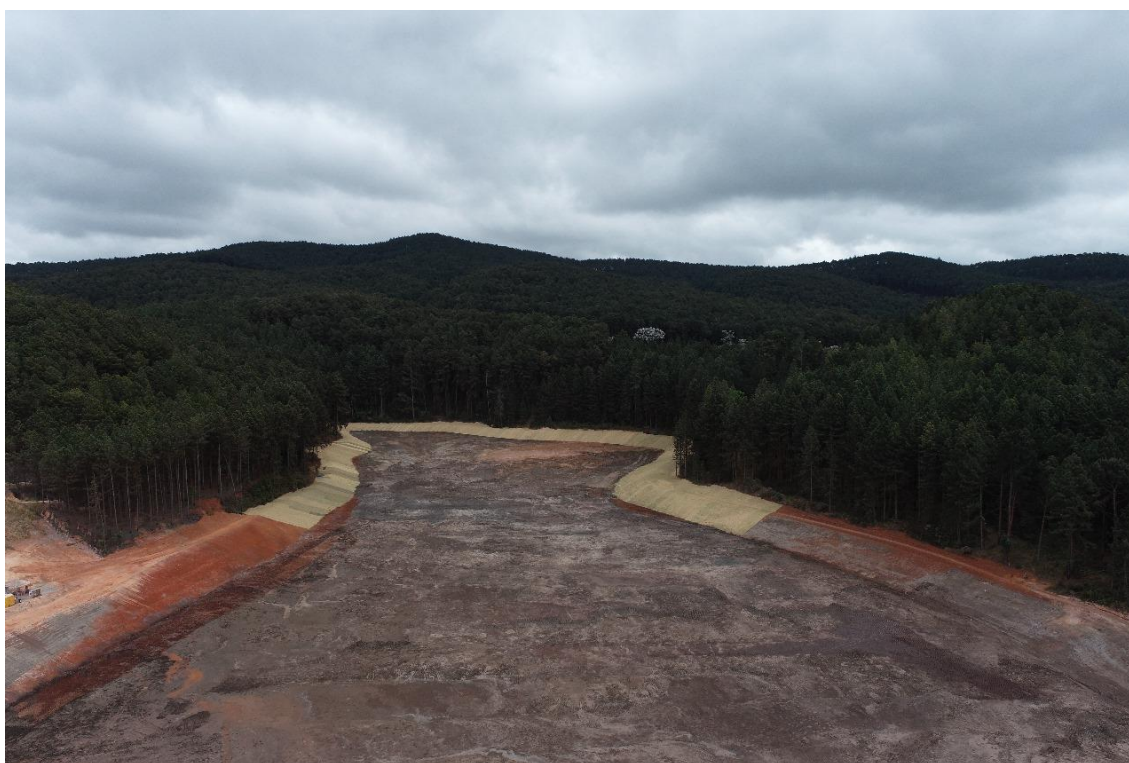
Figura 24 - Conclusão da escavação do Dique 1B (Outubro/24).
