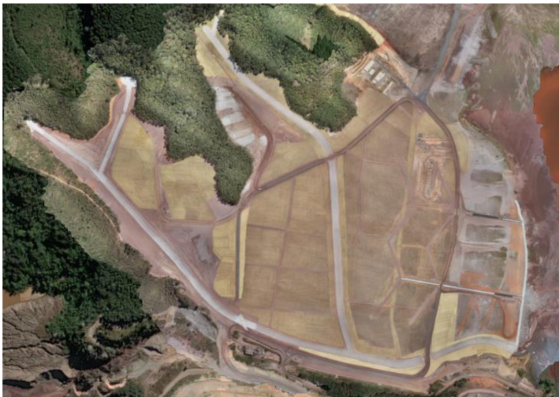
Figura 23 - Visão Geral do Dique 1A (Outubro/24).
