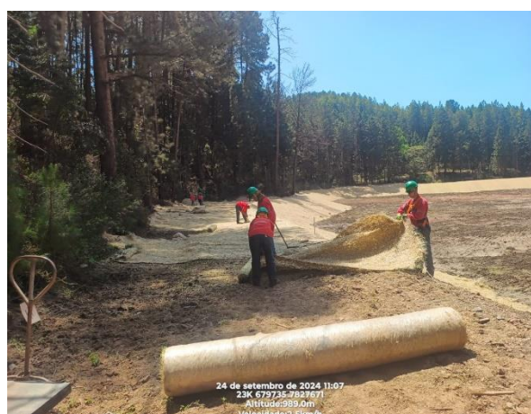
Figura 111 - Biomanta aplicada sobre a área de intervenção no Dique 1B em 24/09/2024 : Fonte: Vale, 2024
