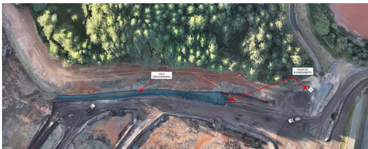
Figura 16 - Sistema de Rebaixamento de freática Dique 1B.
