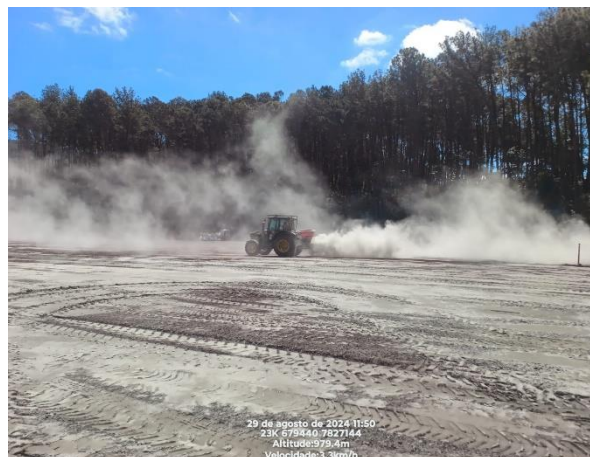
Figura 97 - Execução de práticas de correção do solo em 29/08/2024 nas áreas do Dique 1A. Vale, 2024.
