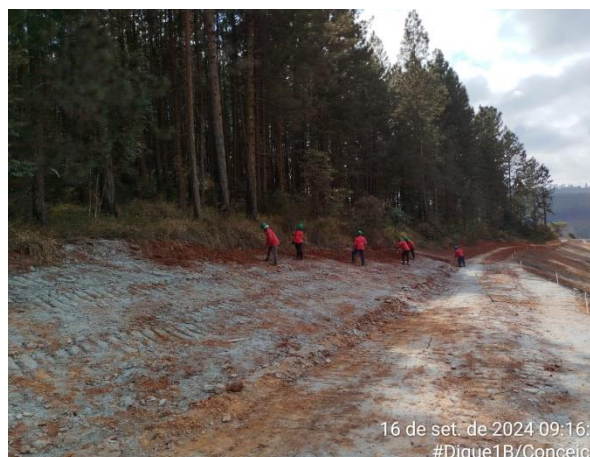
Figura 99 - Execução de práticas de correção do solo em 16/09/2024 nas áreas do Dique 1B. Vale, 2024.
