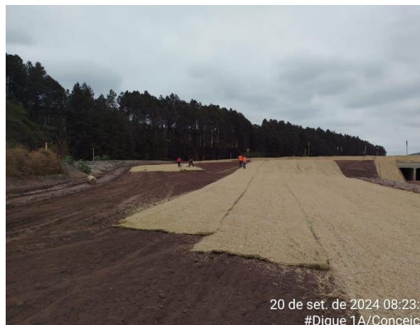
Figura 109 - Biomanta aplicada sobre a área de intervenção no Dique 1A em 20/09/2024 : Fonte: Vale, 2024
