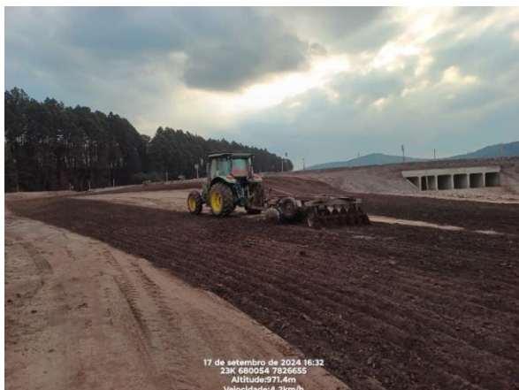
Figura 100 - Execução de gradagem do solo 17/09/2024 nas áreas do Dique 1A. Fonte: Vale, 2024.
