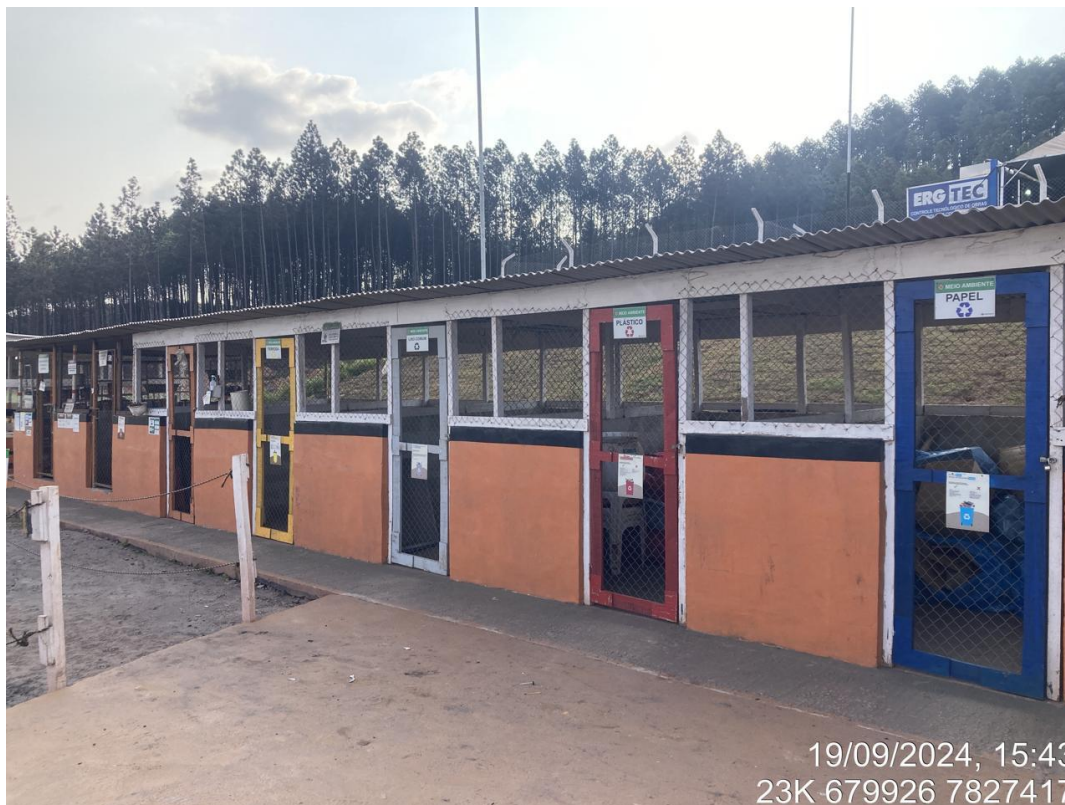
Figura 10 - Depósito Intermediário de Resíduos (DIR) localizado no Dique 1A, também utilizado para as obras do Dique 1B. (Fonte: Vale, 2024).
