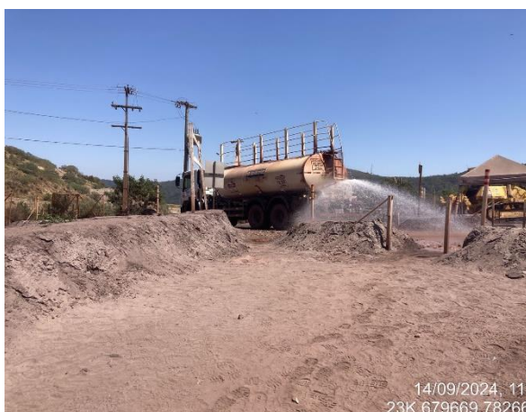
Figura 72 - Umectação de vias de acesso as obras de descaracterização do Dique 1A e 1B. Fonte: Vale, 2024.
