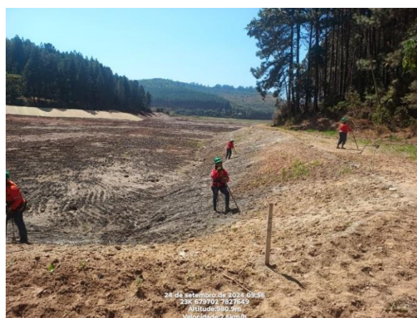
Figura 103 - Execução de coveamento do solo 24/09/2024 nas áreas do Dique 1B. Fonte: Vale, 2024.
