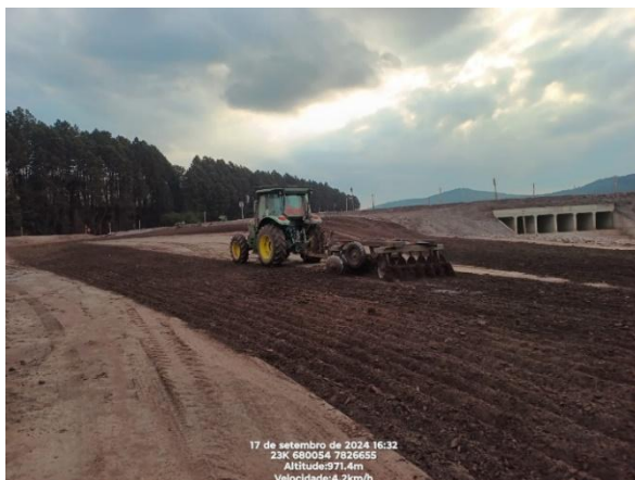
Figura 64 - Execução de gradagem do solo 17/09/2024 nas áreas do Dique 1A. Fonte: Vale, 2024.
