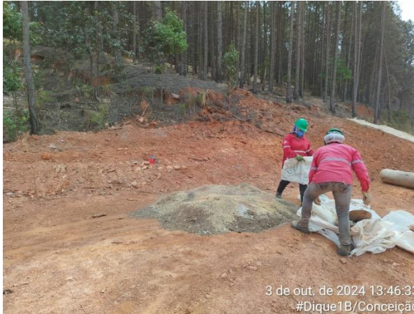
Figura 71 - Preparação do mix de sementes para aplicação nas áreas de plantio do Dique 1B em 03/10/2024. Vale, 2024.
