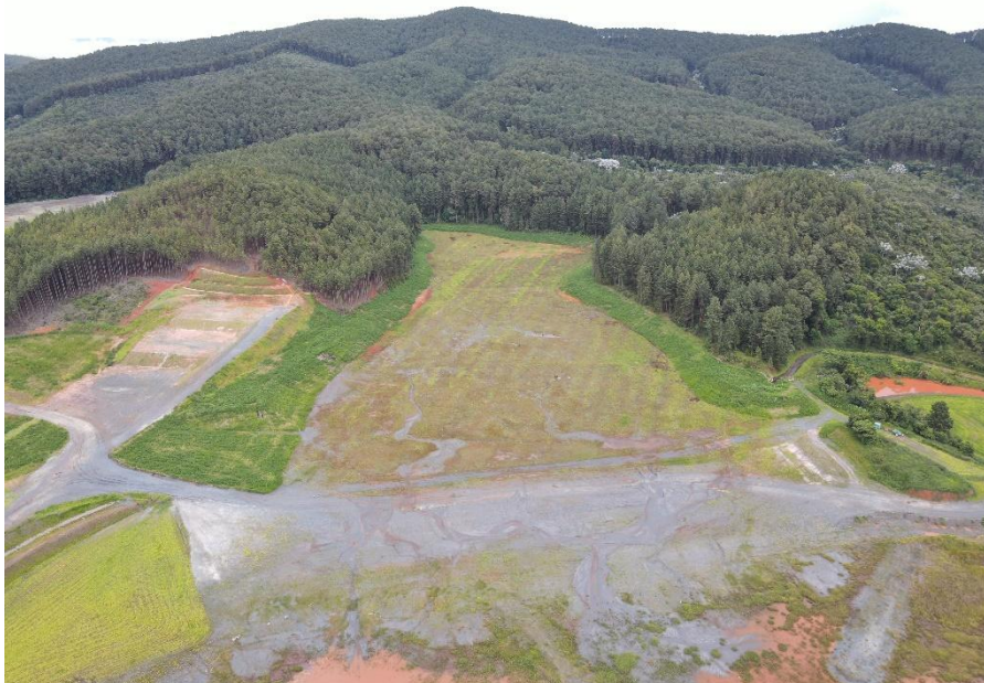
Figura 20 - Visão Geral Dique 1B (Janeiro/25).
