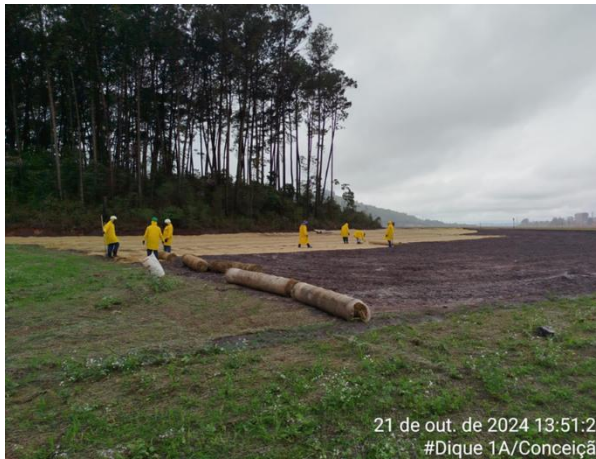
Figura 77 - Biomanta aplicada sobre a área de intervenção no Dique 1A em 21/10/2024: Fonte: Vale, 2024.
