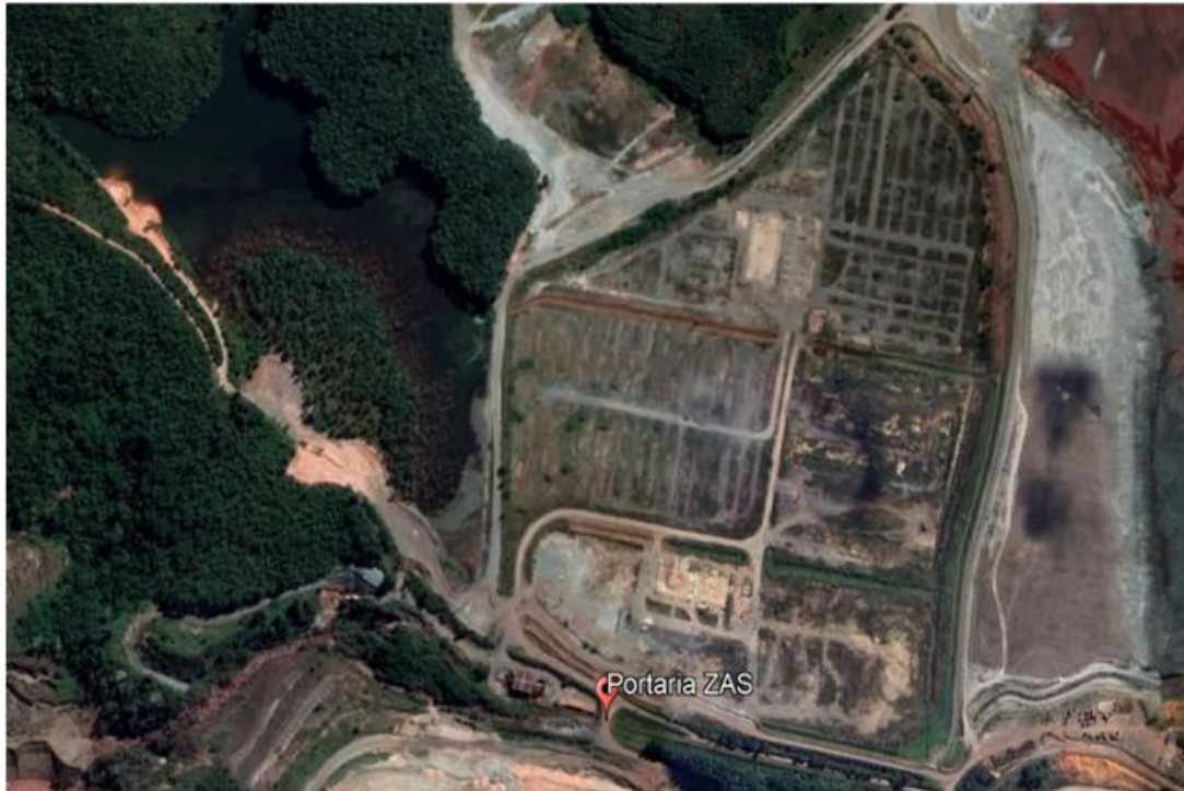
Figura 16 - Localização da Portaria ZAS Dique 1A.
