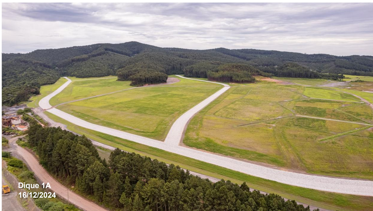
Figura 43 – Canais de Drenagem no Dique 1A em 16/12/2024. Fonte: Vale, 2024
