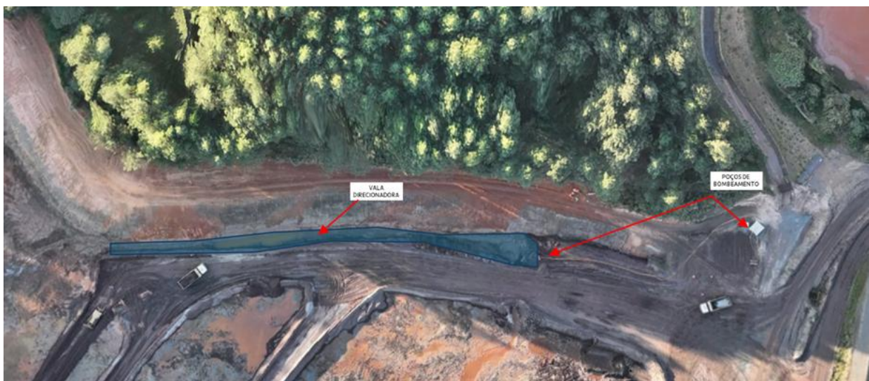
Figura 14 - Sistema de Rebaixamento de freática Dique 1B.
