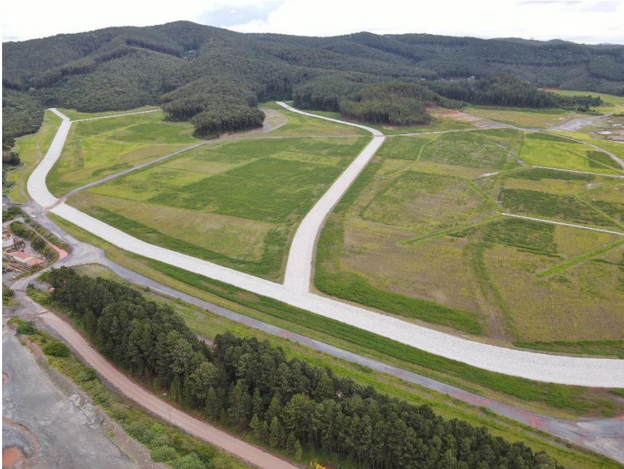
Figura 17 - Canais de drenagem a montante do reservatório do Dique 1A (Janeiro/25).
