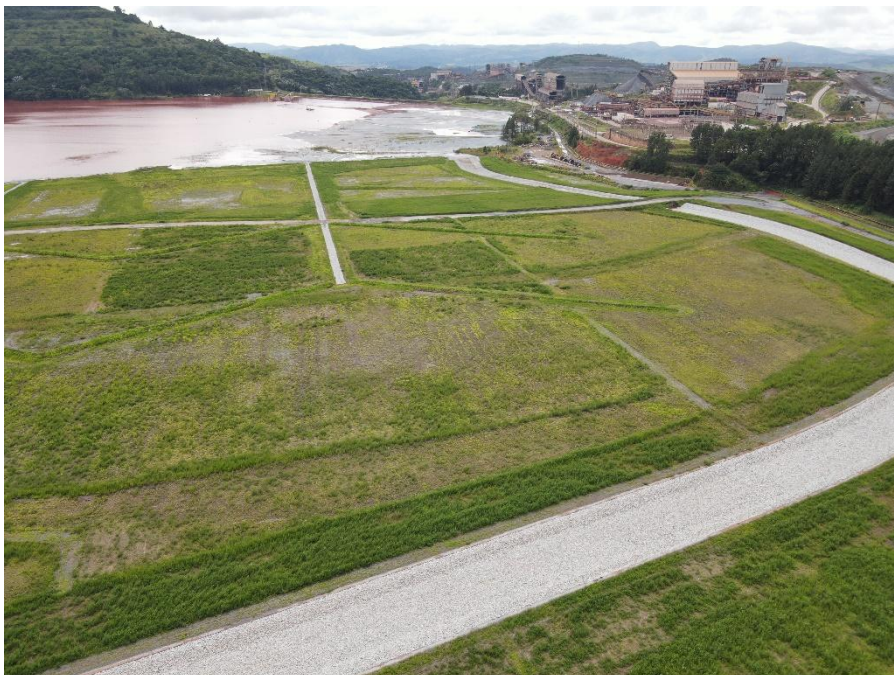
Figura 18 - Canal Secundário - Dique 1A (Janeiro/25).
