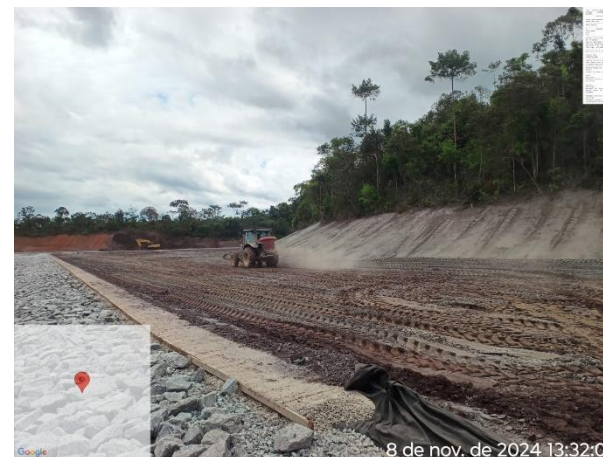
Figura 74 - Aplicação do mix de sementes em trator agrícola para aplicação nas áreas de plantio do Dique 1A em 08/11/2024. Vale, 2024.
