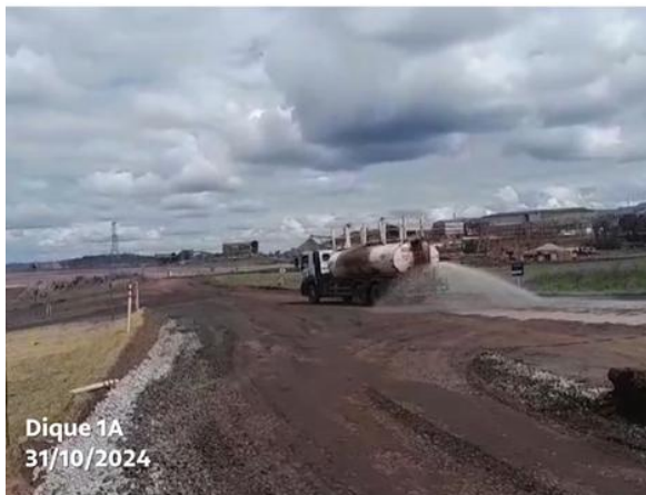
Figura 44 - Umectação de vias de acesso as obras de descaracterização do Dique 1A e 1B em outubro de 2024. Fonte: Vale, 2024.
