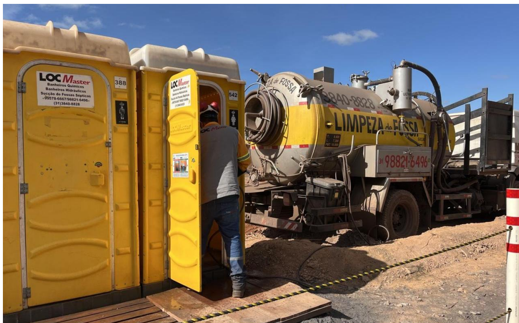
Figura 2 - Evidência de limpeza dos banheiros químicos utilizados nas obras de descaracterização dos Diques 1A e 1B.
