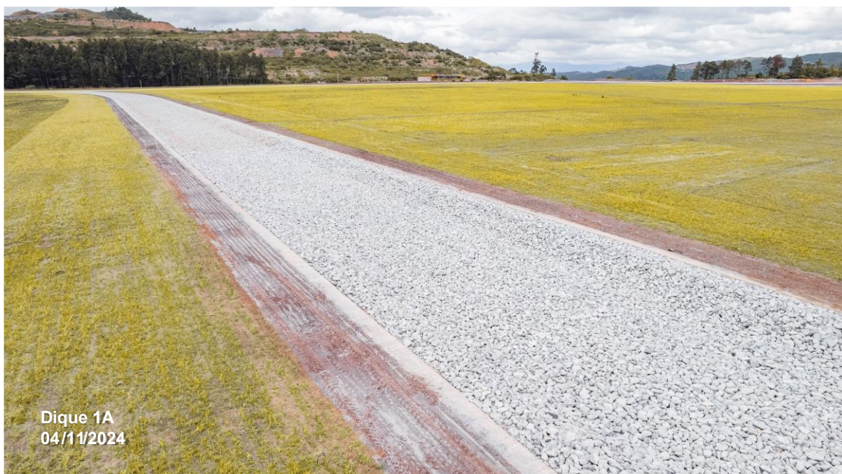
Figura 42 – Canais de Drenagem no Dique 1A em 04/11/2024. Fonte: Vale, 2024
