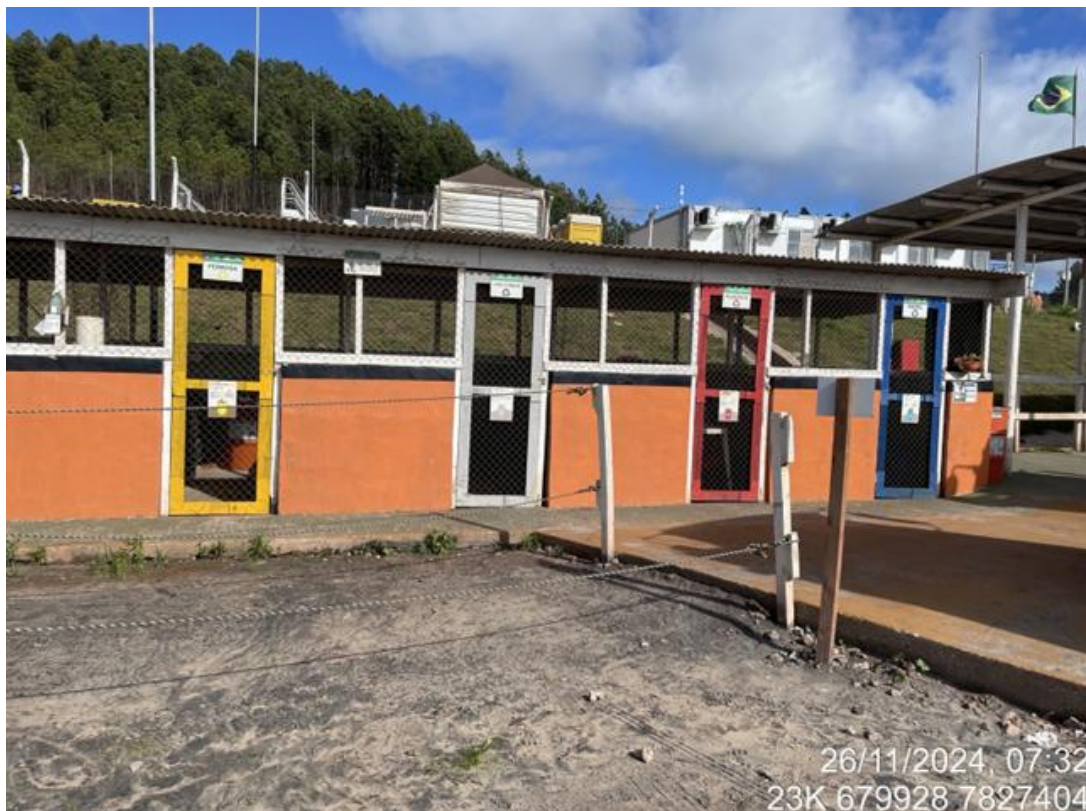
Figura 58 - Depósito Intermediário de Resíduos Dique 1A, também utilizado para as obras do Dique 1B. (Fonte: Vale, 2024).
