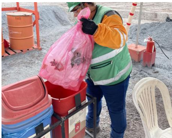
Figura 56 - Coletores de Resíduos em sistema de coleta Seletiva presentes nas obras dos Dique 1A e 1B , (Fonte: Vale, 2024).
