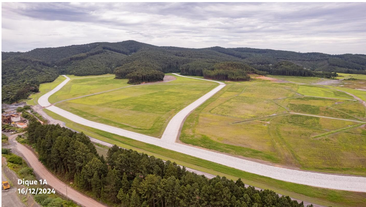
Figura 27 - Canais de Drenagem Permanente construídos conforme projeto para direcionamento de águas para Barragem Conceição. Fonte, Vale, 2024.
