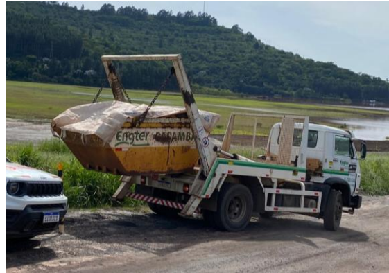
Figura 61 – Caçamba utilizada para a destinação Resíduos de Construção Civil (Entulho) no período de desmobilização das estruturas de apoio às obras Dique 1A e 1B. Fonte: Vale, 2024.
