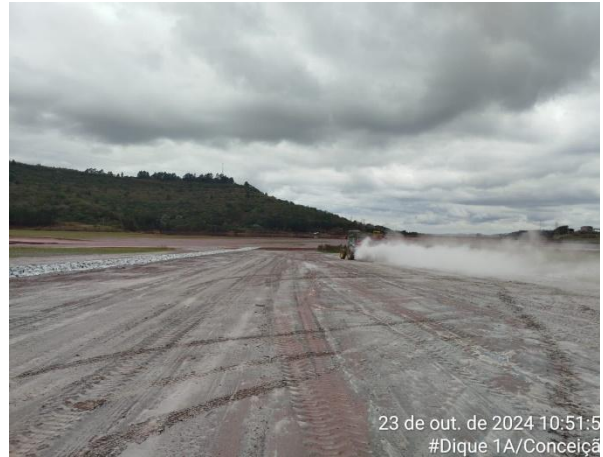
Figura 63 - Execução de práticas de correção do solo em 23/10/2024 nas áreas do Dique 1A. Vale, 2024.
