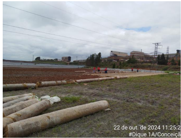
Figura 78 - Biomanta aplicada sobre a área de intervenção no Dique 1A em 22/10/2024 : Fonte: Vale, 2024
