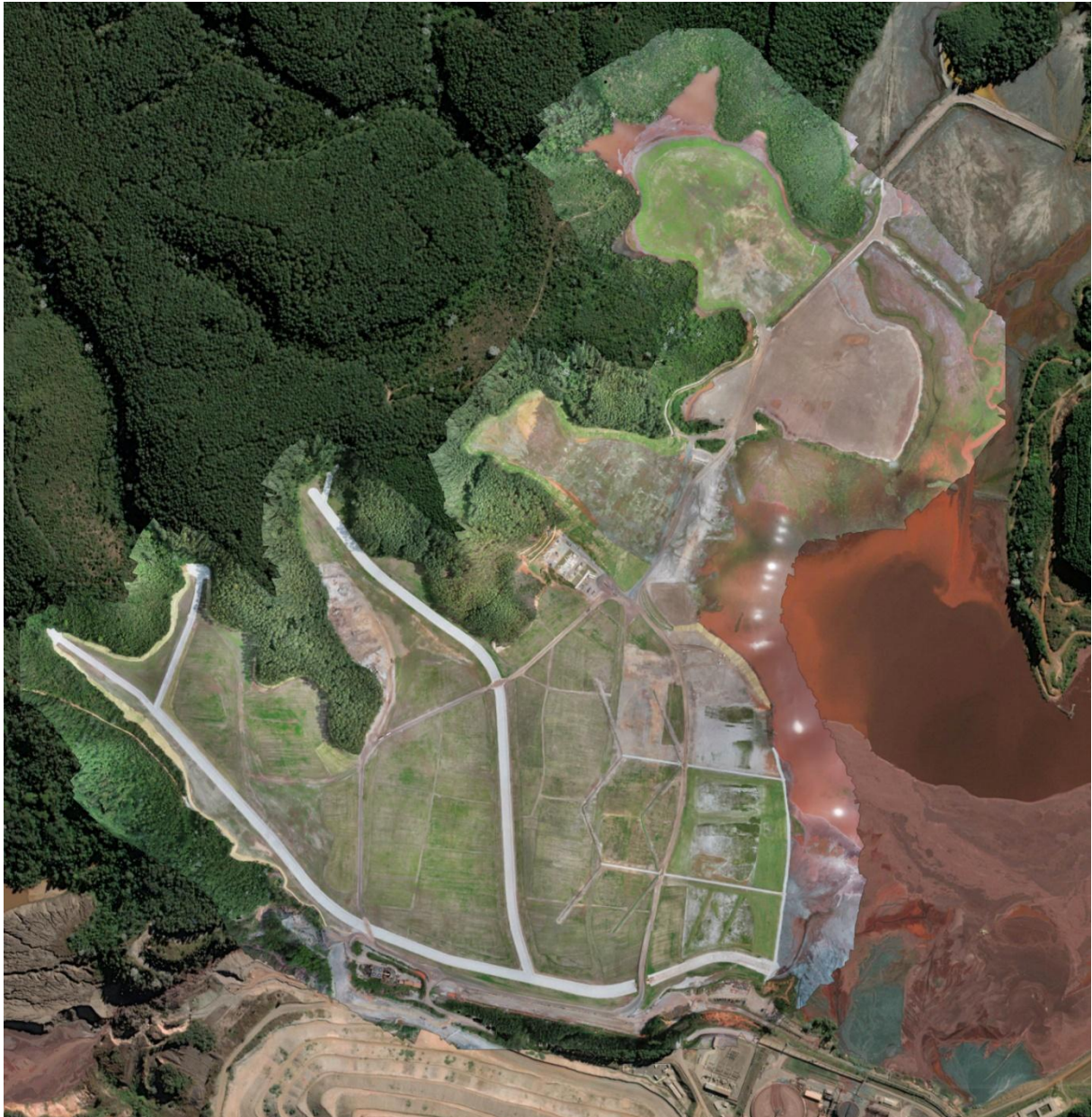
Figura 21 - Visão Geral dos Diques 1A e 1B (Dezembro/24).
