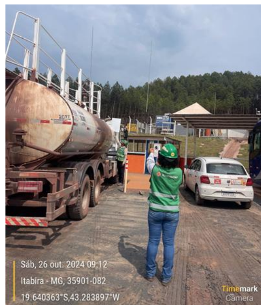
Figura 52 - Controle de emissões atmosféricas proveniente da combustão de motores de equipamentos e veículos movidos a diesel. Dique 1A e 1B. Fonte: Vale, 2024.
