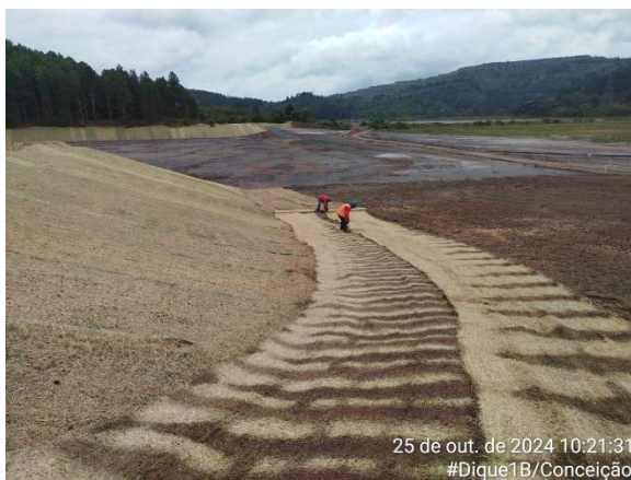
Figura 79 - Biomanta aplicada sobre a área de intervenção no entrono Dique 1B em 25/10/2024: Fonte: Vale, 2024.
