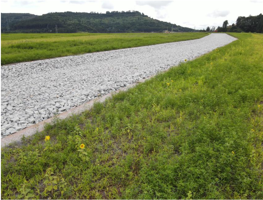
Figura 19 - Canal periférico C1 do Dique 1A (Janeiro/25).
