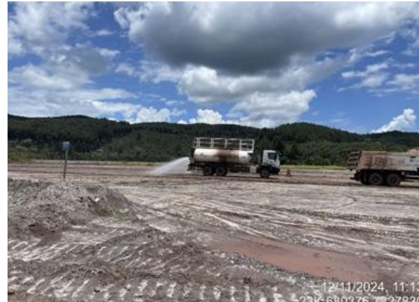
Figura 45 - Umectação de vias de acesso as obras de descaracterização do Dique 1A e 1B em novembro de 2024. Fonte: Vale, 2024.
