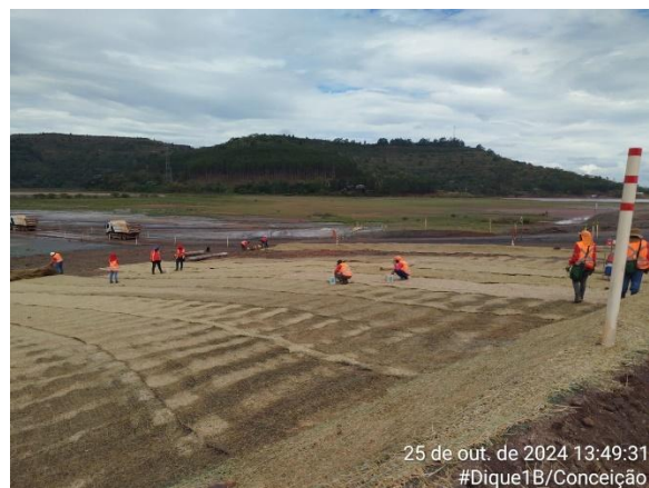
Figura 80 - Biomanta aplicada sobre a área de intervenção no entrono Dique 1B em 25/10/2024: Fonte: Vale, 2024
