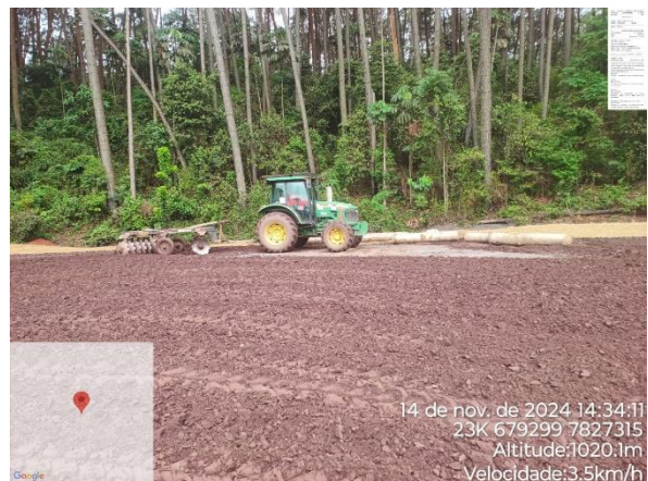
Figura 65 - Execução de gradagem do solo 14/11/2024 nas áreas do Dique 1A. Fonte: Vale, 2024.
