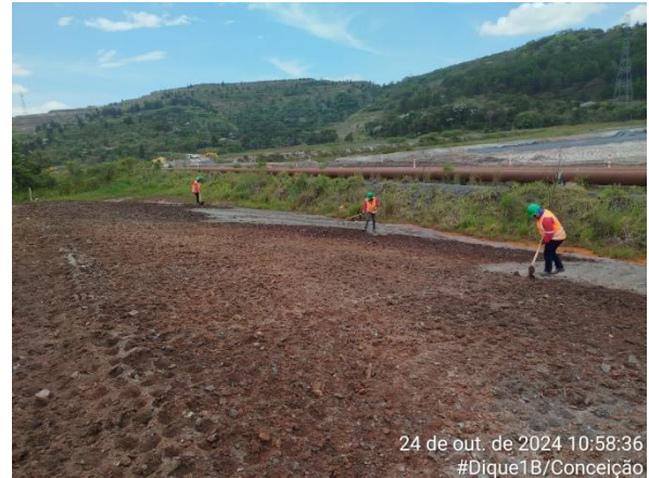
Figura 67 - Execução de coveamento do solo 24/10/2024 nas áreas do Dique 1B. Fonte: Vale, 2024.
