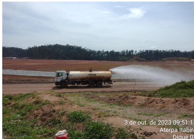
**Foto 14, Foto 15 e Foto 16:** Umectação na área do Dique 02 por meio de caminhão pipa. Fonte: Vale, 2023.
