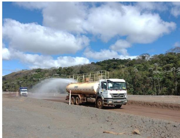
**Foto 17, Foto 18 e Foto 19:** Umectação na área do Sump Minervino por meio de caminhão pipa. Fonte: Vale, 2023.
