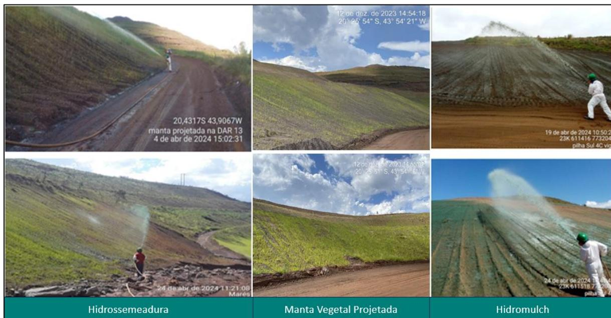
**Figura 52 - Hidrossemeadura e Manta Vegetal Projetada, bem como Hidromulch. Fonte: Vale, 2024.**
