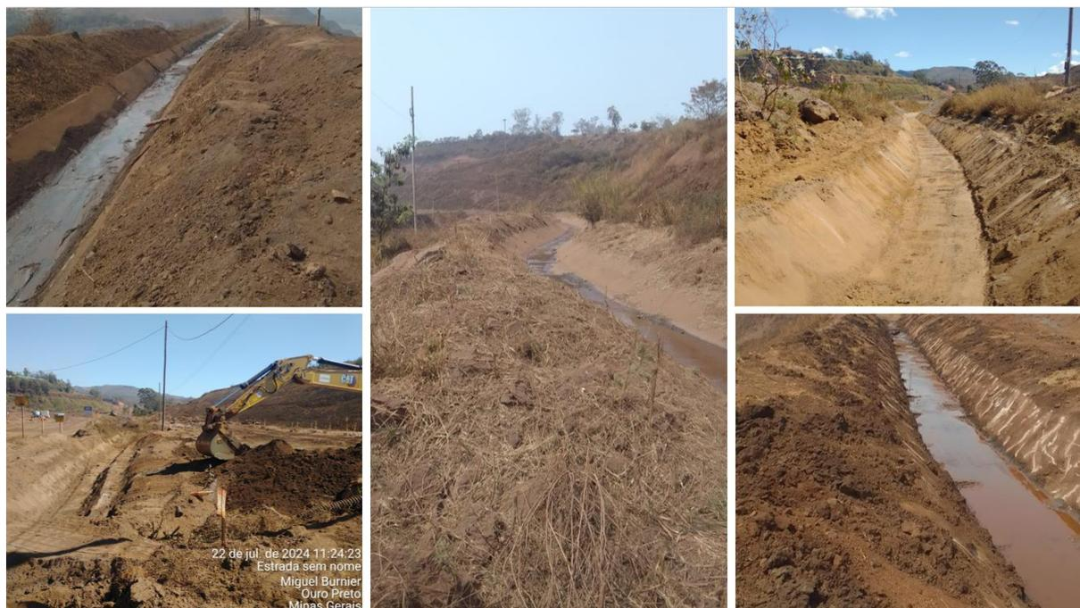
**Figura 23 - Estado de conservação e limpeza dos canais de cintura**
