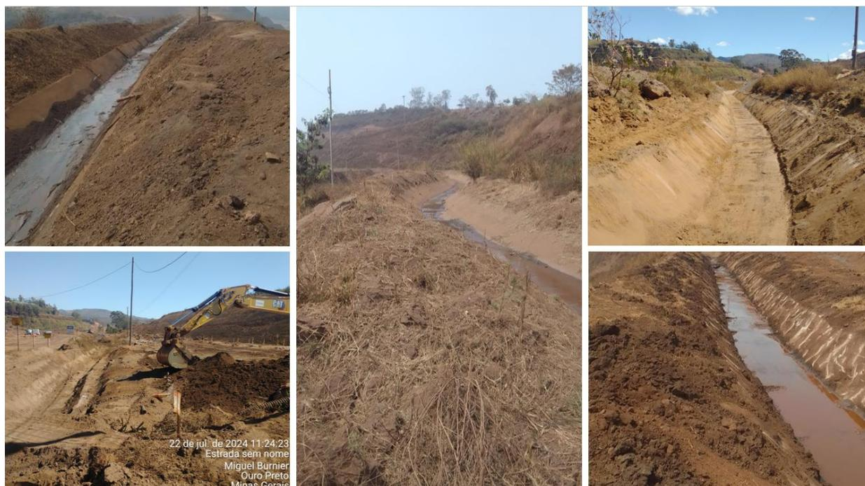
**Figura 9 - Estado de conservação e limpeza dos canais de cintura**
