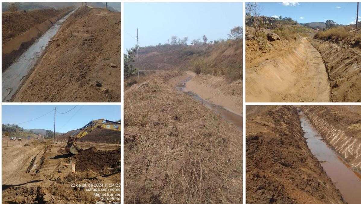
**Figura 34 - Estado de conservação e limpeza dos canais de cintura no período**
