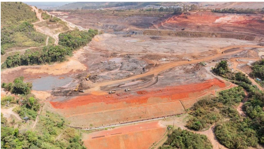
Figura 21 - Andamento da remoção de estruturas abandonadas e sucatas no maciço e reservatório da barragem de Grupo (Outubro/24).
