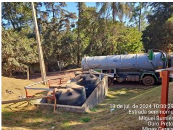
**Figura 83 - Limpeza do tanque séptico instalado no canteiro Grupo. Fonte: Vale, Julho 2024.**
