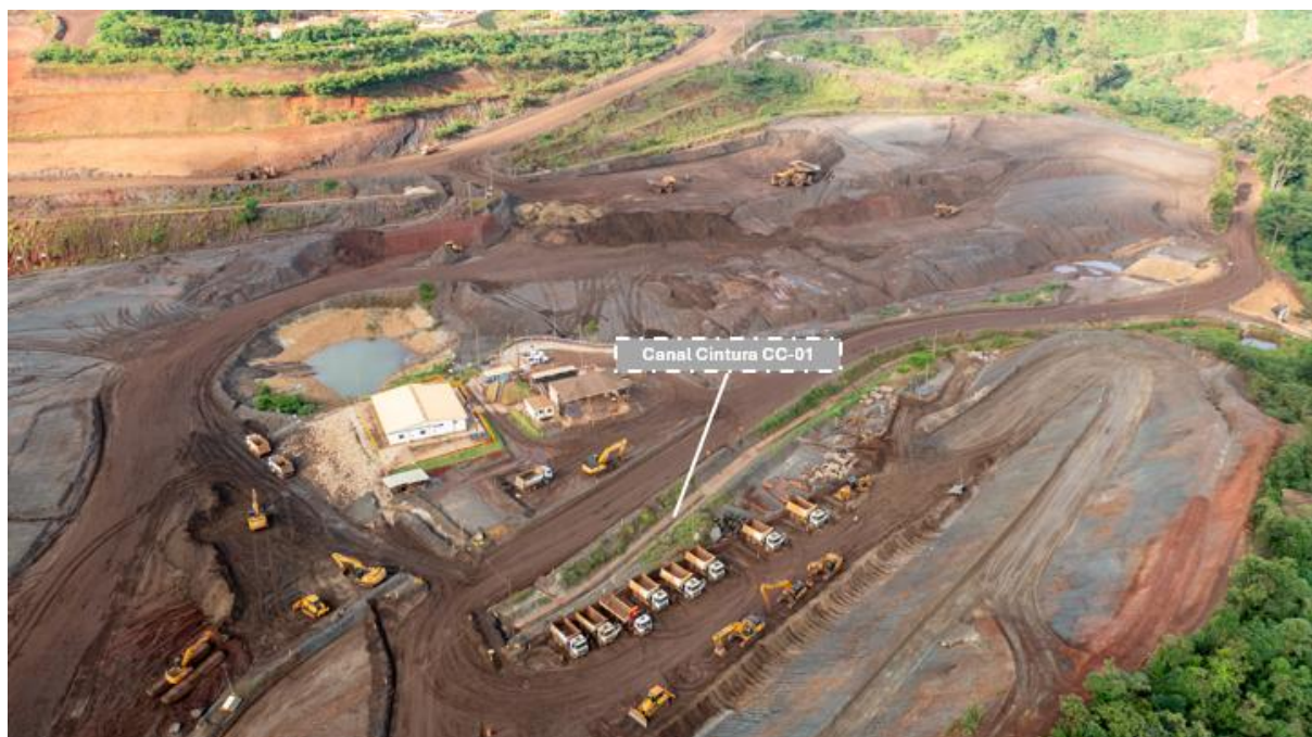
Figura 11 - Estado de conservação e limpeza dos canais de cintura (Janeiro/25)
