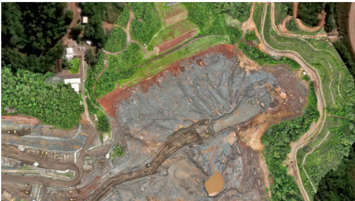
Figura 19 – Escavação de rejeito no reservatório, etapa 3.4 (janeiro/25).
