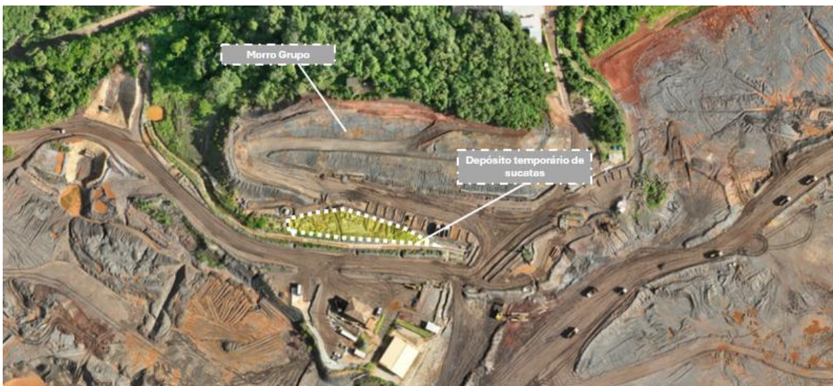
Figura 37 - Área de estocagem temporária de sucatas removidas da estrutura para posterior destinação ao CMD.
