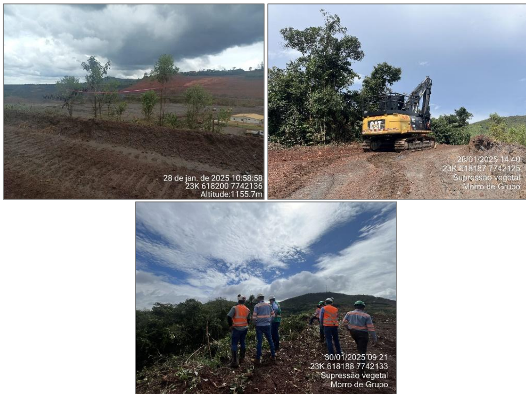
Figura 86 - Isolamento do ninho encontrado, preparação do Feller para começar as atividades de supressão e realização de inspeção entre as equipes responsáveis pelo projeto. Fonte: Vale, 2025.
