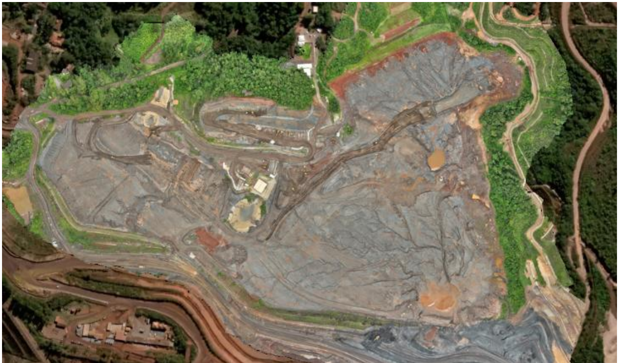
Figura 2 - Manejo de águas superficiais no reservatório (janeiro/25)
