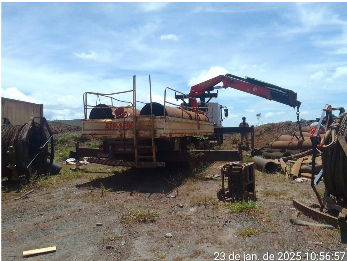
Figura 4 - Continuidade da remoção de sucatas (janeiro/25)
