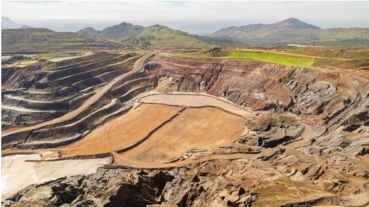
Figura 51 - Disposição definitiva do rejeito da barragem de Grupo na Cava 5 (janeiro/25).
