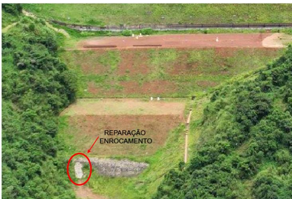
Figura 54 - Reparação do enrocamento do pé da Barragem de Grupo.
