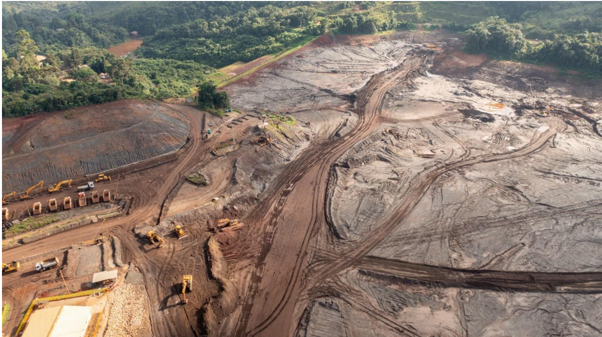
Figura 49 - Escavação dos rejeitos na Etapa 3.4 (janeiro/25).
