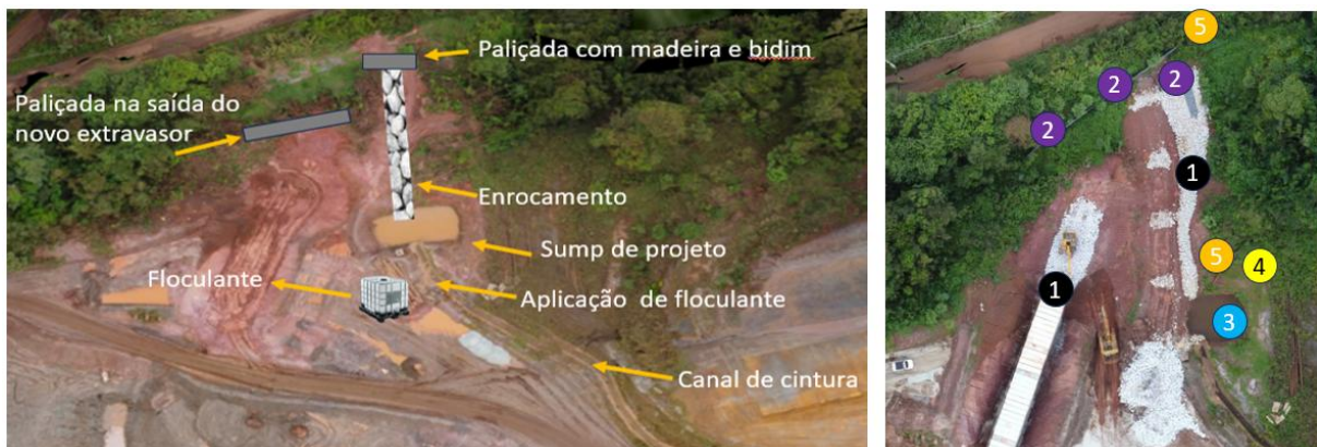
Figura 166 - Controles ambientais já implantados na saída da galeria do extravasor na Cava 10,5. Fonte: Vale, 2024.
