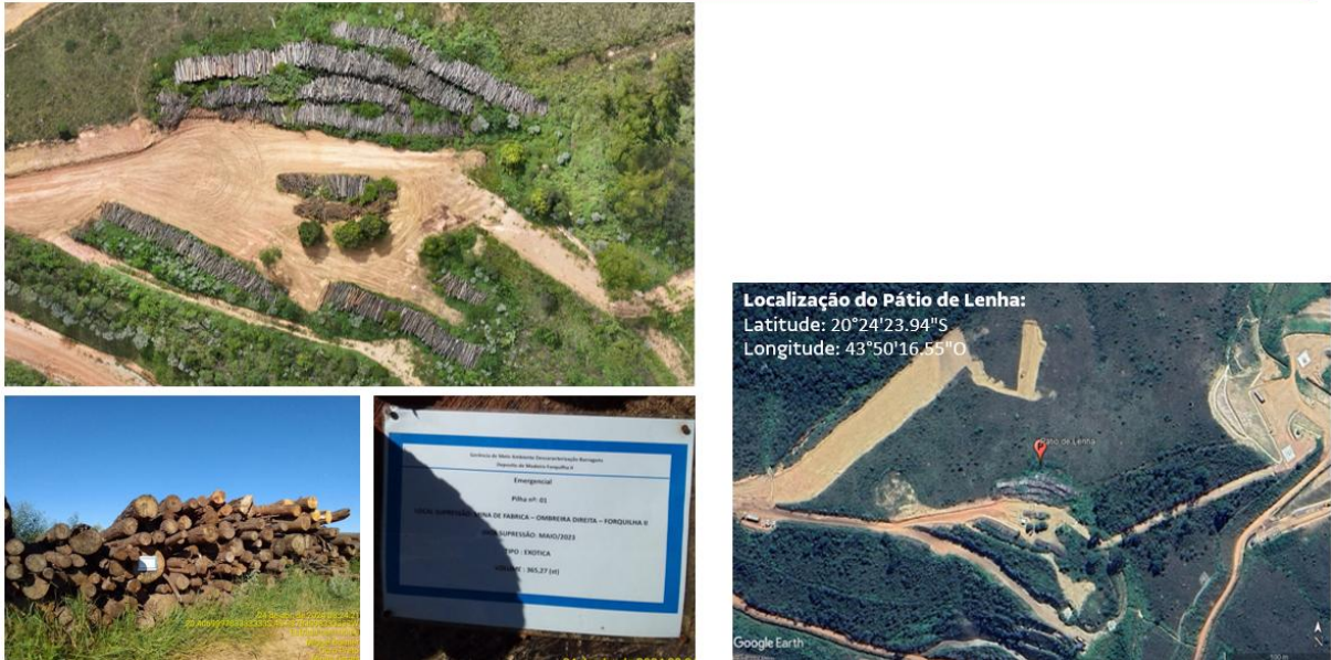
Figura 82 - Pátio de lenha das obras de descaracterização das barragens de Fábrica. Fonte: Vale, 2024.
