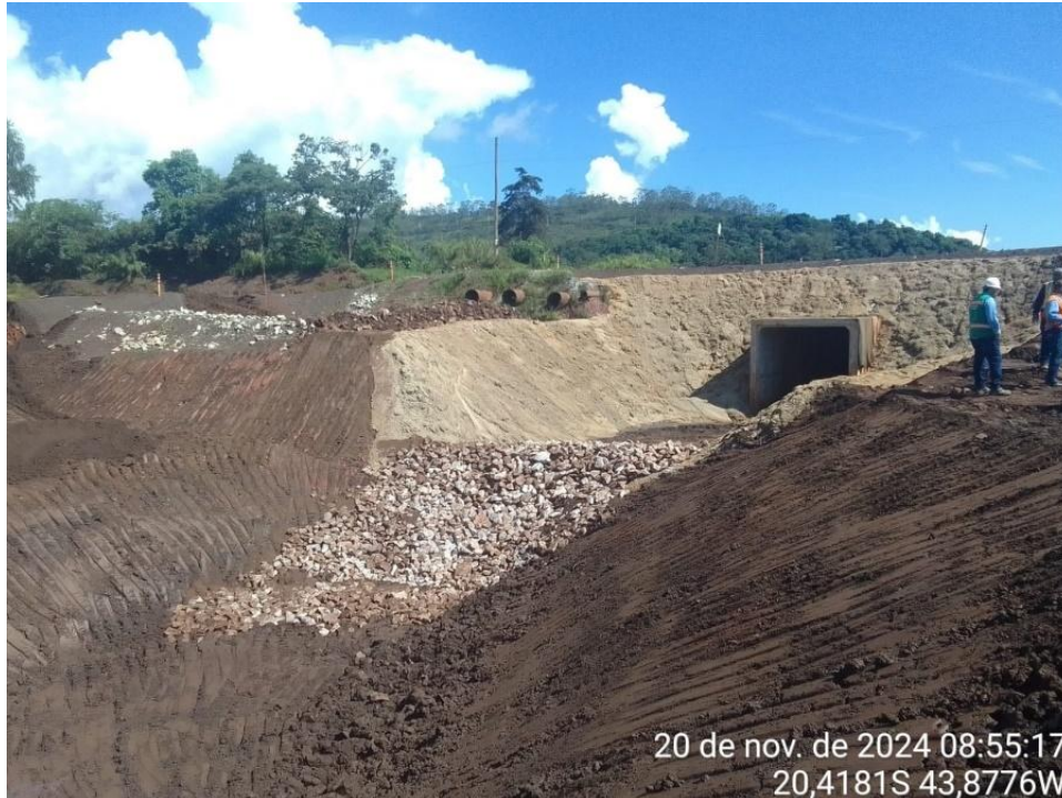
Figura 159 - Sump Cava 10,5 com a borda de enrocamento. Fonte: Vale, 2024.
