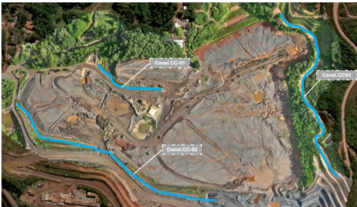
Figura 38 - Localização canais de cintura Barragem Grupo.
