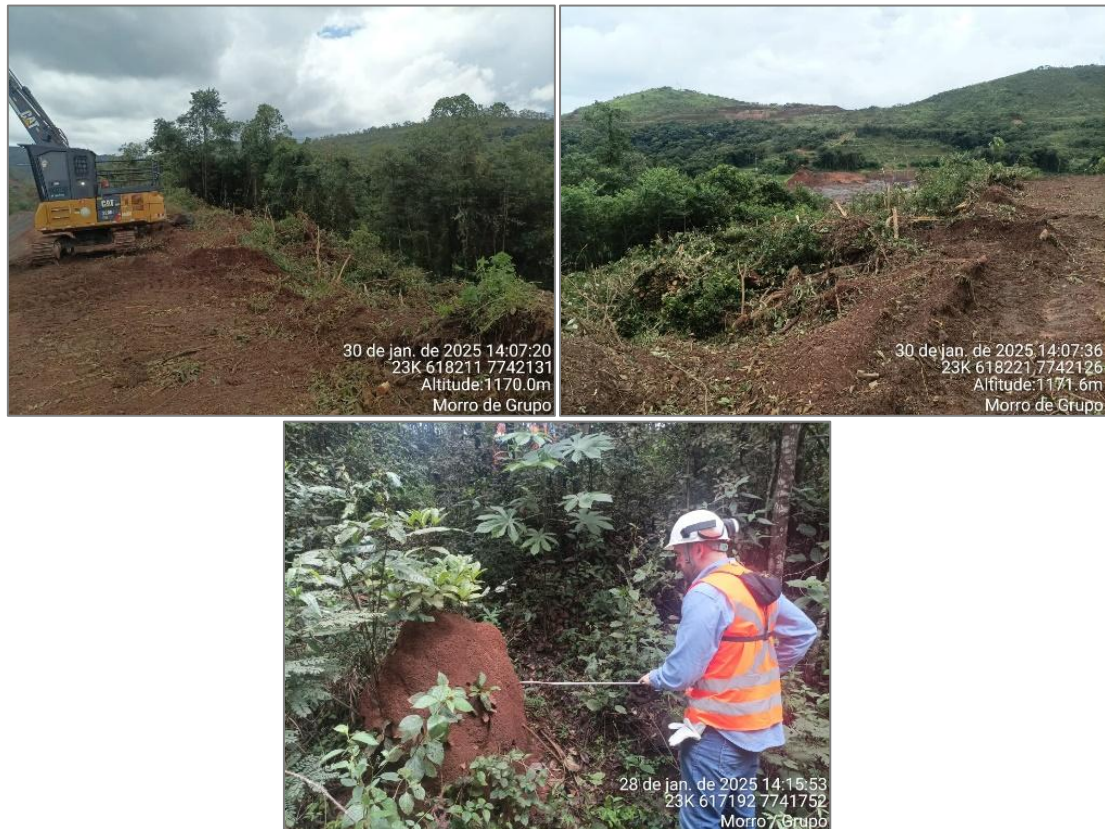
Figura 87 - Supressão Vegetal com o uso de Feller e inspeção da equipe de biólogos(as) na área. Fonte: Vale, 2025.
