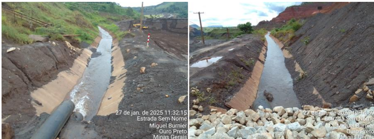
Figura 52 - Manutenção canais de cintura (janeiro/25).
