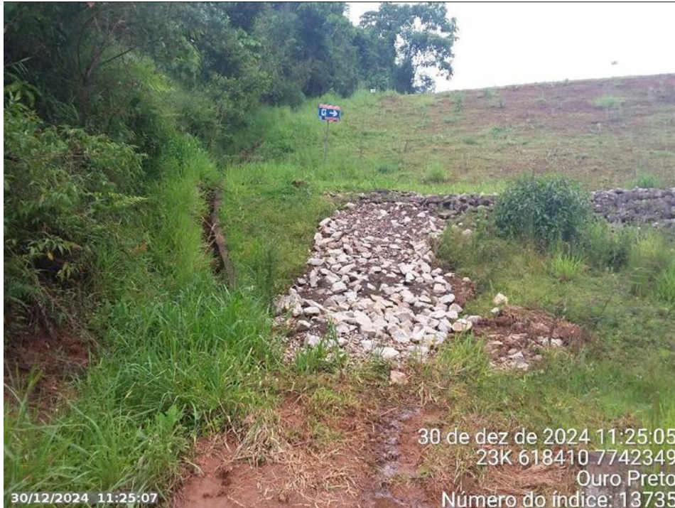
Figura 55 - Reparação do enrocamento do pé da Barragem de Grupo.
