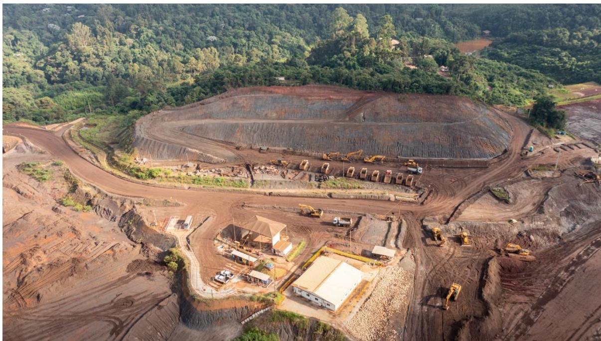
Figura 31 - Início da escavação do Morro de Grupo, conforme projeto (recomendação GR-0152).
