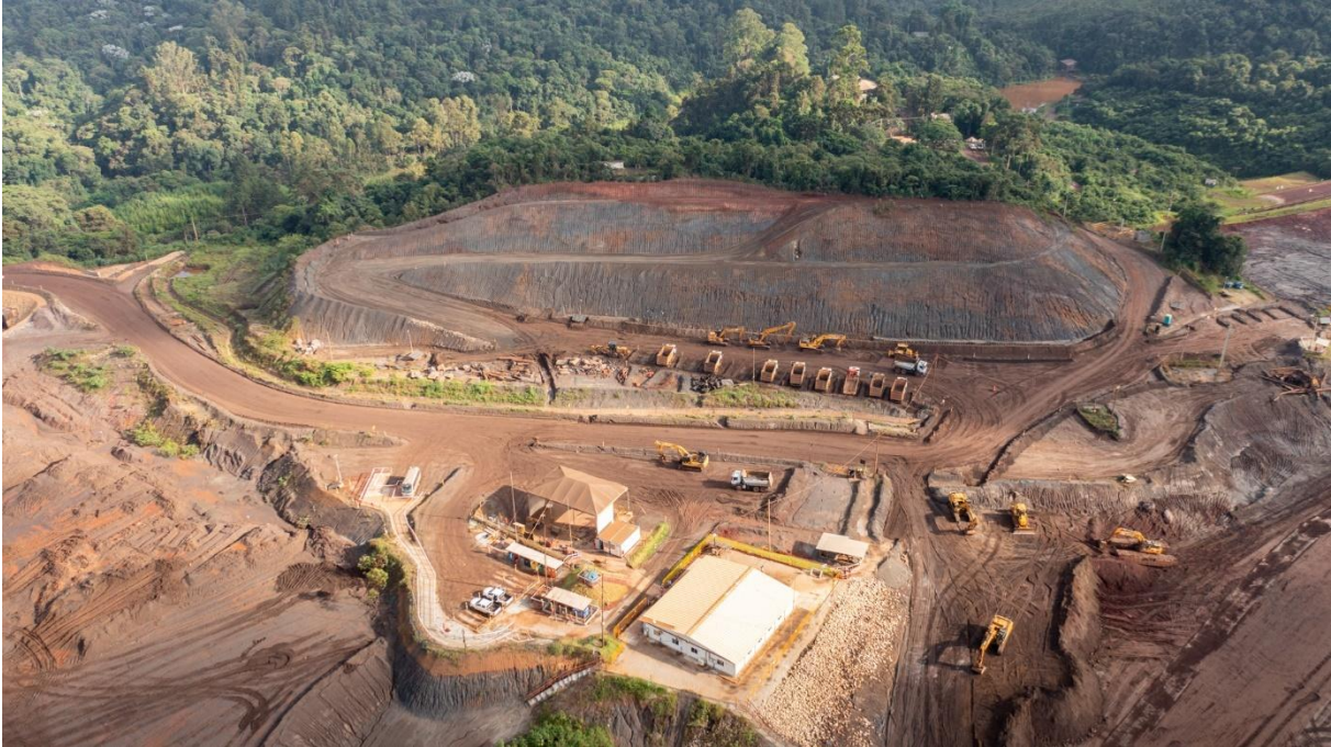
Figura 53 - Início da escavação do morro de Grupo conforme projeto (janeiro/25).
