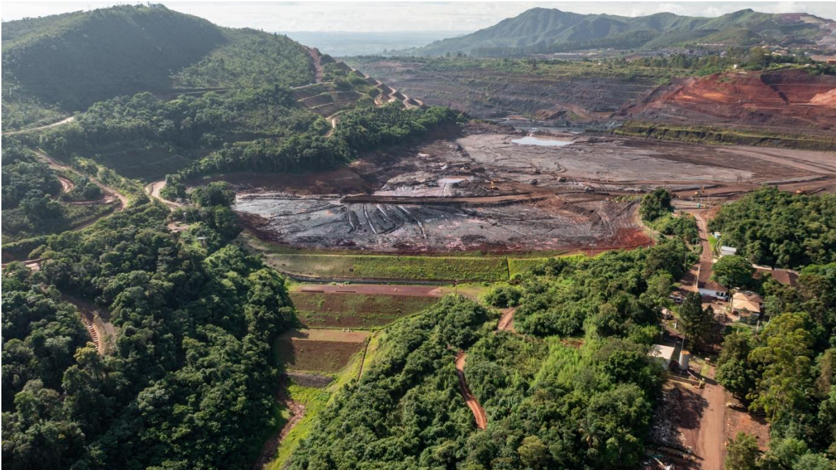
Figura 5 - Rebaixamento de instrumentos conforme necessidade de obra (dezembro/24).
