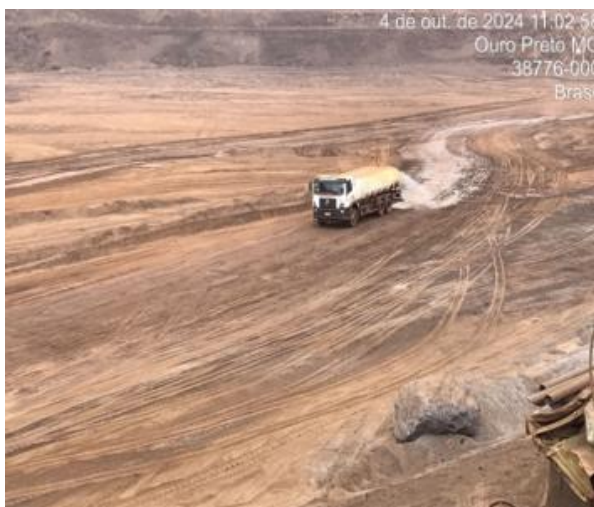
Figura 93 - Uso de caminhão pipa para umectação das vias. Fonte: Vale, outubro de 2024.
