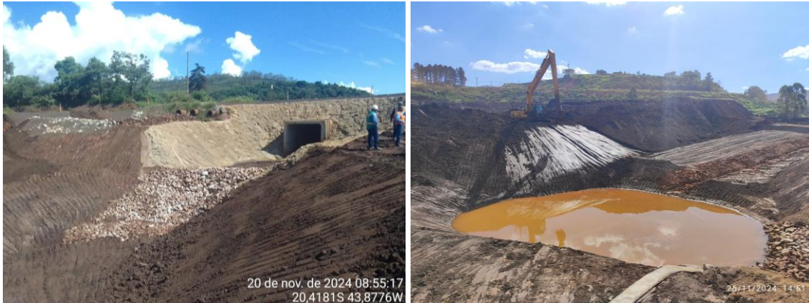
Figura 167 - Implantação do novo Sump, em novembro de 2024. Fonte: Vale, 2024.
