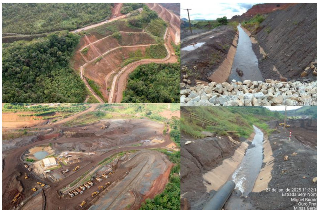
Figura 68 - Estado de conservação e limpeza dos canais de cintura no período (Janeiro/25).
