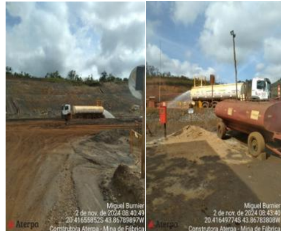
Figura 96 - Aspersão frentes de obras da contratada Aterpa. Fonte: Vale, novembro de 2024.
