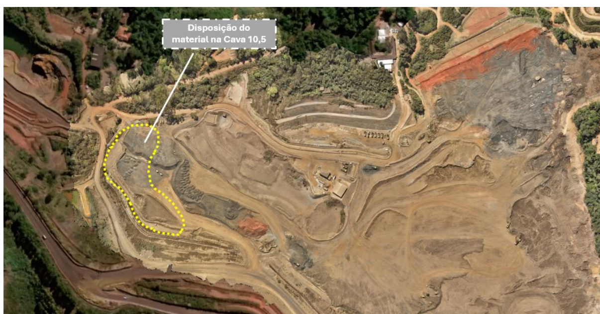
Figura 32 - Localização da disposição temporária de rejeitos da Área IX na Cava 10,5
