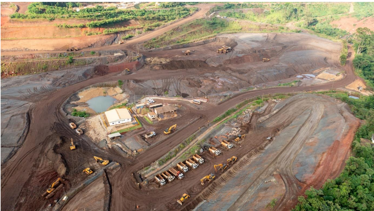
Figura 6 - Carga e transporte do rejeito depositado temporariamente na Cava 10,5 (janeiro/25).
