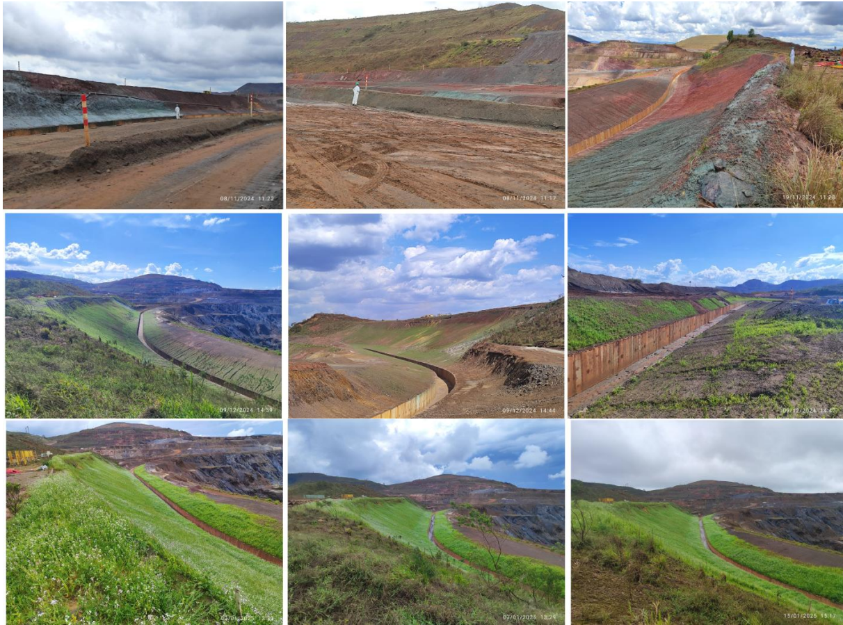
Figura 88: Revegetação dos taludes dos canais de drenagem da Cava V. Fonte: Vale, 2025.
