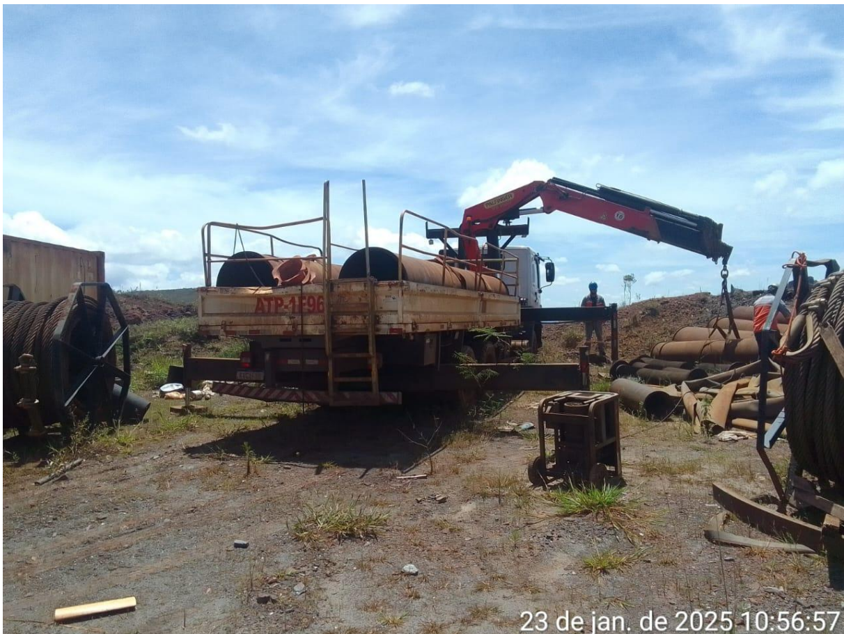
Figura 48 - Remoção de sucatas no reservatório (janeiro/25) – REC GR-0073.
