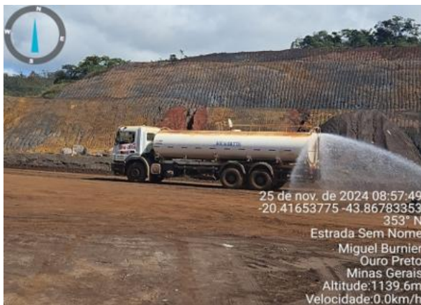
Figura 95 – Aspersão de água nos acessos de obras. Fonte: Vale, novembro de 2024.
