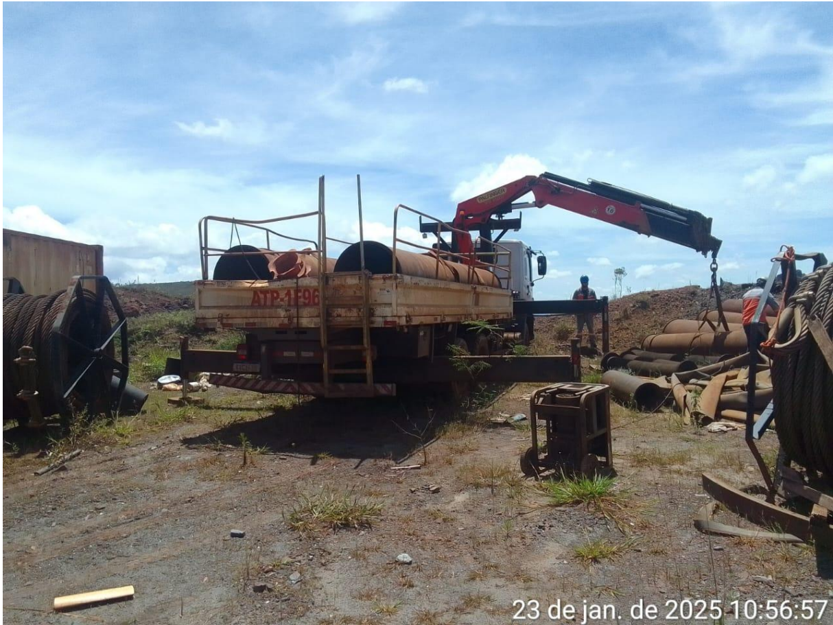
Figura 36 - Andamento da remoção de estruturas abandonadas e sucatas no maciço e reservatório da barragem de Grupo (janeiro/25).
