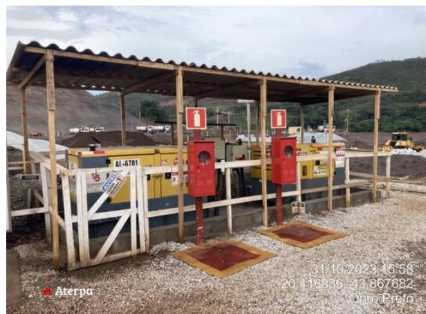
**Foto 58.** Gerador com contenção interna e externa e áreas de cobertura.
