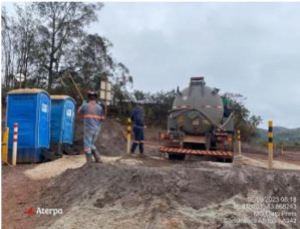
**Foto 45.** Limpeza e higienização dos banheiros químicos. Sucção de tanque sépticos no canteiro de obras. Fonte: Vale, 2023.
