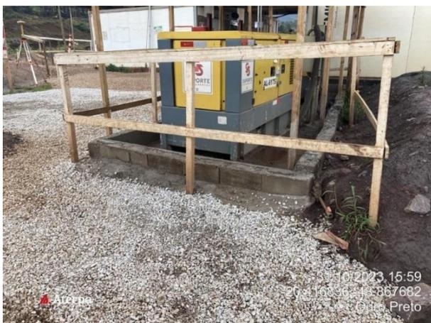
**Foto 57.** Contenção em alvenaria construída em outubro de 2023.
