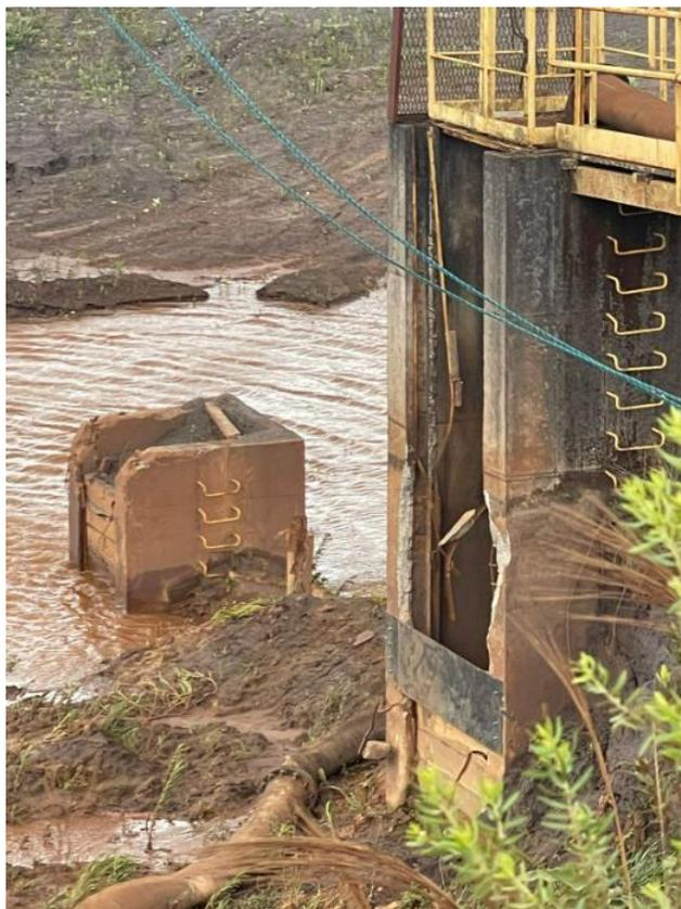
Figura 27 - Emboque do extravasor de Forquilha III – com alteamento do emboque (Outubro/24)
