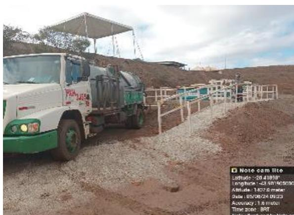
**Figura 103 - Sucção de efluente sanitário armazenado nos tanques sépticos (Fonte: Vale, agosto de 2024).**
