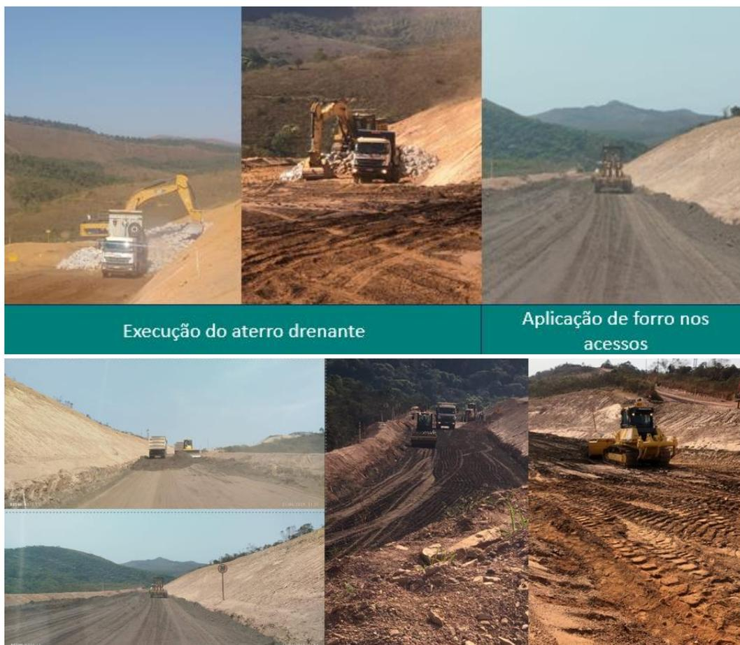
Figura 55 - Execução do aterro drenante e aplicação de forro no acesso operacional da ombreira esquerda de Forquilha III. Fonte: Vale, 2024.
