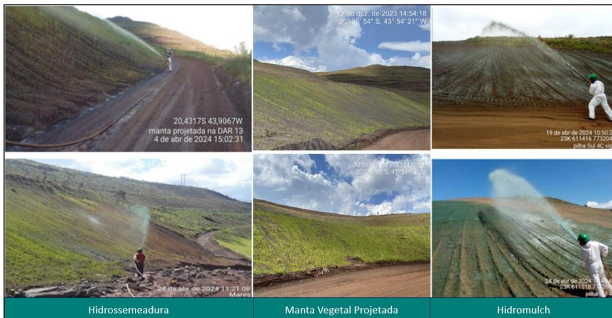
**Figura 68 - Hidrossemeadura e Manta Vegetal Projetada, bem como Hidromulch. Fonte: Vale, 2024.**
