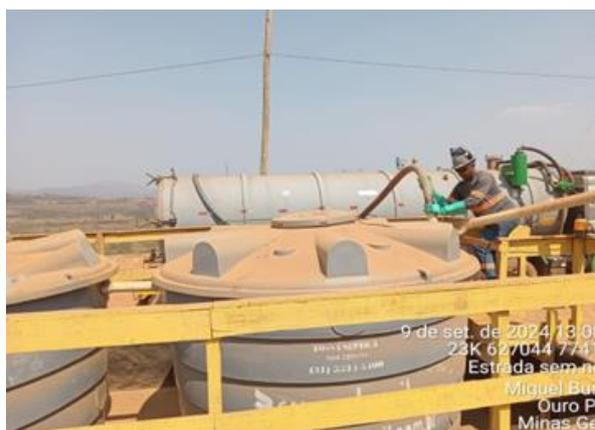
**Figura 105 - Sucção de efluente sanitário armazenado nos tanques sépticos (Fonte: Vale, setembro de 2024).**
