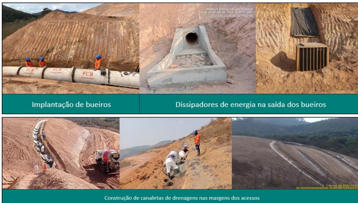
Figura 54 - Construção de bueiros e de canaletas de drenagem nas margens do acesso operacional da ombreira esquerda de Forquilha III. Fonte: Vale, 2024.
