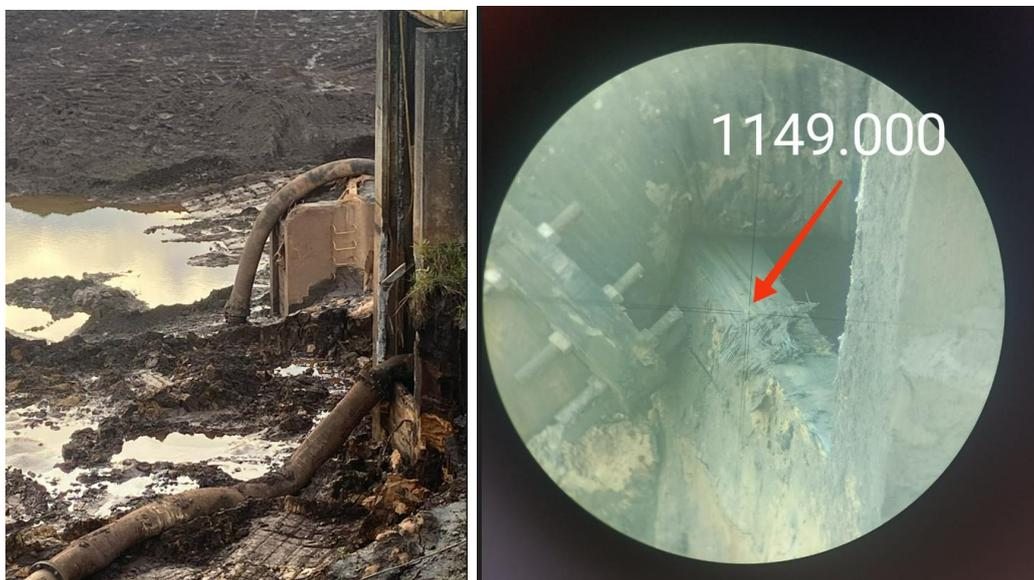
Figura 26 - Desobstrução dos stop-logs até a cota 1.149,00m – Torre T4 – Extravasor Forquilha III (março/24)
