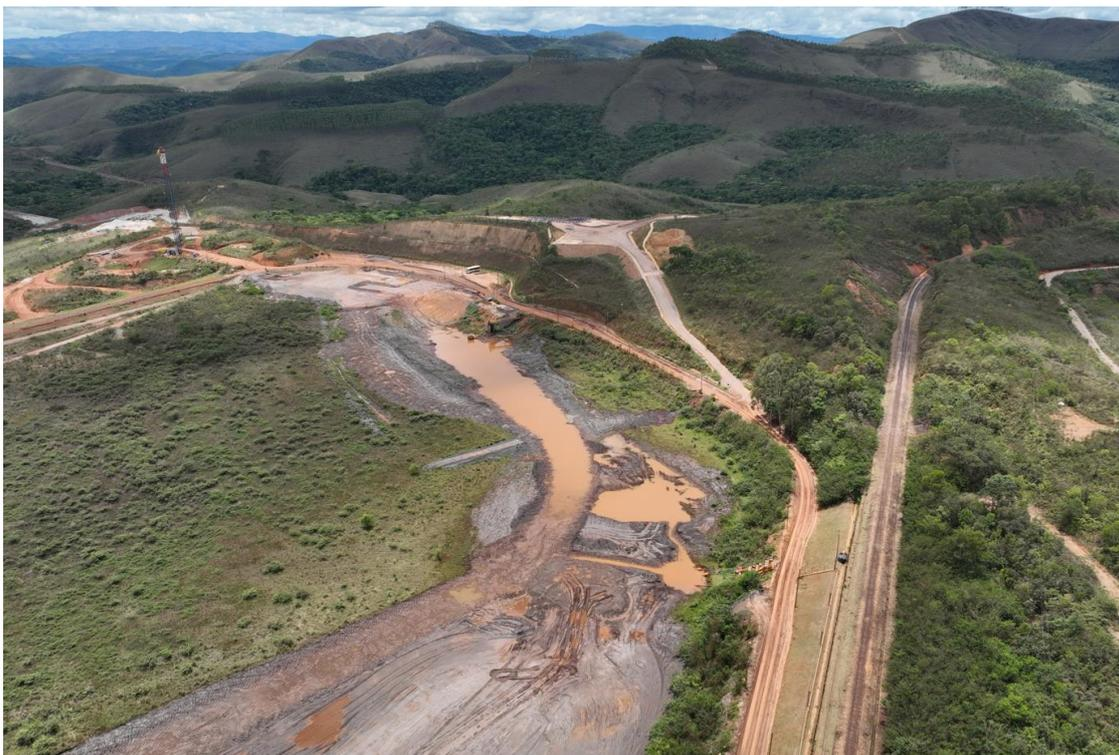
Figura 43 - Remoção de material entre Sump 3 (Dique Ponto 1) e Torres do Extravaser - Recomendação F3-0320 (Outubro/24).
