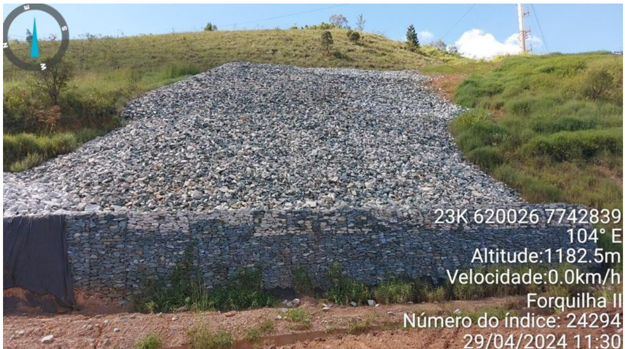
Foto 25. Forquilha II – Correção da anomalia na ombreira direita de Forquilha II (Abril/24).
