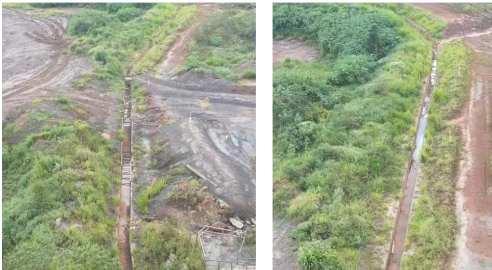
Foto 13: Status da limpeza e desobstrução dos canais de cintura – Forquilha I e II (abril/24).
