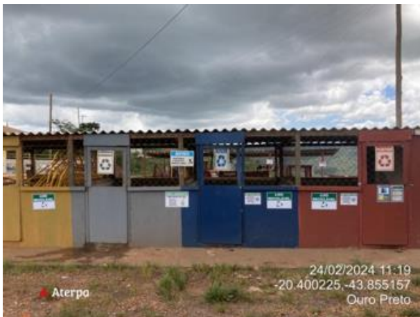
Foto 60: DIR para armazenamento temporário de resíduos no canteiro de Forquilha I e II. Vale, fevereiro de 2024.
