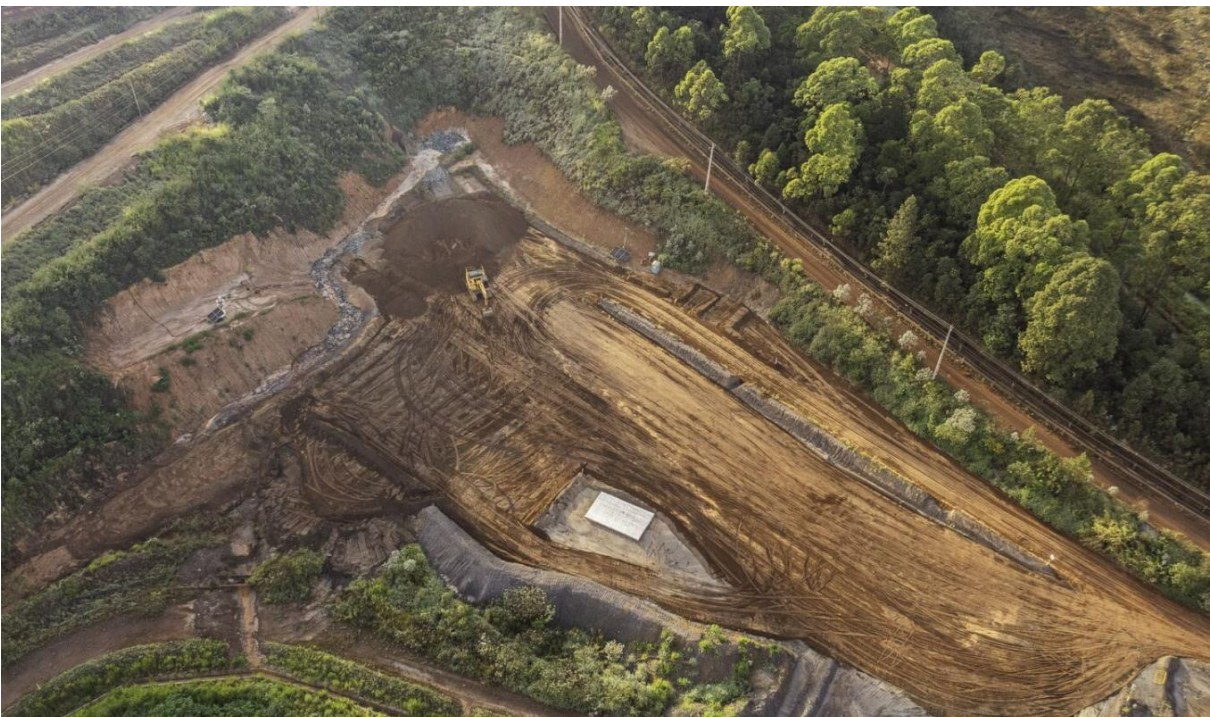
Foto 6. Forquilha II – Praça de Bota espera – Estoque de material proveniente da escavação PPC (Abril/24).
