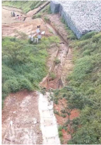
Foto 17: Status da limpeza e desobstrução dos canais de cintura – Forquilha I e II (abril/24).
