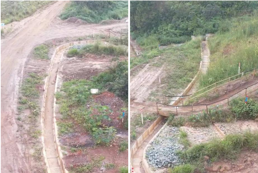
Foto 29: Status da limpeza e desobstrução dos canais de cintura – Forquilha I e II (abril/24)
