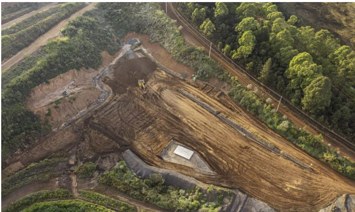
Foto 23. Forquilha II – Praça de Bota espera – Estoque de material proveniente da escavação PPPC (Abril/24).
