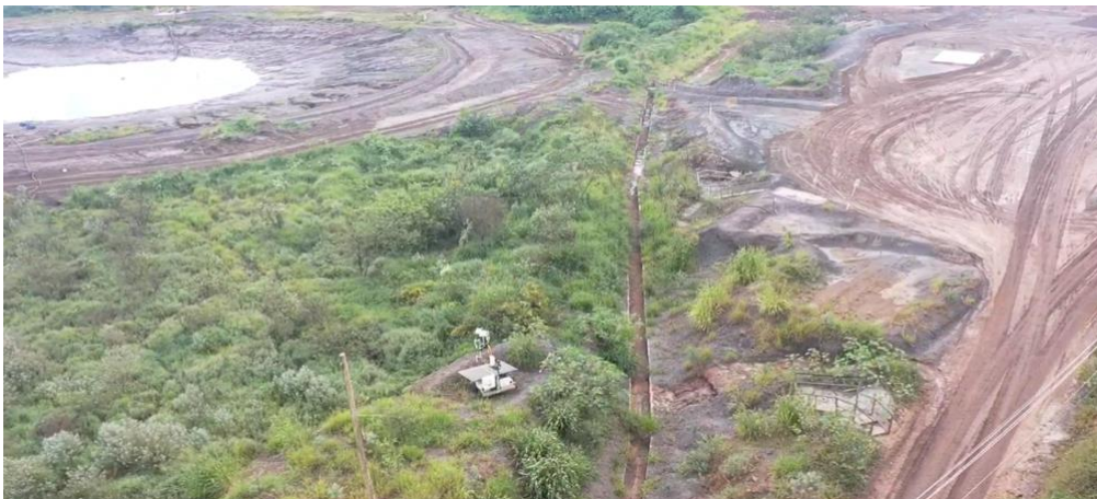
Foto 12: Status da limpeza e desobstrução dos canais de cintura – Forquilha I e II (abril/24).
