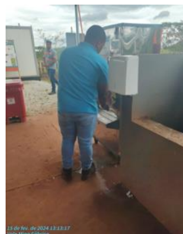
Foto 68. Análise de potabilidade no bebedouro no Canteiro Forquilhas. Fonte: Vale, fevereiro, 2024.
