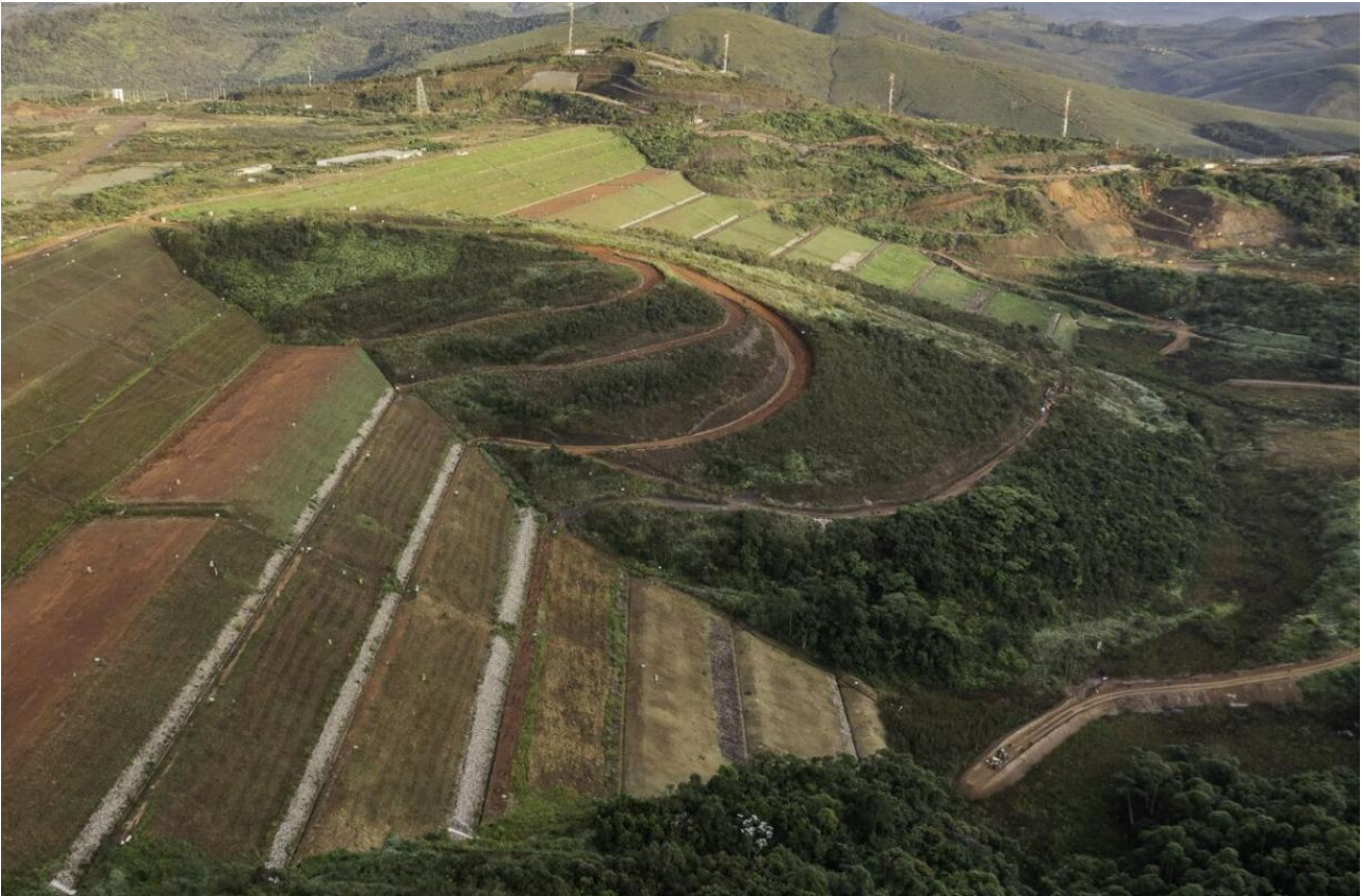
Foto 1. Forquilha II – Sondagens a jusante – Campanha Intertechne (Abril/24).
