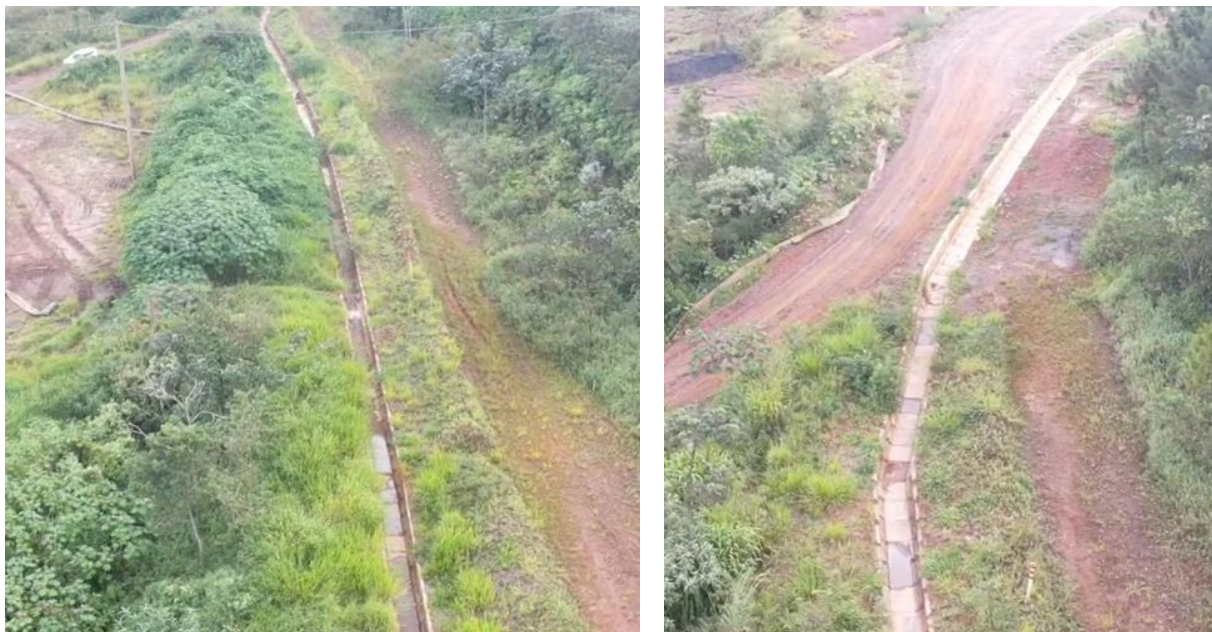
Foto 28: Status da limpeza e desobstrução dos canais de cintura – Forquilha I e II (abril/24)
