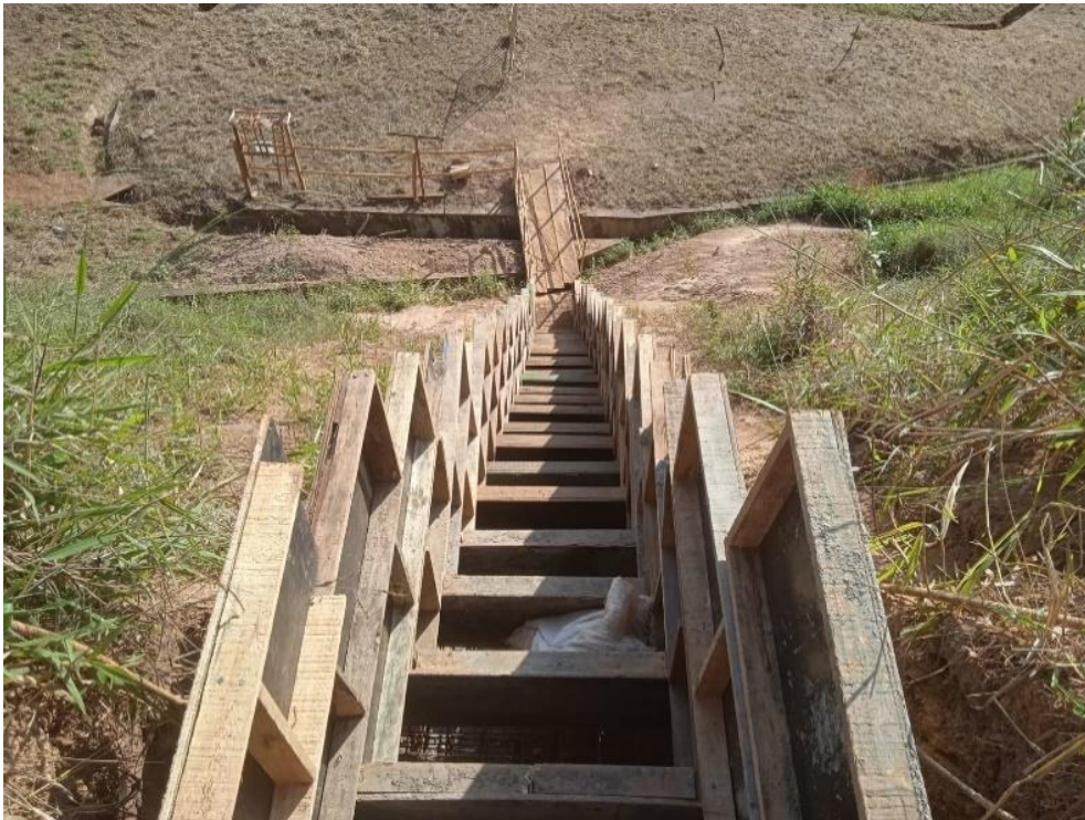
Foto 42. Vista da construção da descida d'água em degraus – Ponto 14
