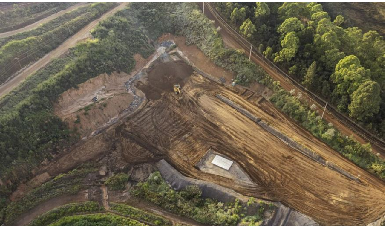
Foto 8: Área de bota espera – margem direita de Forquilha II (Abril/24)
