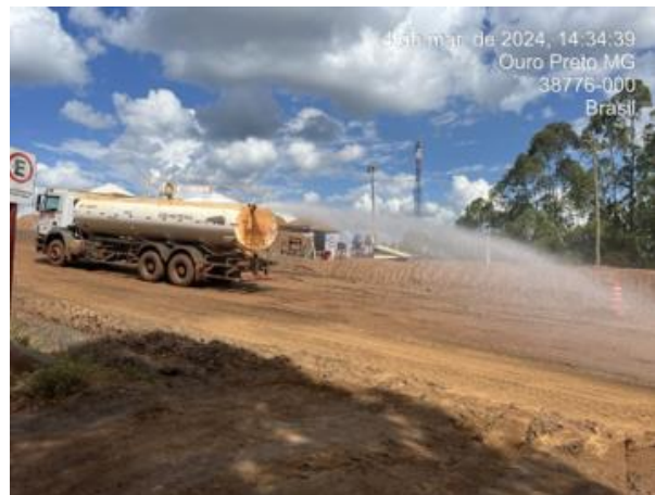
Foto 48 Caminhão pipa realizando aspersão das vias. Fonte: Vale, março, 2024.
