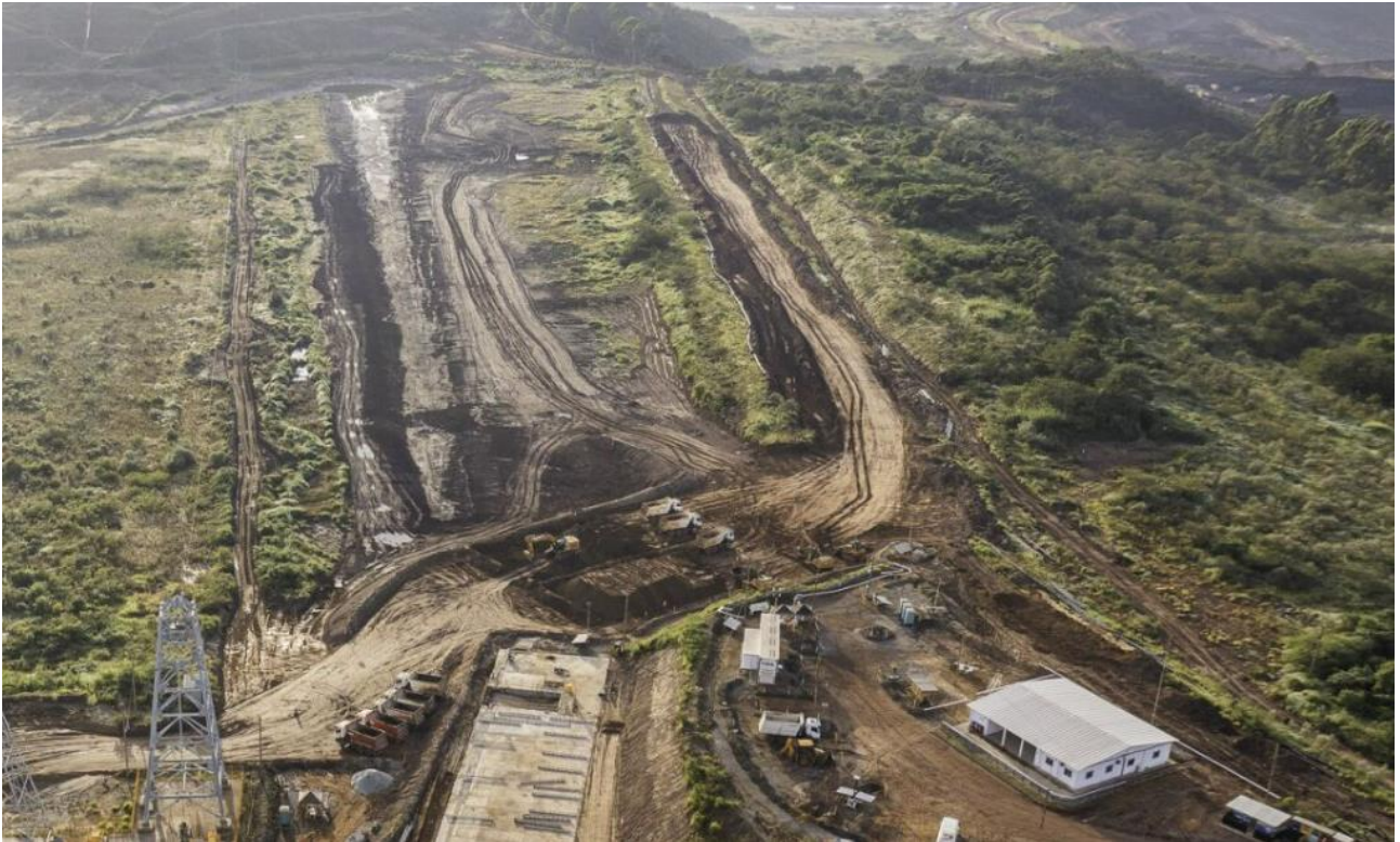
Foto 3. Forquilha II – Escavação do PPC 24/25 e Dique da Adutora (Abril/24).
