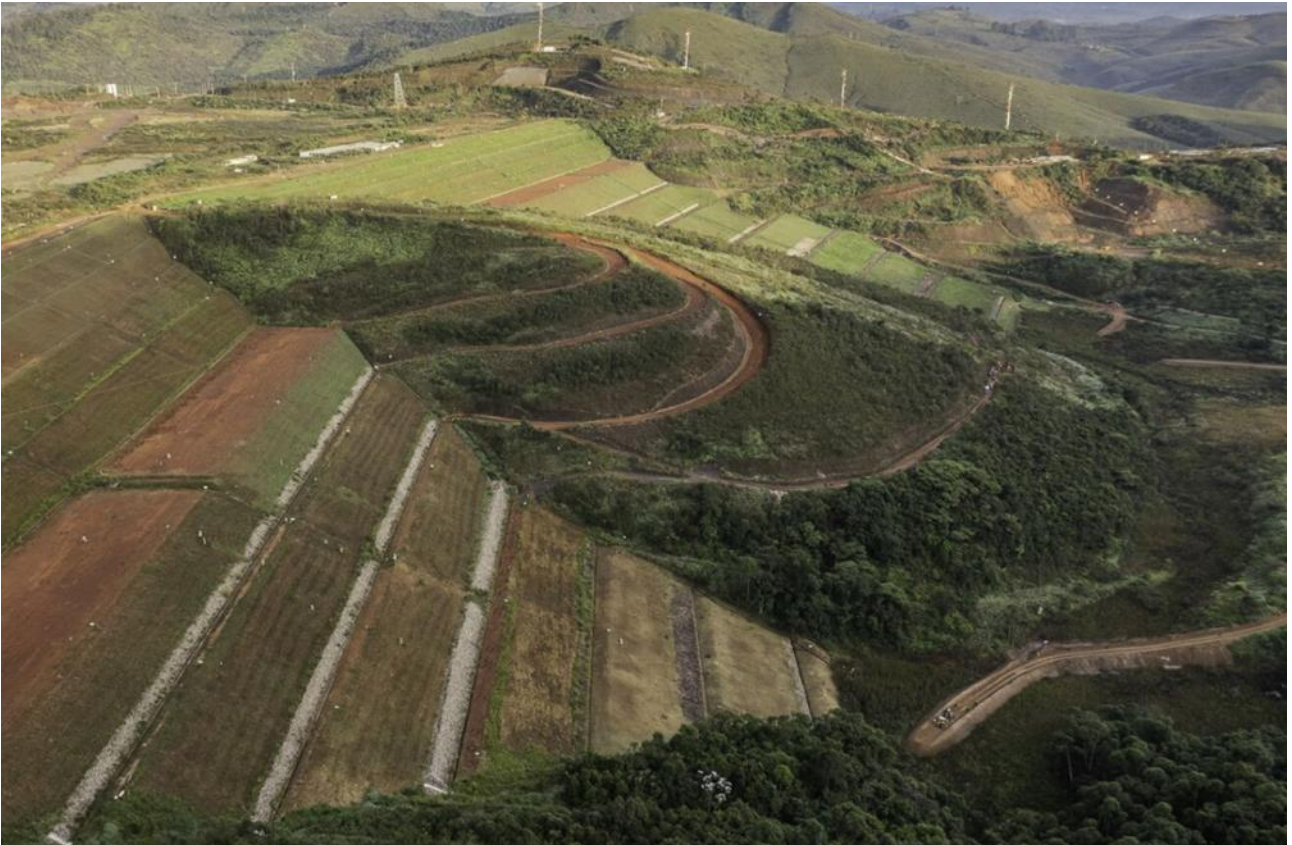
Foto 18. Forquilha II – Sondagens à jusante – Campanha Intertechne (Abril/24).
