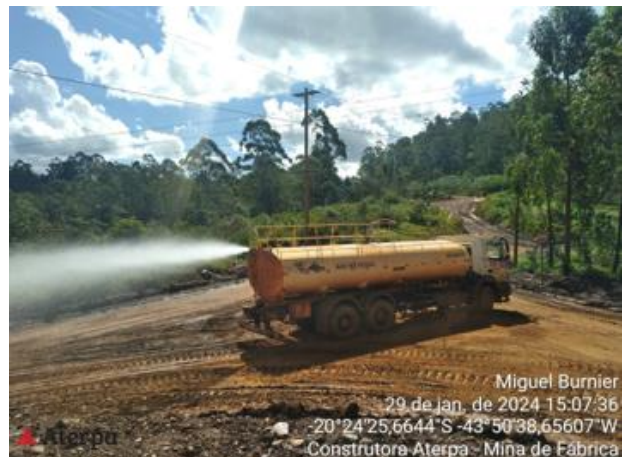
Foto 44. Aspersão das vias. Fonte: Vale, janeiro, 2024.
