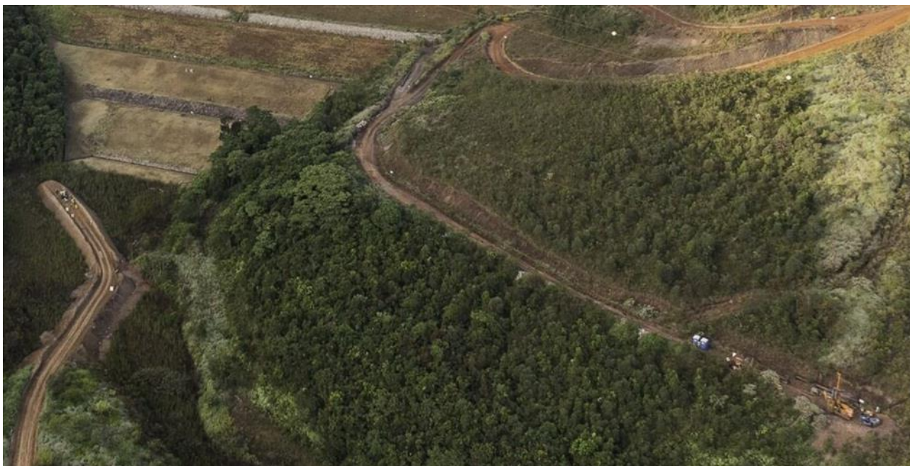
Foto 19. Forquilha II – Sondagens à jusante – Campanha Intertechne (Abril/24).
