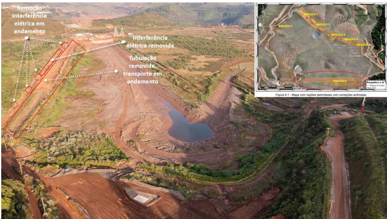
Foto 11: Status de remoção da interferências e infraestruturas (Abril/24)
