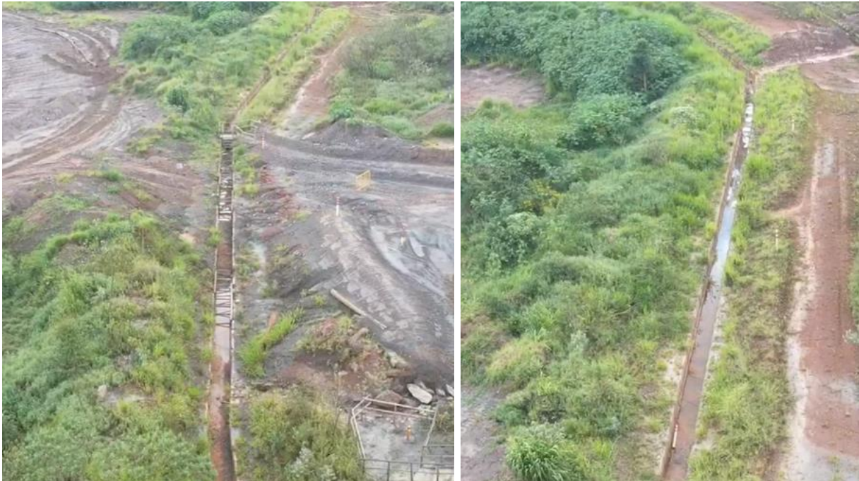
Foto 27: Status da limpeza e desobstrução dos canais de cintura – Forquilha I e II (abril/24)
