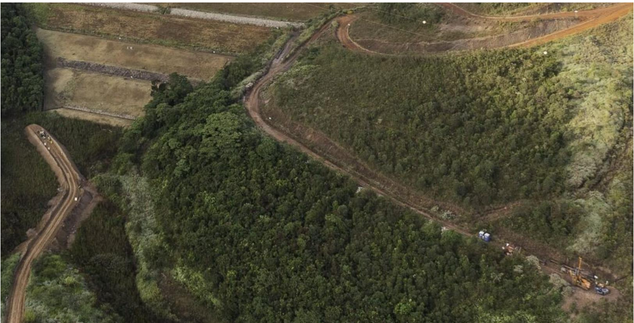
Foto 2. Forquilha II – Sondagens a jusante – Campanha Intertechne (Abril/24)
