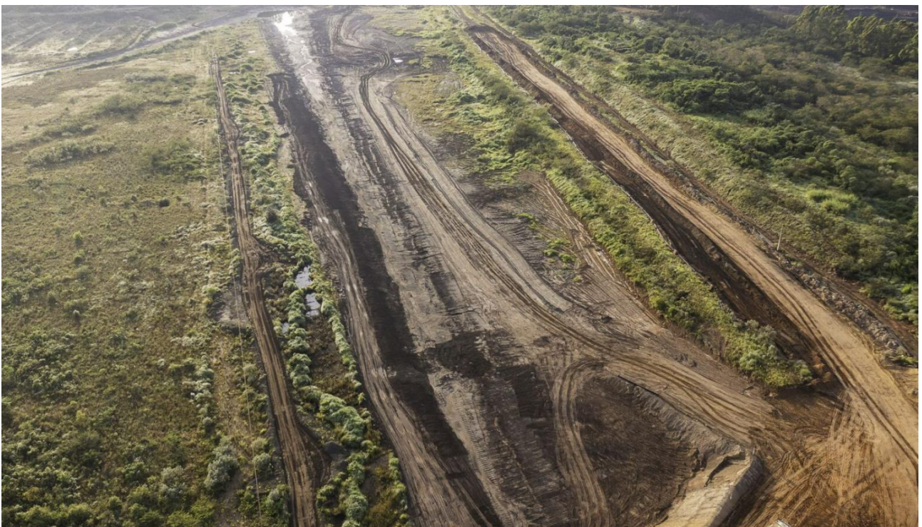
Foto 4. Forquilha II – Escavação do PPC 24/25 e Dique da Adutora (Abril/24).
