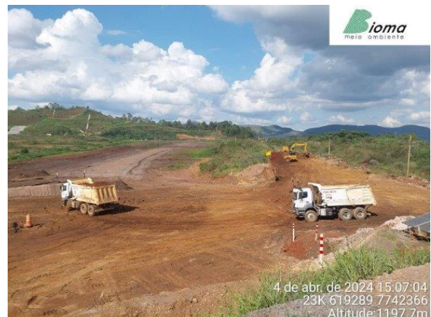
Foto 41: Execução da atividade de remoção de topsoil – equipamentos não tripulados
