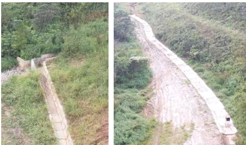
Foto 16: Status da limpeza e desobstrução dos canais de cintura – Forquilha I e II (abril/24)
