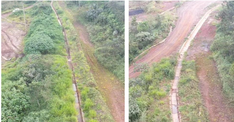
Foto 14: Status da limpeza e desobstrução dos canais de cintura – Forquilha I e II (abril/24).
