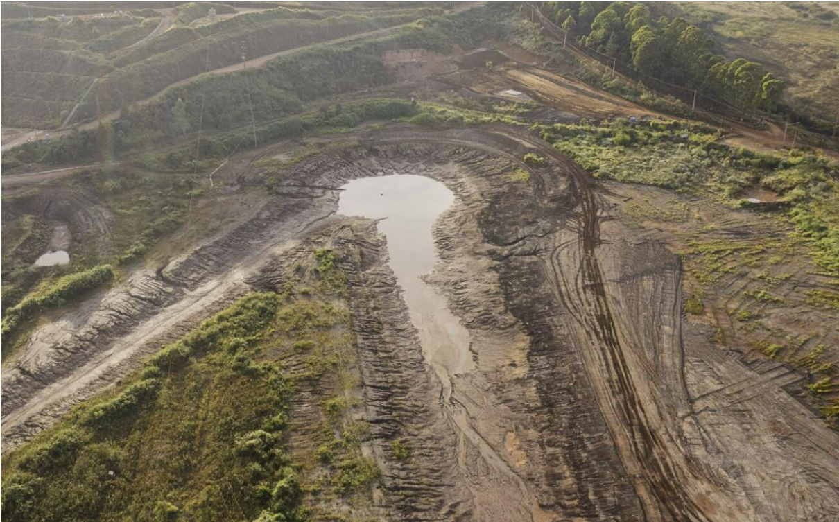
Foto 5. Forquilha II – Canal e Sump do plano de chuva – bombeamento em operação (Abril/24).
