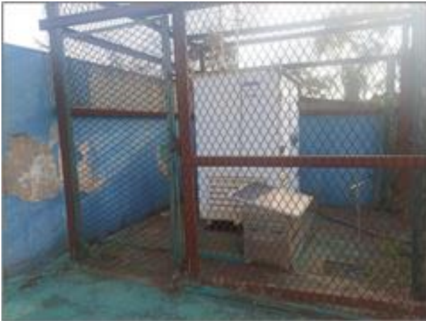
Foto 51. Estação de Monitoramento de Qualidade do Ar de Mota. Fonte: Vale, agosto 2023.
