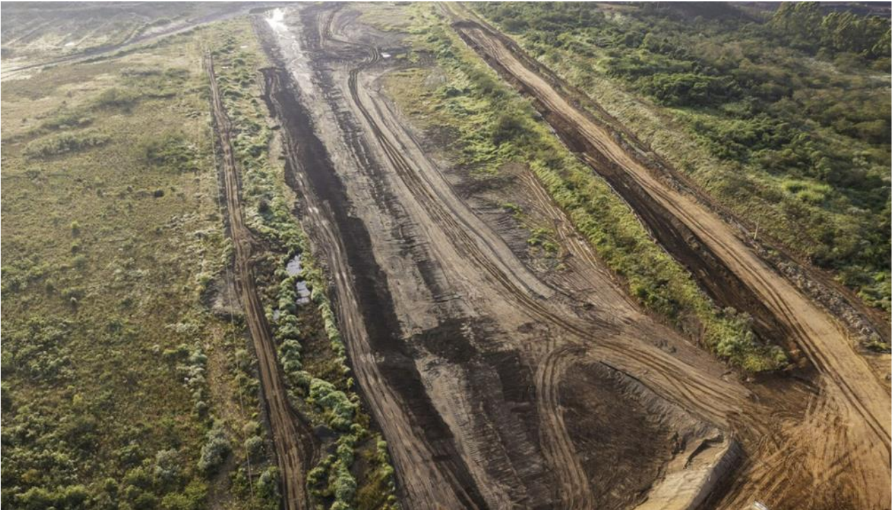
Foto 21. Forquilha II – Escavação do PPPC 24/25 e Dique da Adutora (Abril/24).
