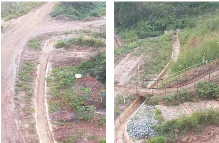
Foto 15: Status da limpeza e desobstrução dos canais de cintura – Forquilha I e II (abril/24).
