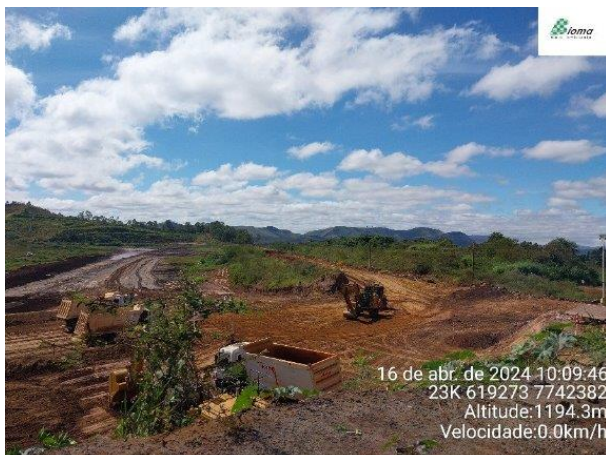
Foto 40: Execução da atividade de remoção de topsoil – equipamentos não tripulados
