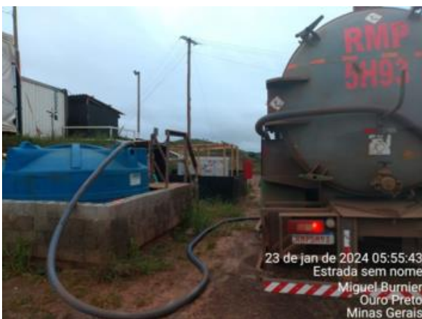
Foto 54. Sucção de efluente sanitário dos tanques sépticos no Canteiro de Forquilhas. Vale, janeiro de 2024.
