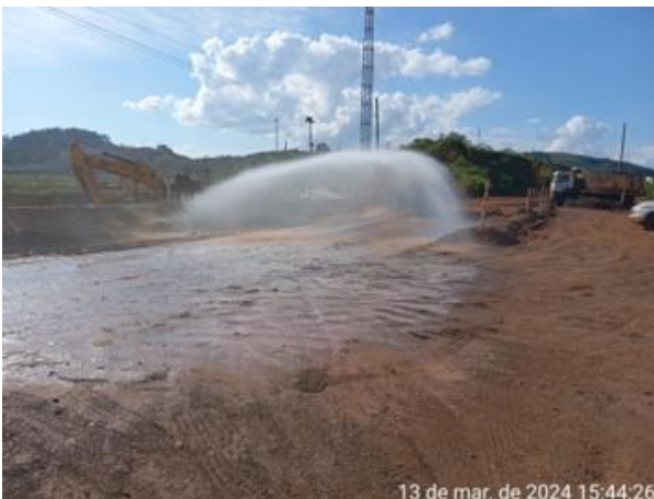
Foto 47 Aspersão frentes de obras da contrata Aterpa. Fonte: Vale, março, 2024.
