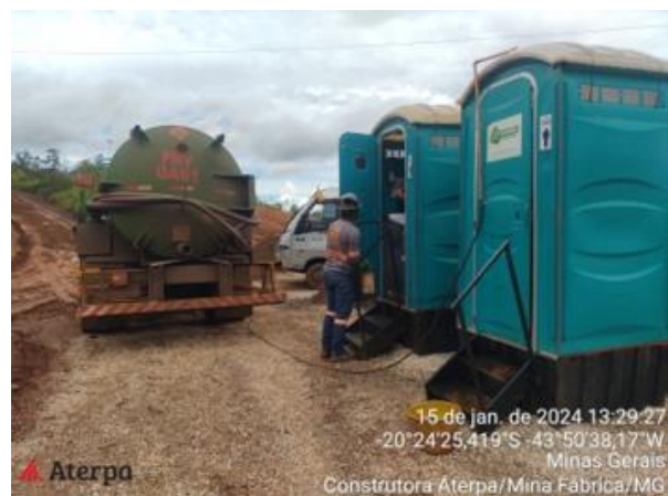
Foto 55. Sucção do tanque séptico no canteiro de Forquilhas realizado pela HB locações. Vale, janeiro de 2024.
