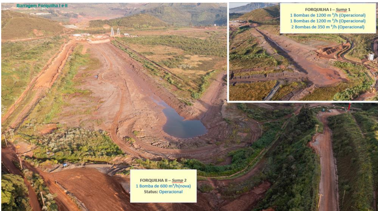
Foto 10: Sistemas de bombeamento de Forquilhas I e II – Implantação concluída (Abril/24)
