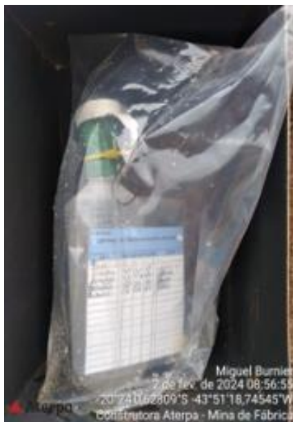
Foto 64. Selo de inspeção no lavador de olhos disponibilizado próximo a área de armazenamento de químicos. (Vale, 2024)
