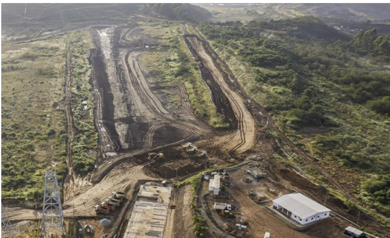
Foto 20. Forquilha II – Escavação do PPPC 24/25 e Dique da Adutora (Abril/24).
