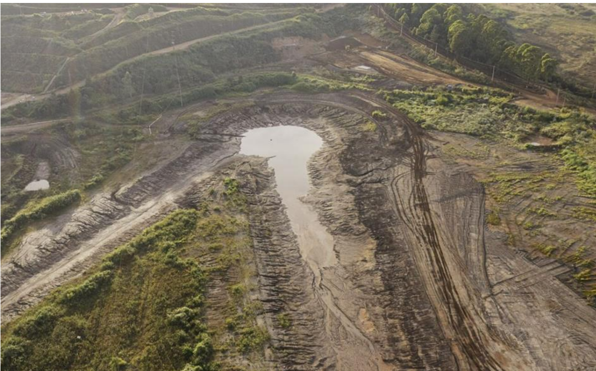
Foto 22. Forquilha II – Canal e Sump do plano de chuva – bombeamento em operação (Abril/24).
