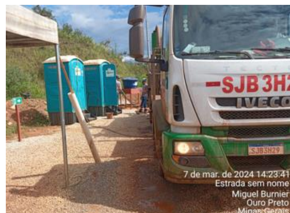
Foto 57: Sucção de efluentes sanitários nas frentes de obras. Vale, março de 2024.
