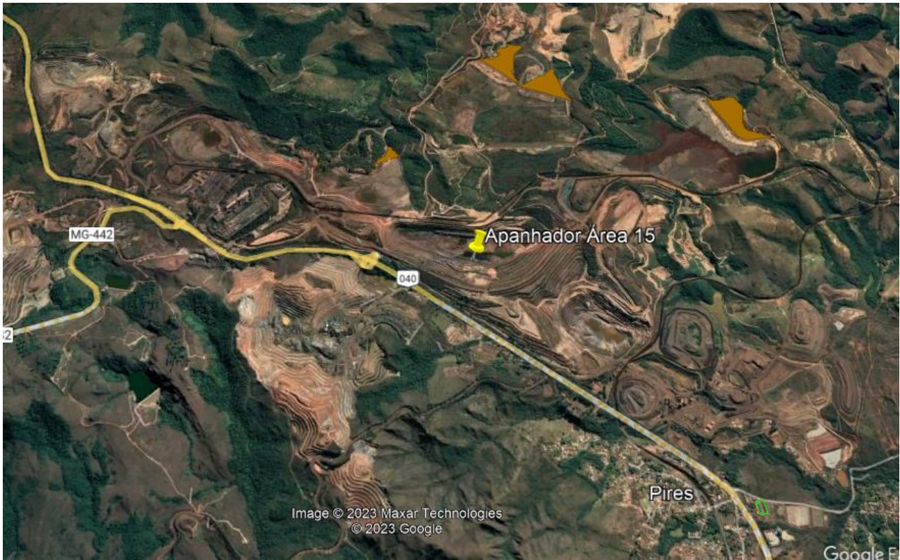
Figura 19: Localizados Apanhador de água para aspersão - Área 15.
