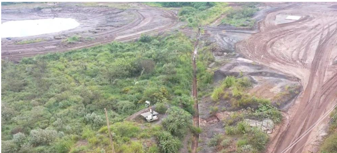
Foto 26: Status da limpeza e desobstrução dos canais de cintura – Forquilha I e II (abril/24)
