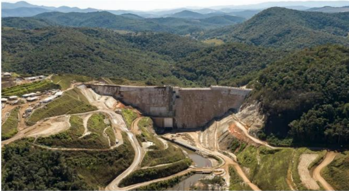
Foto 69. Estrutura de Contenção a Jusante Fábrica. Fonte: Vale, 2022.
