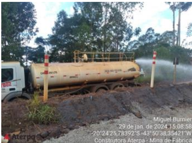
Foto 43. Atividades de aspersão das vias Forquilhas, a de Forquilha I Fonte: Vale, Janeiro, 2024.
