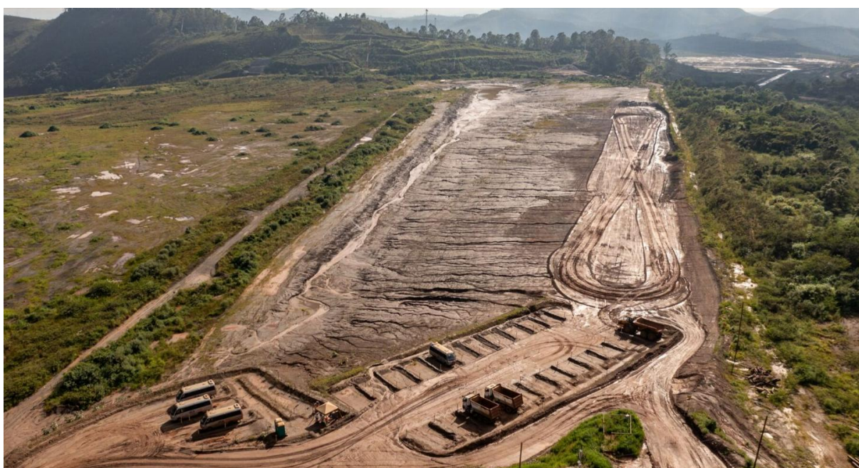
Figura 13 - Forquilha II – Canais e Sump do PPC 24/25 e Dique da Adutora (Janeiro/25).
