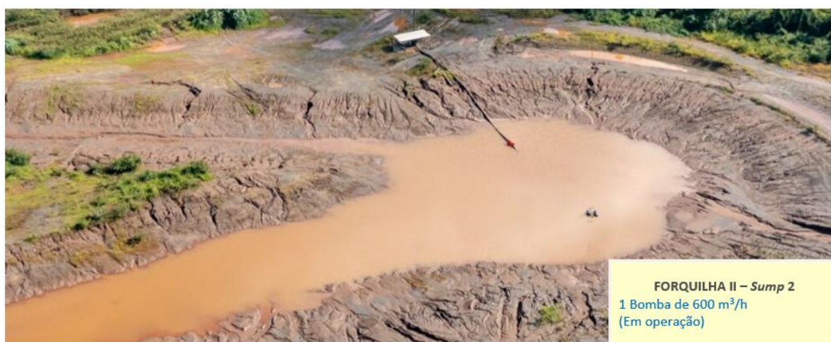
Figura 25 - Sistema de bombeamento de Forquilha II – Em operação (Janeiro/25).
