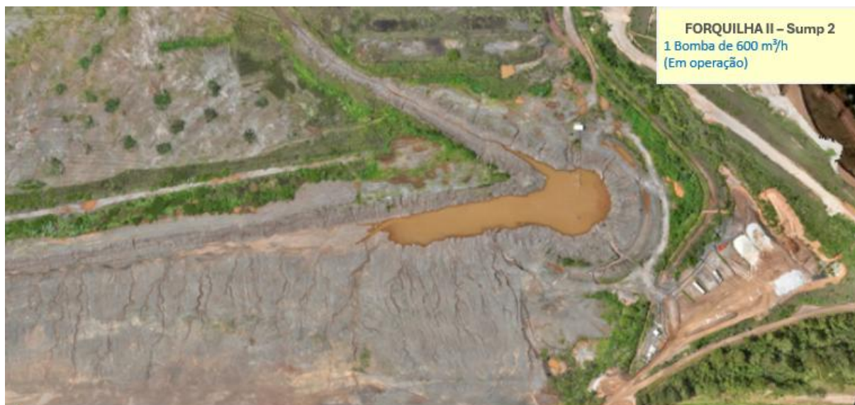
Figura 35 - Operação e manutenção do sistema de bombeamento (Janeiro/25).
