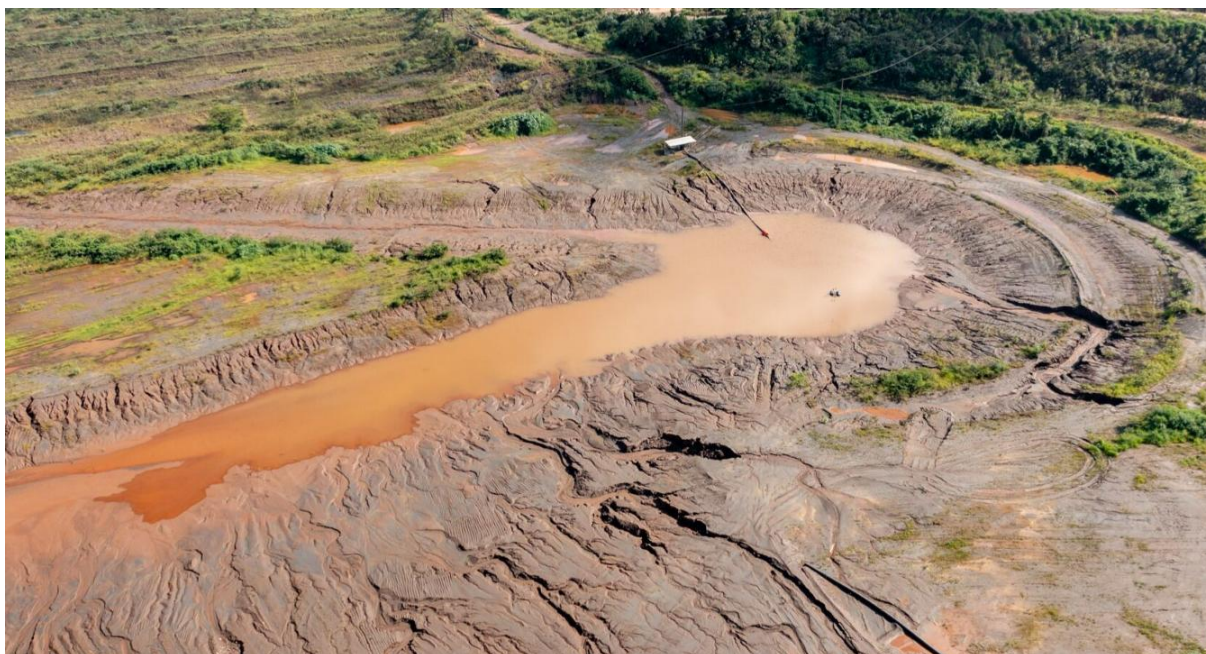
Figura 12 - Forquilha II – Sumps e sistemas de bombeamento (Janeiro/25)
