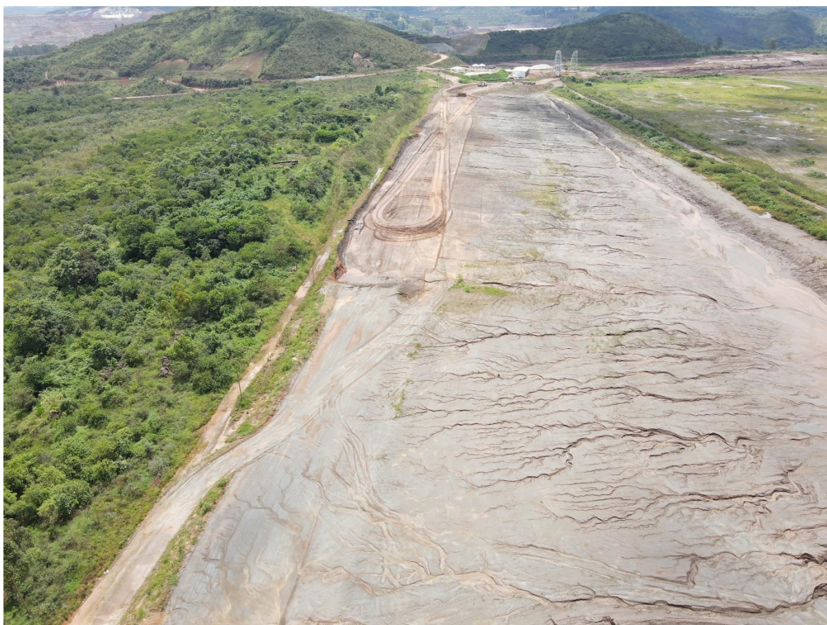
Figura 36 - Forquilha II – Dique da Adutora (Janeiro/25).
