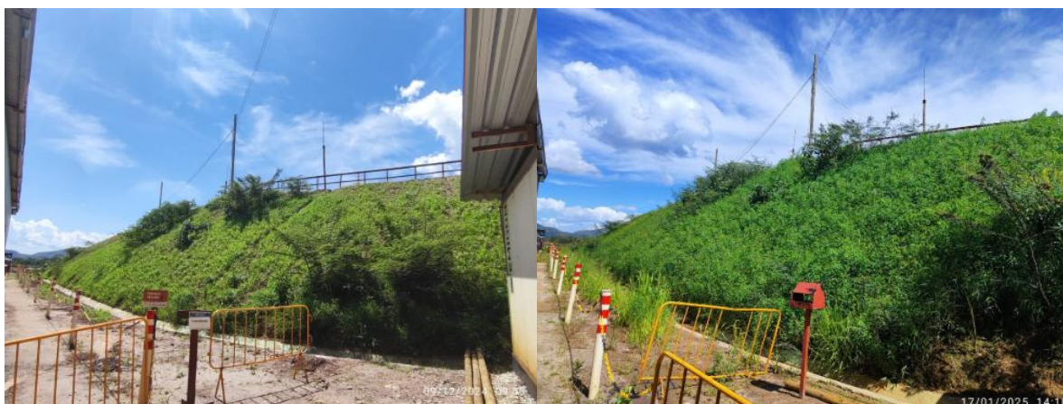
Figura 50 - Resultado da aplicação de MVP nos taludes da região do COR. Fonte: Vale, 2025.
