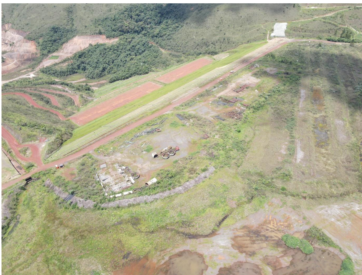
Figura 27 - Visão geral das infraestruturas a serem removidas Forquilha II (Janeiro/25).
