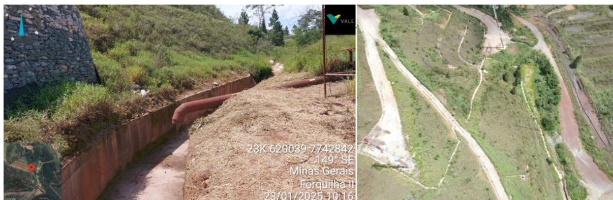
Figura 37 - Manutenção dos canais de cintura (Janeiro/25).
