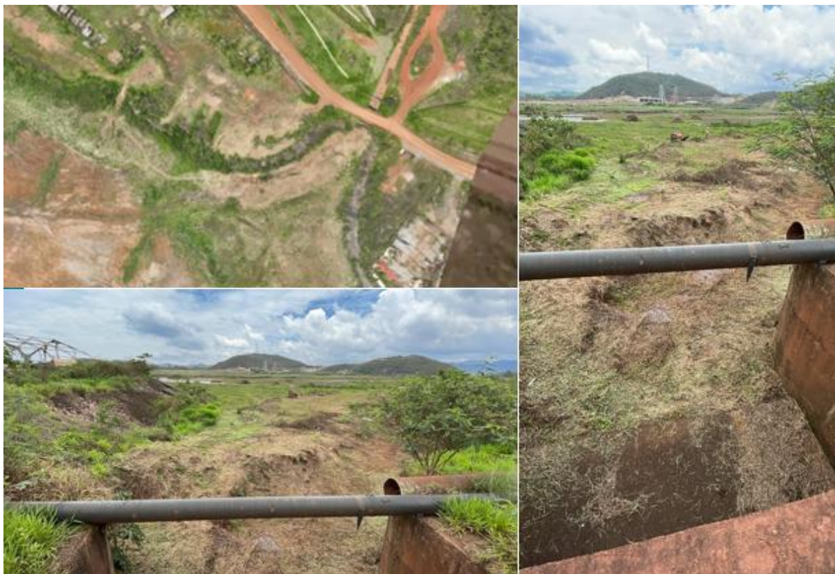
Figura 32 - Limpeza canal de aproximação Novembro/25
