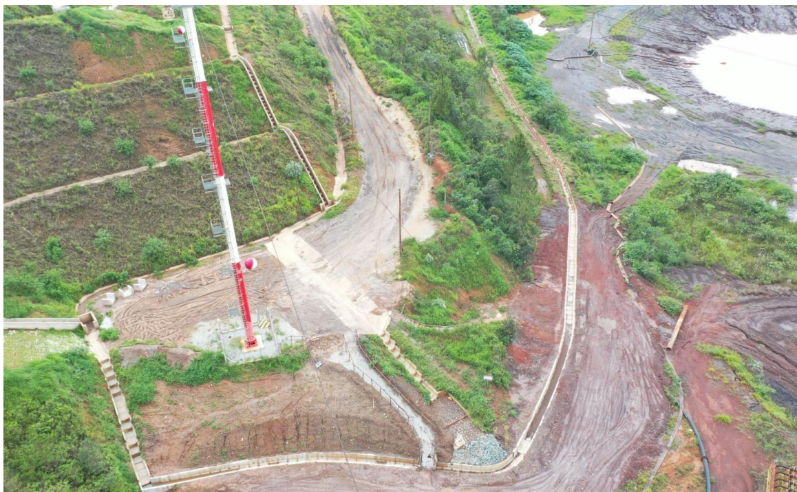
Figura 39 - Status da limpeza e estado de conservação dos canais de cintura – Forquilha II (Janeiro/24).
