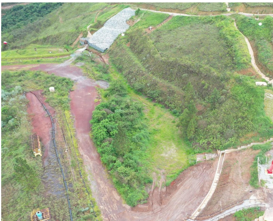
Figura 40 – Estado de conservação dos canais de cintura – Forquilha II (Janeiro/25).
