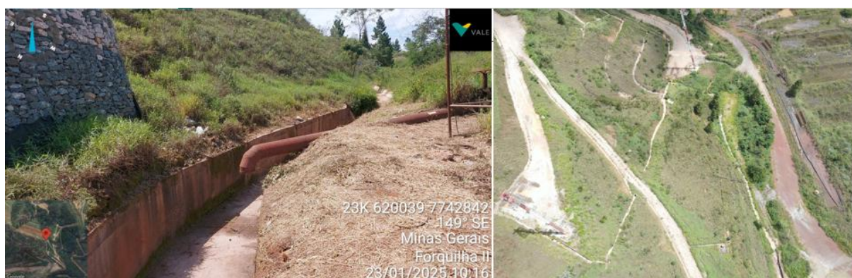
Figura 31 - Status da limpeza e desobstrução dos canais de cintura – Forquilha II (Janeiro/25).
