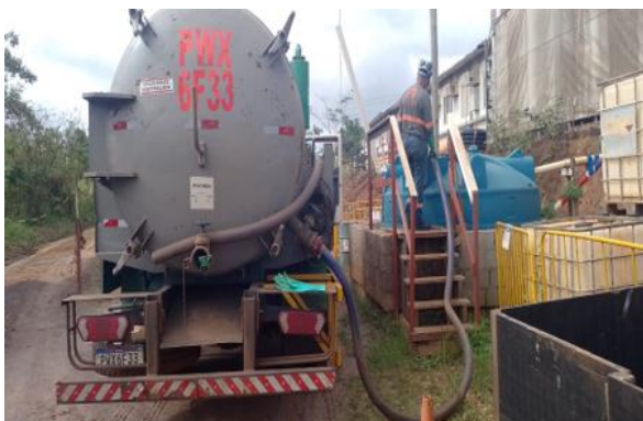
Figura 97 - Recolhimento de efluentes do tanque localizado no canteiro, dezembro de 2024 (Fonte: Vale, 2024).
