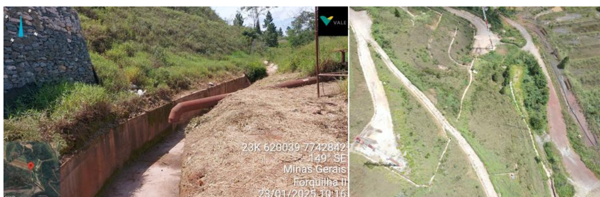
Figura 38 - Manutenção dos canais de cintura (Janeiro/25).
