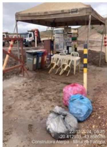
Figura 106 – Recolhimento de resíduos na frente de serviço para estoque provisório no DIR (Fonte: Vale, 2024).
