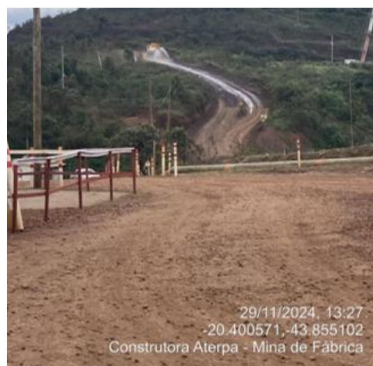
Figura 55 - Aspersão de água nos acessos de obra. Fonte: Vale, novembro de 2024.
