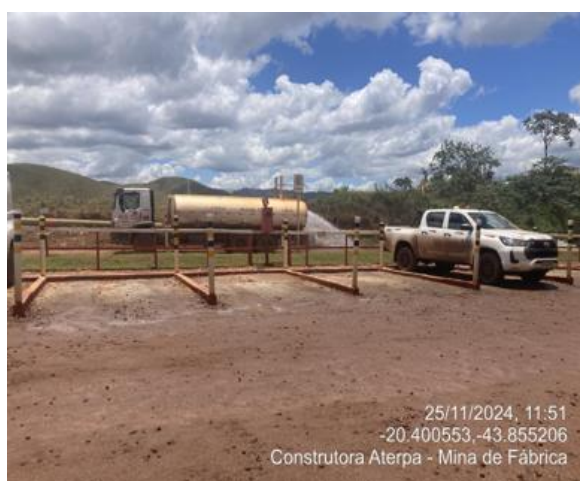
Figura 54 - Caminhão pipa realizando aspersão das vias. Fonte: Vale, novembro de 2024.
