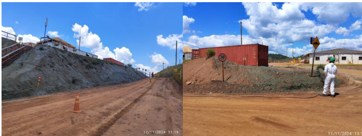
Figura 49 - Aplicação de MVP nos taludes da região do COR. Fonte: Vale, 2025.
