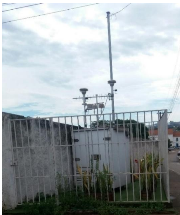
Figura 68 - Estação de monitoramento de Qualidade do Ar - Matriz. Fonte: Vale, 2024.
