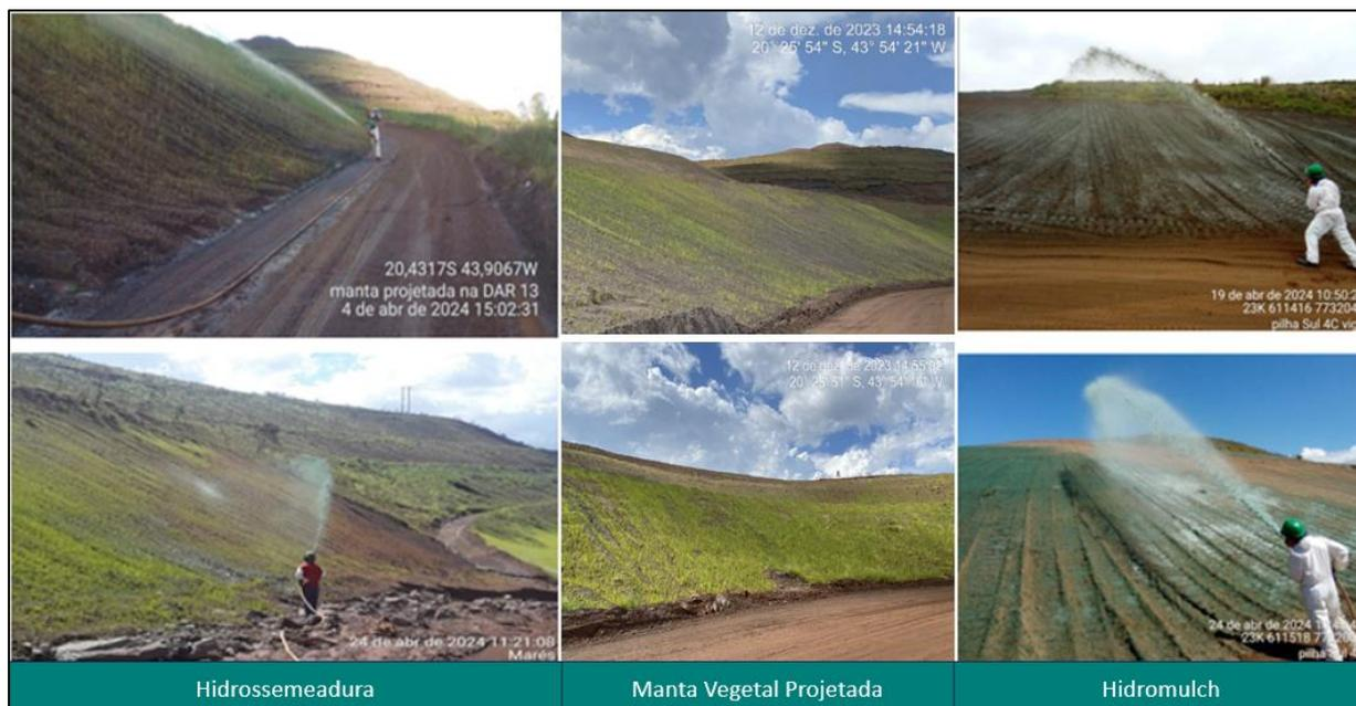
**Figura 53 - Hidrossemeadura e Manta Vegetal Projetada, bem como Hidromulch. Fonte: Vale, 2024.**
