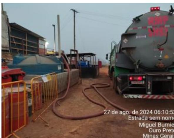
**Figura 86 - Limpeza tanque séptico canteiro central Forquilhas. Vale, agosto de 2024.**
