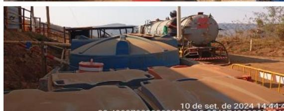
**Figura 87 - Sucção de efluente sanitário armazenado nos tanques sépticos. Vale, setembro de 2024.**
