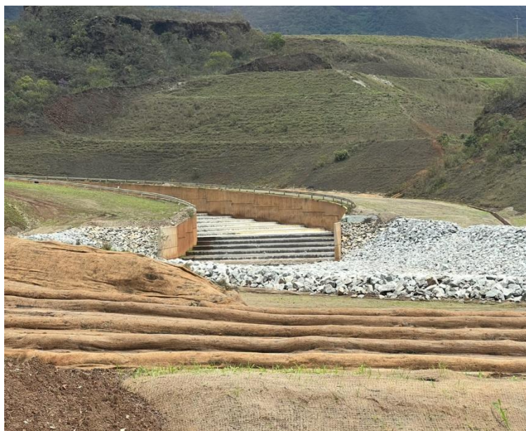
Figura 9 - bacia de restituição concluída (22/10/24)
