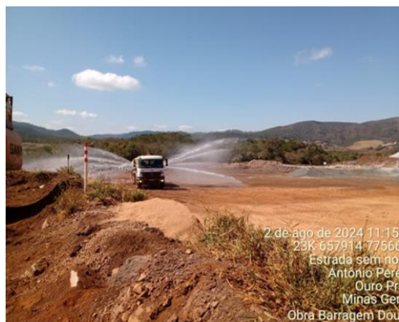
Figura 29 e Figura 30 - Umectação das vias de acesso através do caminhão pipa. Fonte: Vale, 2024.
