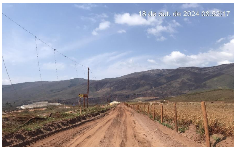
Figura 31 - Cortina de aspersão. Fonte: Vale, 2024.
