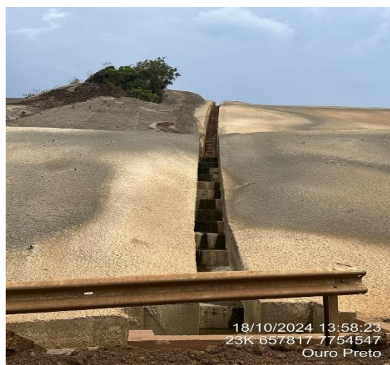
Figura 22 – Canaleta talude 4 e 5 e Figura 23 - Canaletas Talude 3. Nota-se o bom estado de conservação das estruturas de drenagem. Fonte: Vale, outubro/24.
