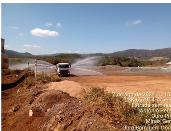
Figura 27 e Figura 28 - Umectação das vias de acesso através do caminhão pipa. Fonte: Vale, 2024.
