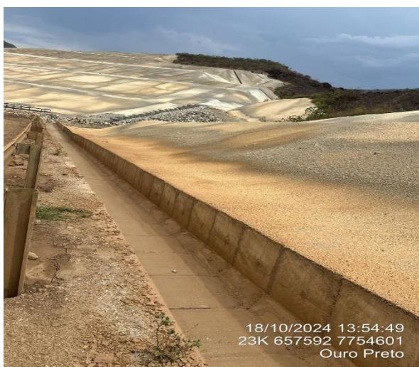
Figura 22 – Canaleta talude 4 e 5 e Figura 23 - Canaletas Talude 3. Nota-se o bom estado de conservação das estruturas de drenagem. Fonte: Vale, outubro/24.
