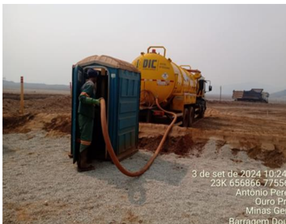
Figura 38 - Limpeza de banheiro químico. Fonte: Vale, (set/2024).
