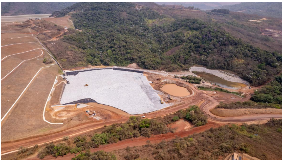
Figura 20 - Tratamento de Fundação do Maciço Principal - foto dia 16/10/24 (Concluído)
