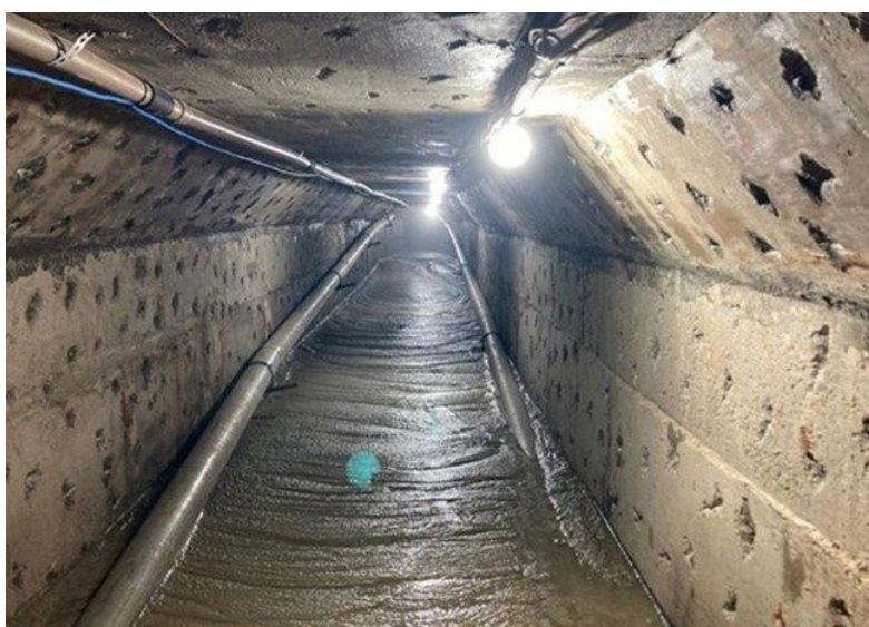
Figura 13 - Tamponamento da Tulipa Foto 25/09/24 (Em andamento) - Término previsto – 11/04/2025.
