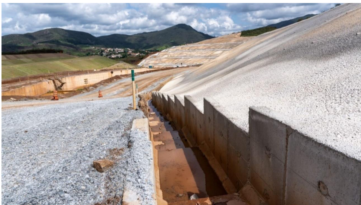
Figura 17 - Recuperação de taludes (Concluída) foto dia 13/12/23.
