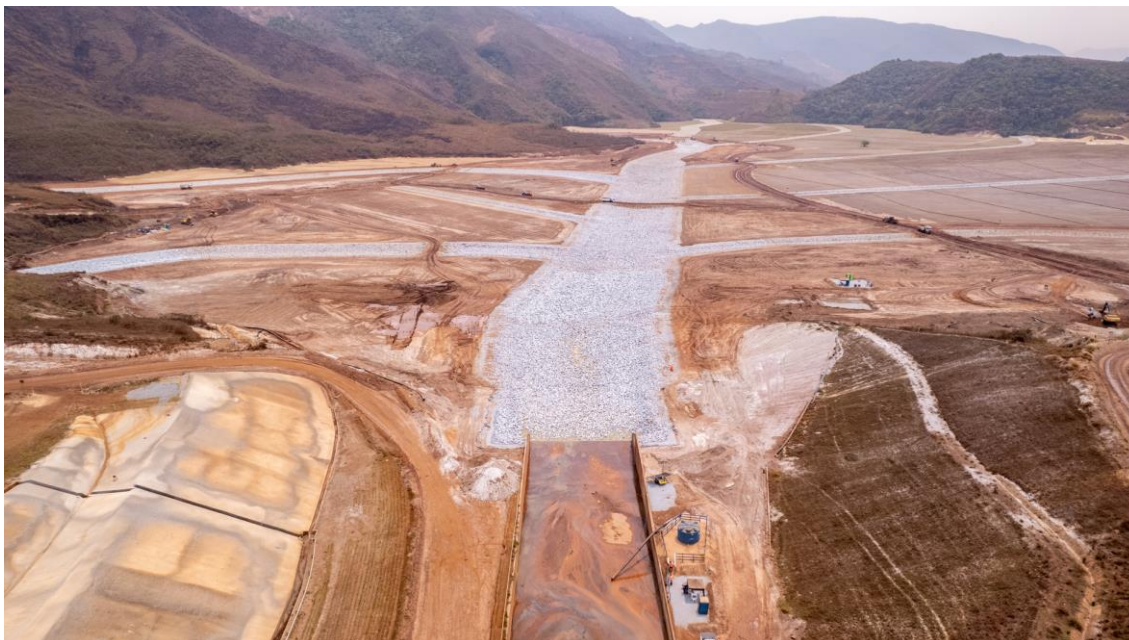
Figura 11 - Reconformação do reservatório (Foto 16/10/24).
