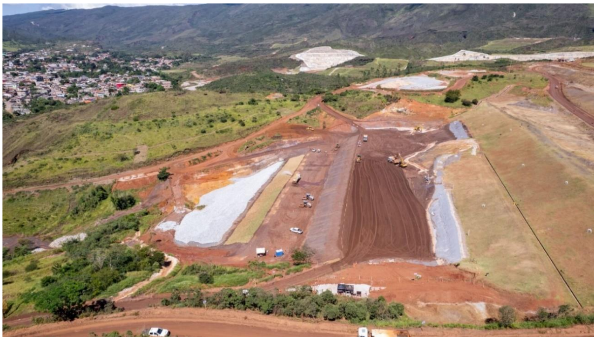
Figura 18 - Tratamento da fundação do Dique 1 – foto dia 24/04/24 (Concluído).
