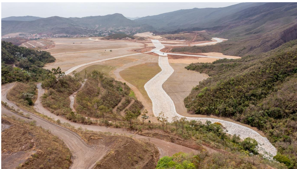
Figura 15 - Reconformação do reservatório – Canal 1 foto dia 16/10/24 (Concluído).
