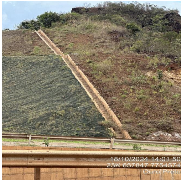
Figura 24 – Gabiões do talude 3 e Figura 25 - Canaletas talude 1. Fonte: Vale, outubro/24.
