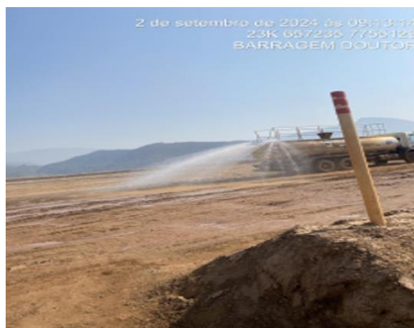
Figura 27 e Figura 28 - Umectação das vias de acesso através do caminhão pipa. Fonte: Vale, 2024.
