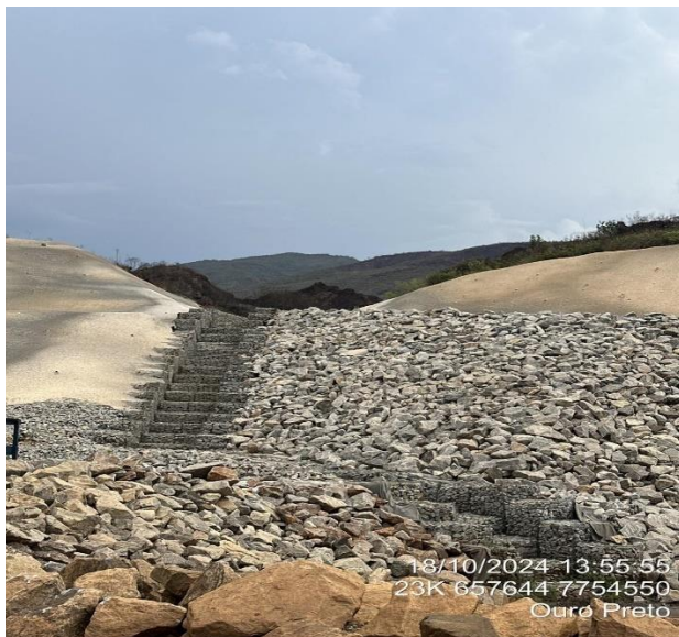
Figura 24 – Gabiões do talude 3 e Figura 25 - Canaletas talude 1. Fonte: Vale, outubro/24.
