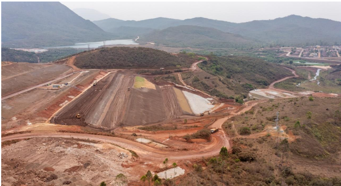
Figura 12 - Tratamento de fundação do Dique 1 (Imagem de 16/10/24).
