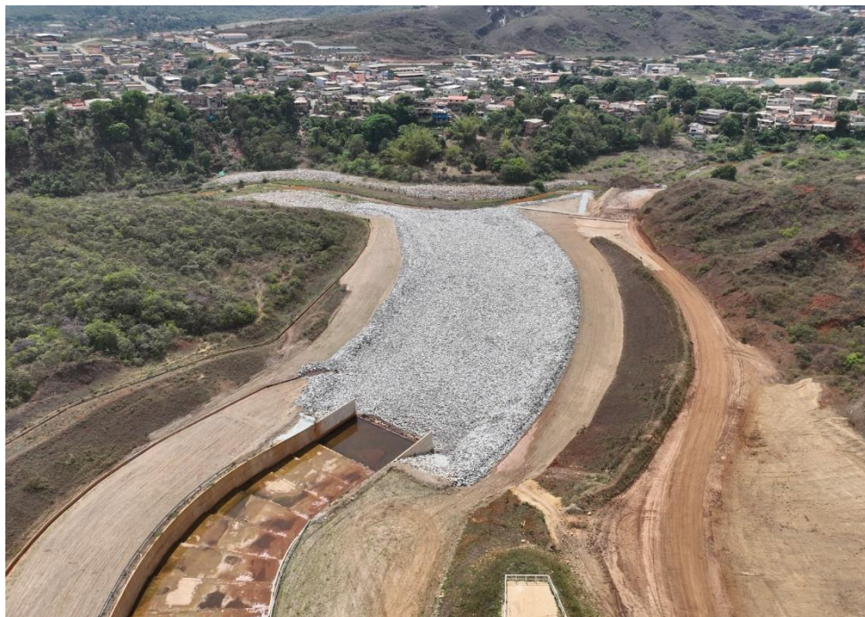
Figura 26 - Bacia de dissipação do canal extravasor. Fonte: Vale, 17/10/24.
