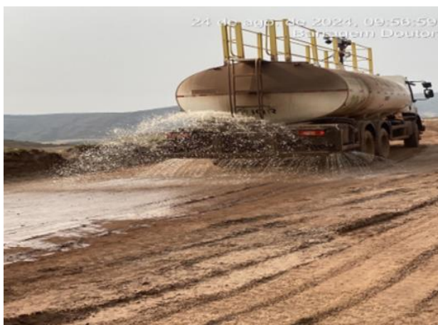
Figura 29 e Figura 30 - Umectação das vias de acesso através do caminhão pipa. Fonte: Vale, 2024.
