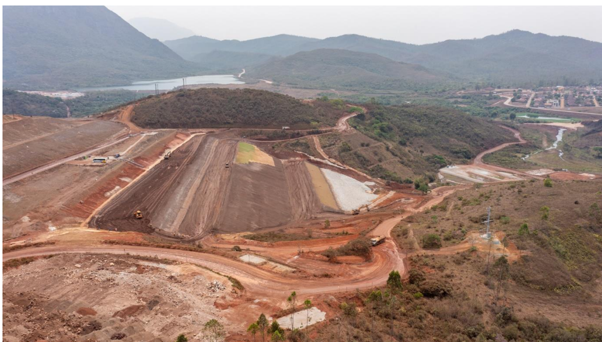
Figura 19 - Aterro do reforço do Dique 1 – foto dia 16/10/24 (Em andamento) – Término previsto – 27/01/2027.
