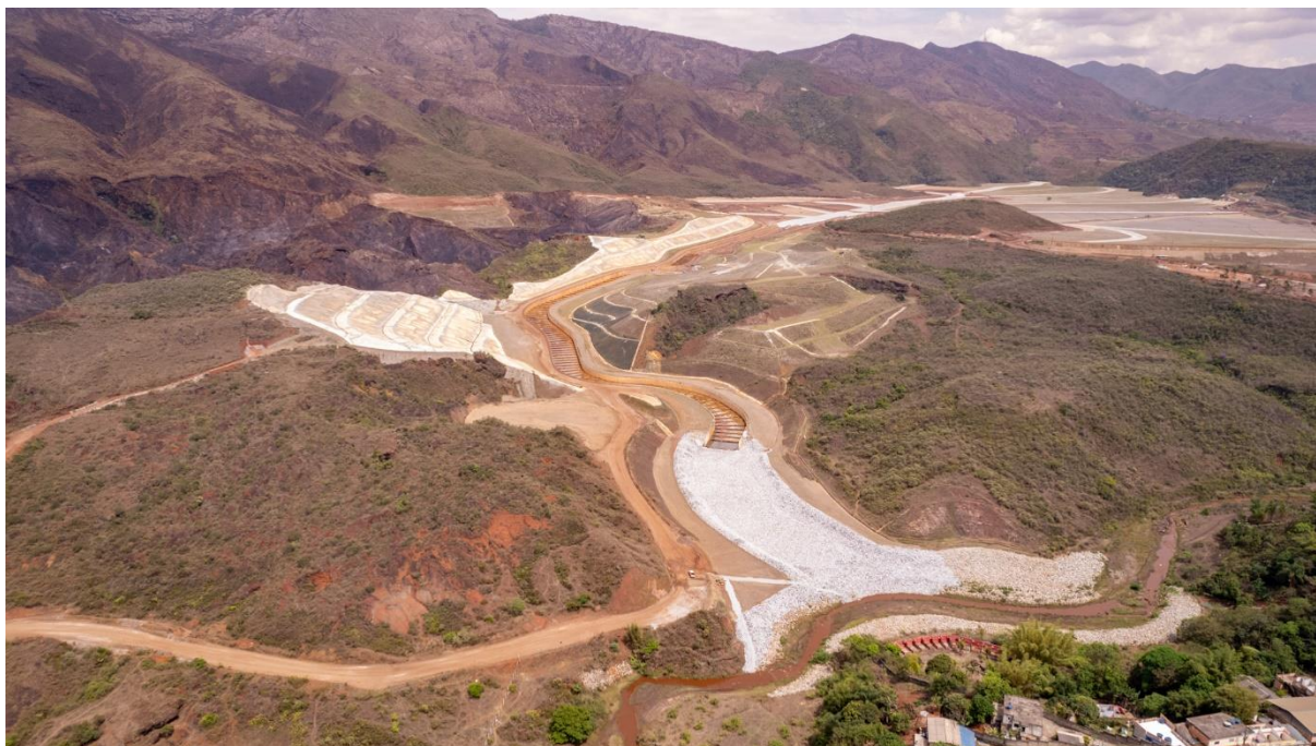
Figura 16 - Construção do canal extravasador em concreto foto dia 11/01/24 (Concluído).
