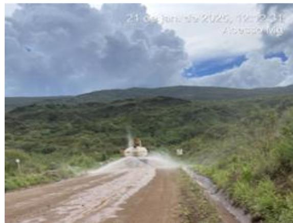
**Figura 38 e Figura 39 – Aplicação de polímero no acesso do extrator e no acesso à MG-129.**
