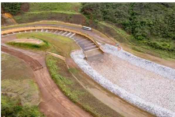
**Figura 30 - Revegetação na área de entorno do desemboque do extravasor e Bacia de dissipação. Fonte: Vale, 2025.**
