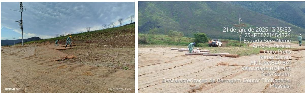
**Figura 26 - Revegetação de áreas expostas na obra de descaracterização da barragem de Doutor. Fonte: Vale, 2025.**
