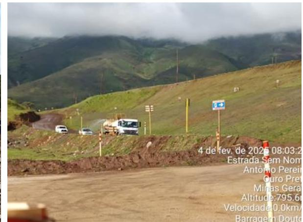
**Figura 36 - Umidificação das vias do Dique 1 com caminhão pipa. Fonte: Vale, 2025.**
