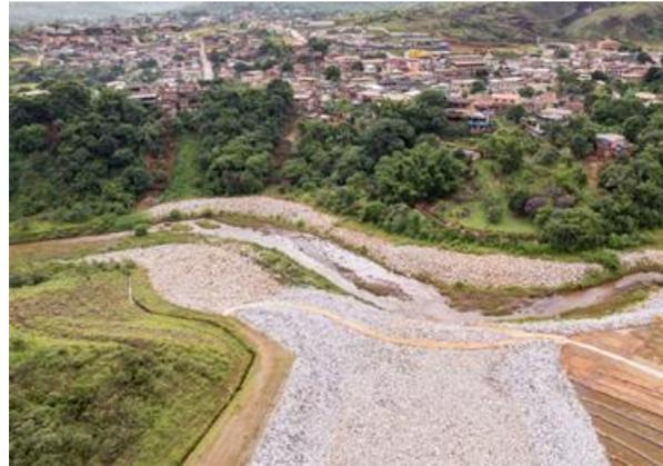
**Figura 33 - Revegetação no entorno da bacia de dissipação nas imediações do córrego água suja. Fonte: Vale, 2025.**
