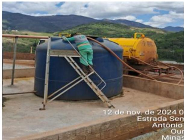
**Figura 53 - Limpeza de tanque séptico. Fonte:**
