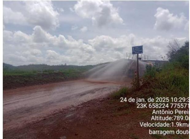
**Figura 34 e Figura 35 - Umectação das vias do pátio 2 e canteiro com caminhões pipa. Fonte: Vale, 2025.**
