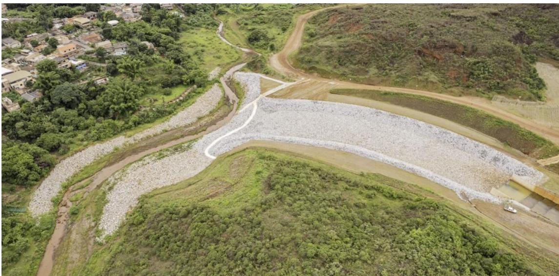
**Figura 23 - Bacia de dissipação do canal extravasor. Fonte: Vale, 29/01/25.**
