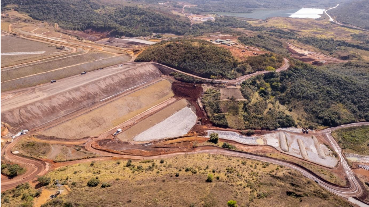
Figura 9 - Início das atividades de Drenagens Dique 1 (Imagem de 23/07/25).
