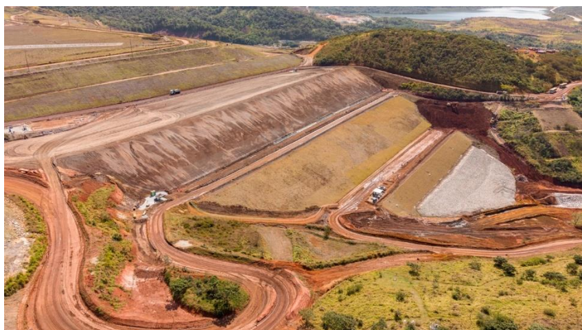
Figura 13 – Execução de Drenagens no Dique 1 – foto dia 23/07/25 (Em andamento)
