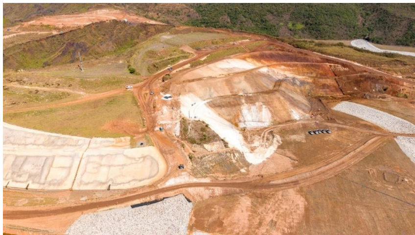
Figura 15 – Execução do retaludamento do Talude 08 – foto dia 23/07/25 (Em andamento)
