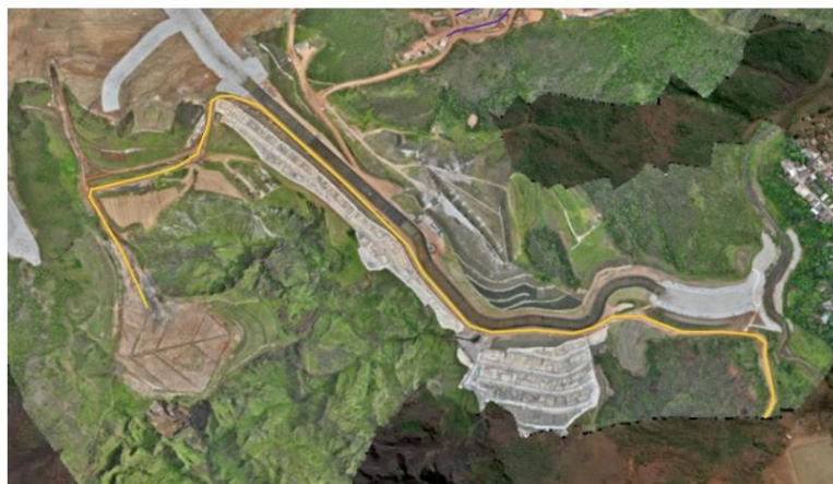
Figura 28 - Rotograma das áreas de umectação na barragem Doutor. Fonte: Vale, 2025.
