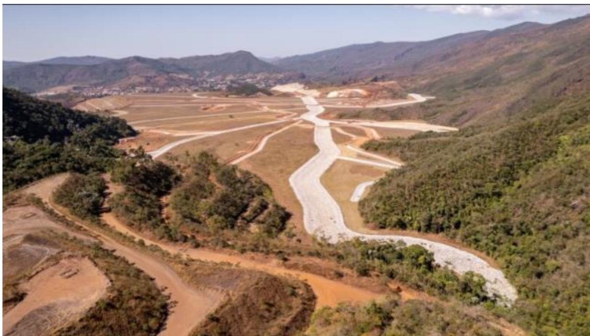
Figura 10 - Reconformação do reservatório – Canal 1 foto dia 23/07/25 (Concluído).
