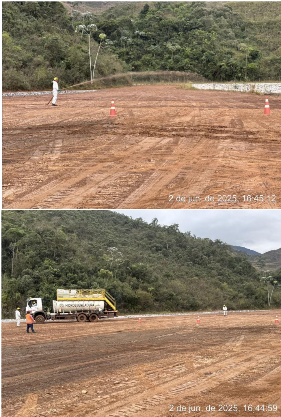
Figura 27 – Recuperação ocorrida com aplicação de hidrossemeadura na área do regreide. Fonte: Vale, 2025.
