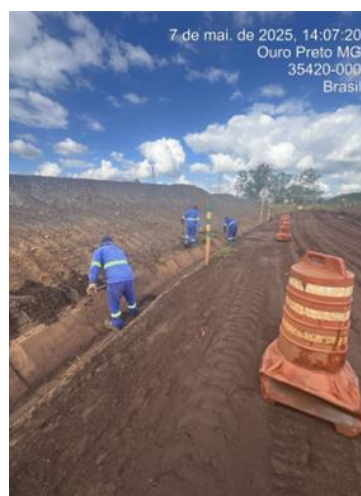
Figura 19 - Limpeza das canaletas da pilha de Miguel Congo. Fonte: Vale, 2025
