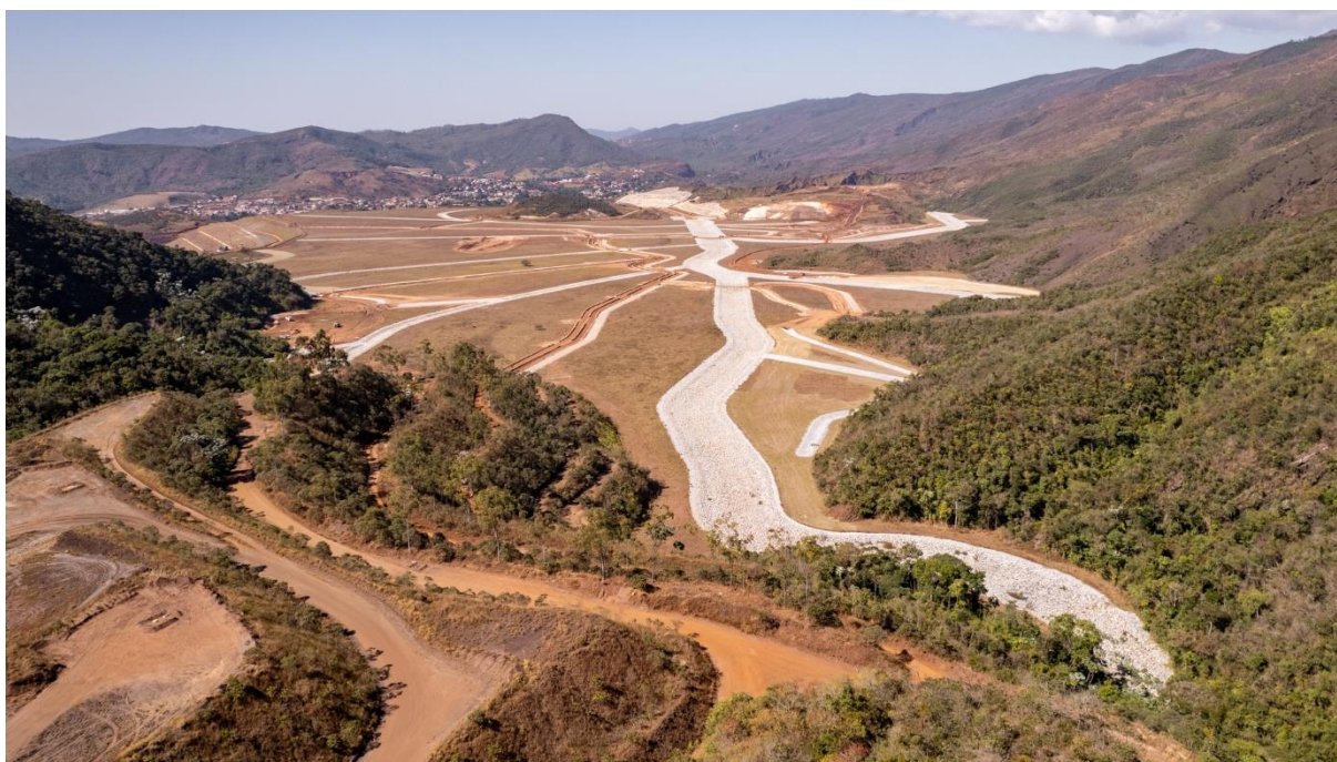
Figura 8 - Reconformação do reservatório (Foto 23/07/25).
