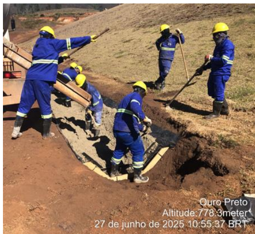
Figura 20 - Construção de canaletas do talude do dique 1.
