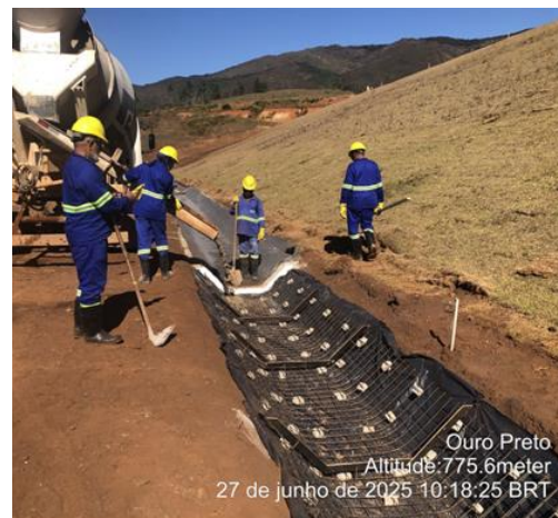
Figura 20 - Construção de canaletas do talude do dique 1.
