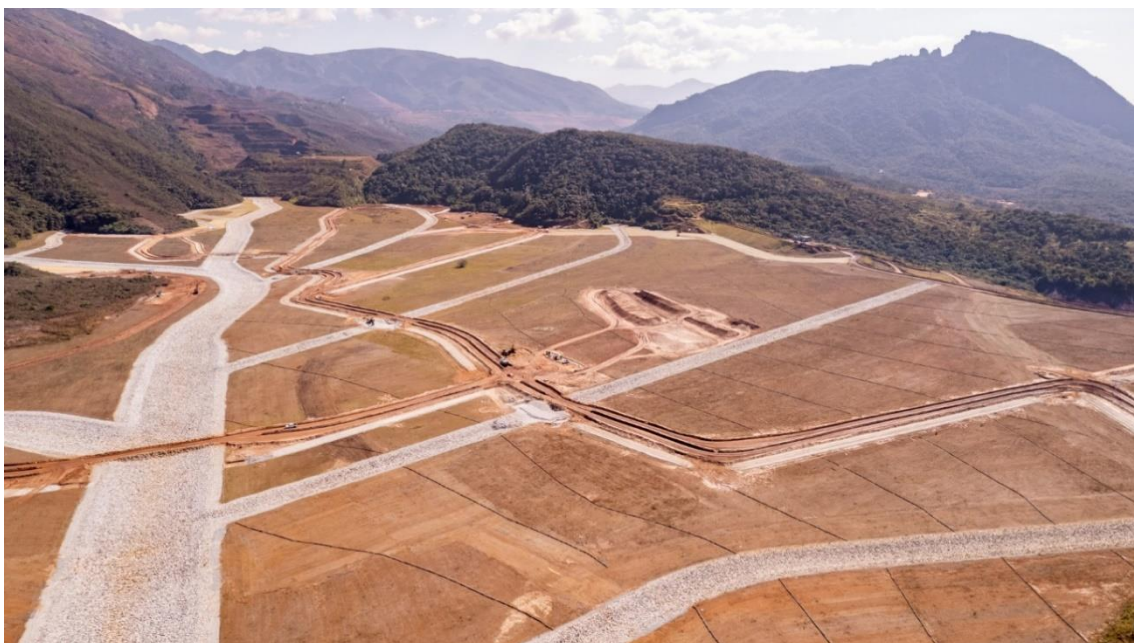
Figura 3 - Vista do Reservatório – 23/07/2025
