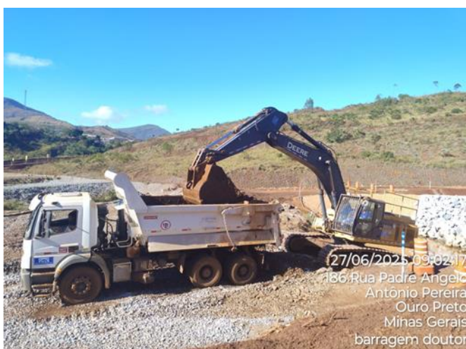
Figura 18 - Limpeza do sump do dique 1. Fonte: Vale, 2025
