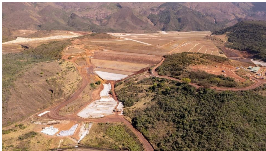
Figura 12 - Tratamento da fundação do Dique 1 – foto dia 23/07/25 (Concluído).
