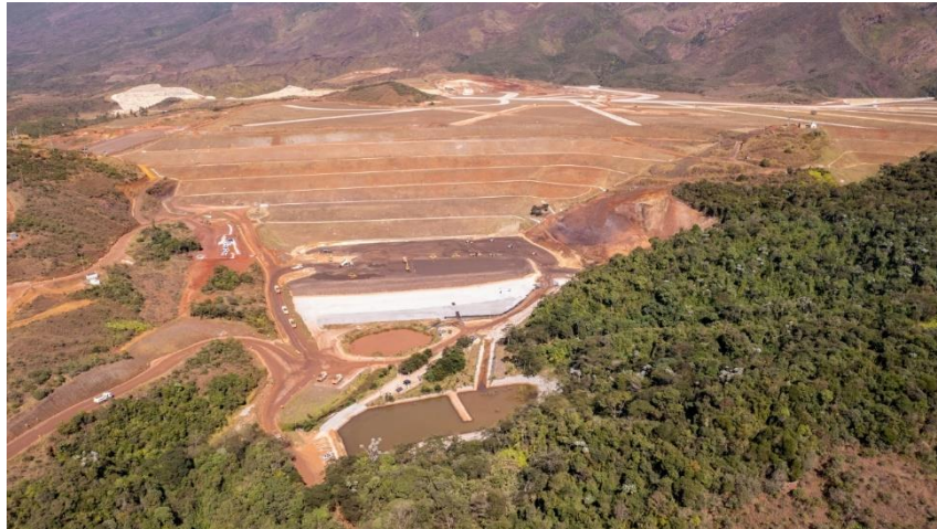
Figura 14 – Execução de reforço em aterro no Maciço Principal – foto dia 23/07/25 (Em andamento)
