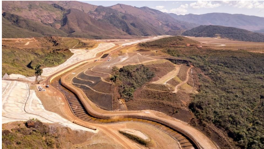
Figura 11 - Construção do canal extravasor em concreto foto dia 23/07/25 (Concluído).
