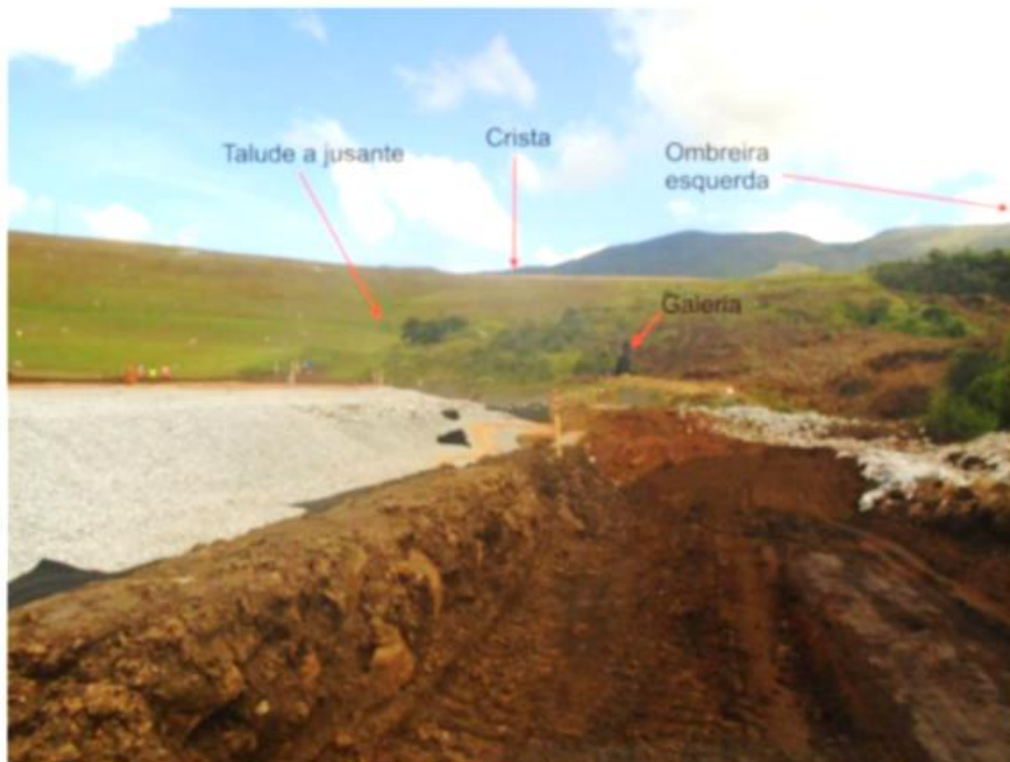
Figura 21 – Localização da galeria com relação as estruturas da Barragem Doutor.
