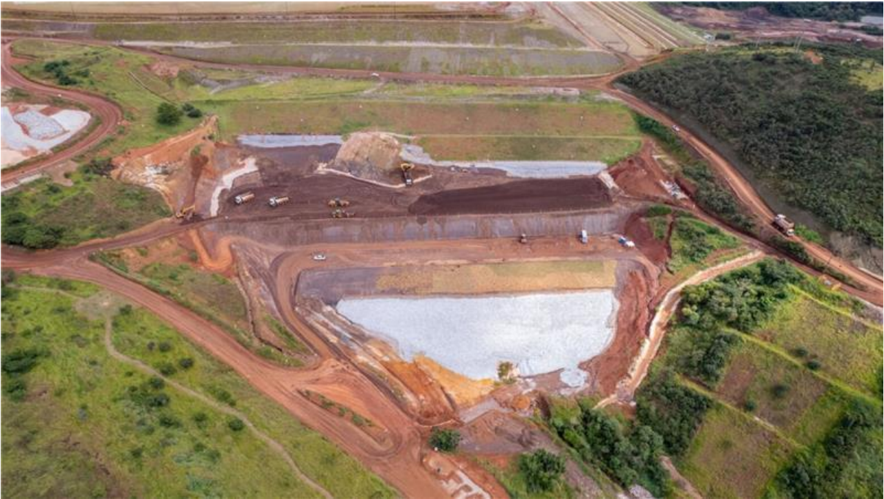
Foto 4. Tratamento de fundação do Dique 1 (Imagem de 24/04/24).
