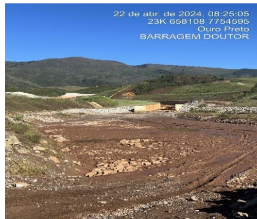
Foto 16 e Foto 17. Limpeza da bacia de dissipação.
