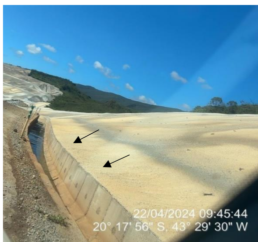
Foto 10 e Foto 11. Canaletas do Talude 4. Nota-se o bom estado de conservação das estruturas de drenagem.
