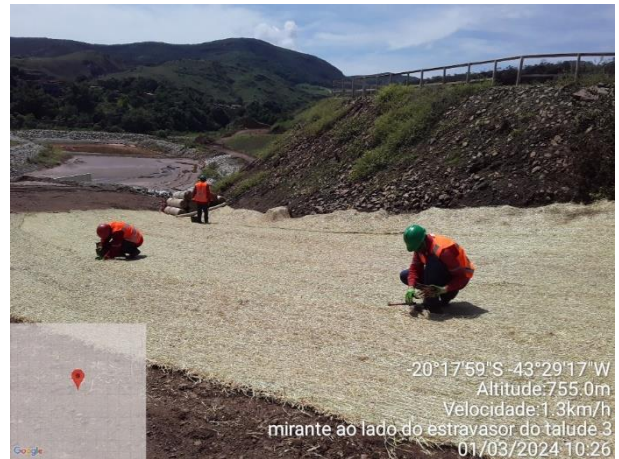
Foto 41 e Foto 42. Revegetação com aplicação de hidrossemeadura com biomanta.Fonte: Vale, 2024.
