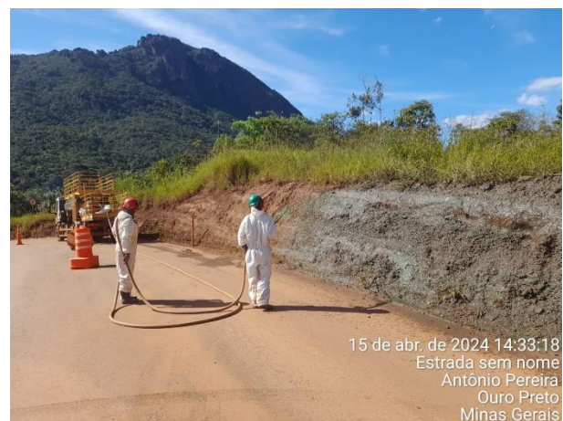
Foto 39 e Foto 40. Aplicação de manta vegetal projetada MVP. Fonte: Vale, 2024.
