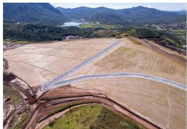
Foto 45 e Foto 46. Revegetação do regreide e grama no dique 1.Fonte: Vale, 2024.
