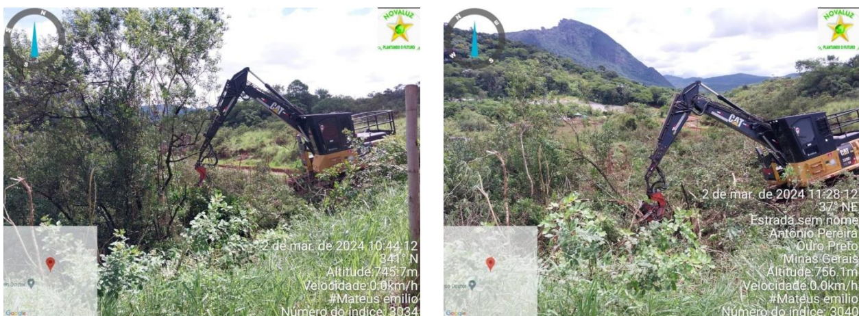
Foto 31 e Foto 32. Supressão Maciço Principal. Fonte: Bioma (abril/2024).
