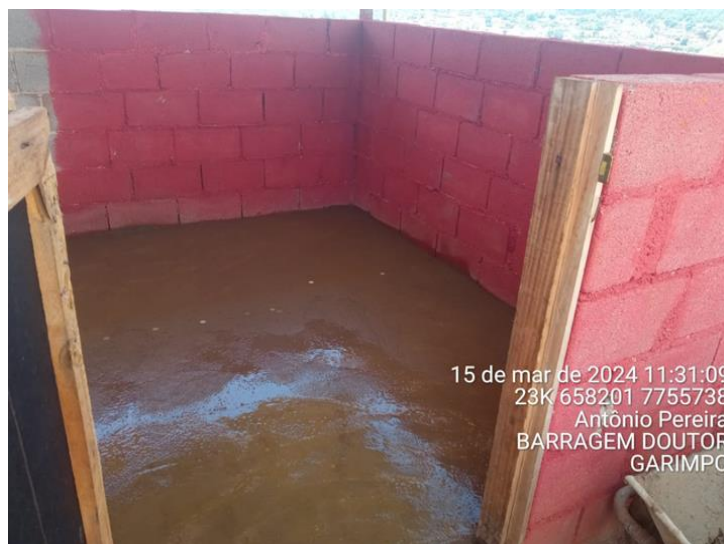
Foto 55. Depósito Intermediário de Resíduos - DIR.Fonte: Vale, (03/2024).
