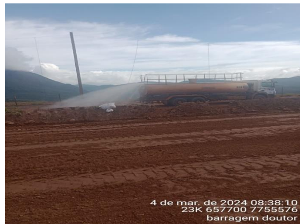
Foto 47 e Foto 48. Umectação das vias de acesso através do caminhão pipa. Fonte: Vale, 2024.
