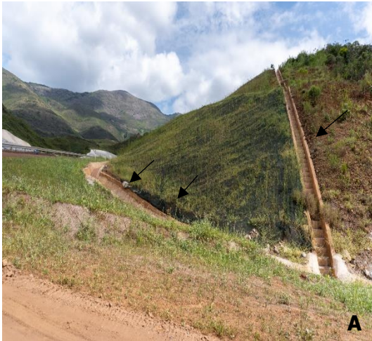
Foto 12 e Foto 13. Canaletas e escada hidráulica para drenagem do (A) Talude 1 e (B) Talude 3.
