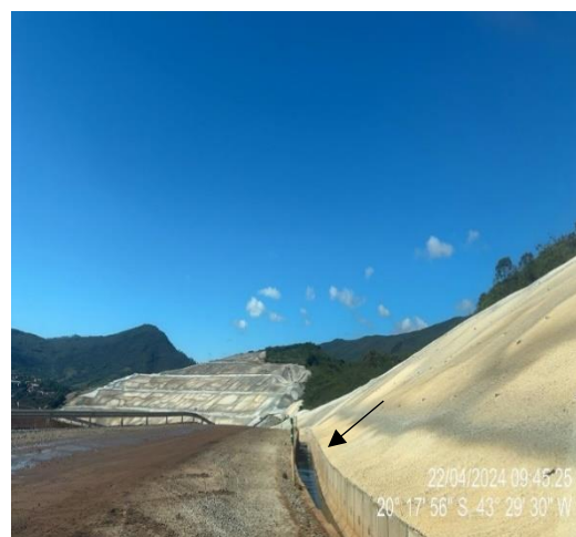
Foto 10 e Foto 11. Canaletas do Talude 4. Nota-se o bom estado de conservação das estruturas de drenagem.
