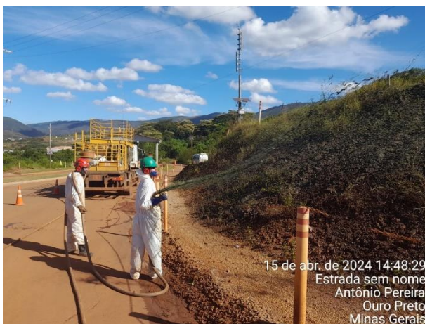
Foto 39 e Foto 40. Aplicação de manta vegetal projetada MVP. Fonte: Vale, 2024.
