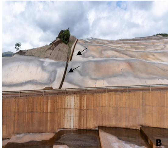
Foto 12 e Foto 13. Canaletas e escada hidráulica para drenagem do (A) Talude 1 e (B) Talude 3.
