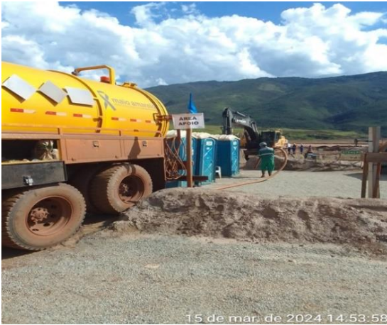
Foto 51. Limpeza de banheiro químico. Fonte: Vale, (03/2024).
