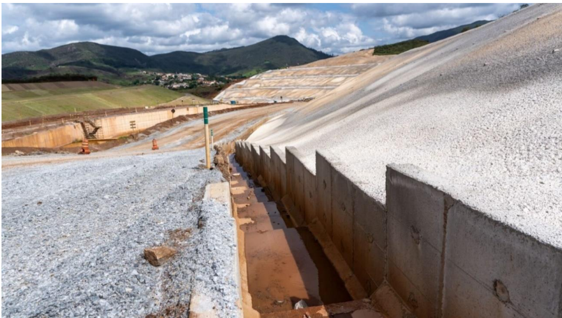
Foto 7. Recuperação de taludes (Concluída) foto dia 13/12/23.
