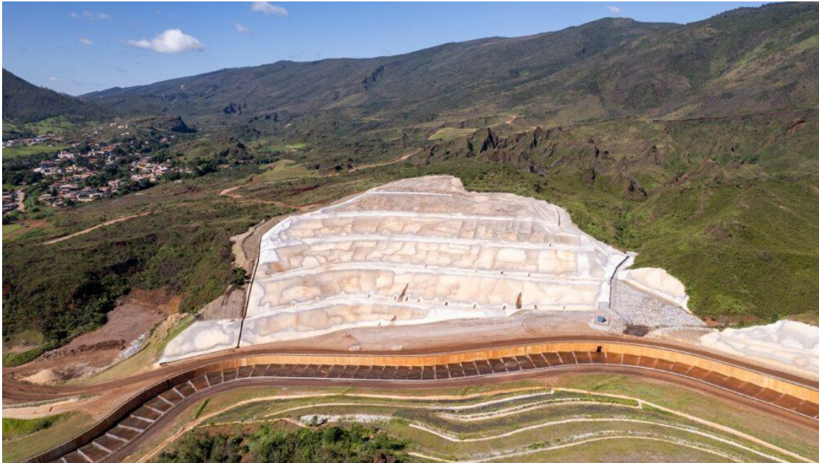
Foto 2. Situação atual das obras do Talude 3 (Foto 24/04/24).
