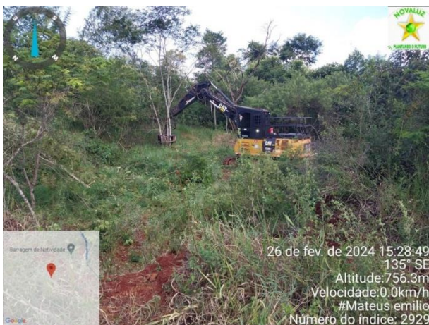
Foto 35. Supressão Pátio de Agregados 02.
