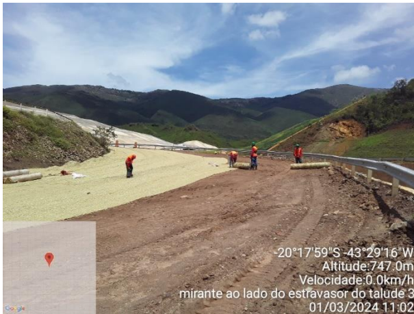
Foto 41 e Foto 42. Revegetação com aplicação de hidrossemeadura com biomanta.Fonte: Vale, 2024.
