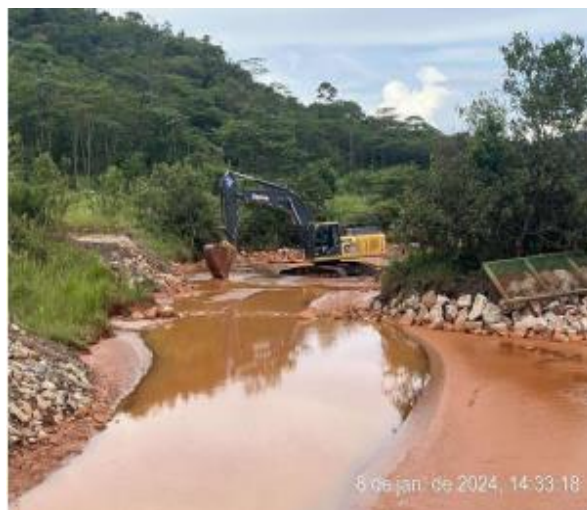
Foto 19. Implantação da caneleta de drenagem no acesso e limpeza do sump a jusante do maciço principal
