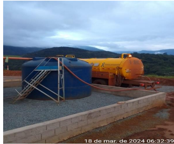
Foto 52. Limpeza de tanque séptico. Fonte: Vale, (03/2024).
