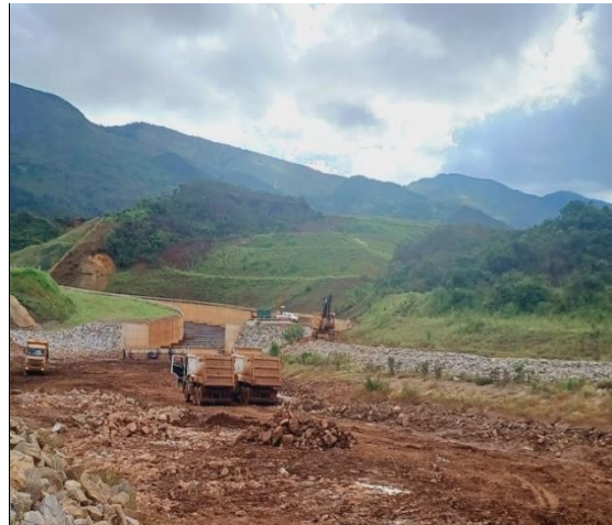
Foto 14 e Foto 15. Limpeza da bacia de dissipação.
