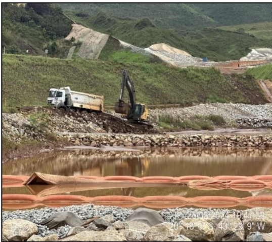
Foto 14 e Foto 15. Limpeza da bacia de dissipação.
