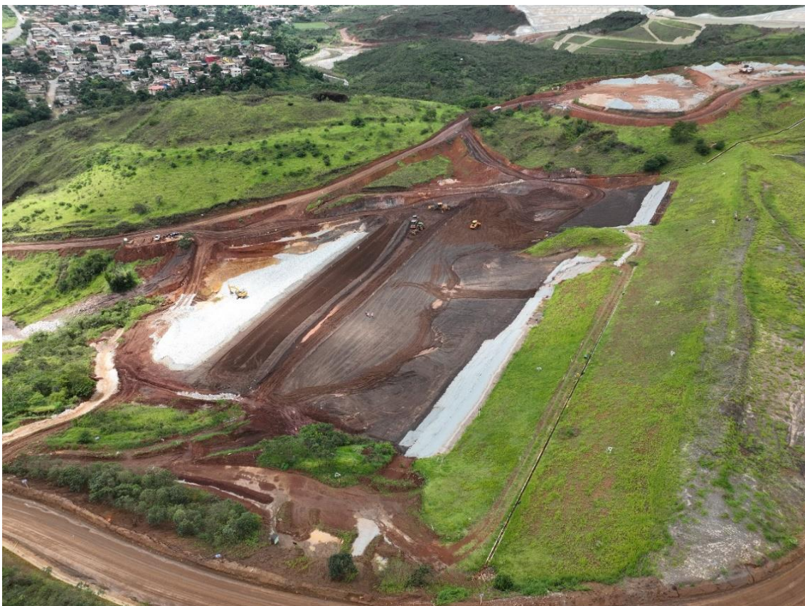
Foto 9. Aterro do reforço do Dique 1 – foto dia 24/04/24 (Em andamento) – Término previsto – 27/01/2027.
