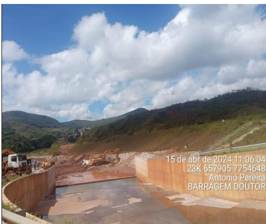
Foto 16 e Foto 17. Limpeza da bacia de dissipação.
