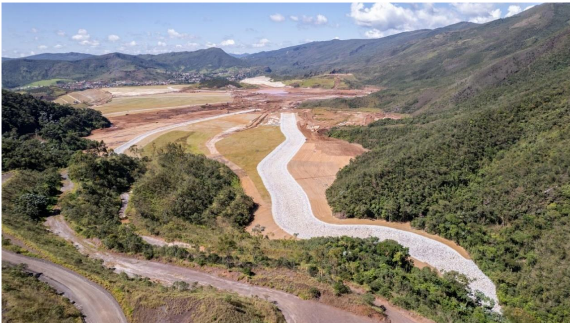
Foto 5. Reconformação do reservatório – Canal 1 foto dia 24/04/24 (Em andamento) Término previsto – 19/10/2027.
