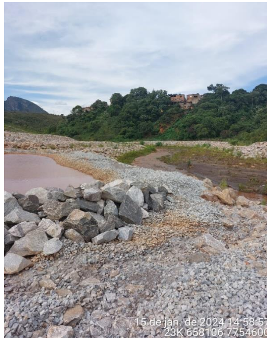
Foto 20. Bacia de Contenção à jusante do extravasor.
