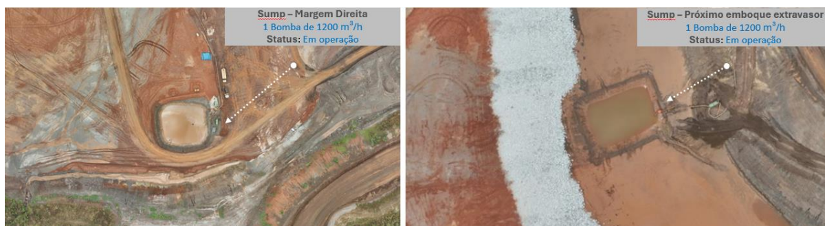
Figura 24 e Figura 25 - Sumps com bombeamento em operação (Outubro/24).
