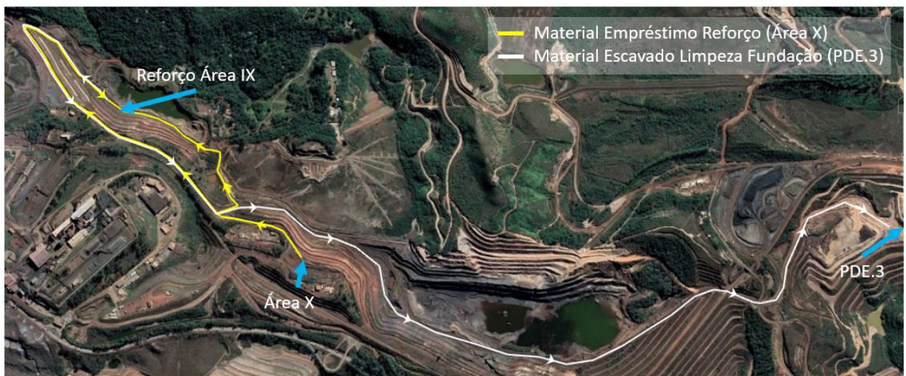
Figura 15 - Movimentação de Terra.
