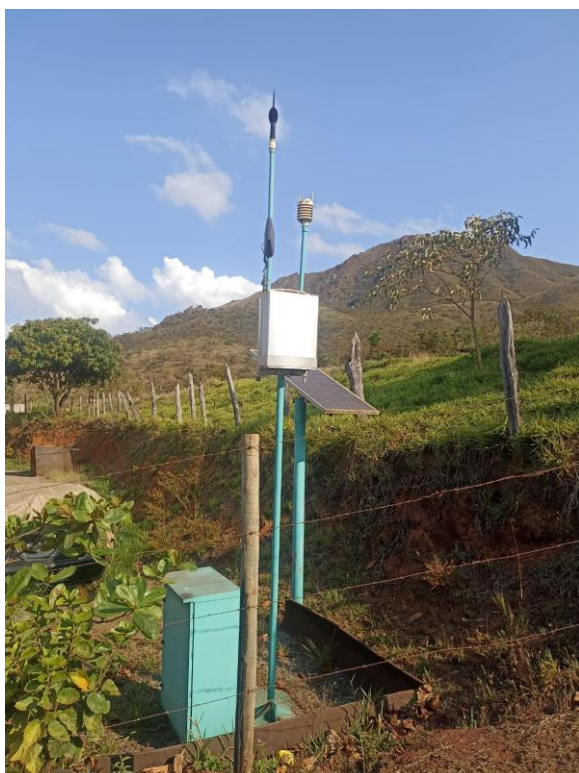
Figura 40 - Estação de Monitoramento de Ruído de Pires. Vale, 2023.
