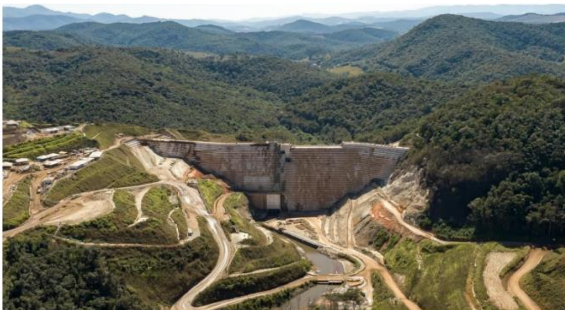
Figura 107 - Estrutura de Contenção a Jusante Fábrica. Fonte: Vale, 2022.
