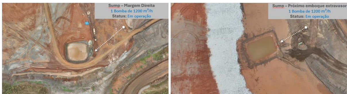
Figura 23 - Sumps com bombeamento em operação (Outubro/24).
