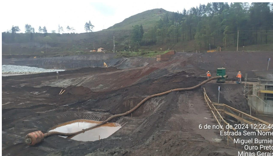
Figura 26 - Escavação do emboque do canal extravasor (Novembro/24)
