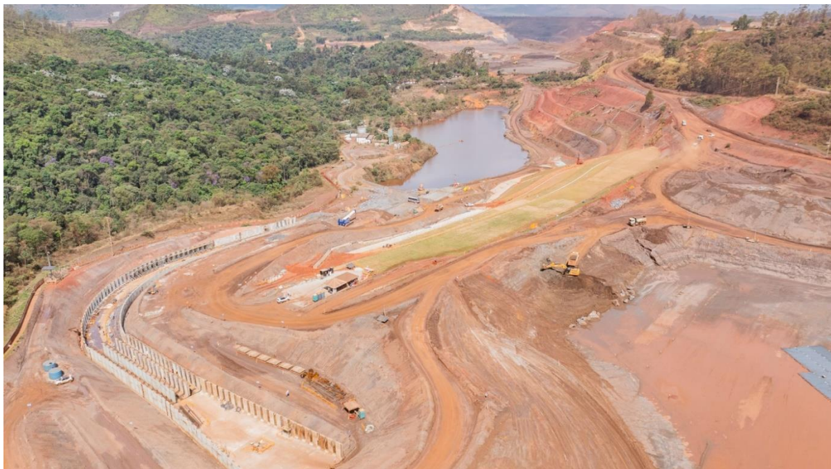
Figura 21 - Escavação de rejeitos no reservatório (Outubro/24).
