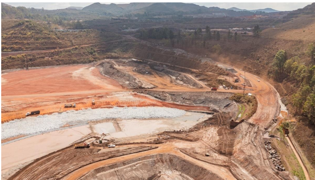
Figura 12 - Carga e transporte do rejeito para Cava 5 (Outubro/24).
