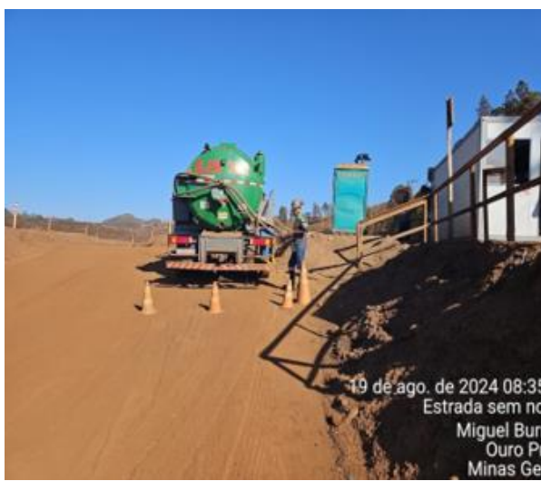
Figura 85 - Sucção de efluente sanitário armazenado nos tanques sépticos. Vale, agosto de 2024.
