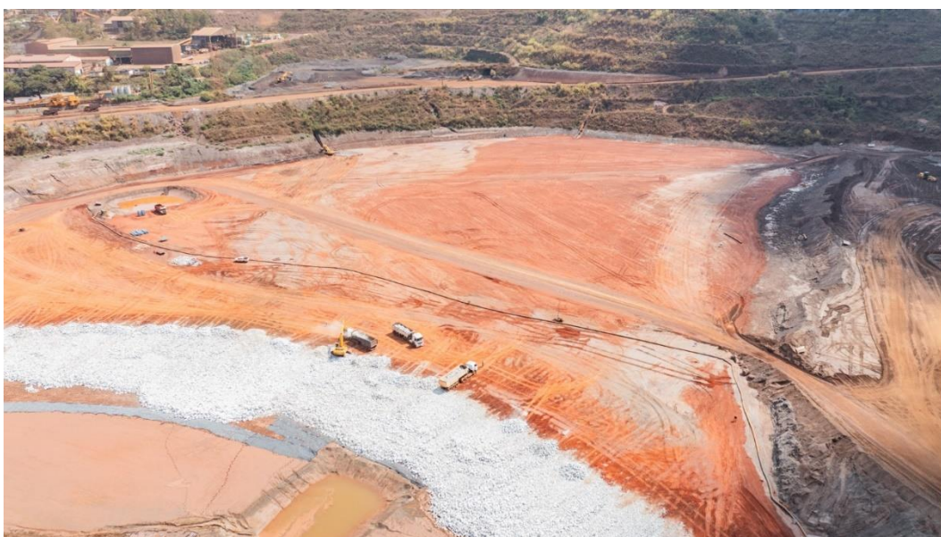
Figura 8 - Cobertura superficial do reservatório com argila em andamento (Outubro/24).
