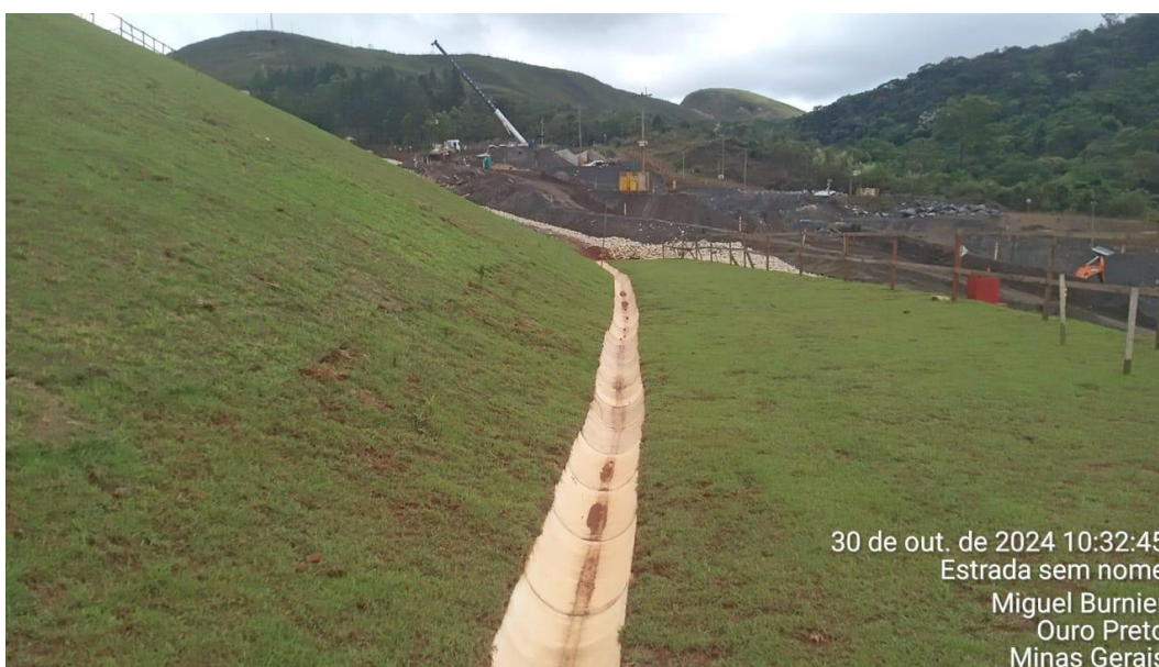
Figura 28 - Limpeza de canaletas superficiais (Outubro/24).
