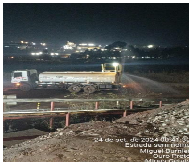
Figura 48 - Aspersão de água nos acessos de obra. Fonte: Vale, setembro de 2024.
