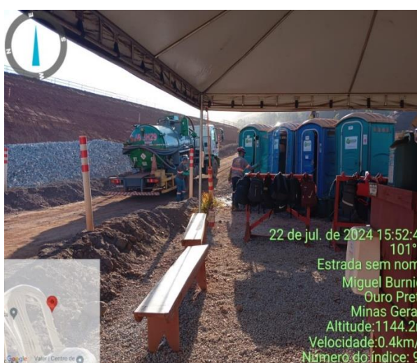
Figura 82 - Manutenção dos banheiros químicos disponíveis nas frentes de obra. Vale, julho de 2024.
