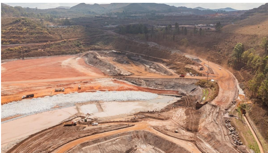
Figura 33 - Carga e transporte de material dos bota espera para Cava 5 (Outubro/24).
