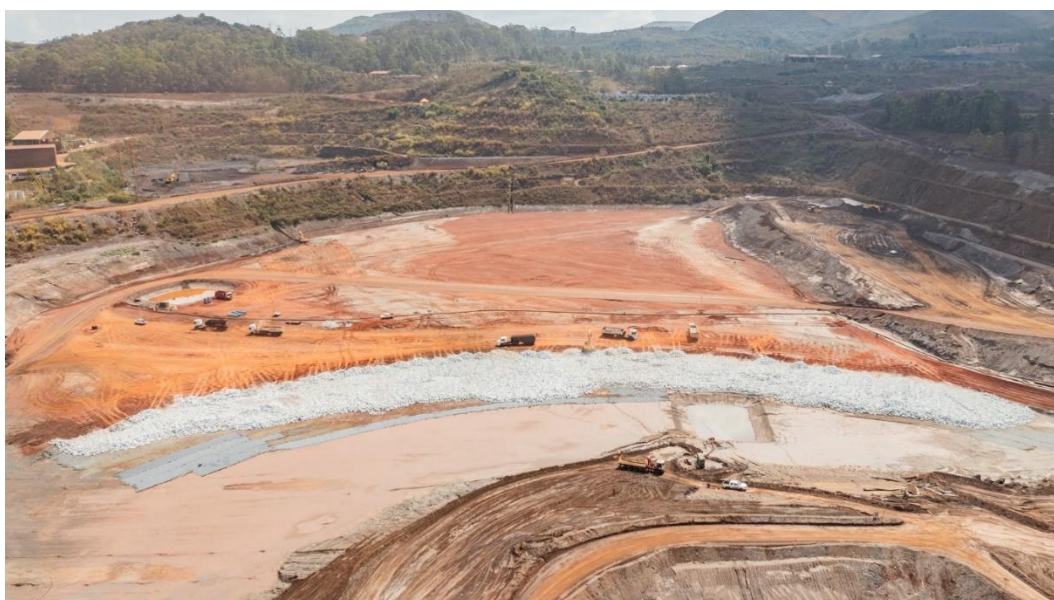
Figura 31 - Construção do cinturão de enrocamento (Outubro/24).
