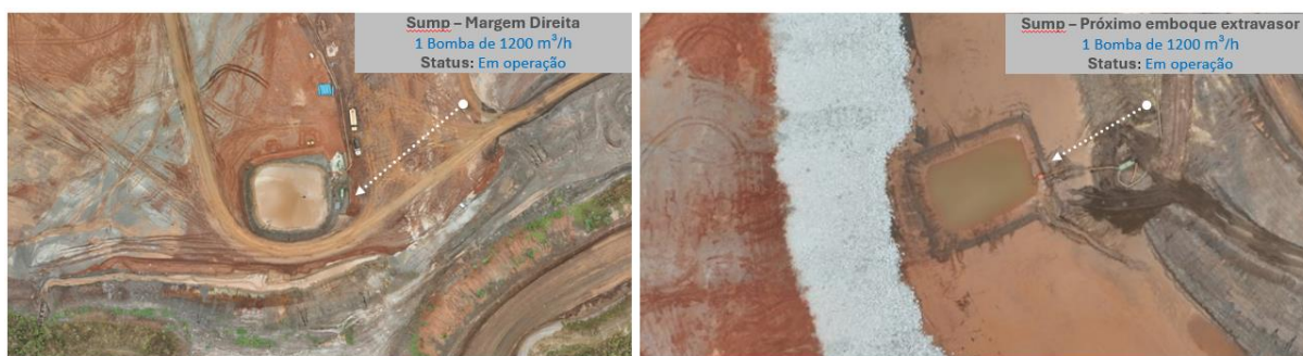
Figura 30 - Construção e manutenção dos sumps (Outubro/24).
