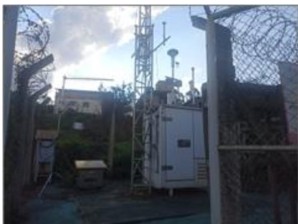
Figura 57 - Estação de Monitoramento de Qualidade do Ar de Pires.
