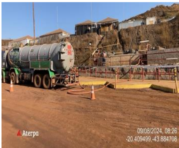
Figura 87 - Sucção de efluente sanitário armazenado nos tanques sépticos. Vale, setembro de 2024.
