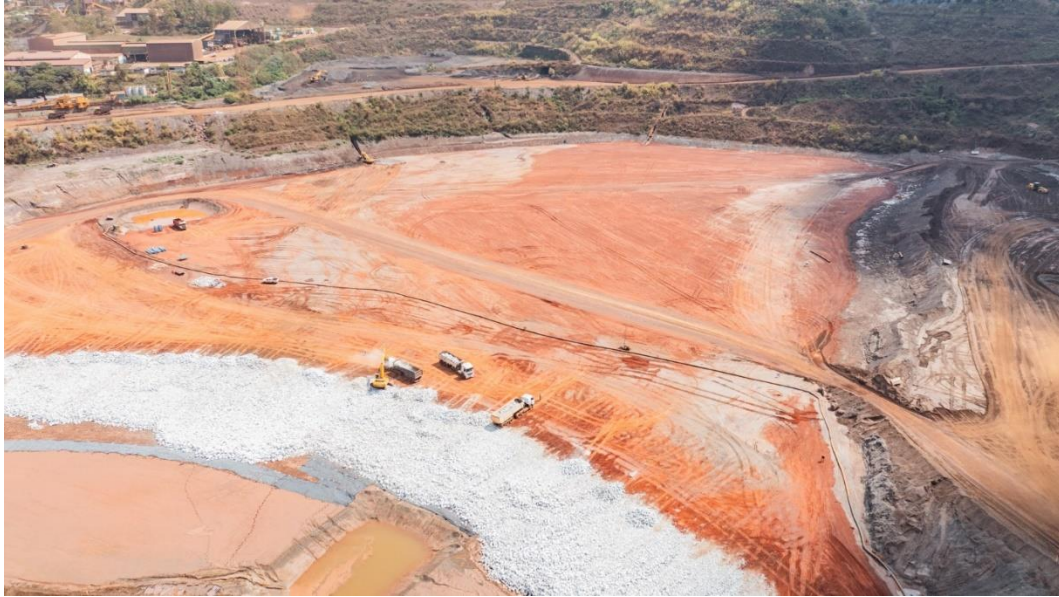
Figura 13 - Aplicação de argila no reservatório (Outubro/24).
