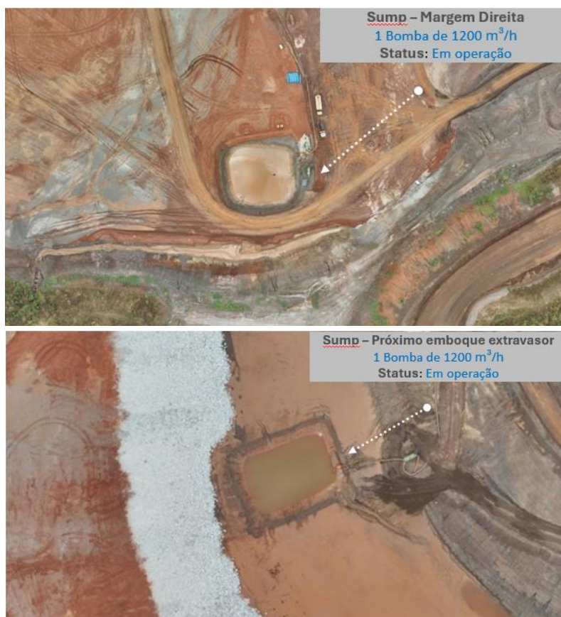
Figura 6 - Sumps com bombeamento em operação (Outubro/24)
