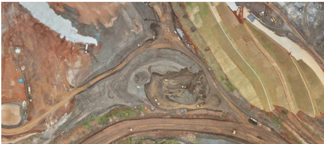
Figura 14 - Carga e transporte do rejeito para Cava 5 (Outubro/24).
