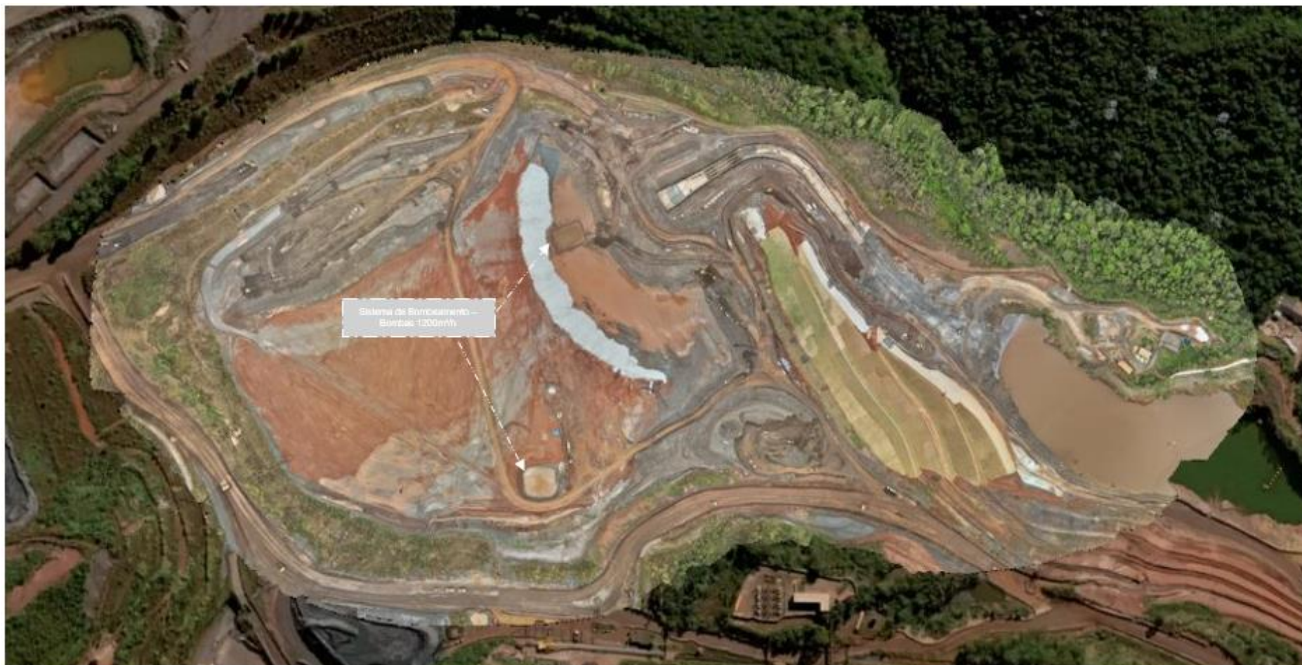
Figura 35 - Planta com o sistema de bombeamento operante no reservatório Área IX (status de outubro/2024).
