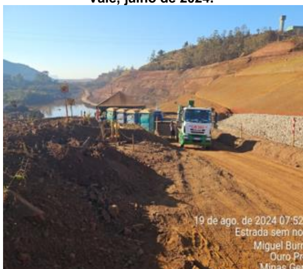
Figura 84 - Manutenção diária dos banheiros nas frentes de trabalho. Vale, agosto de 2024.
