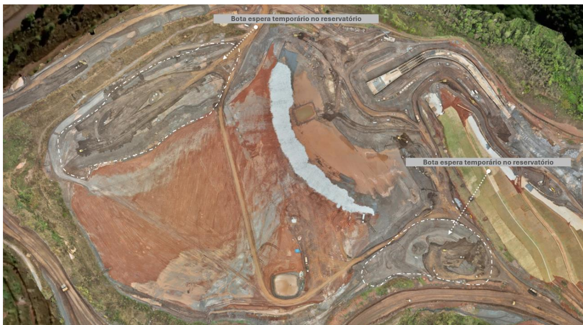
Figura 22 - Bota esperas no interior do reservatório Área IX (Outubro/24).
