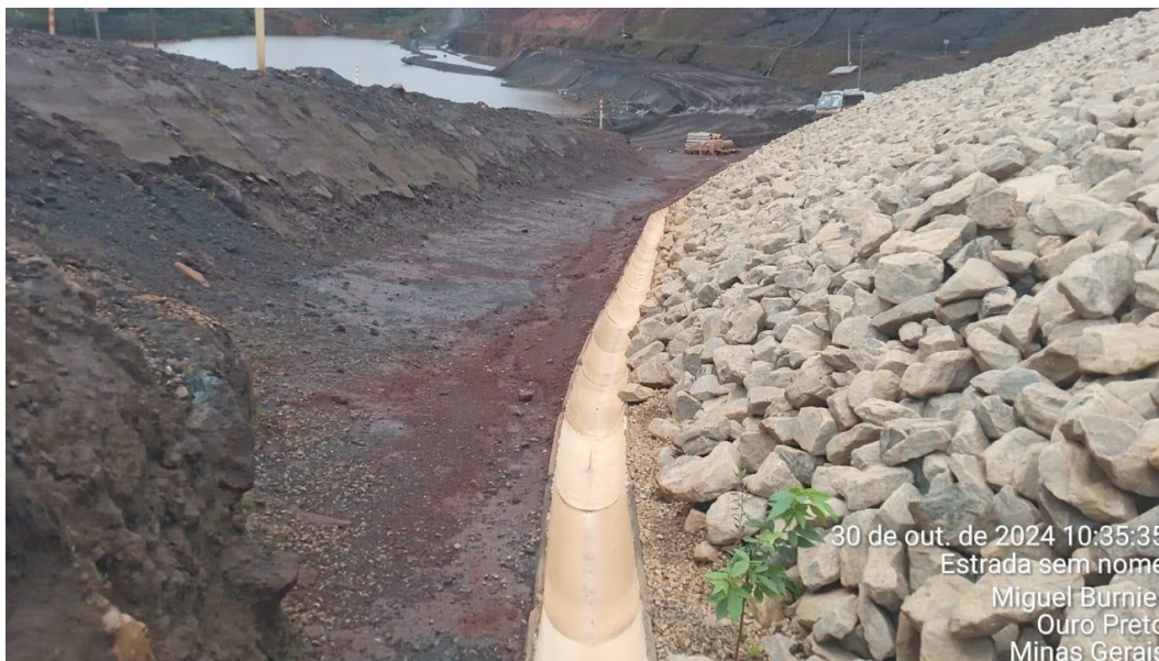
Figura 27 - Limpeza de canaletas superficiais (Outubro/24).
