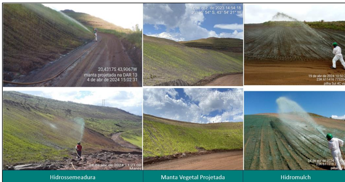
Figura 51 - Hidrossemeadura e Manta Vegetal Projetada, bem como Hidromulch. Fonte: Vale, 2024.
