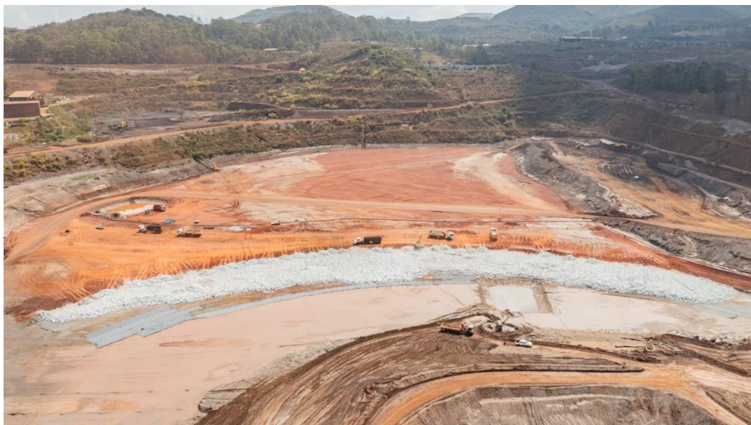
Figura 9- Construção do enrocamento em andamento (Outubro/24).
