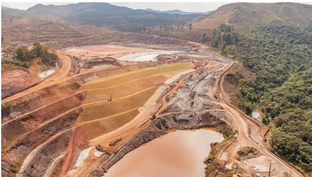
Figura 7 - Plantio de grama no talude jusante do reforço (Outubro/24).
