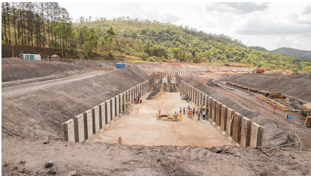
Figura 34 - Construção do canal extravasor (Outubro/24).
