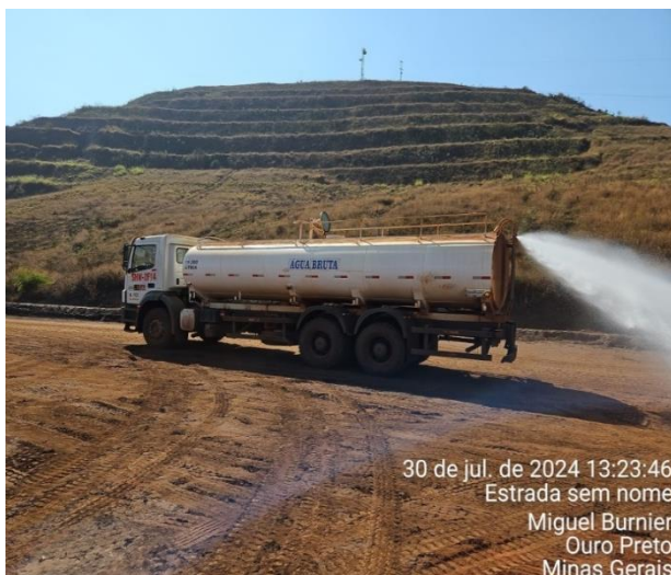
Figura 45 - Caminhão pipa realizando aspersão das vias. Fonte: Vale, julho de 2024.
