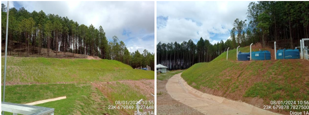
Foto 12 e Foto 13. Evolução da reconformação de talude na área do canteiro de obras do Dique 1A.
