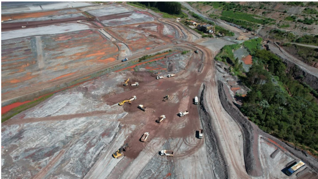
Foto 5. Carga de material da área de estoque para uso no regrade a montante.
