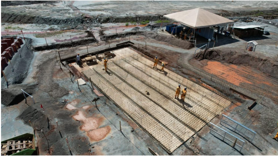
Foto 6. Execução de galeria do canal de drenagem C1.
