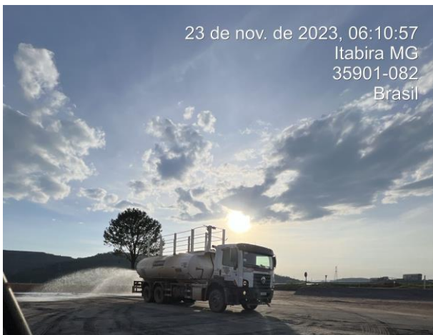
Foto 14, Foto 15, Foto 16 e Foto 17. Umectação de vias de acesso as obras de descaracterização do Dique 1A. Fonte: Vale, 2024.
