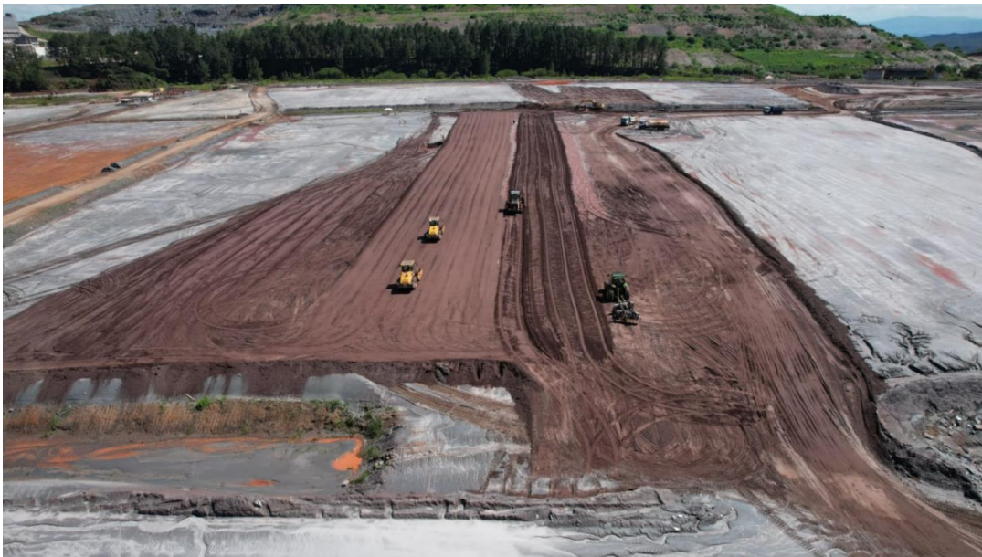
Foto 4. Regrade a montante do reservatório.
