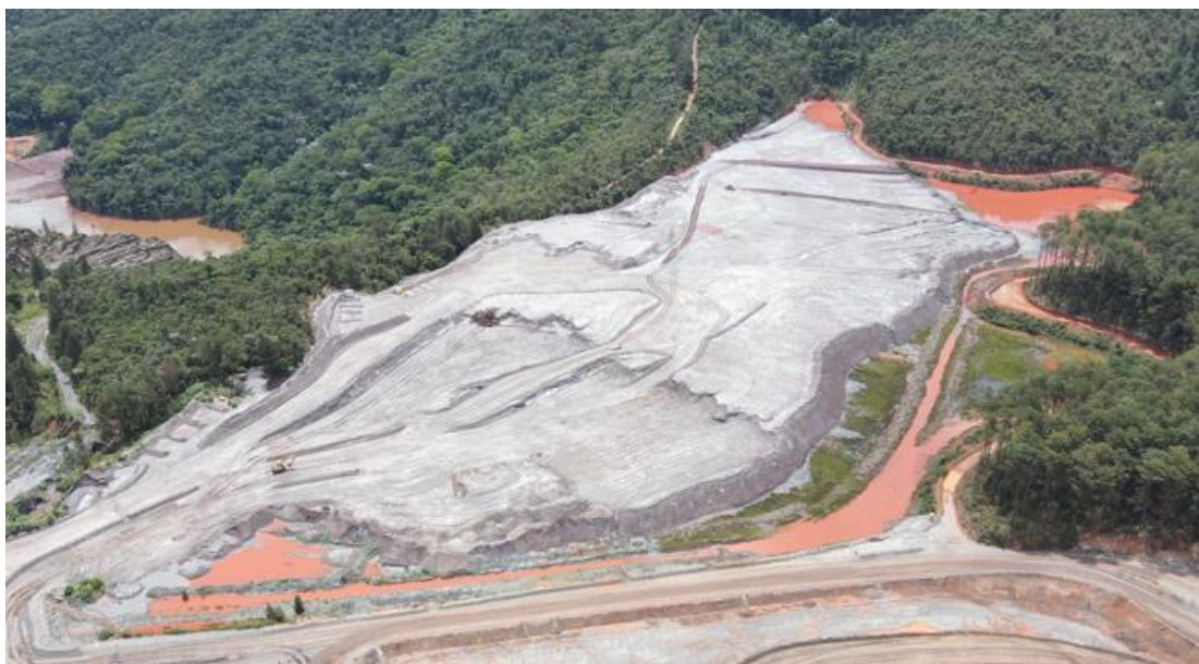
Foto 3. Área de execução do preenchimento do reservatório a montante do Dique 1A através de um aterro de conquista com rejeito filtrado.
