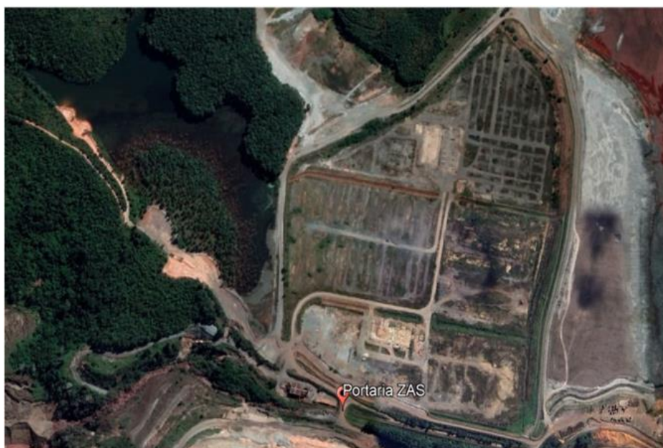
Figura 7. Localização da Portaria ZAS Dique 1A.
