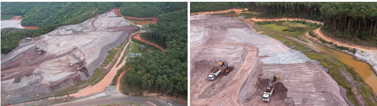
Foto 8 e Foto 9. Canal provisório de direcionamento de água do Dique 1A para Barragem Itabiruçu. Fonte: Vale, 2024.
