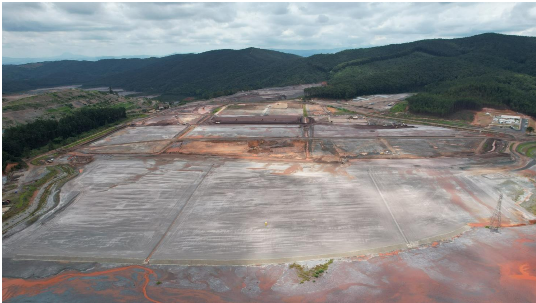
Foto 7. Reconformação do reforço a jusante e execução dos canais secundários.
