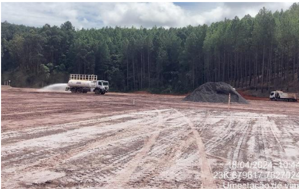
Foto 46. Umectação de vias de acesso as obras de descaracterização do Dique 1A e 1B. Fonte: Vale, 2024.
