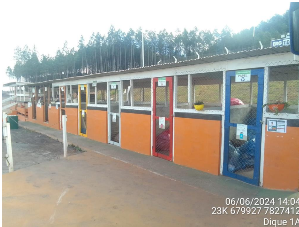
Foto 60. Depósito Intermediário de Resíduos Dique 1A, também utilizado para as obras do Dique 1B. (Fonte: Vale, 2024).
