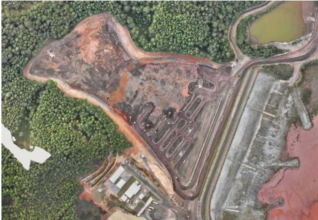
Foto 12. Escavação do Dique 1B (Julho/24).
