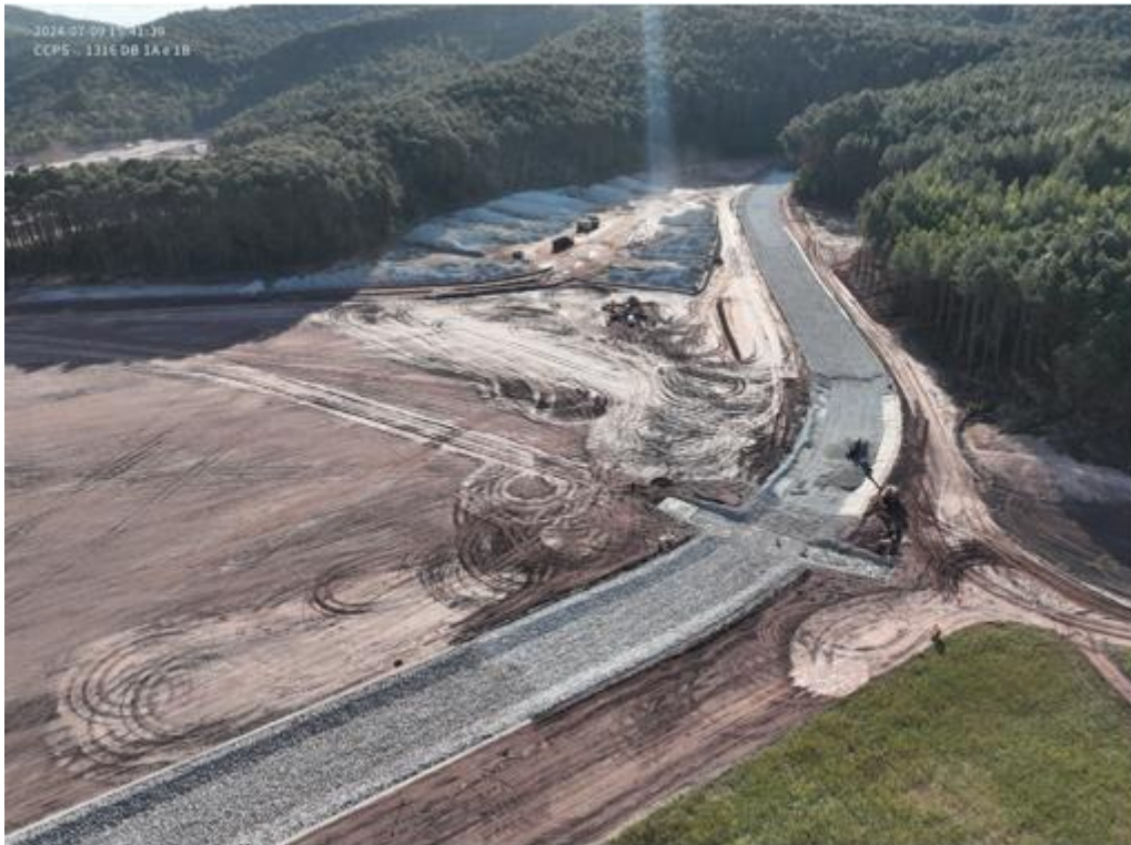
Foto 4. Canal Periférico C2 - Dique 1A (Julho/24).
