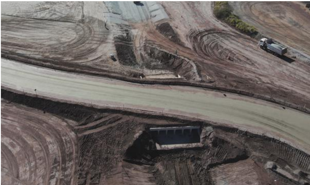
Foto 7. Galeria do Canal C1 do Dique 1A (Junho/24).
