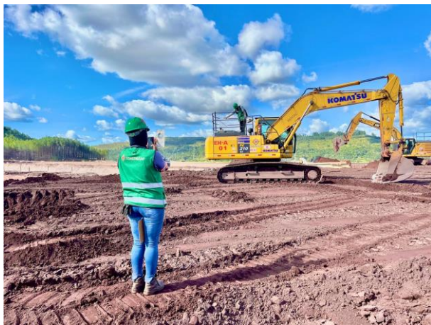
Foto 52. Controle de emissões atmosféricas proveniente da combustão de motores de equipamentos e veículos movidos a diesel. Dique 1A e 1B. Fonte: Vale, 2024.
