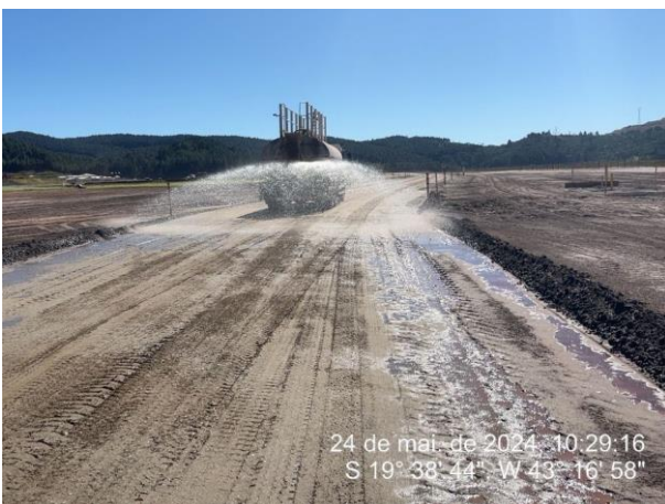
Foto 48. Umectação de vias de acesso as obras de descaracterização do Dique 1A e 1B. Fonte: Vale, 2024.
