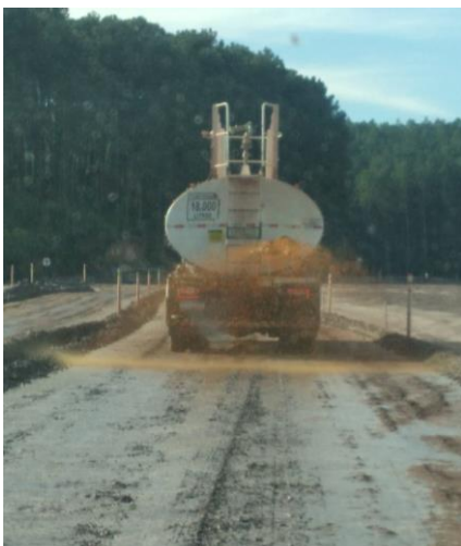
Foto 50. e Foto 51. Aplicação de polímero supressor de poeira nas principais vias de acesso as obras de descaracterização do Dique 1A e 1B. Fonte: Vale, 2024.
