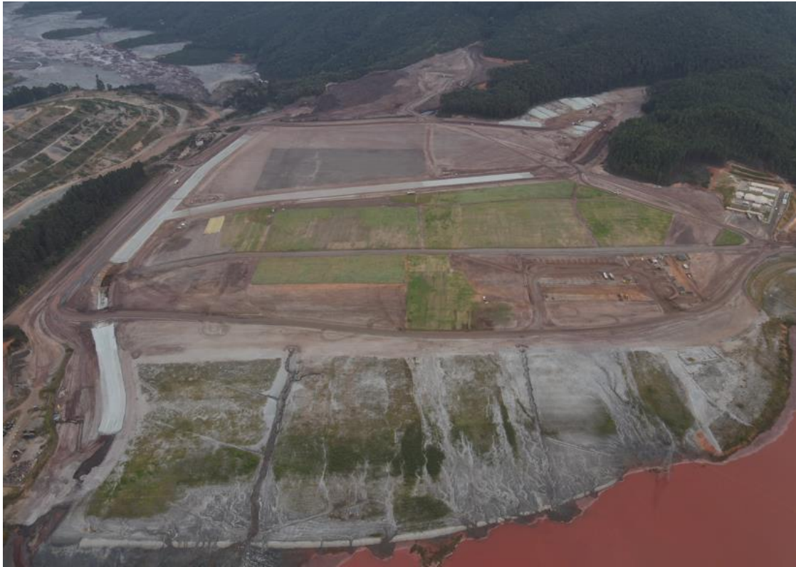
Foto 8. Visão Geral do Dique 1A (Julho/24).
