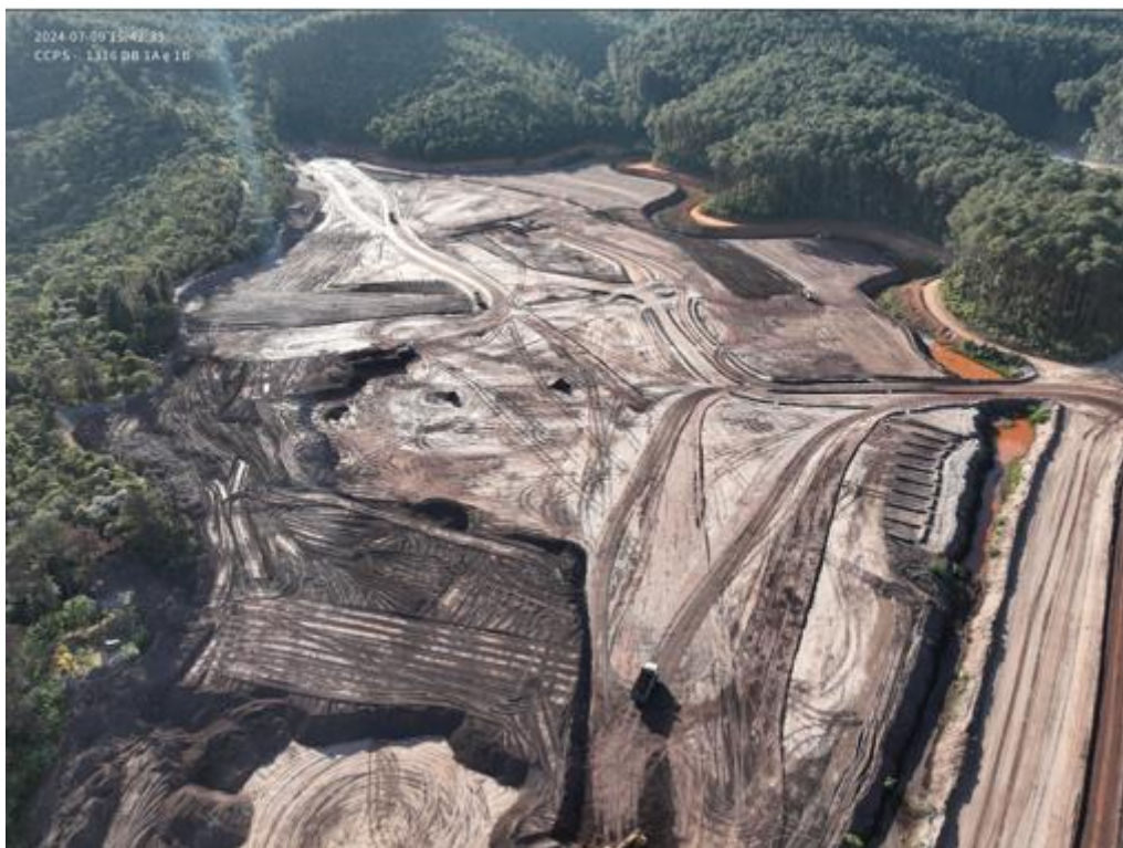
Foto 5. Carga de material da área de estoque para uso no regrade a montante do Dique 1A (Julho/24).
