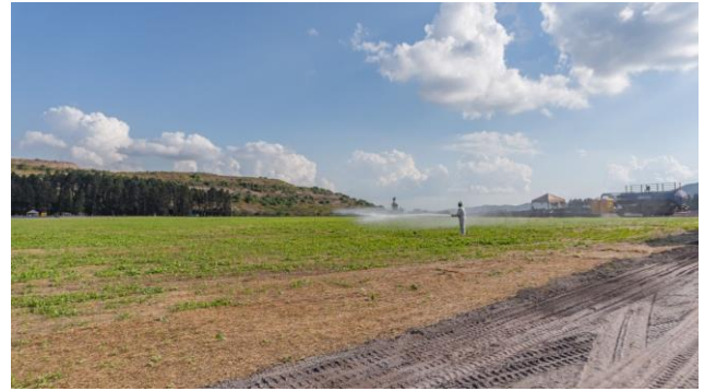
Foto 41. Irrigação da área de plantio no Dique 1A. Fonte: Vale, 2024.
