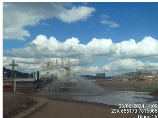
Foto 49. Umectação de vias de acesso as obras de descaracterização do Dique 1A e 1B. Fonte: Vale, 2024
