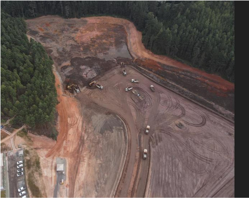
Foto 10. Escavação do Dique 1B (Junho/24).
