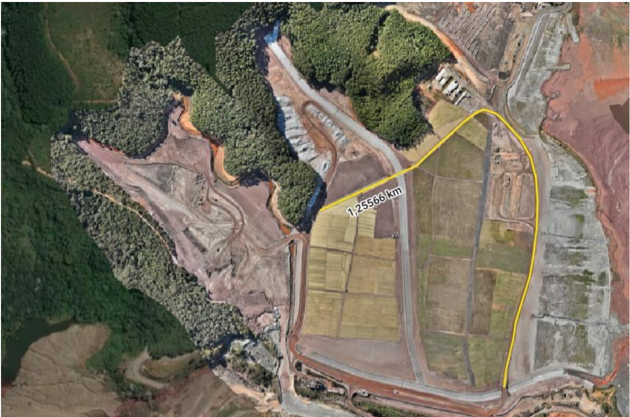
Figura 36. Rotograma de aplicação de polímero supressor de poeira nas principais vias de acesso as obras de descaracterização do Dique 1A e 1B. Fonte: Vale, 2024.
