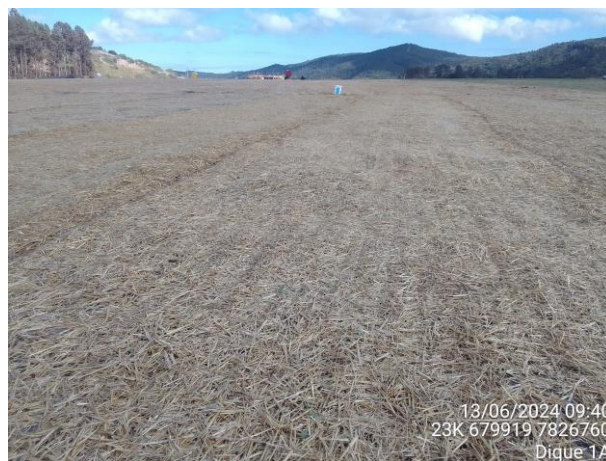
Foto 39. Biomanta aplicada sobre a área de intervenção no Dique 1A: Fonte: Vale, 2024
