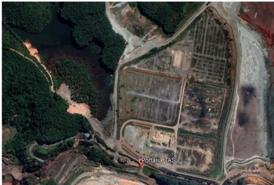
Figura 8. Localização da Portaria ZAS Dique 1A.
