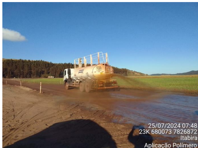
Foto 50. e Foto 51. Aplicação de polímero supressor de poeira nas principais vias de acesso as obras de descaracterização do Dique 1A e 1B. Fonte: Vale, 2024.
