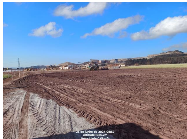
Foto 35. Execução de gradagem do solo 26/06/2024. Fonte: Vale, 2024.
