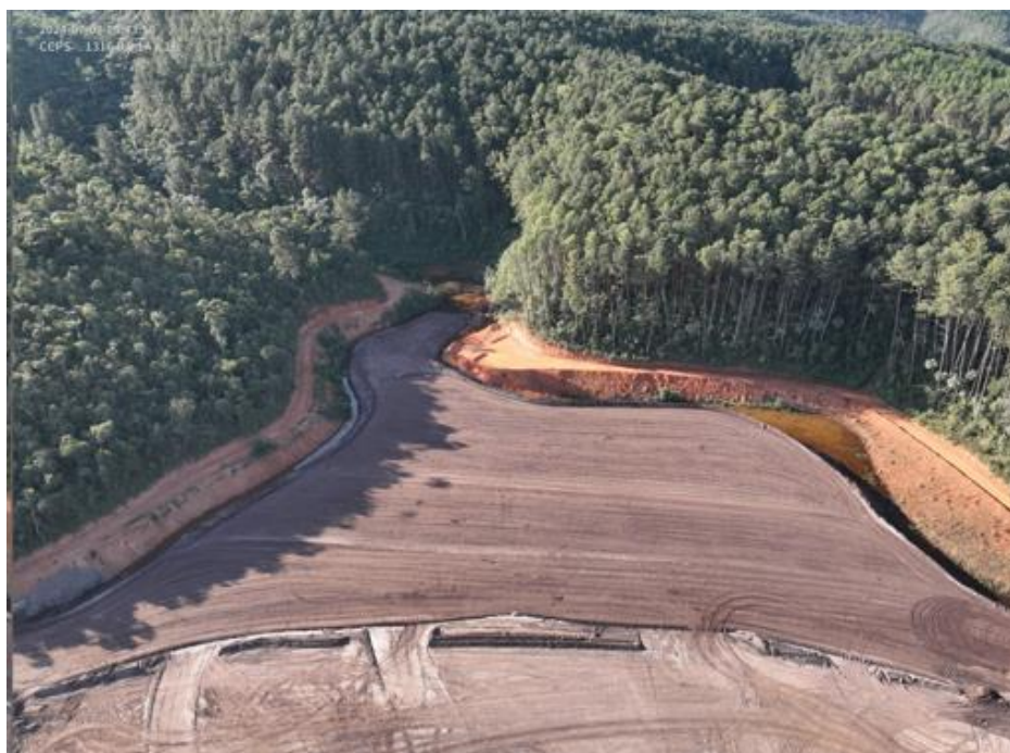
Foto 3. Regrade a montante do reservatório do Dique 1A (Julho/24).
