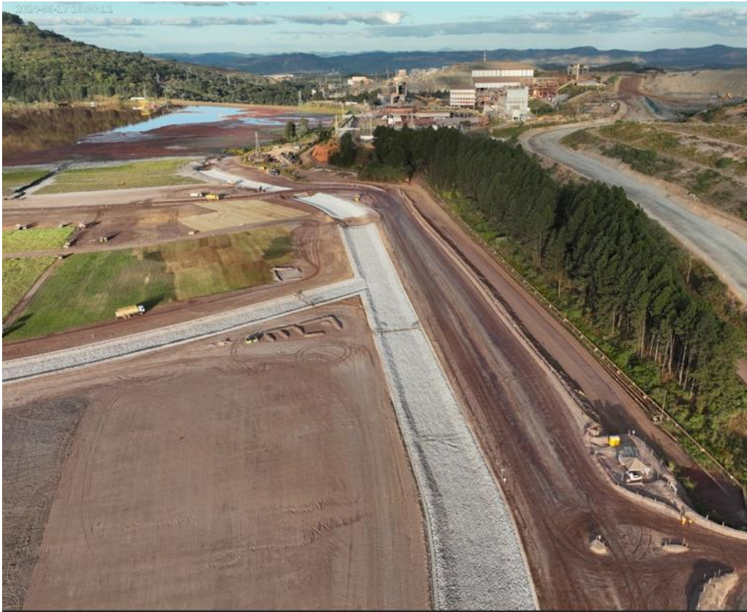
Foto 6. Canal Periférico C1 - Dique 1A (Julho/24).
