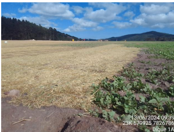
Foto 38. Biomanta aplicada sobre a área de intervenção no Dique 1A: Fonte: Vale, 2024.
