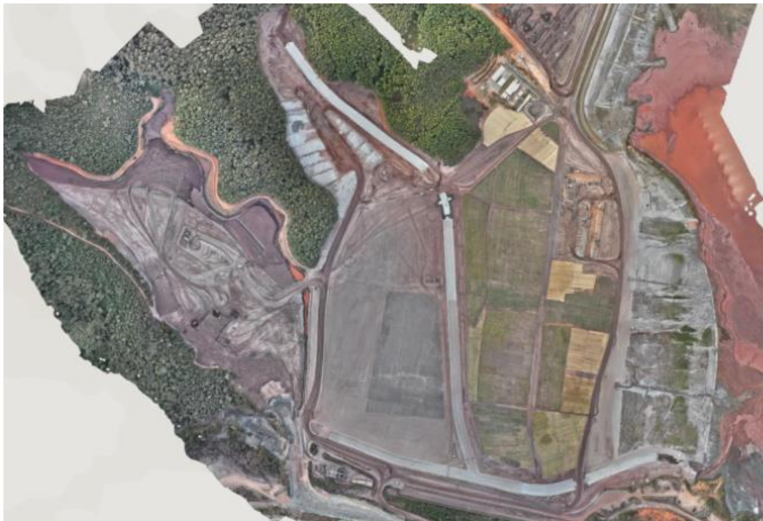
Foto 9. Visão Geral do Dique 1A (Julho/24).
