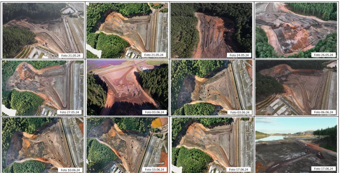
Figura 9. Evolução Obra de Descaracterização Dique 1B.
