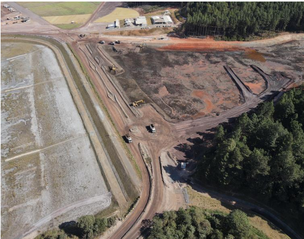
Foto 11. Escavação do Dique 1B (Julho/24).
