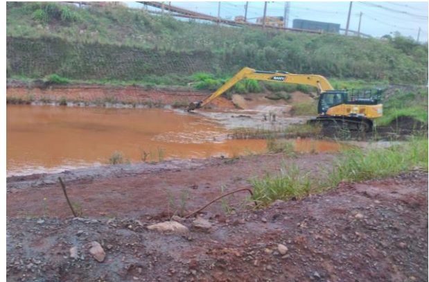
Foto 7: Limpeza do Sump do canal de cintura da Barragem Vargem Grande (Fonte: Vale, 2024)
