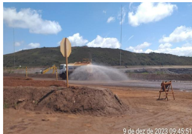
Foto 16: Umectação das vias do canteiro (Fonte: Vale 2023)
