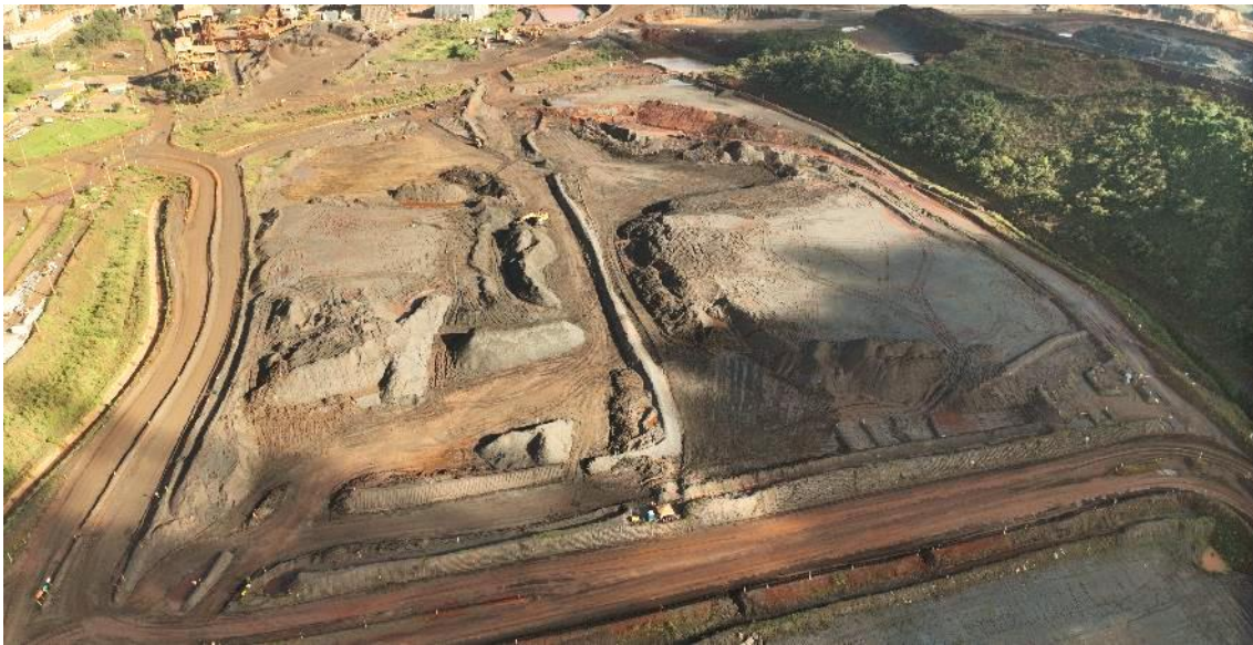
Foto 4: Visão geral pilha de estocagem temporária (11/01/2024).
