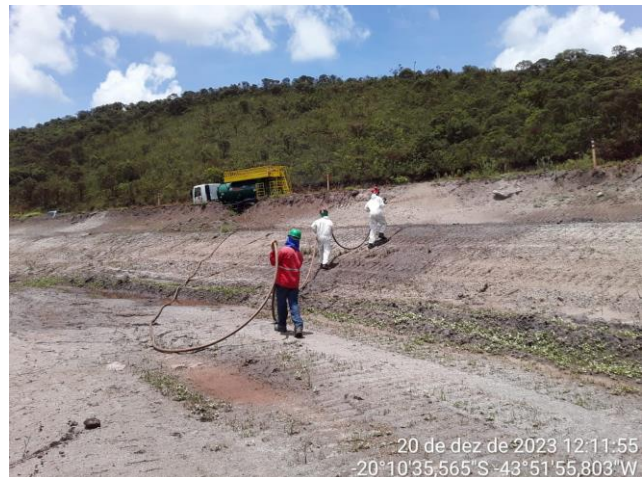
Foto 12: Aplicação de MVP (Fonte: Vale, 2023)
