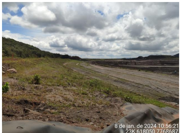
Foto 14: Vista da área após revegetação mostrando o processo bem estabelecido. (Fonte: Vale, 2024)
