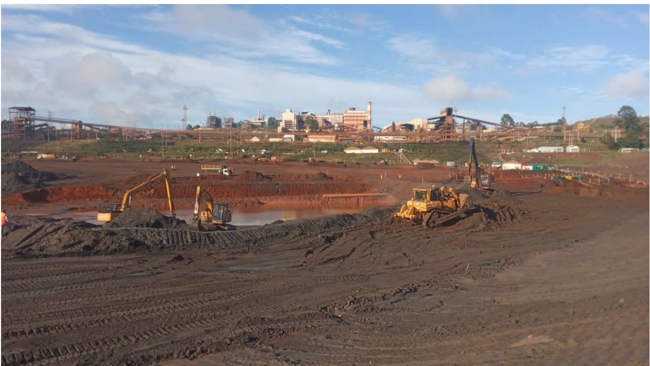
Foto 27. Atividade de expansão do SUMP interno (Fonte: Vale, 2023)
