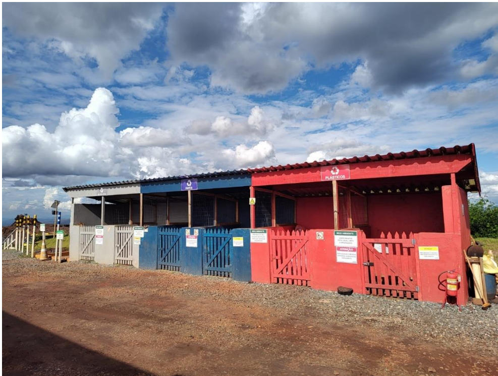
Foto 23. DIR do Canteiro. (Fonte: Vale, 2024).
