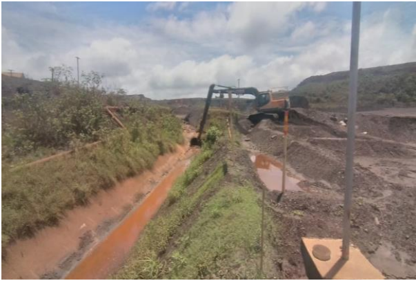
Foto 6: Início da limpeza de finos do canal corugado do CC02 - Canal de concreto, advindo do sump 01. (Fonte: Vale, 2024)
