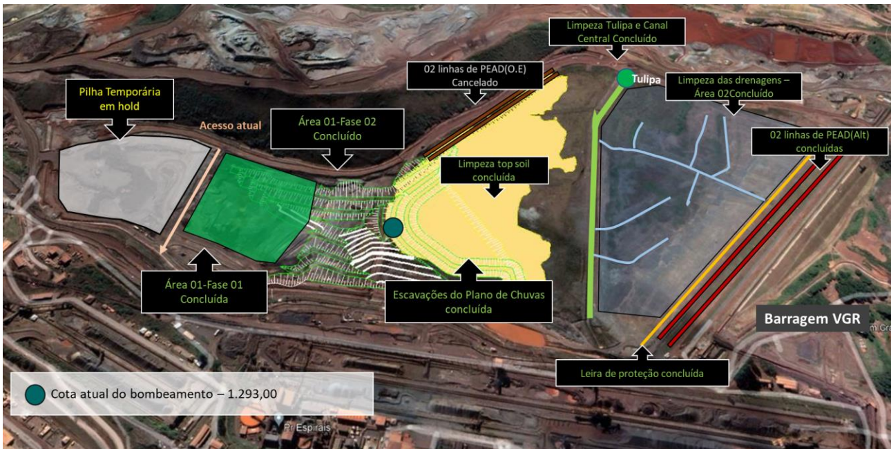
Figura 4. Visão das obras de melhorias na estrutura.
