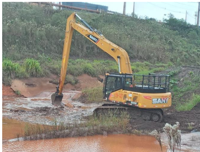
Foto 8: Limpeza do SUMP através de aterros de conquista para acesso a toda extensão da estrutura e continuidade do recebimento dos efluentes. (Fonte: Vale, 2024)
