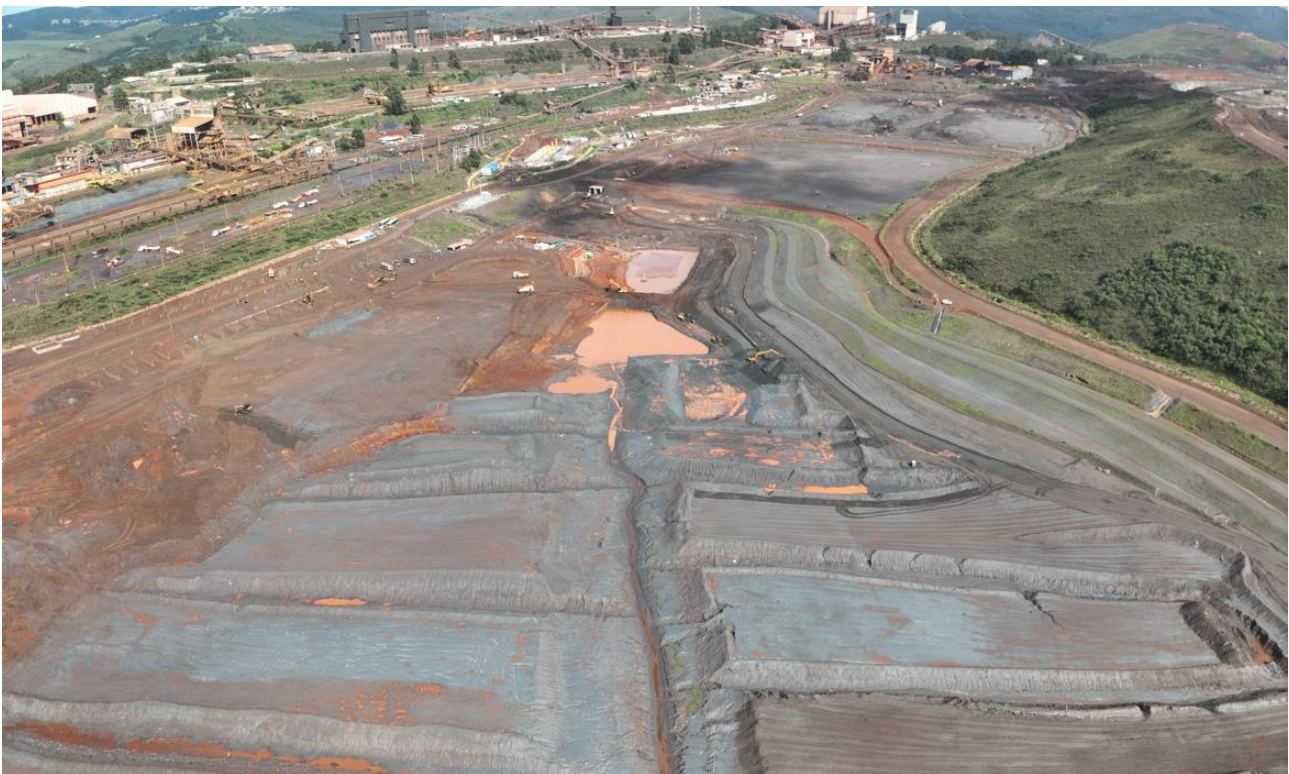
Foto 5: Visão geral conclusão das escavações Fase 1 (16/01/2023).
