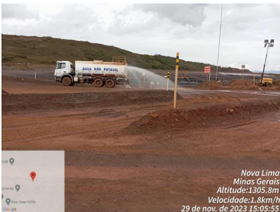
Foto 15: Umectação das vias do canteiro (Fonte: Vale 2023)
