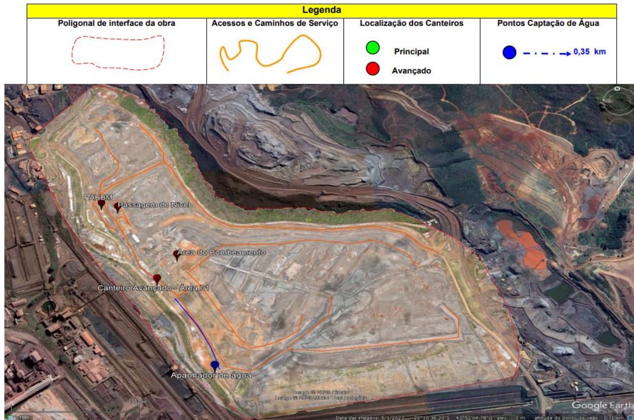
Figura 7. Rotograma para as obras de descaracterização da barragem Vargem Grande (Fonte: Vale 2023).
